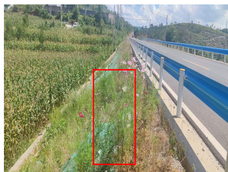
边坡回填区域
