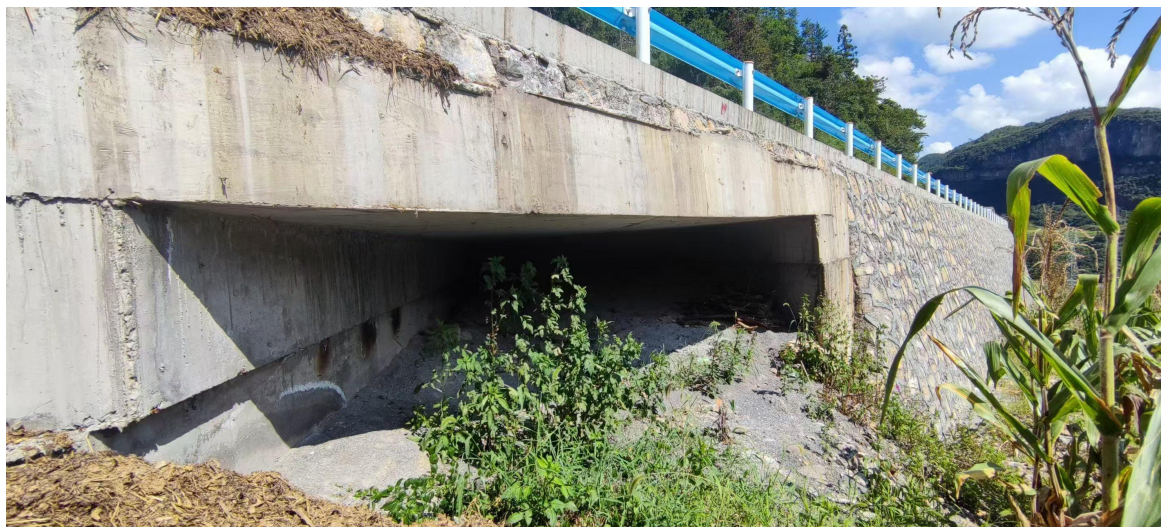
岔河 1 号小桥改涵洞现状
