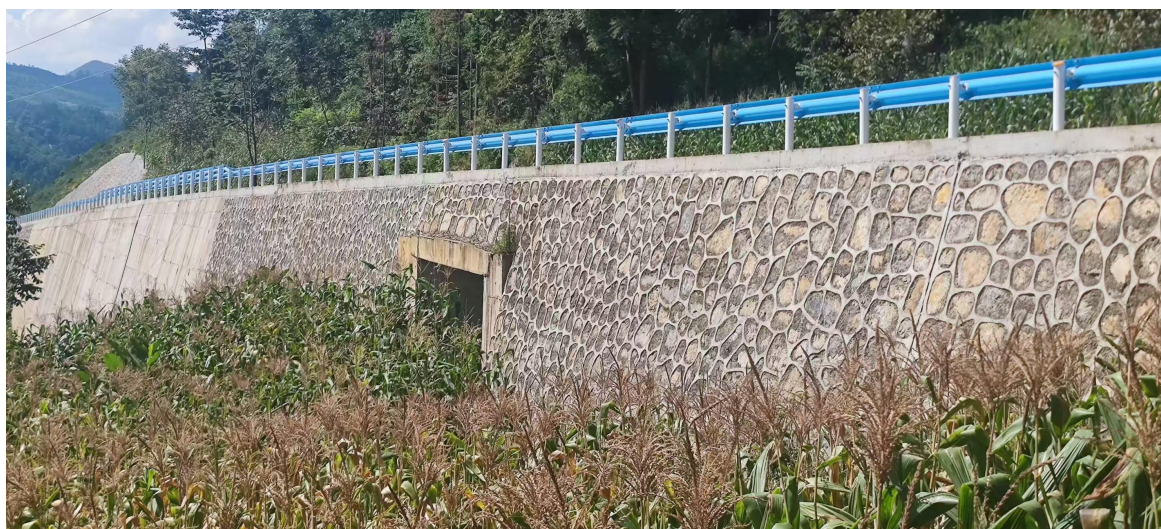
岔河 2 号小桥改涵洞现状
