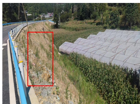
边坡回填区域
