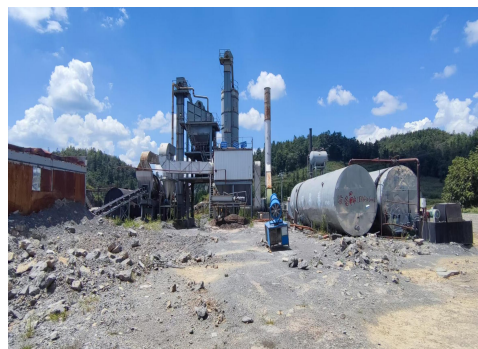
沥青混凝土拌合站
