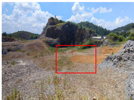
水稳碎石拌合站
