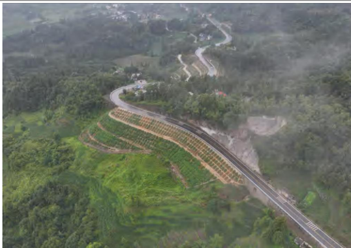
路基工程区恢复情况（航拍）
