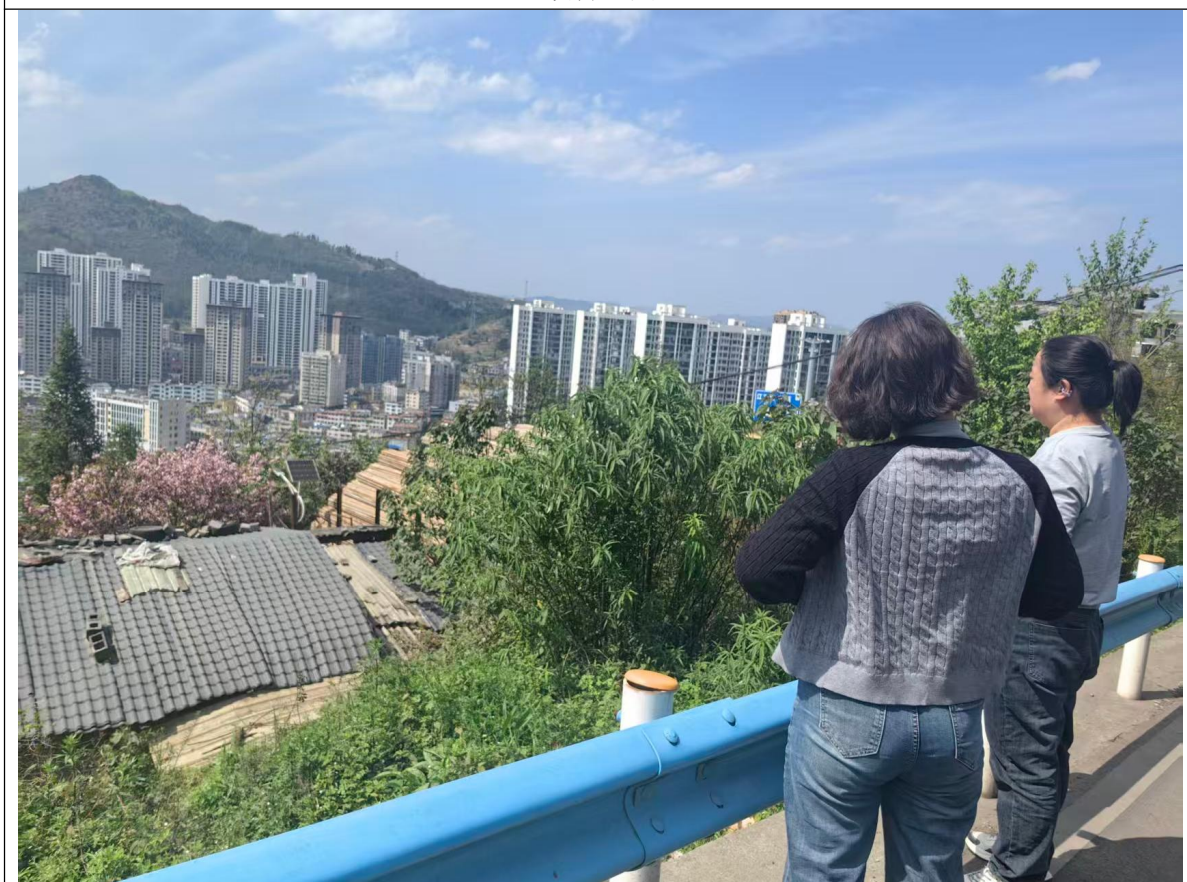
验收专家组现场踏勘道路起点
