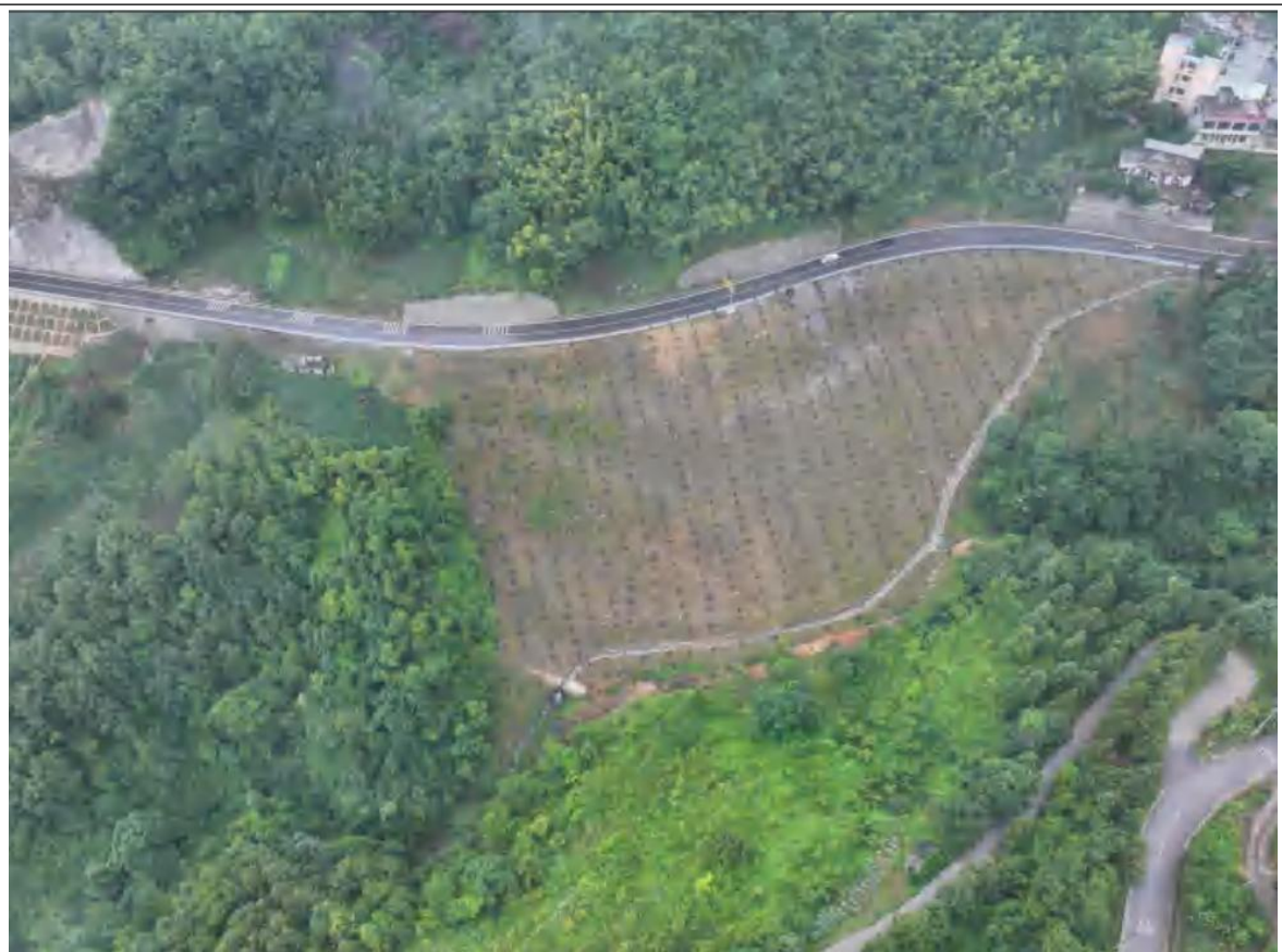
弃土场区恢复情况（航拍）
