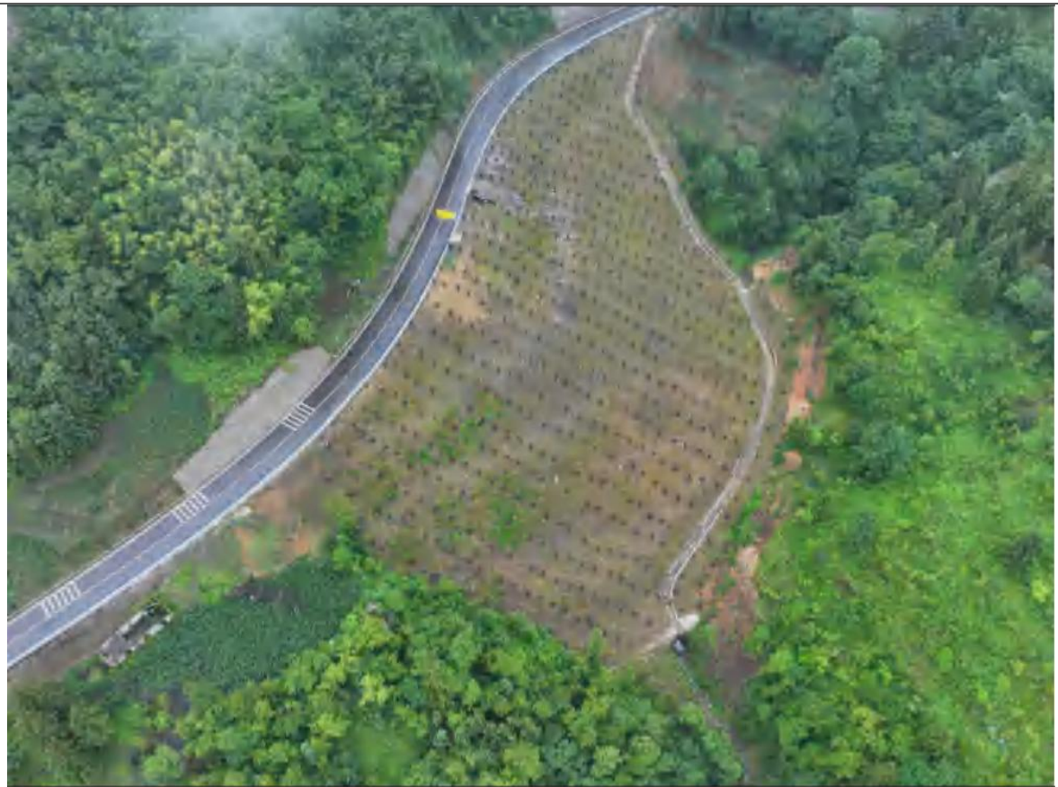
弃土场区恢复情况（航拍）
