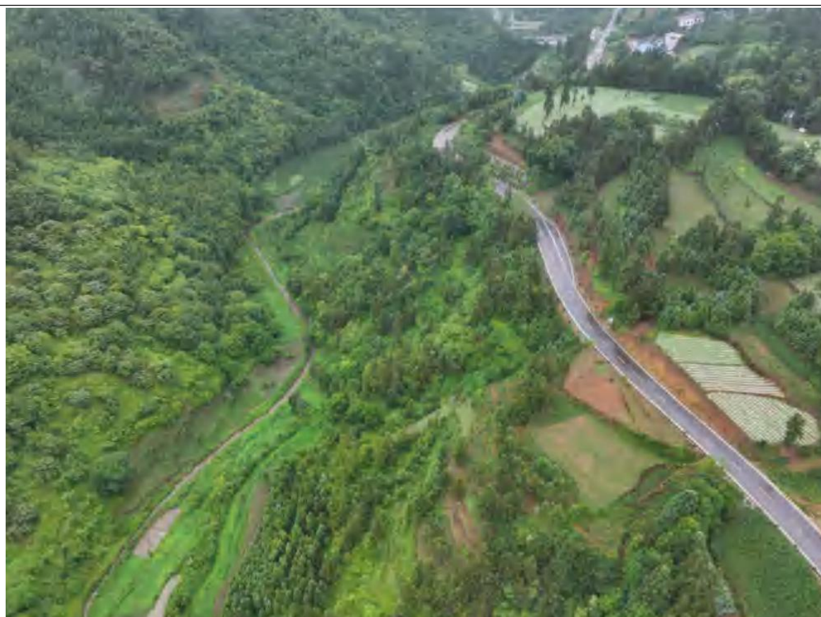
路基工程区恢复情况（航拍）
