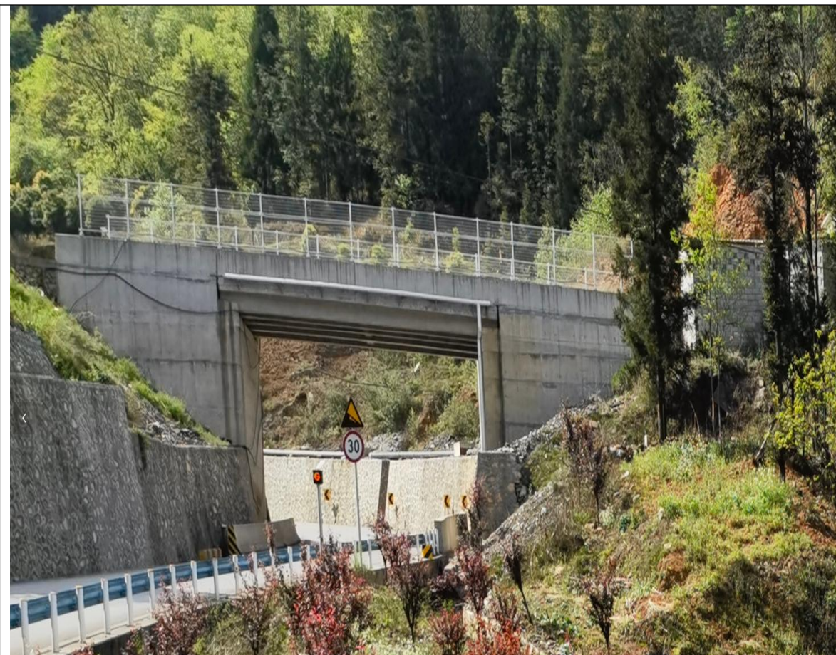
代山田天桥（中心桩号 K13+700）
