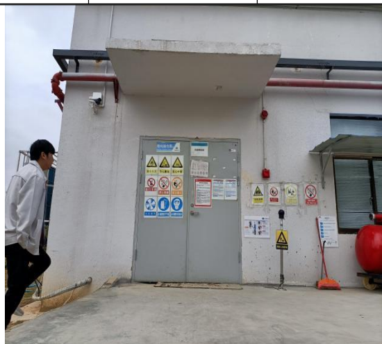
危险废物暂存间
