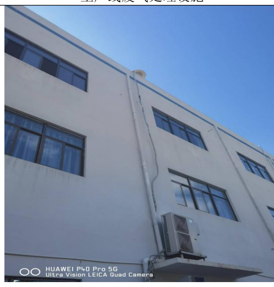
实验室排气筒
