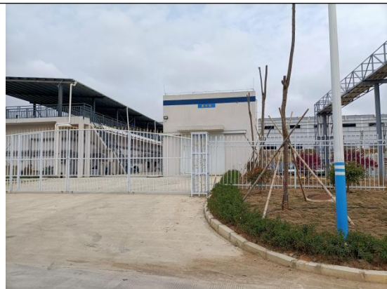
生产废水处理站
