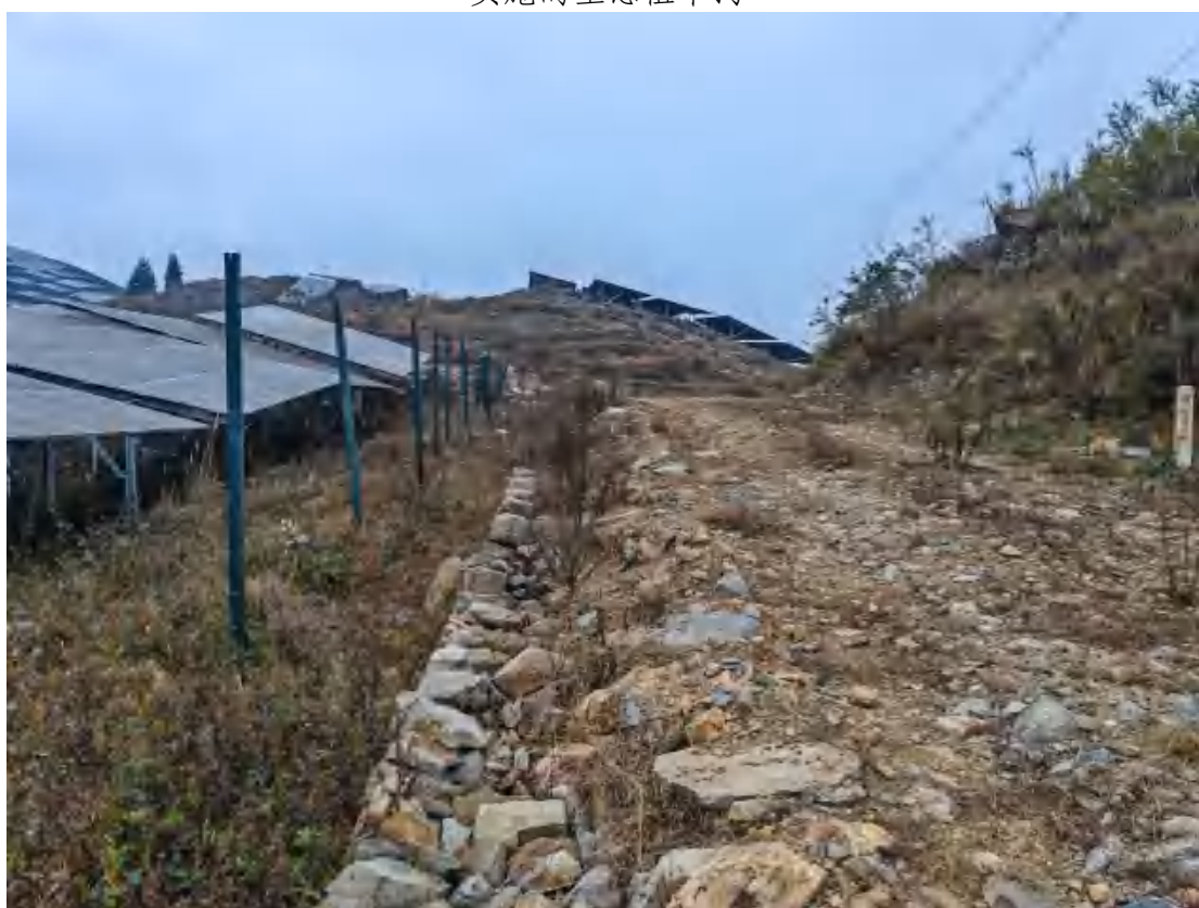
监测过程中实施的干砌石挡墙
