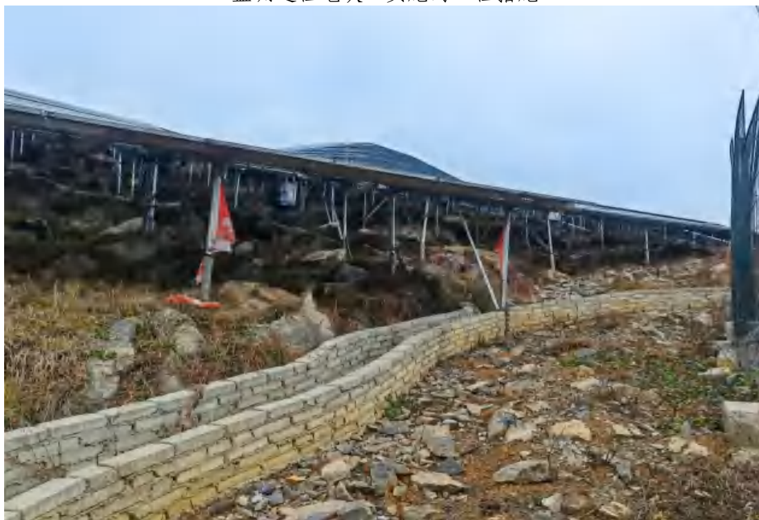
监测过程地块 5 实施的工程措施
