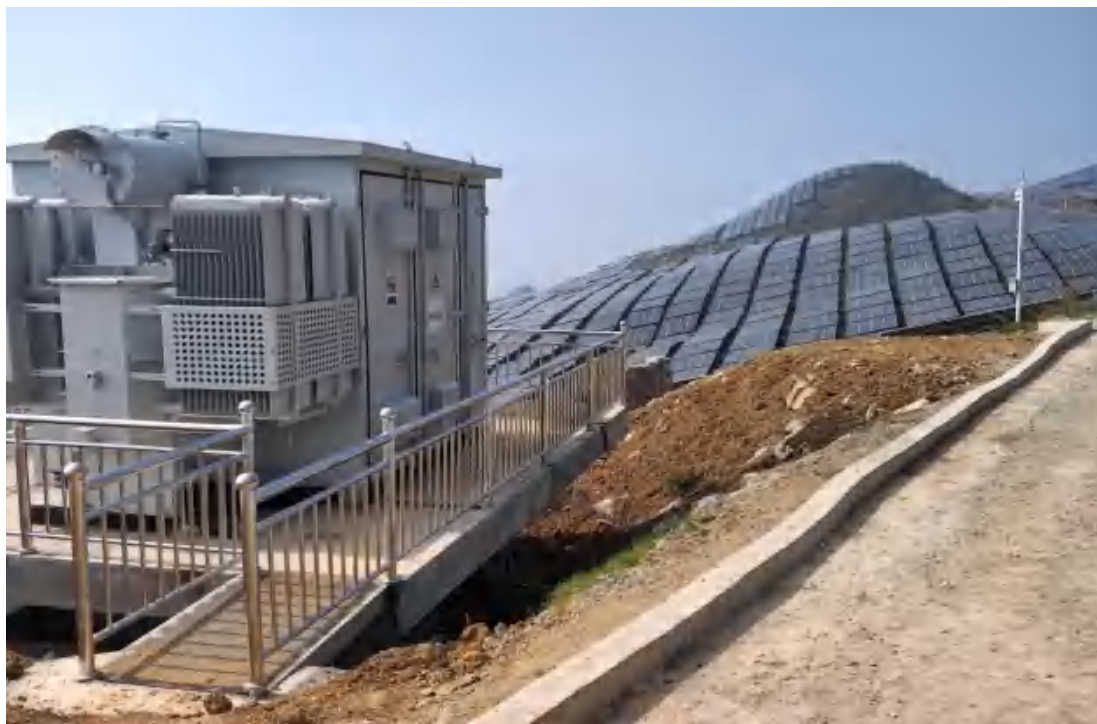
监测过程地块 5 实施的工程措施
