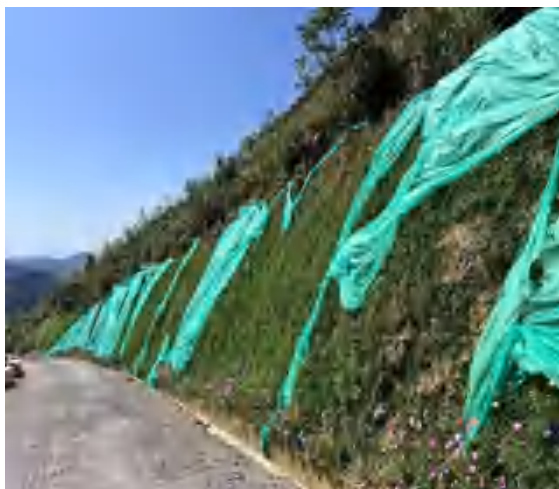
新建道路区上边坡喷播植草和道路排水沟
