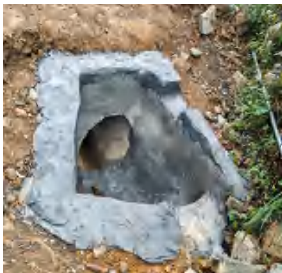
13#新建道路区沉沙池和排水涵管
