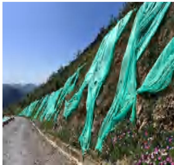
新建道路区上边坡喷播植草和裸露区域植被建设
