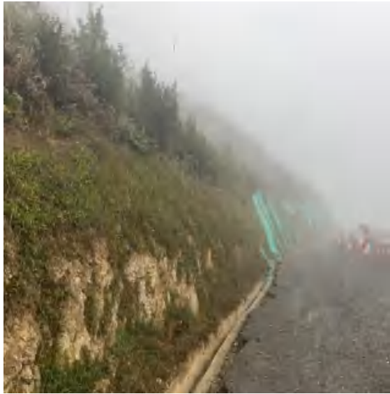
新建道路区上边坡喷播植草和裸露区域植被建设
