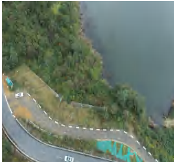
11#新建道路区下边坡植被建设和主体挡土墙
