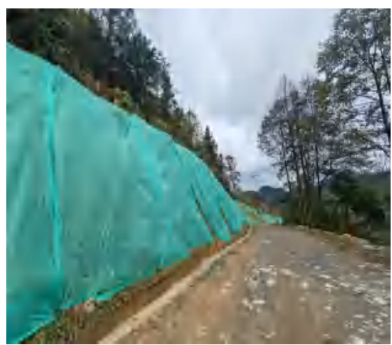
13#新建道路区上边坡喷播植草、道路排水沟
