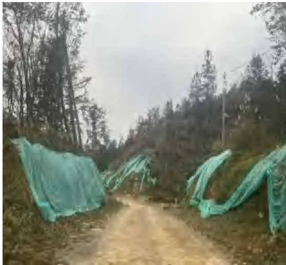
13#新建道路区上边坡喷播植草
