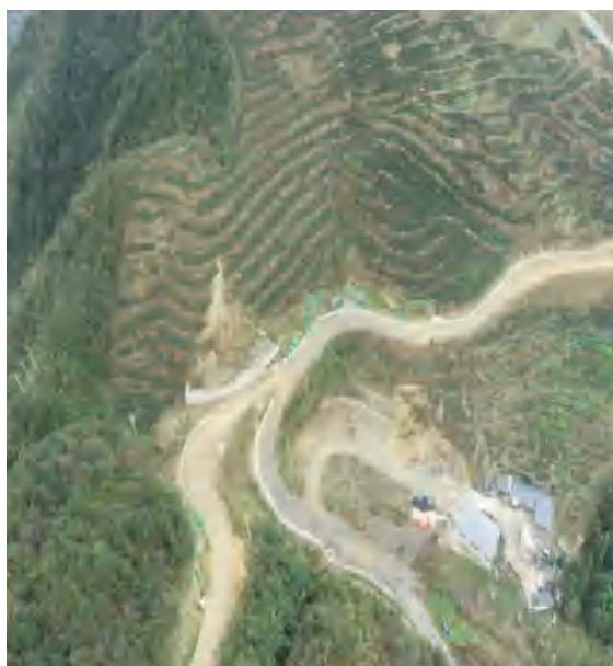
11-2#新建道路区道路排水沟、主体挡土墙、下边坡植被建设和上边坡喷播植草
