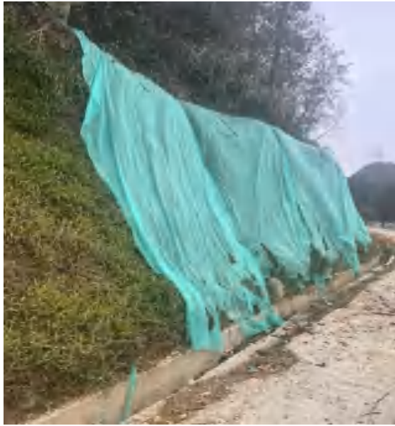
新建道路区道路排水沟和上边坡喷播植草
