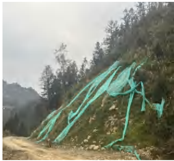
新建道路区上边坡喷播植草
