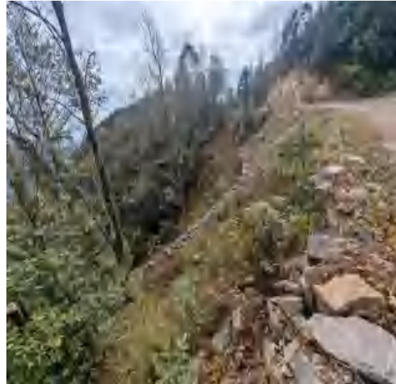
13#新建道路区下边坡植被建设和主体挡土墙
