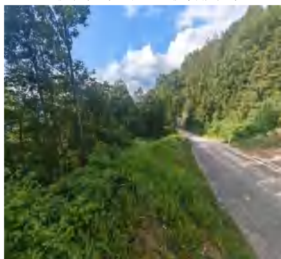
13#新建道路区道路排水沟和裸露地表植被建设
