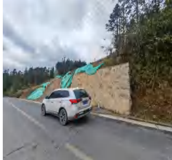
12#新建道路区上边坡喷播植草、道路排水沟和主体挡土墙
