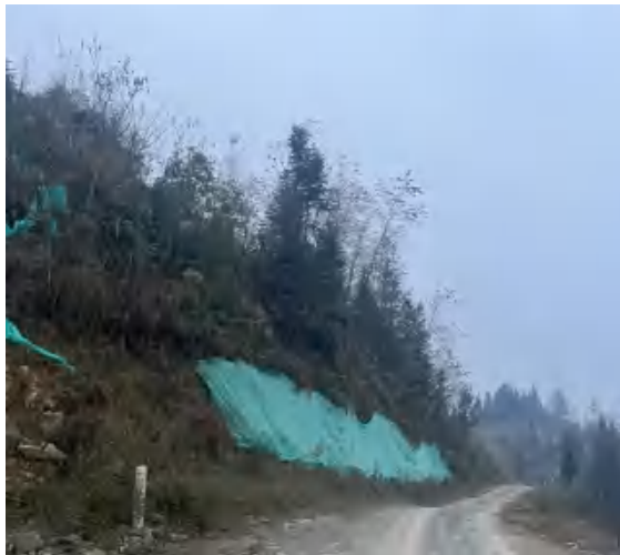
13#新建道路区上边坡喷播植草
