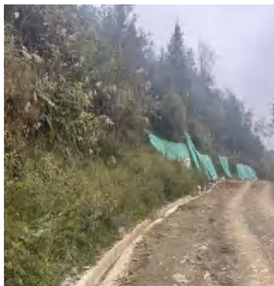
13#新建道路区上边坡喷播植草和裸露地表 植被生长情况
