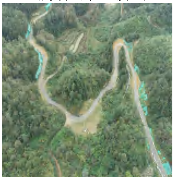
11#新建道路区道路排水沟、覆土绿化、下边坡植被建设和上边坡喷播植草
