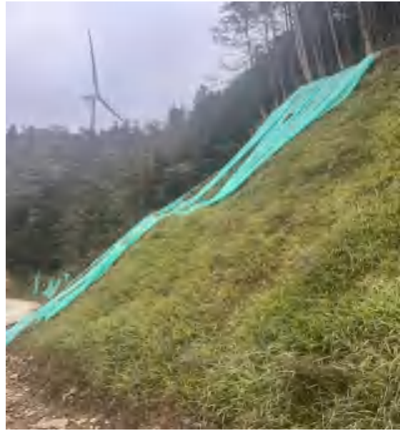
新建道路区上边坡喷播植草
