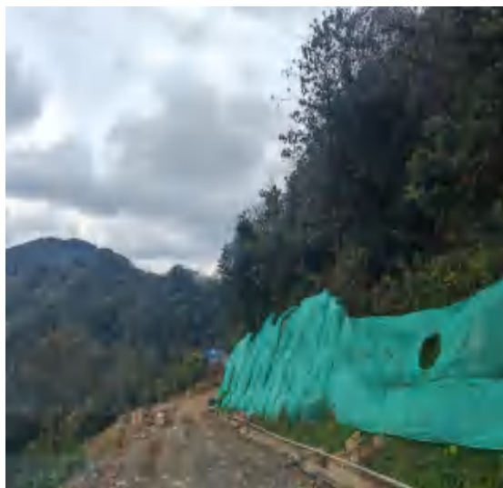
13#新建道路区上边坡喷播植草、道路排水沟
