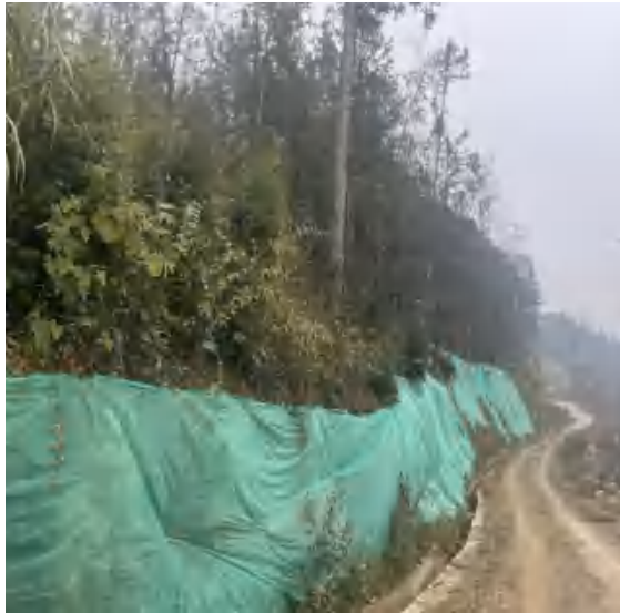
13#新建道路区上边坡喷播植草和排水沟
