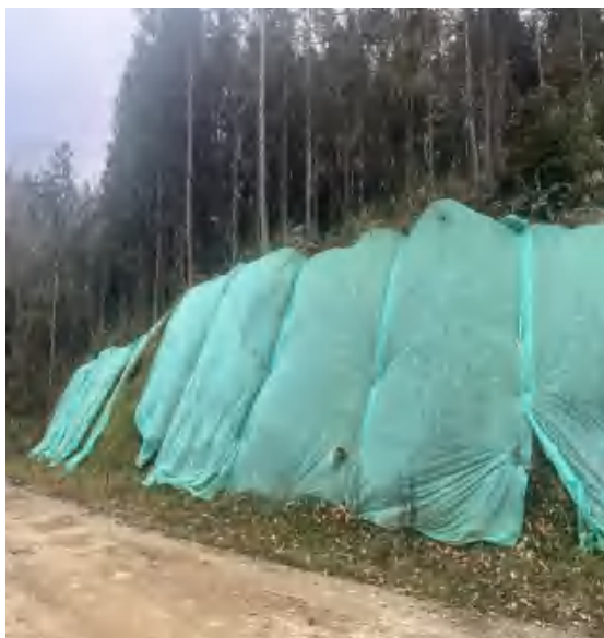
新建道路区上边坡喷播植草
