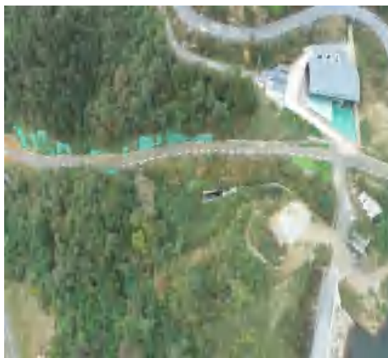
11#新建道路区道路排水沟、下边坡植被建设和上边坡喷播植草
