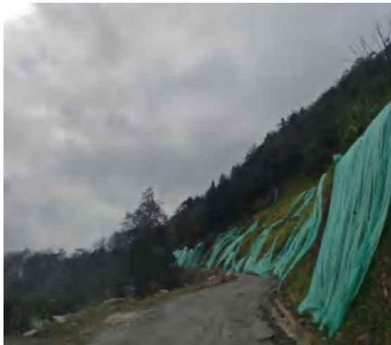
13#新建道路区上边坡喷播植草、道路排水沟
