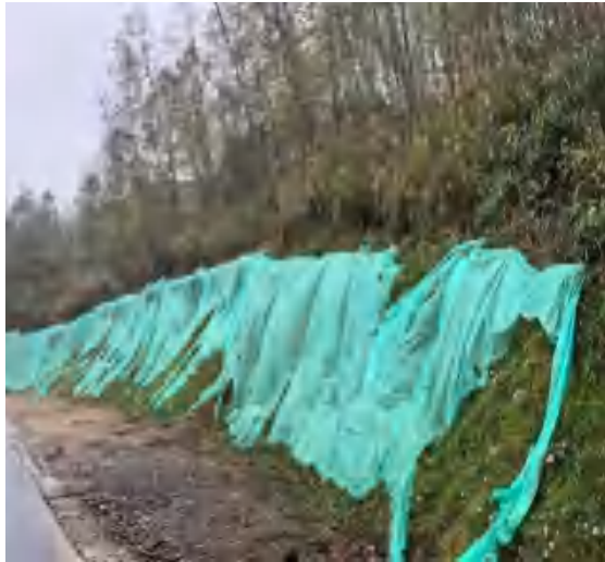
改扩建道路区上边坡喷播植草
