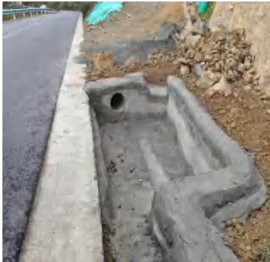
12#新建道路区沉沙池和排水涵管
