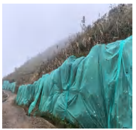
7#新建道路区上边坡喷播植草和排水沟
