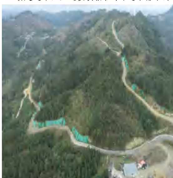
11#新建道路区道路排水沟、主体挡土墙、下边坡植被建设和上边坡喷播植草
