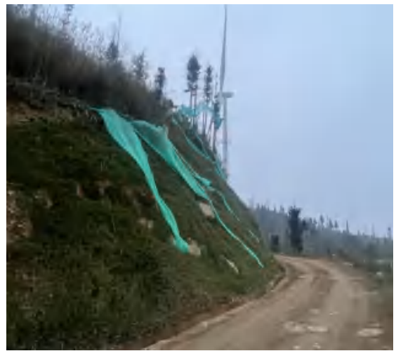
13#新建道路区上边坡喷播植草和排水沟
