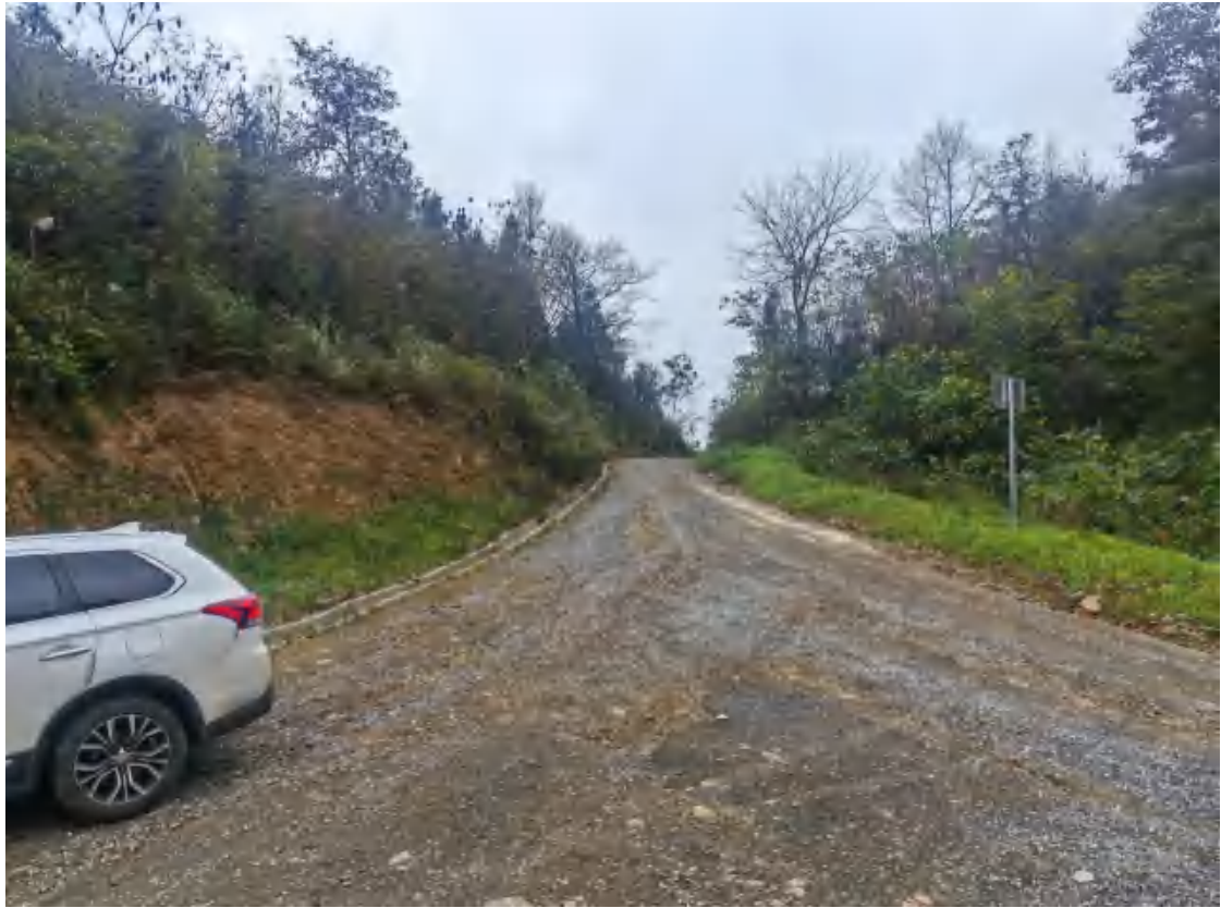
2 号道路排水沟和裸露区域植被建设
