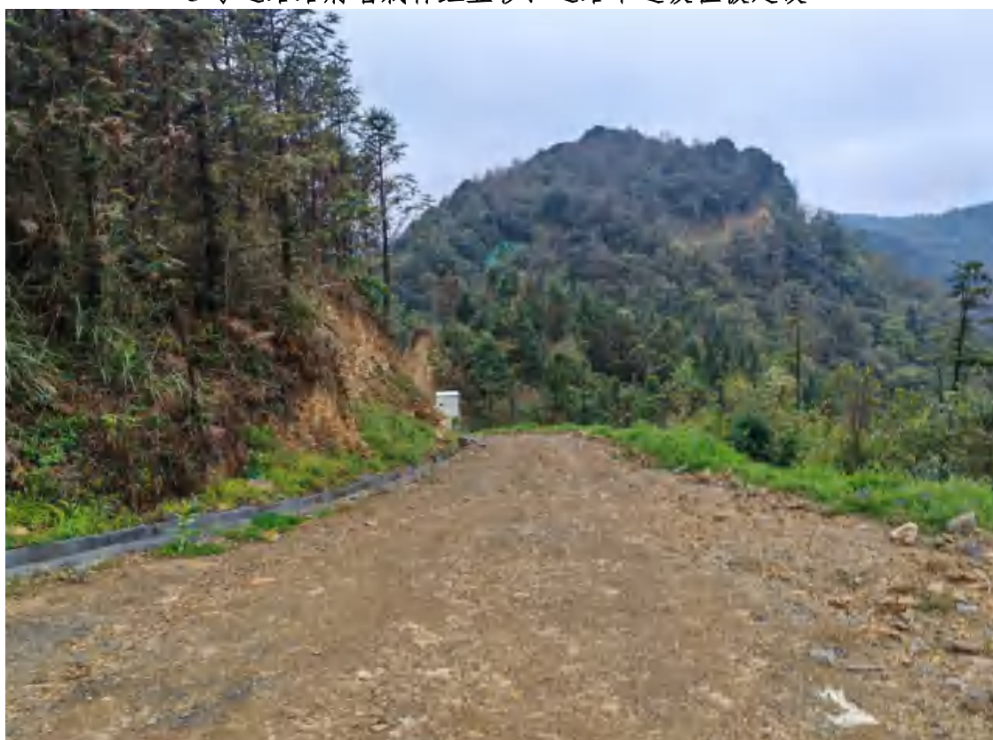
5号道路路肩墙栽种红豆杉、植物槽和裸露地表植被建设
