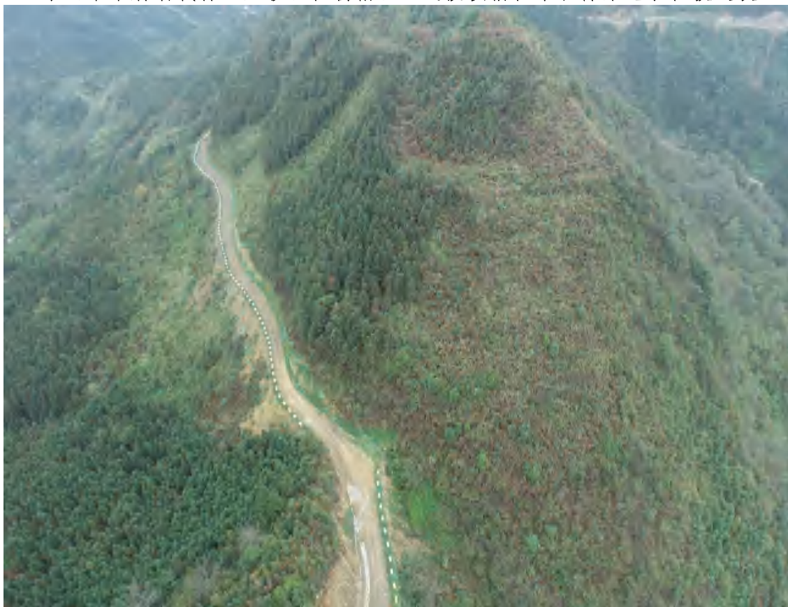
4号道路路肩墙栽种红豆杉、上边坡喷播植草、下边坡植被和裸露地表植被建设
