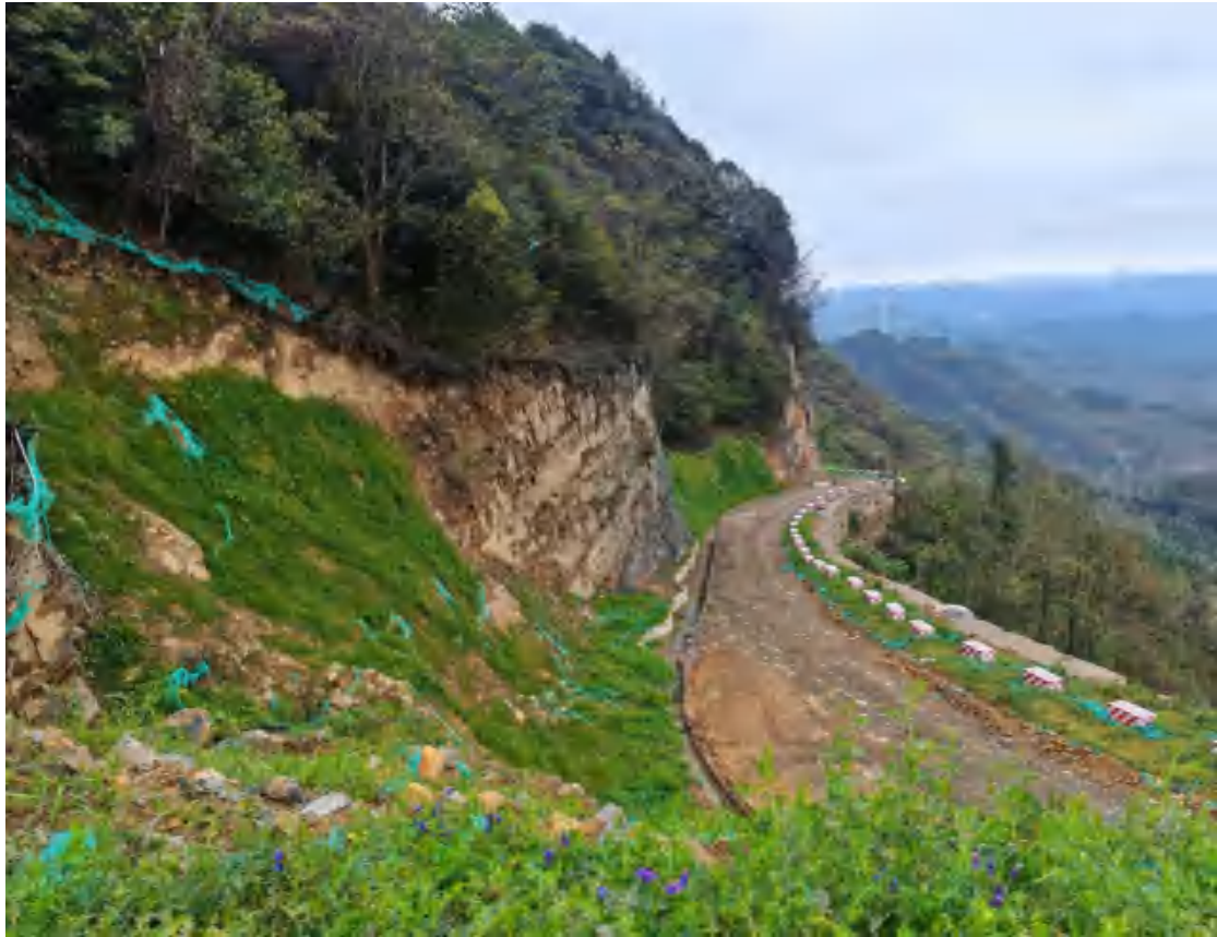
4号道路路肩墙栽种红豆杉、植物槽、上边坡喷播植草和裸露地表植被建设
