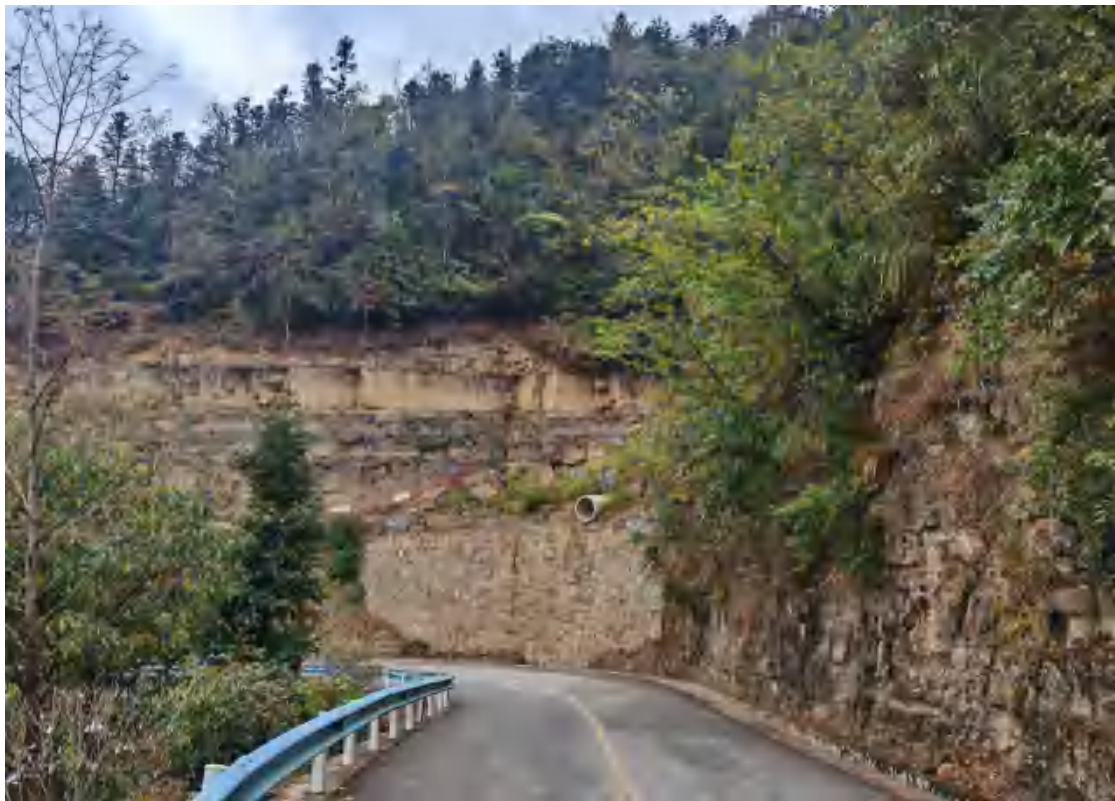
12 号道路挡土墙和排水涵管
