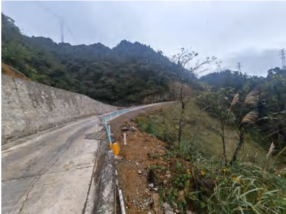
改扩建道路填方区植被恢复情况
