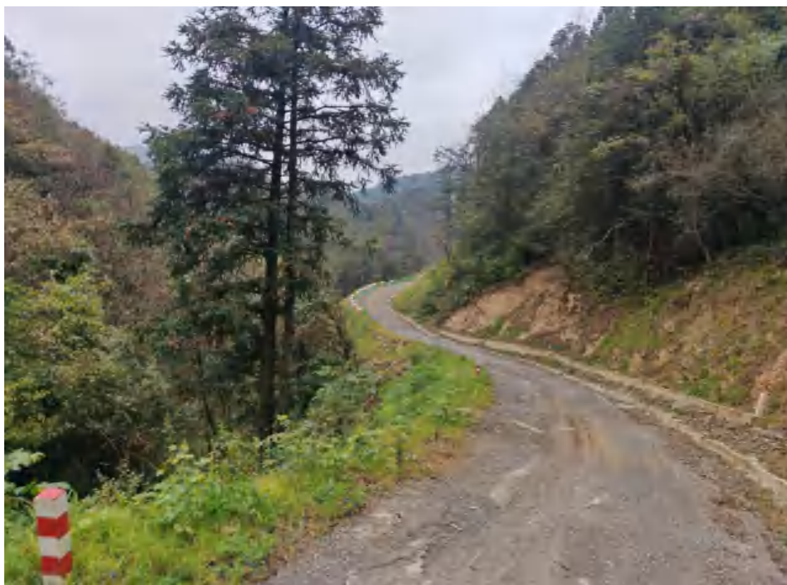
6号道路路肩墙栽种红豆杉、排水沟和裸露地表植被建设
