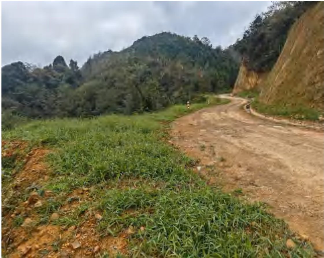
2 号道路排水沟、上边坡喷播植草和裸露区域植被建设
