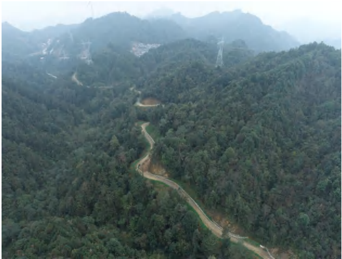
6号道路路肩墙栽种红豆杉、排水沟、上边坡喷播植草、修建植物槽和裸露地表植被建设
