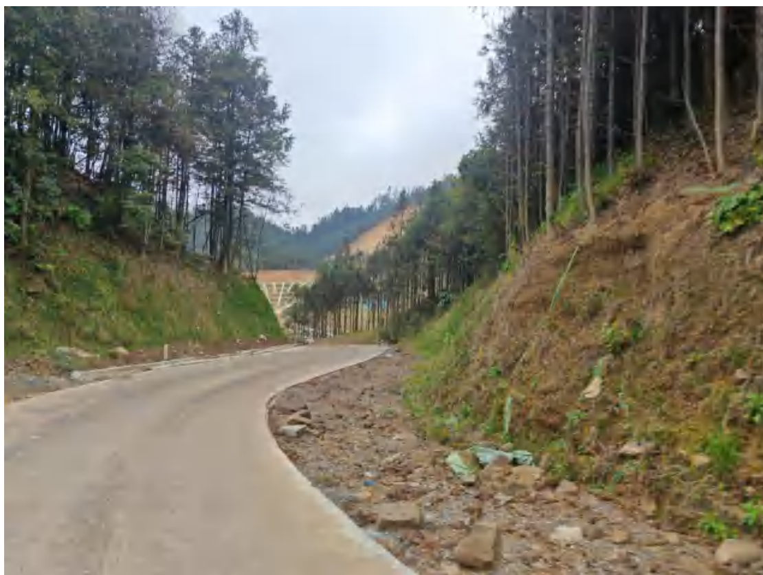
7号道路上边坡喷播植草
