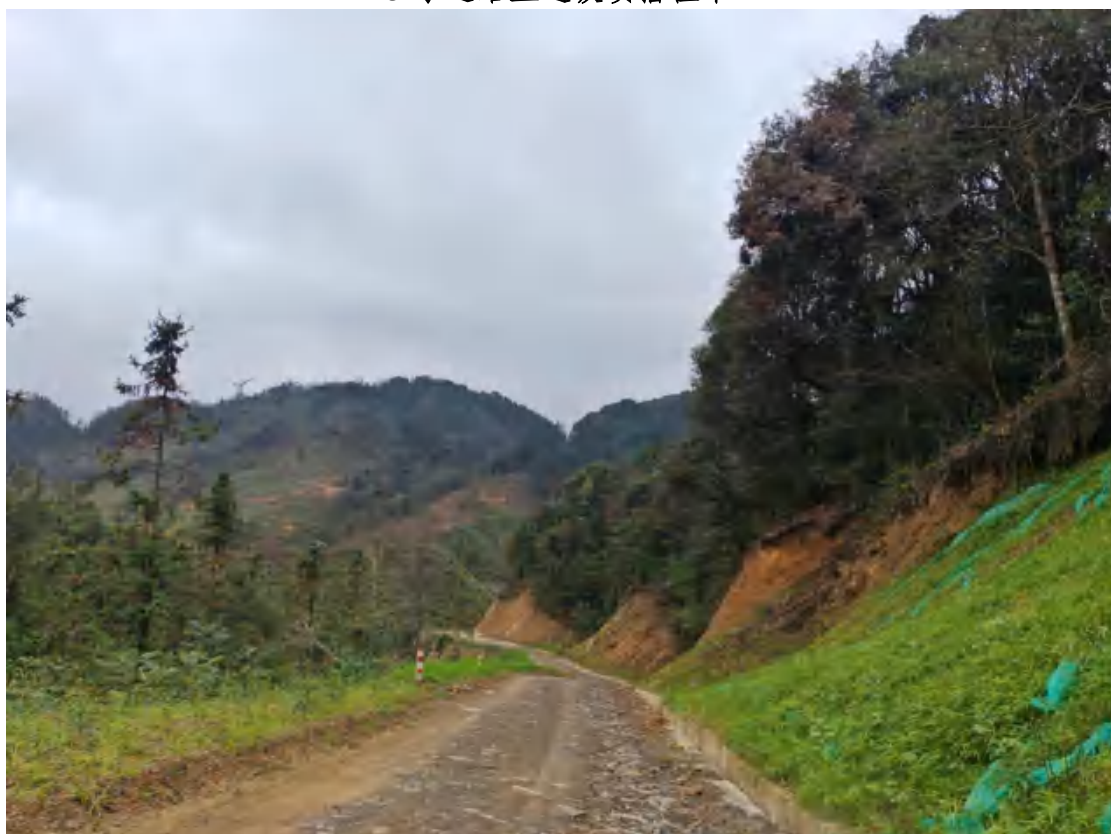
3号道路排水沟和上边坡喷播植草
