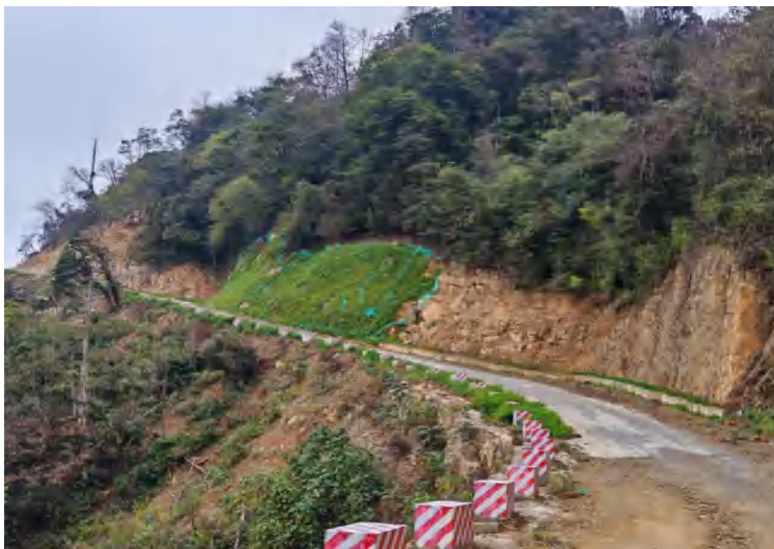
5号道路路肩墙栽种红豆杉、植物槽、排水沟和上边坡喷播植草
