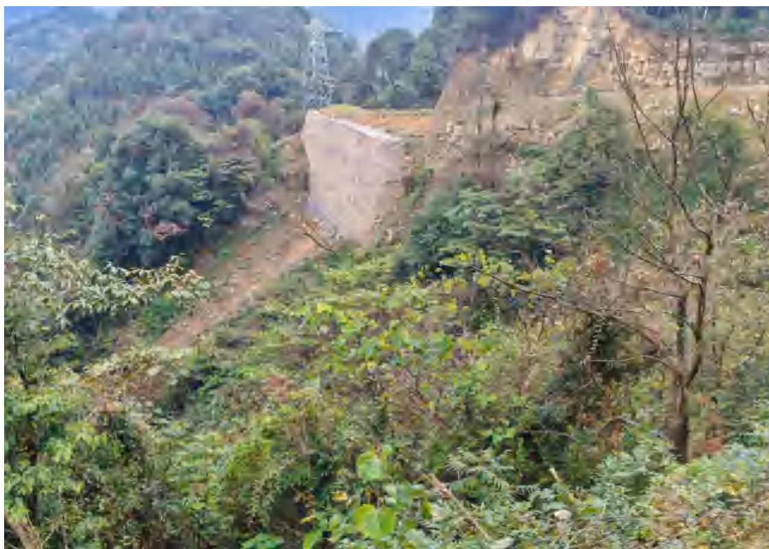
2号道路下边坡挡土墙和植被建设
