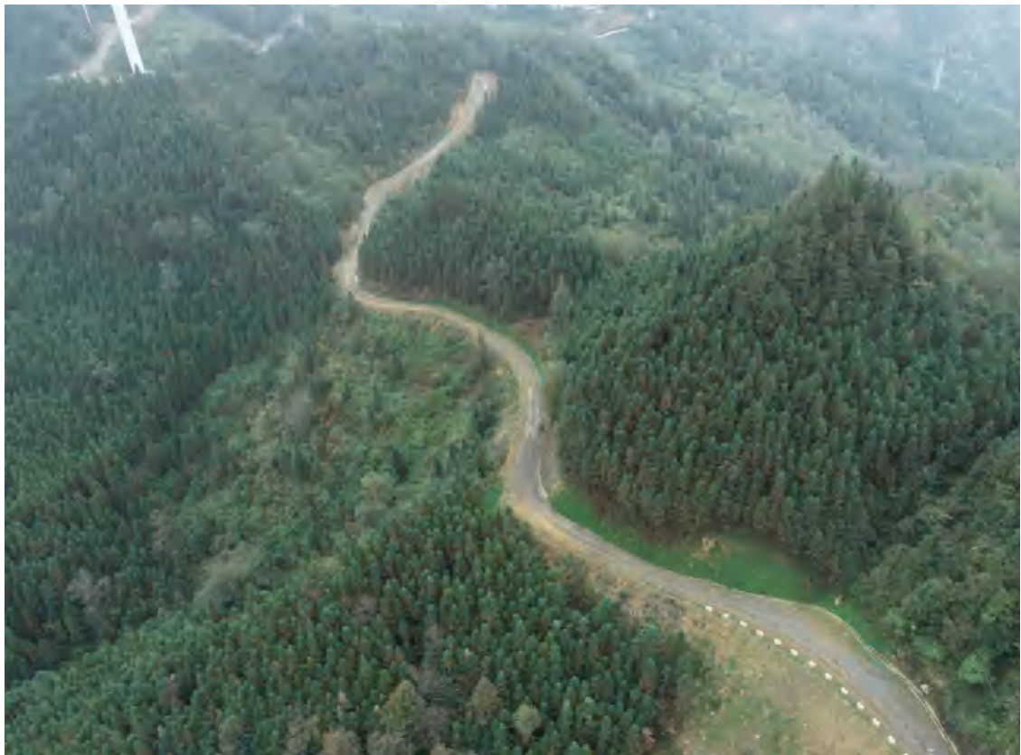
10 号道路排水沟、上边坡喷播植草和裸露区域、下边坡植被恢复
