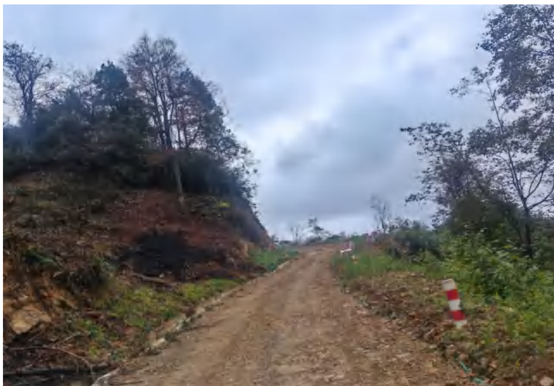
1 号道路排水沟和裸露区域植被建设
