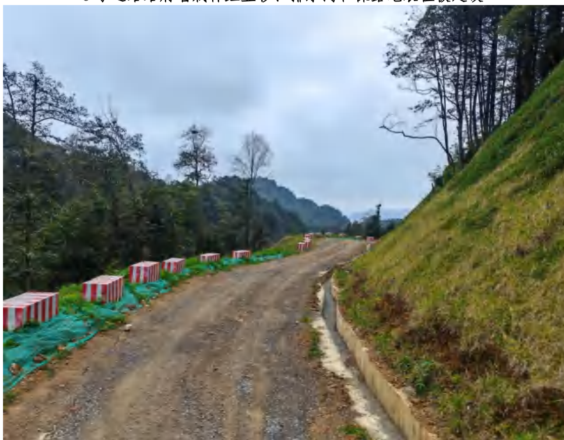
6号道路路肩墙栽种红豆杉、排水沟、裸露地表植被建设和上边坡喷播植草
