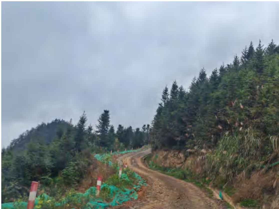
9号道路排水沟、上边坡喷播植草和裸露区域植被恢复效果图
