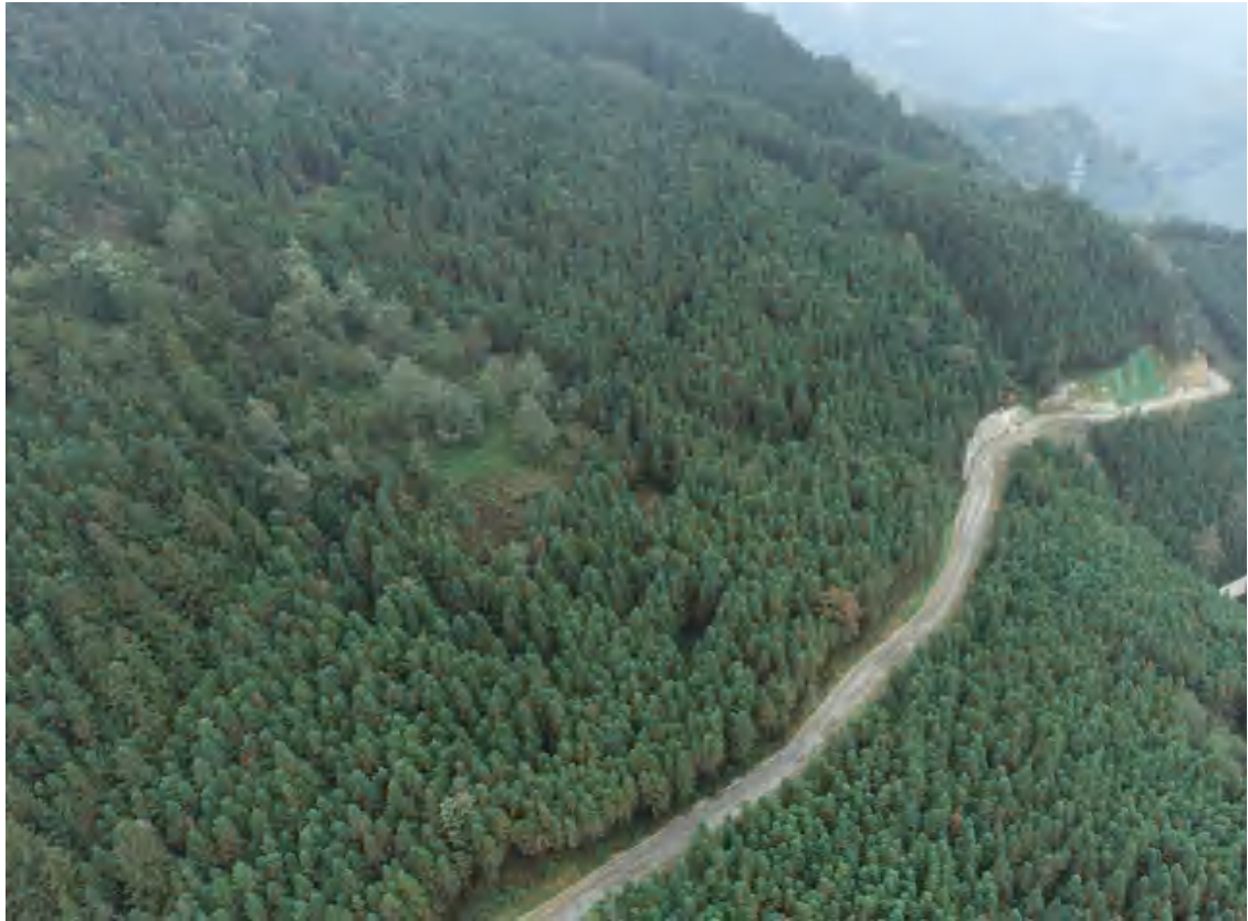
9 号道路排水沟、上边坡喷播植草和裸露区域植被恢复
