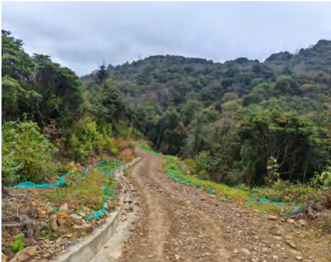
5号道路路肩墙栽种红豆杉、排水沟和裸露区域植被建设
