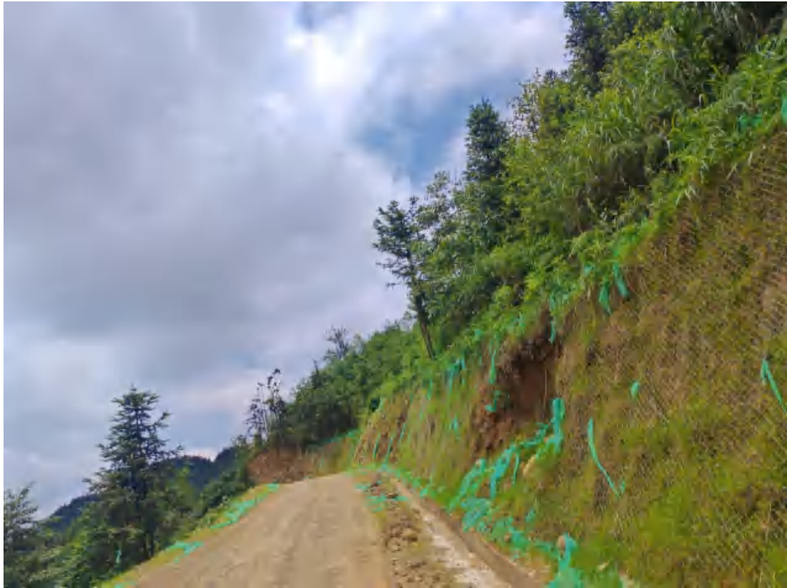
11 号道路排水沟、上边坡喷播植草和裸露区域植被恢复
