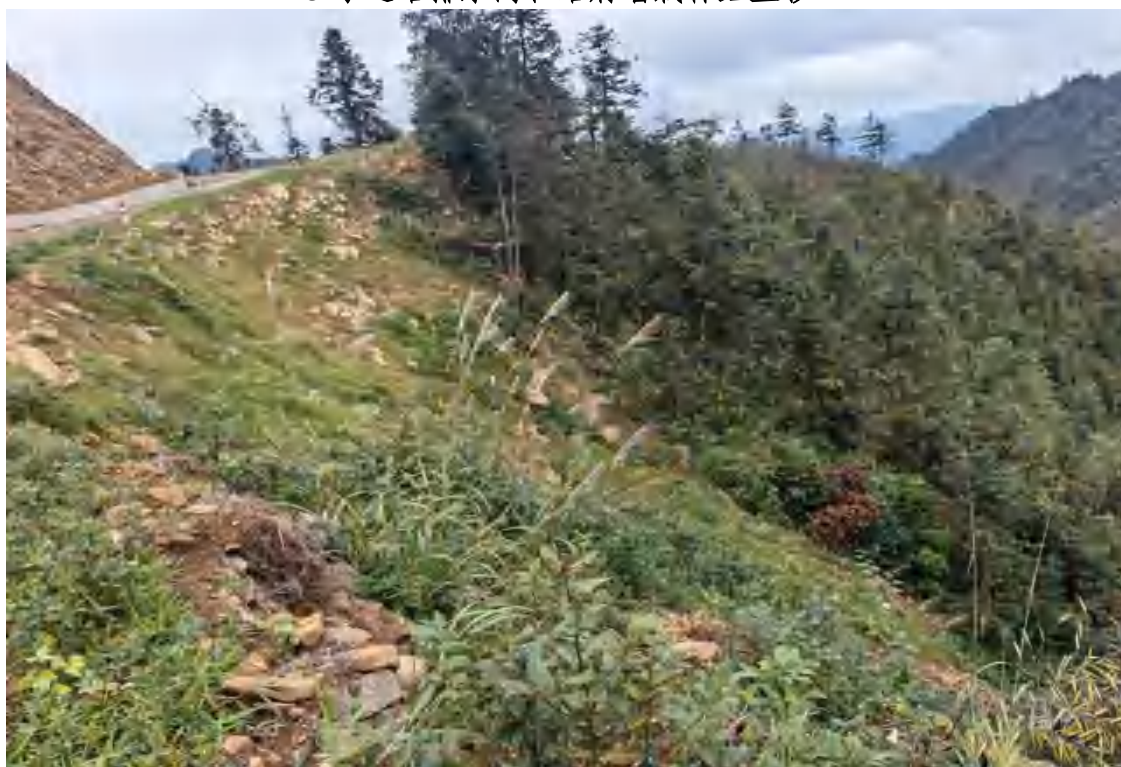
3 号道路下边坡植被建设情况
