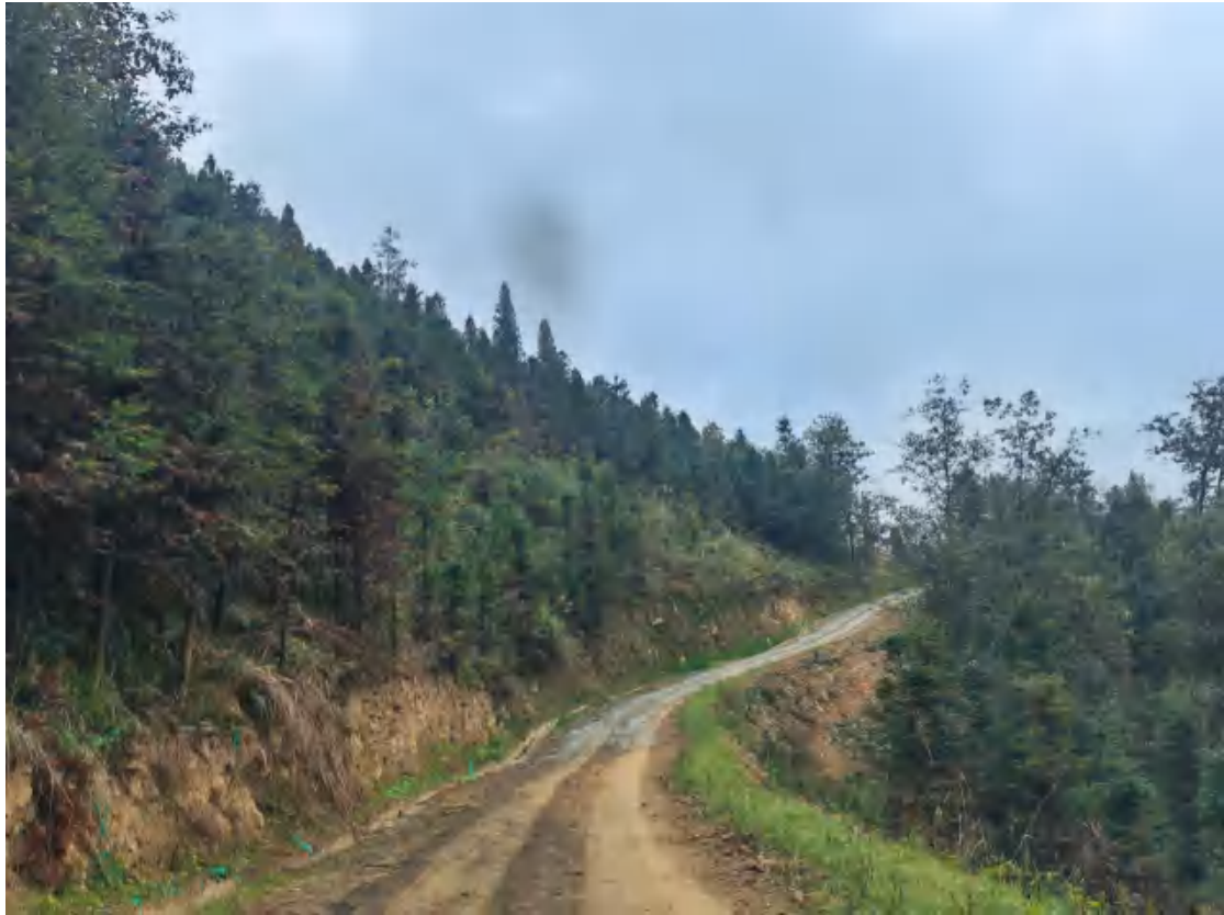
8号道路排水沟、上边坡喷播植草和裸露区域植被恢复效果图
