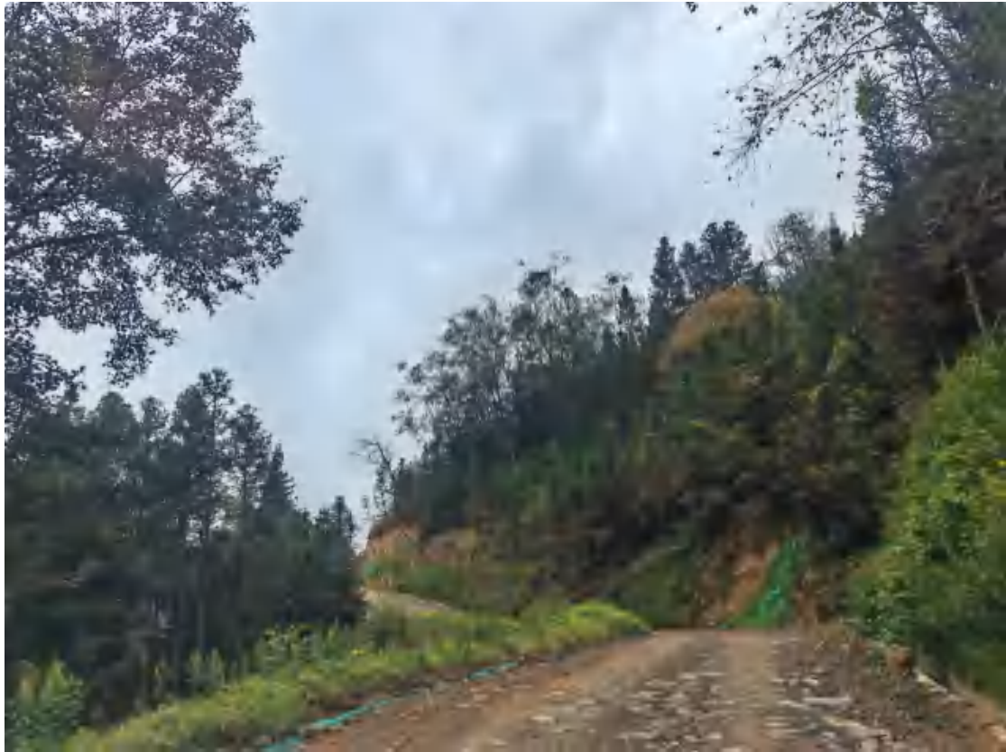
8号道路上边坡喷播植草、排水沟和裸露区域植被恢复效果图
