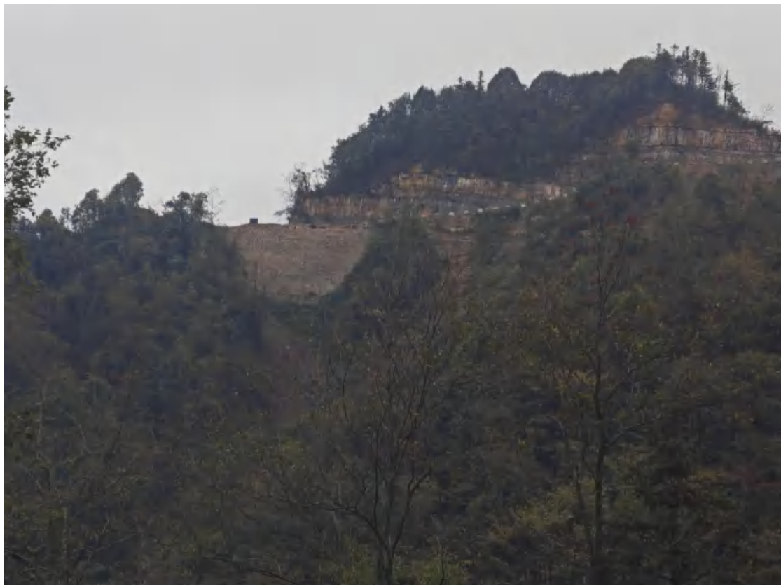
8号道路填方区修建挡土墙
