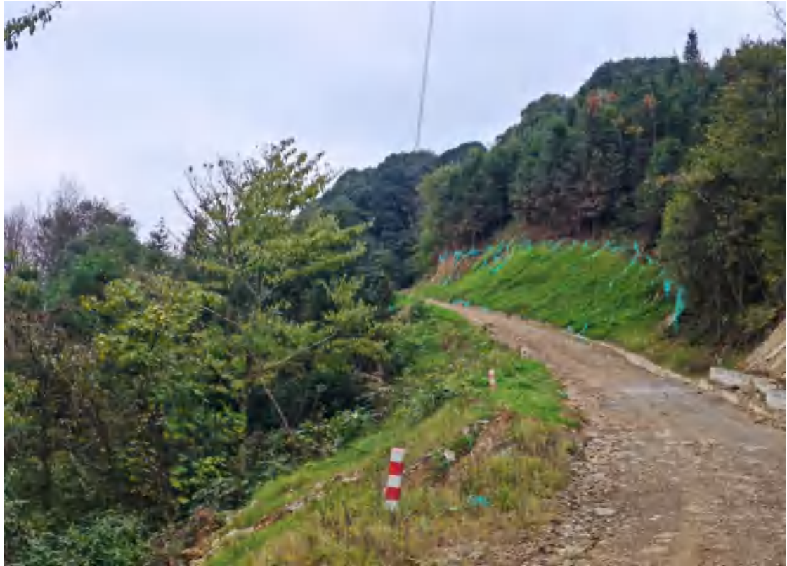
3号道路路肩墙栽种红豆杉、排水沟和上边坡喷播植草
