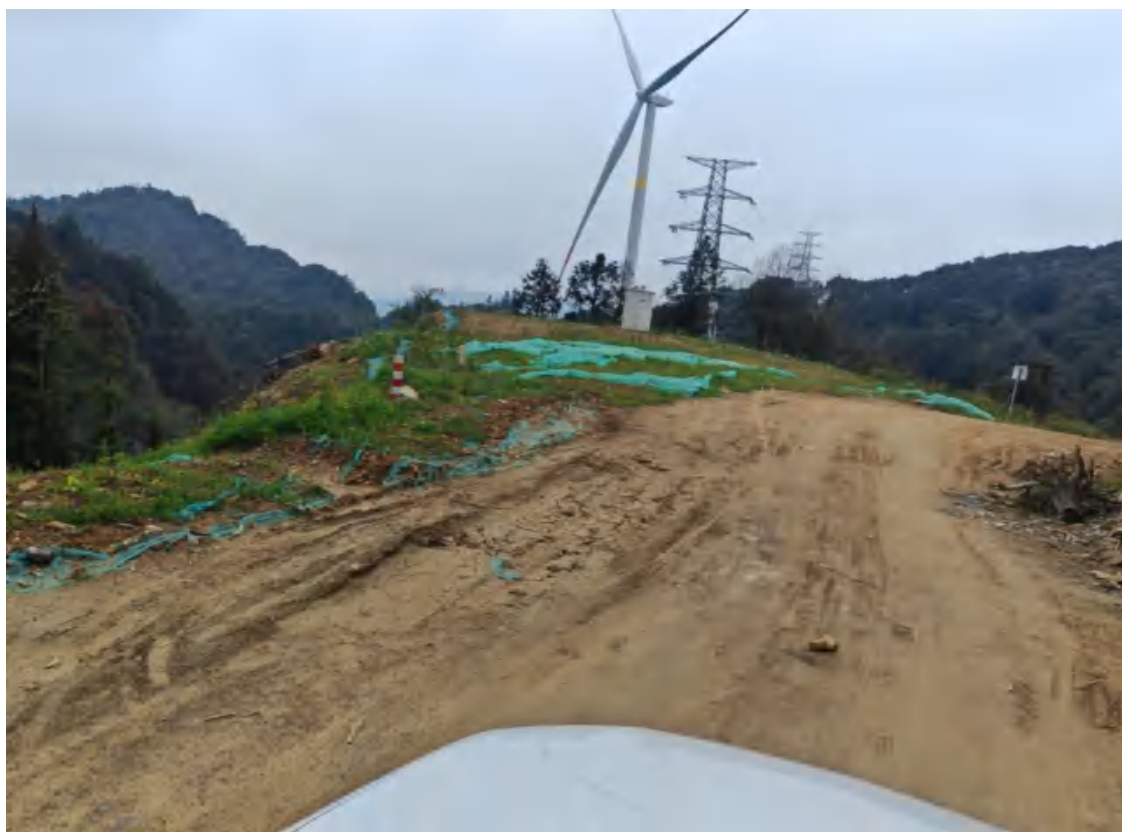
6号道路路肩墙栽种红豆杉和裸露地表植被建设（临时堆放材料）
