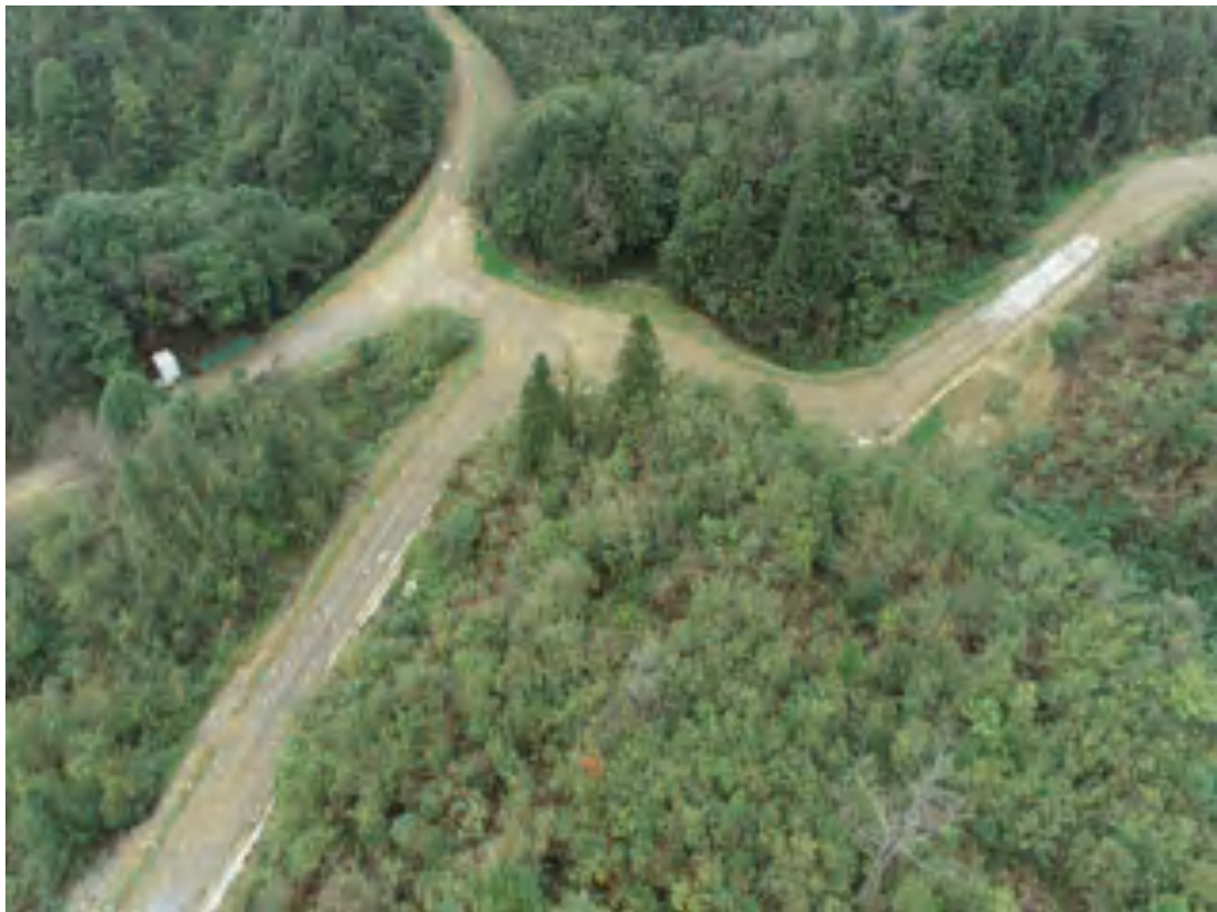
12 号道路排水沟、上边坡喷播植草和裸露区域、下边坡植被恢复效果图
