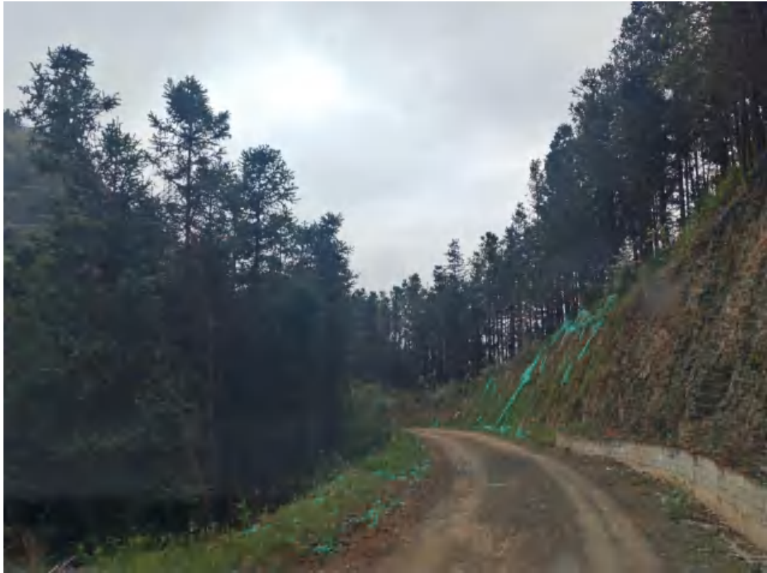
9号道路上边坡喷播植草、修建植草槽悬挂植物攀爬网栽种爬藤植物和裸露区域植被恢复效果图
