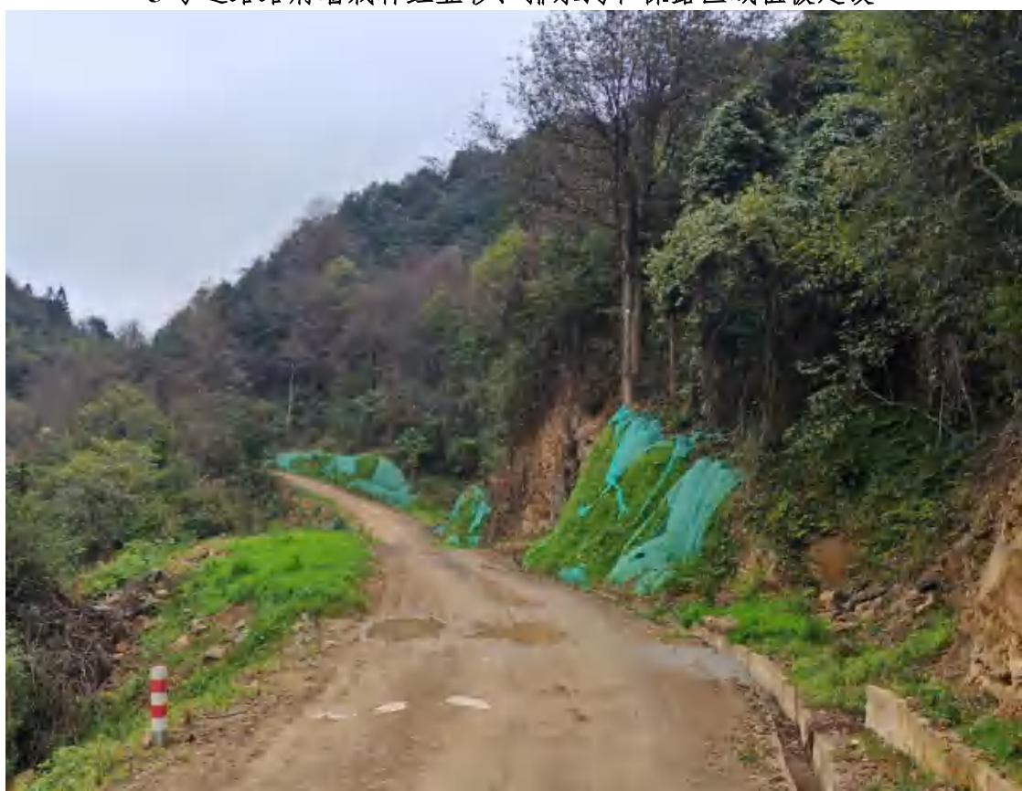
5号道路路肩墙栽种红豆杉、排水沟、裸露区域植被建设和上边坡喷播植草
