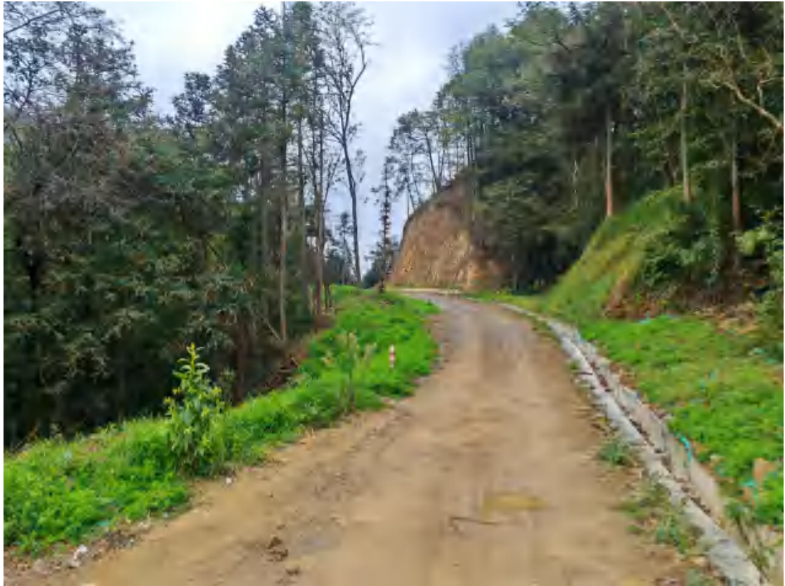
6号道路栽种红豆杉、排水沟、上边坡植物槽、喷播植草和下边坡植被建设
