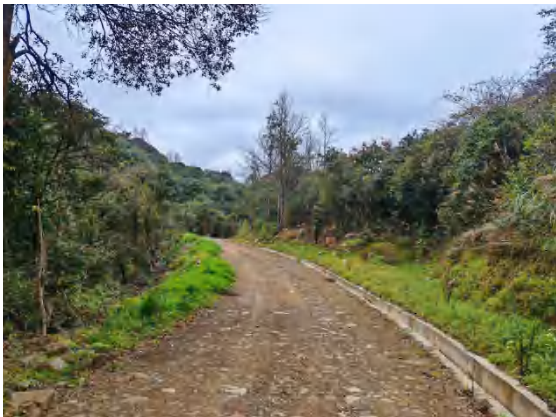
5号道路路肩墙栽种红豆杉、排水沟和裸露区域植被建设
