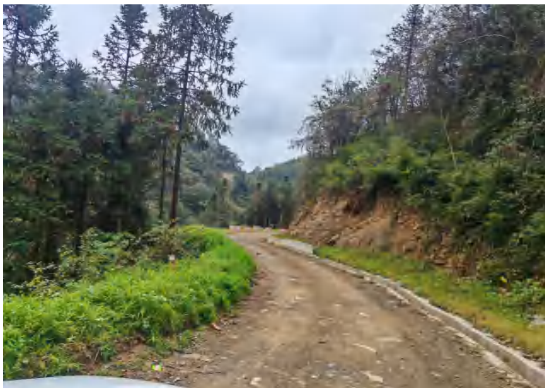
2号道路排水沟、植物槽和植被建设
