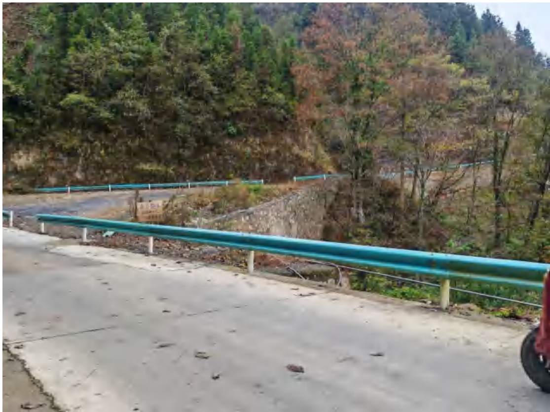
改扩建道路填方区修建挡土墙和植被恢复情况
