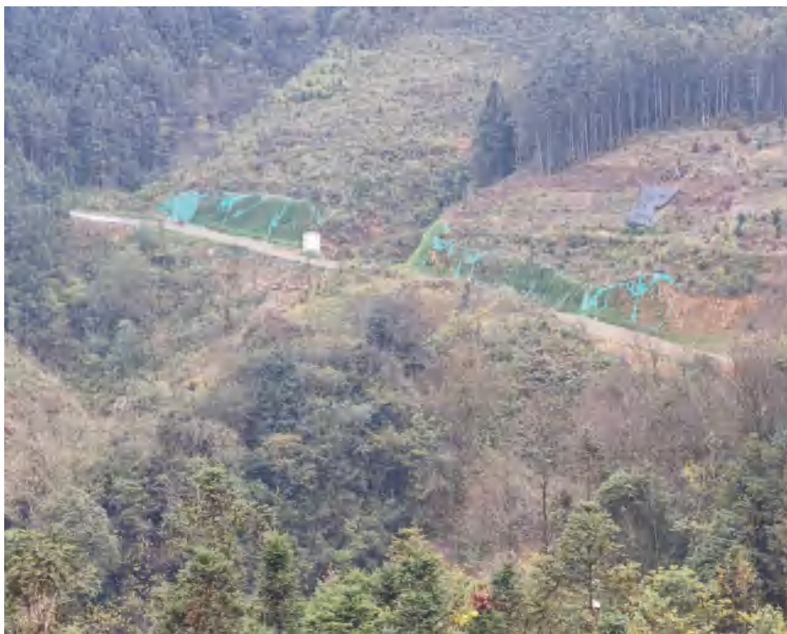
3号道路上边坡喷播植草
