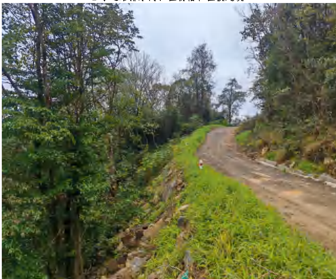
2号道路排水沟裸露区域植被建设
