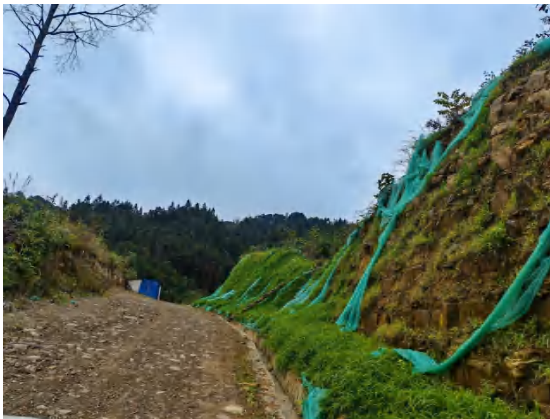
3号道路上边坡喷播植草和排水沟
