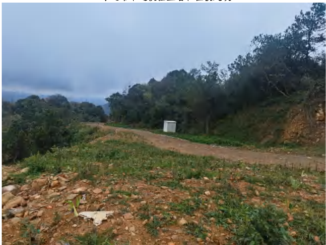
2号道路排水沟和植被建设
