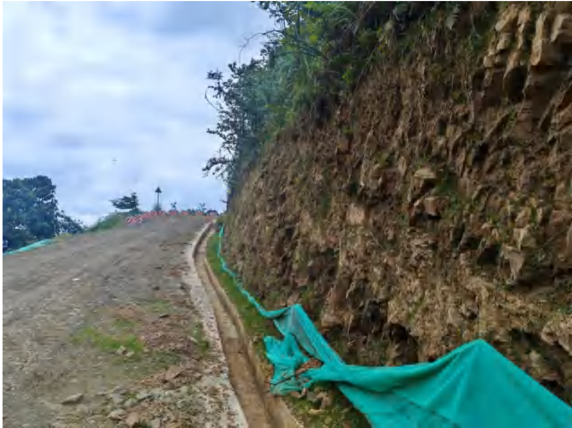
12 号道路排水沟、上边坡喷播植草
