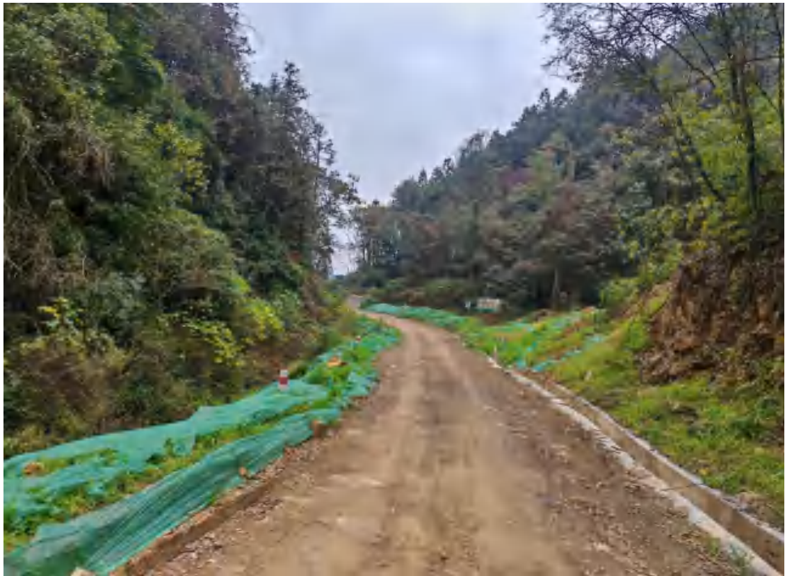
4号道路路肩墙栽种红豆杉、排水沟、裸露地表植被建设
