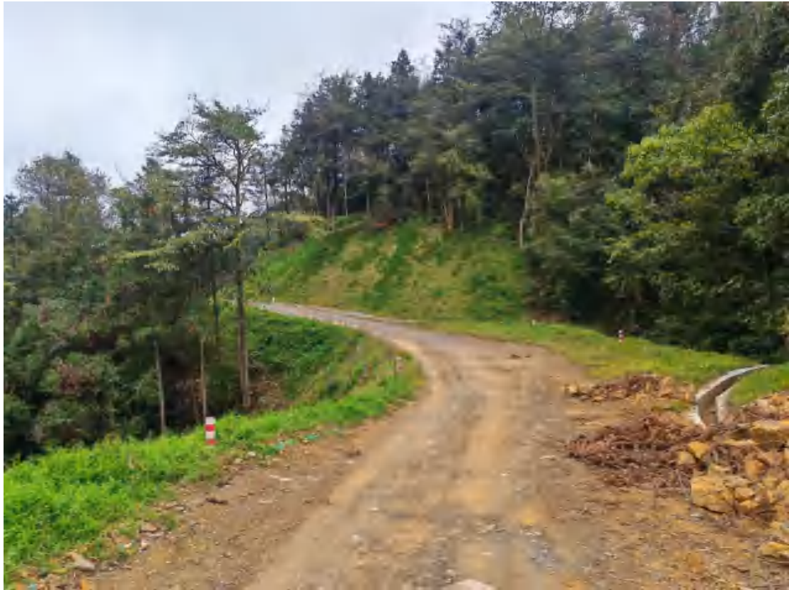
6号道路栽种红豆杉、排水沟、上边坡喷播植草和下边坡植被建设
