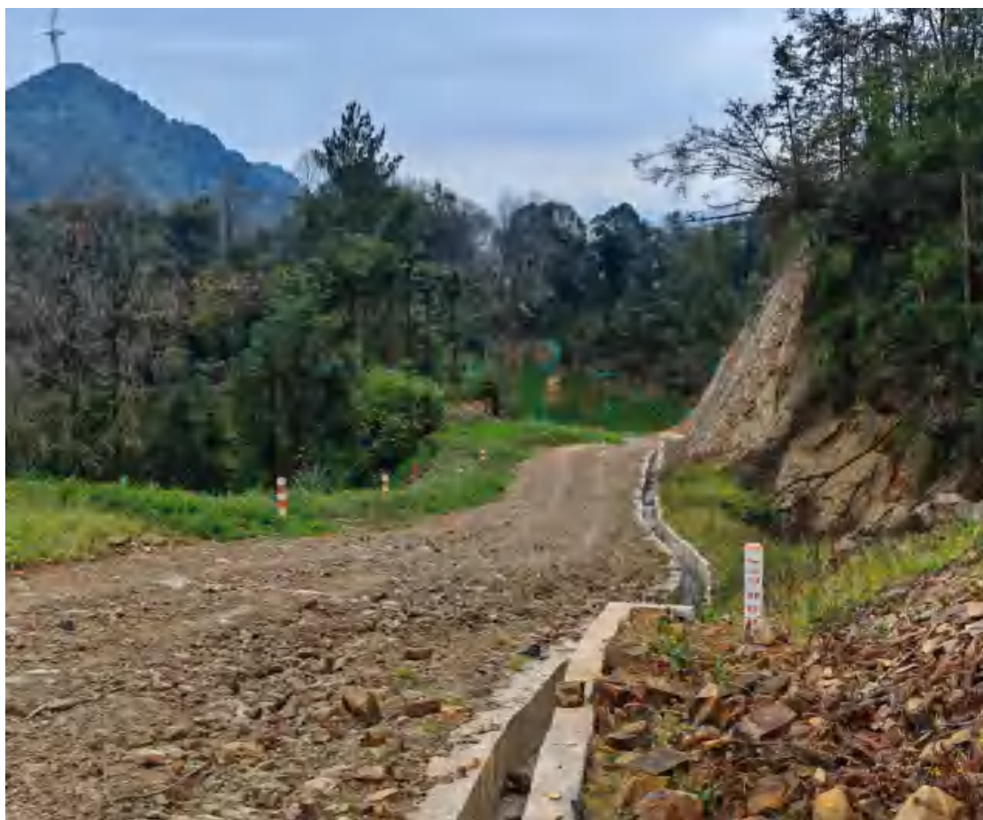
3 号道路排水沟和路肩墙栽种红豆杉
