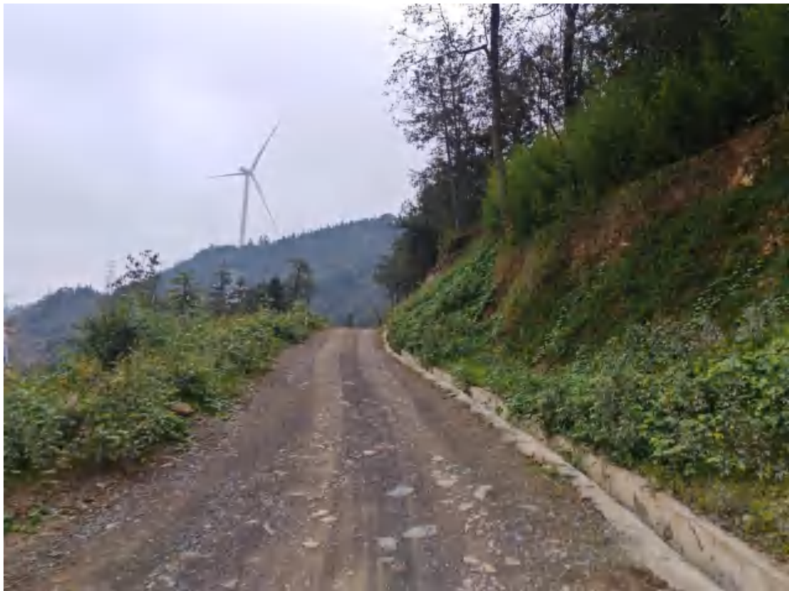
6号道路栽种红豆杉、排水沟、上边坡喷播植草和裸露地表植被建设
