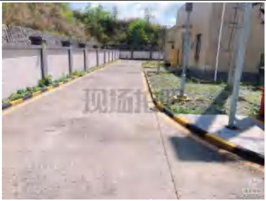
场内硬化道路
