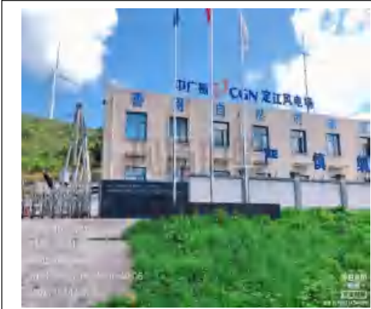
贵定县擦耳山风电场 220kV 升压站
