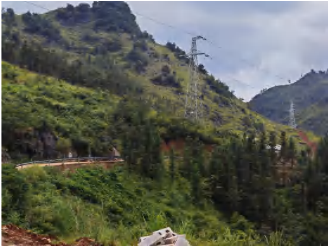
架空线路植被建设情况（2023.0.9.22）
