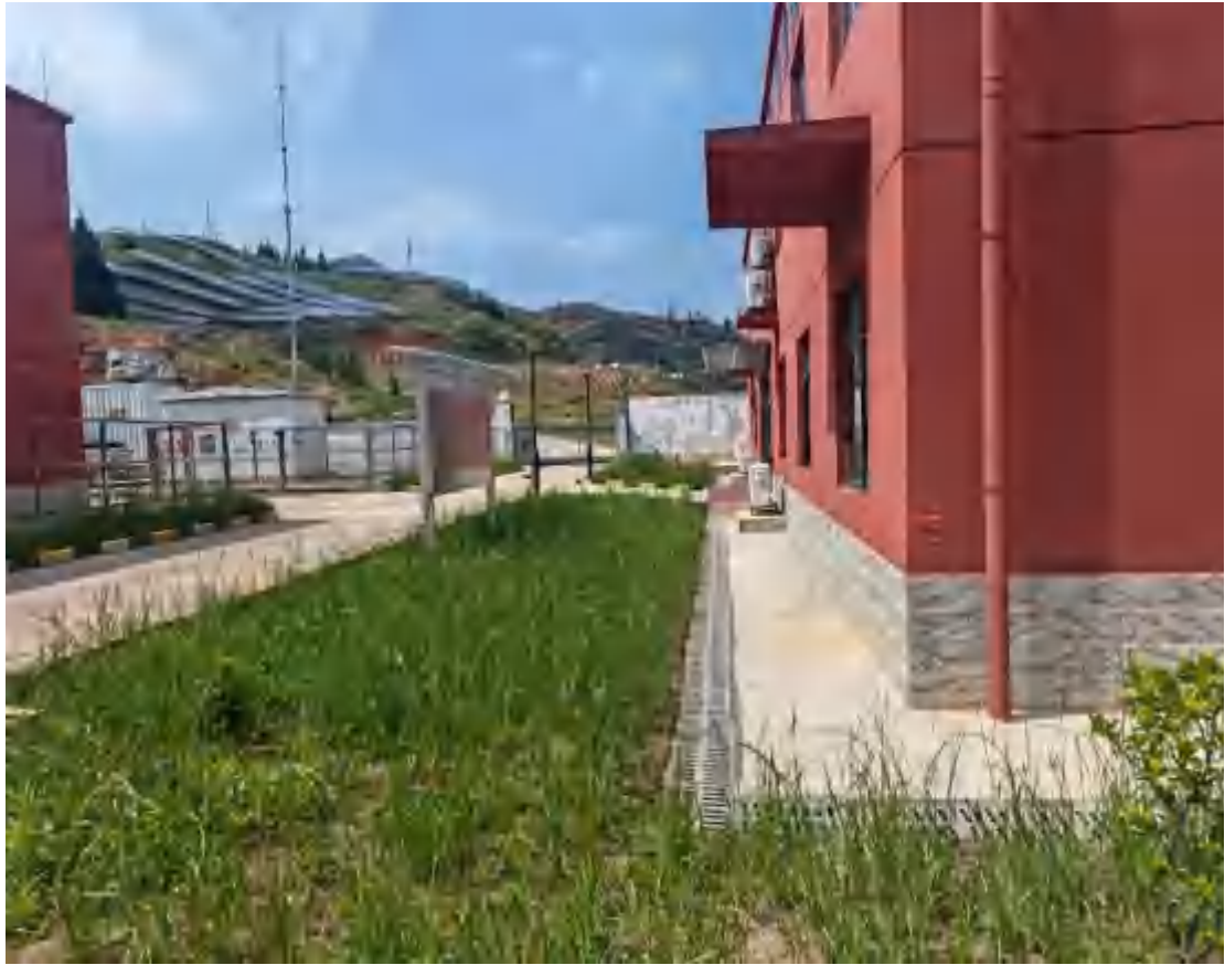
升压站排水系统和植被建设情况（近照）（2024.05.14）
