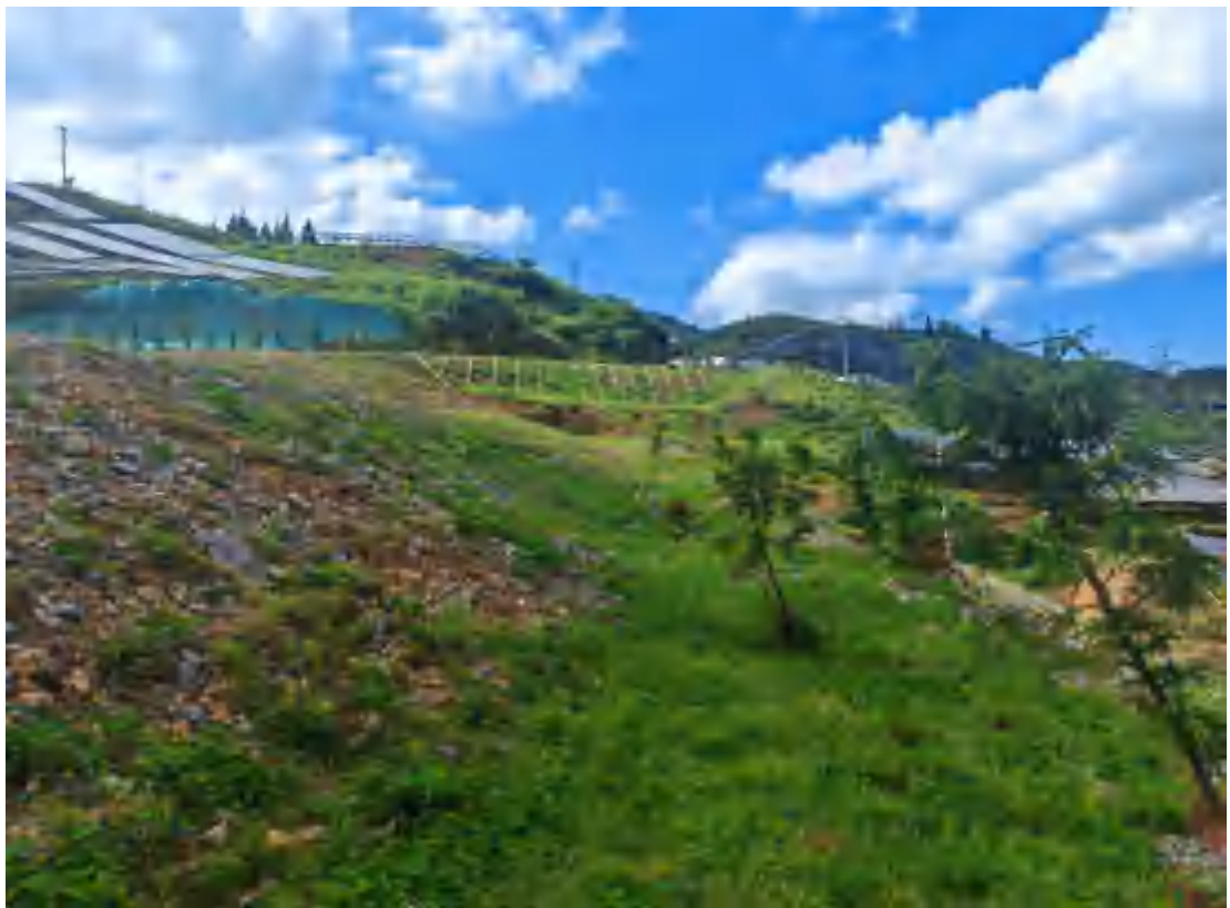
A 地块光伏道路区排水沟和光伏区植被建设情况（2024.07.15）
