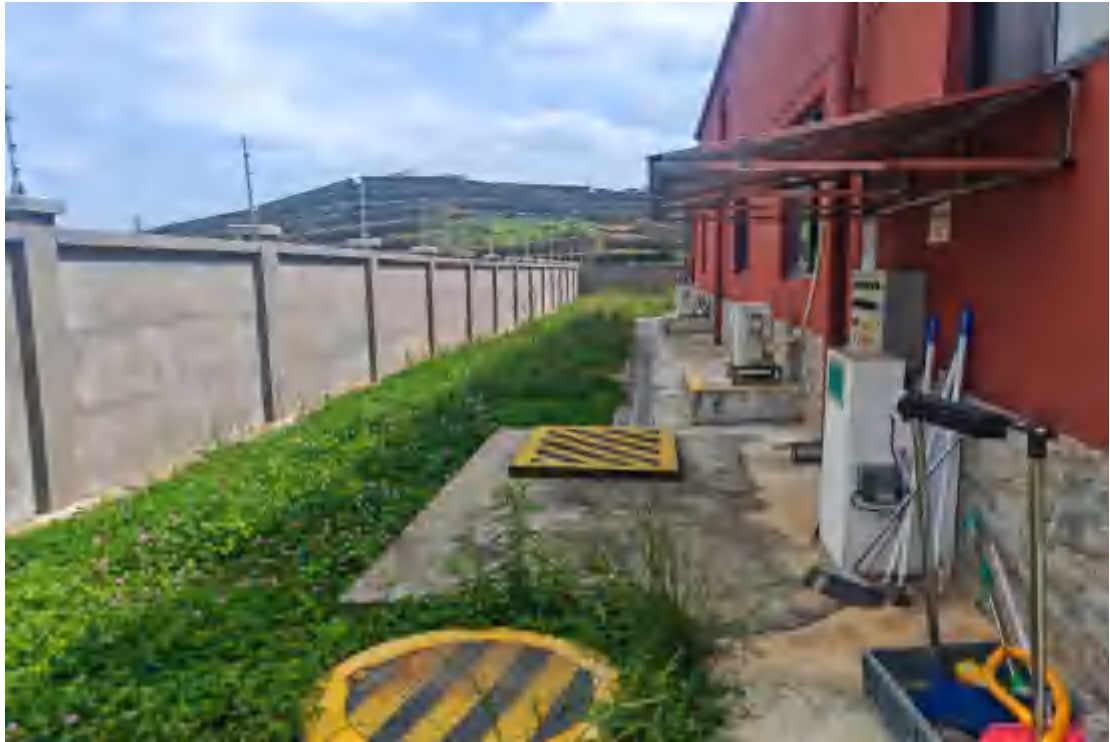
升压站排水系统和植被建设情况（近照）（2024.05.14）
