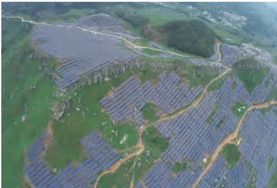
C 地块植被建设情况（2024.06.18）
