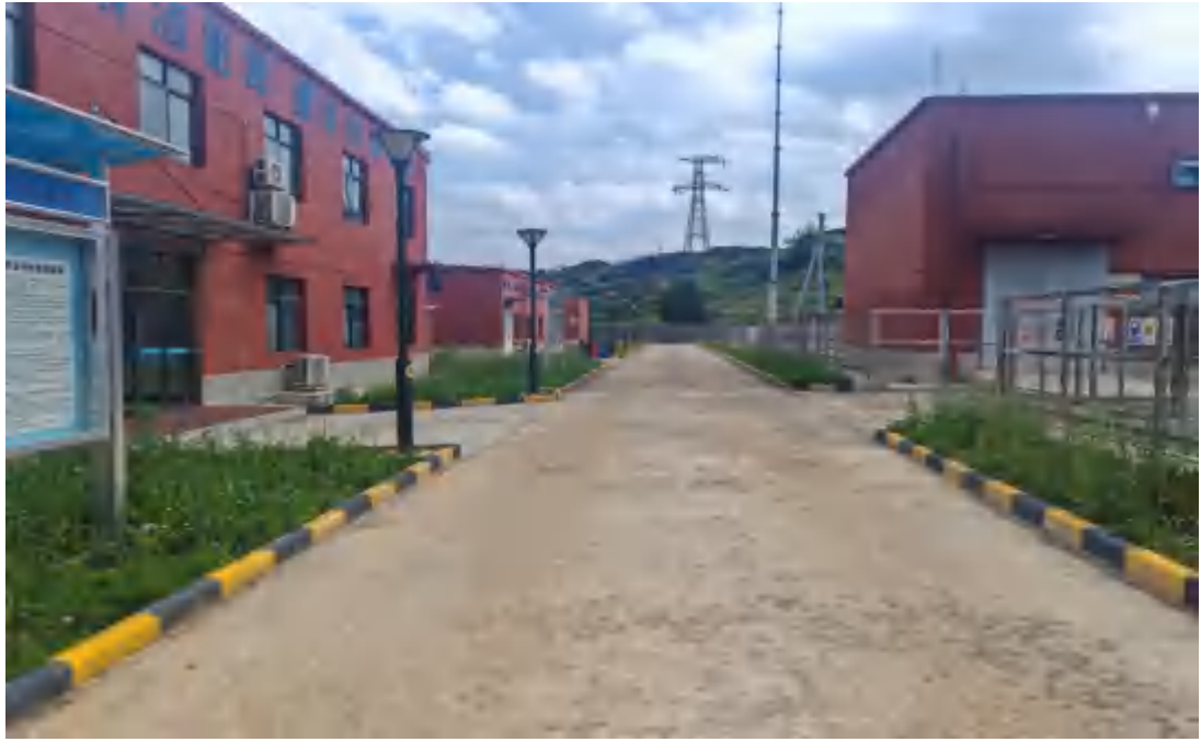
升压站植被建设情况（2024.05.14）
