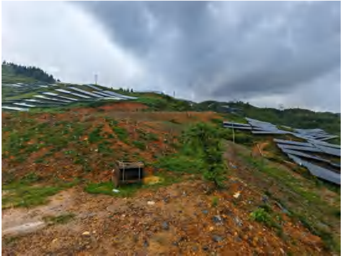
进场道路已建综合护坡、覆土整治和植被建设情况（2023.07.28）
