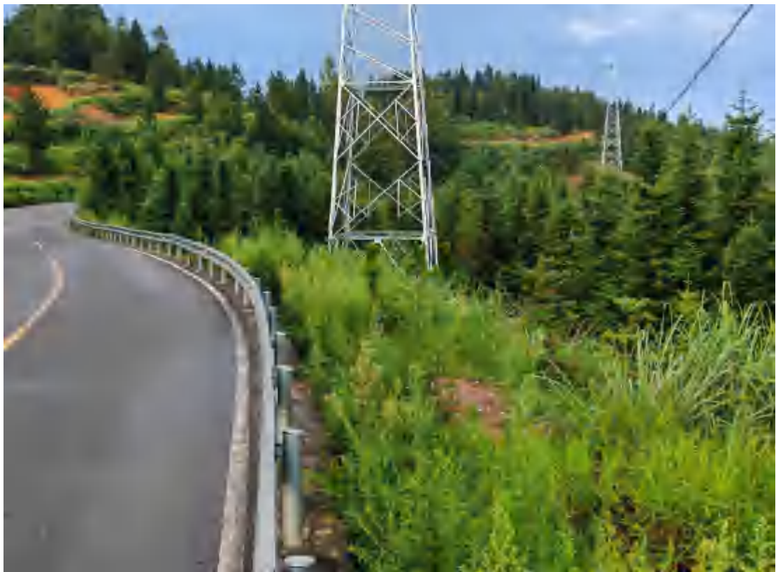
架空线路植被建设情况（2023.07.28）
