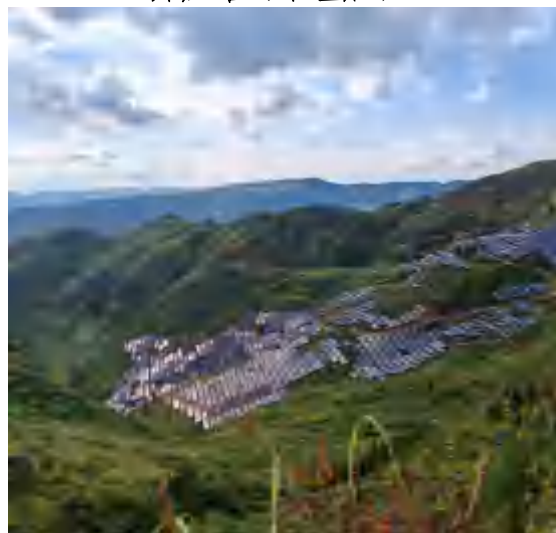
升压站（治理后）
