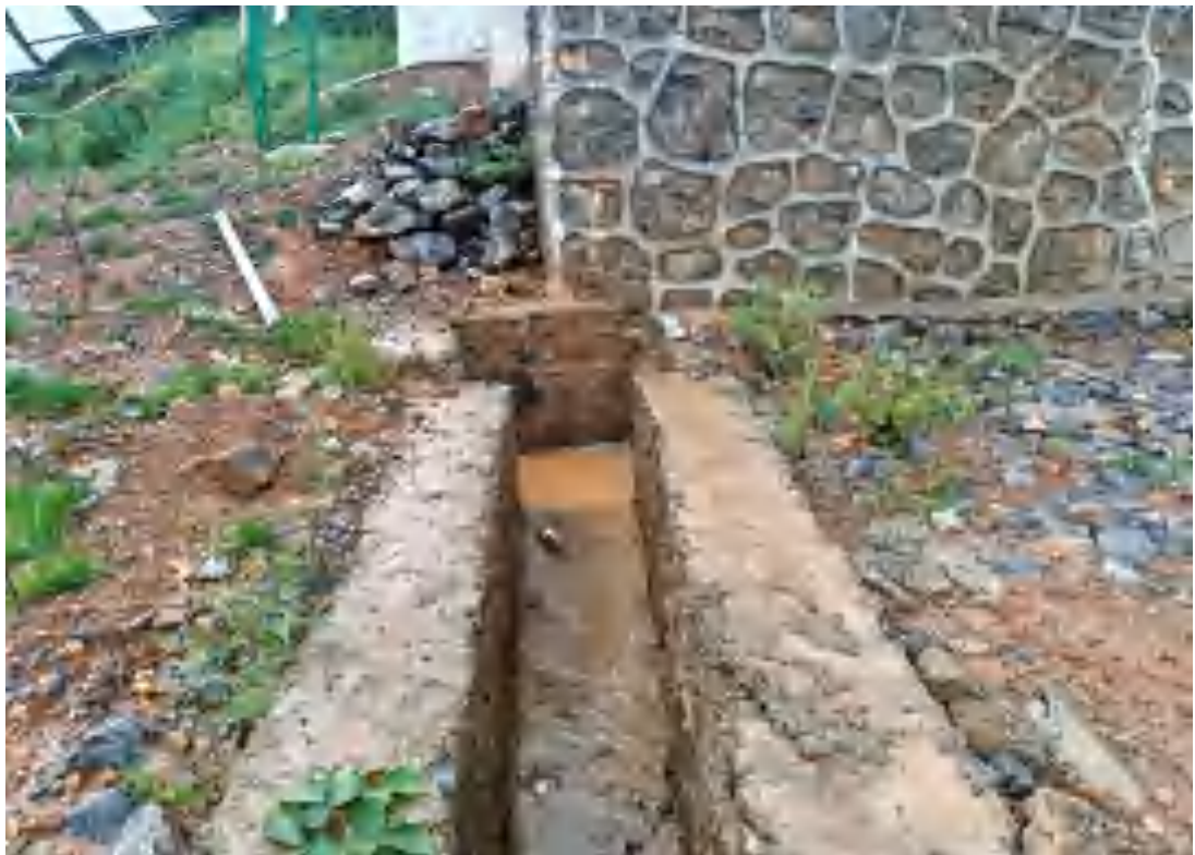
进场道路排水系统（沉沙池）（2023.07.28）
