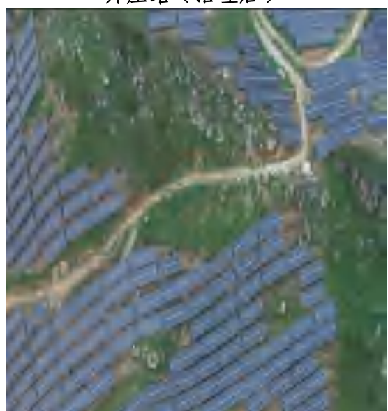
光伏道路上、下边坡（治理前）
