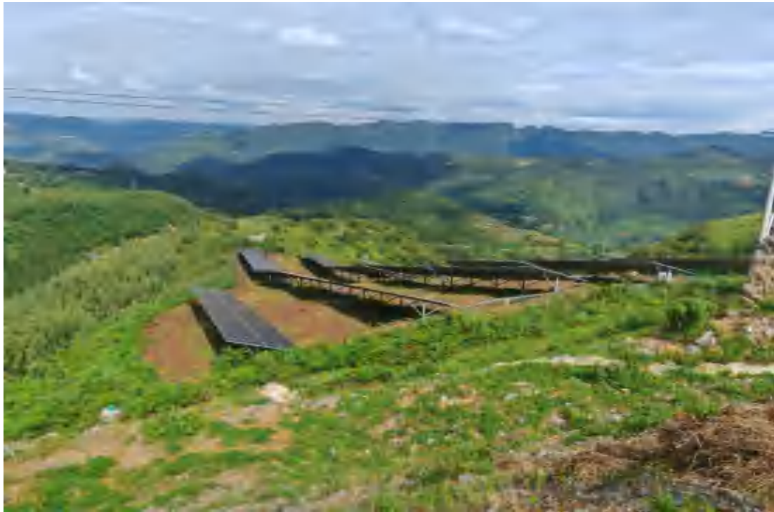
C 地块植被建设情况（2024.07.15）
