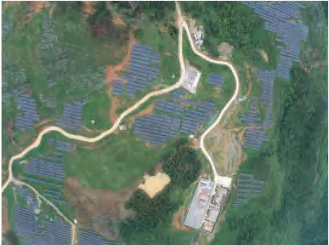
升压站周边植被建设情况（2024.06.18）
