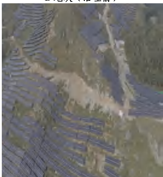
光伏道路上、下边坡（治理前）
