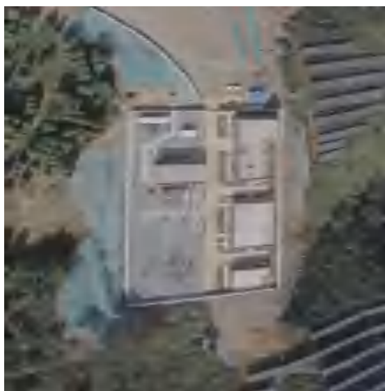
升压站（治理前）
