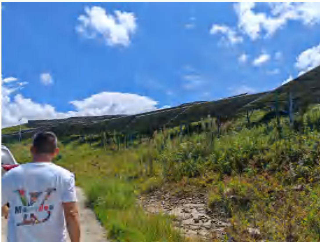
C 地块植被建设情况（2024.08.11）
