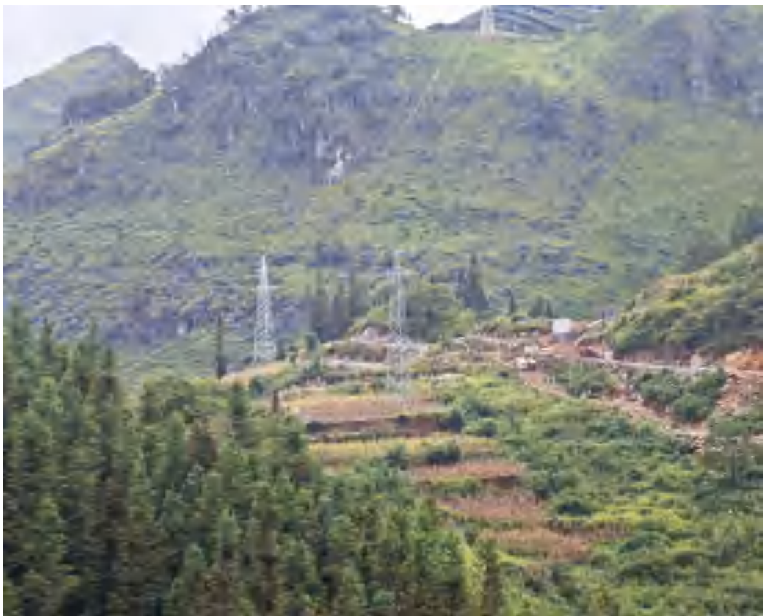
架空线路植被建设情况（2023.09.22）
