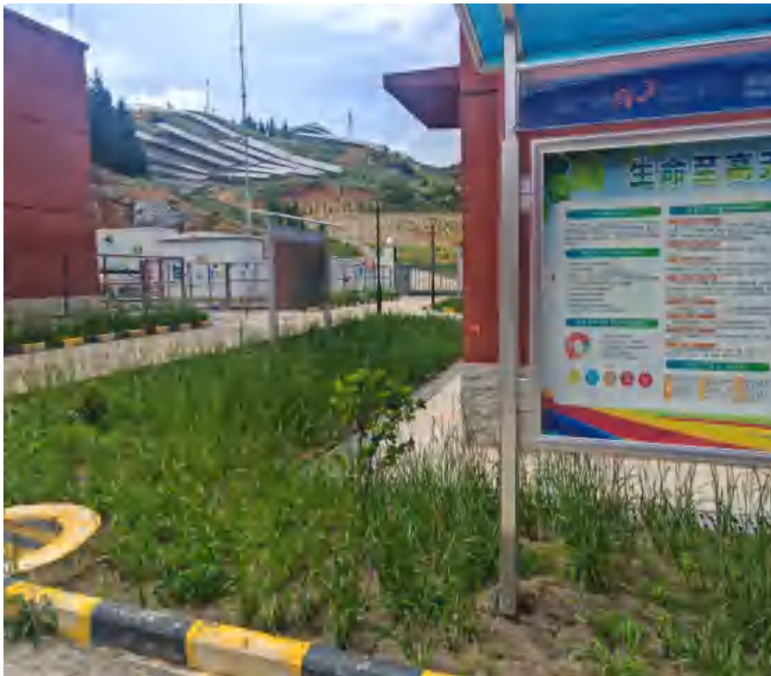
升压站植被建设情况（2024.05.14）
