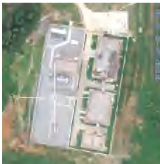
升压站（治理后）
