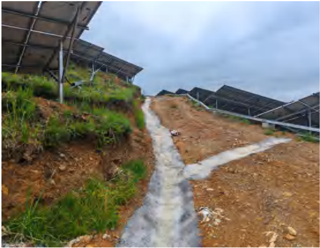
A 地块光伏道路区排水沟和光伏区植被建设情况（近照）（2024.05.14）
