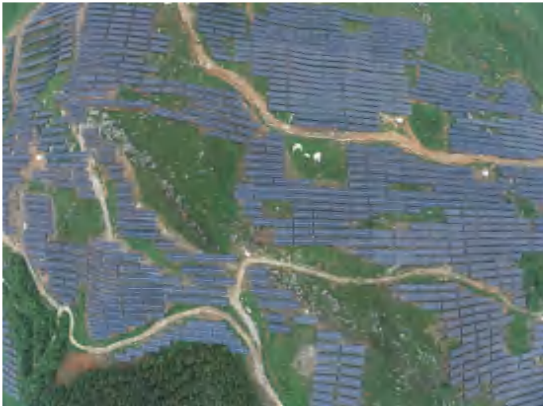
C 地块植被建设情况（2024.06.18）
