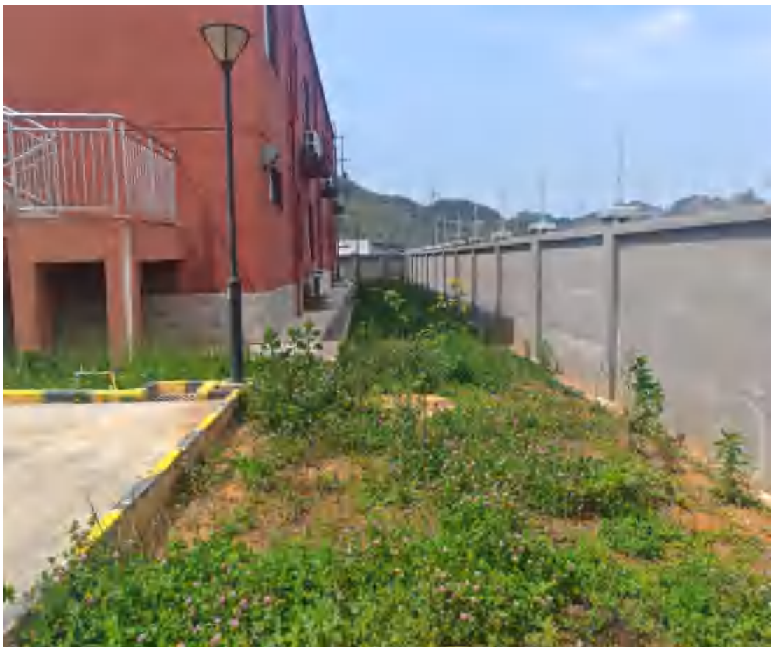
升压站排水系统和植被建设情况（近照）（2024.05.14）
