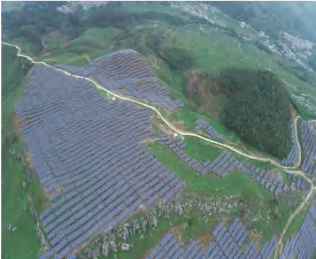
C 地块植被建设情况（2024.06.18）
