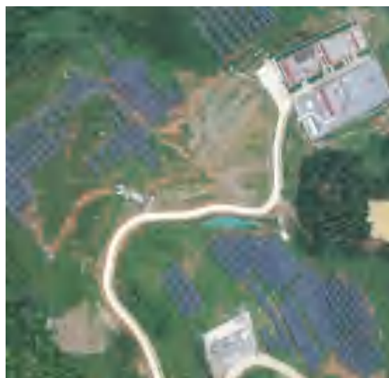
进场道路（治理后）
