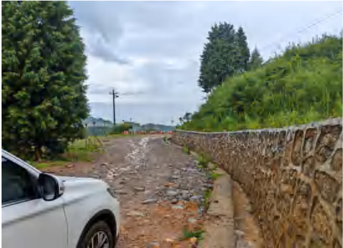
进场道路挡土墙（2023.07.28）
