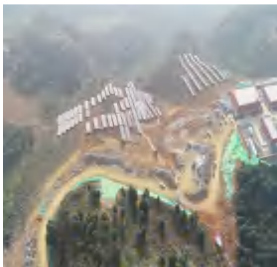
进场道路（治理前）
