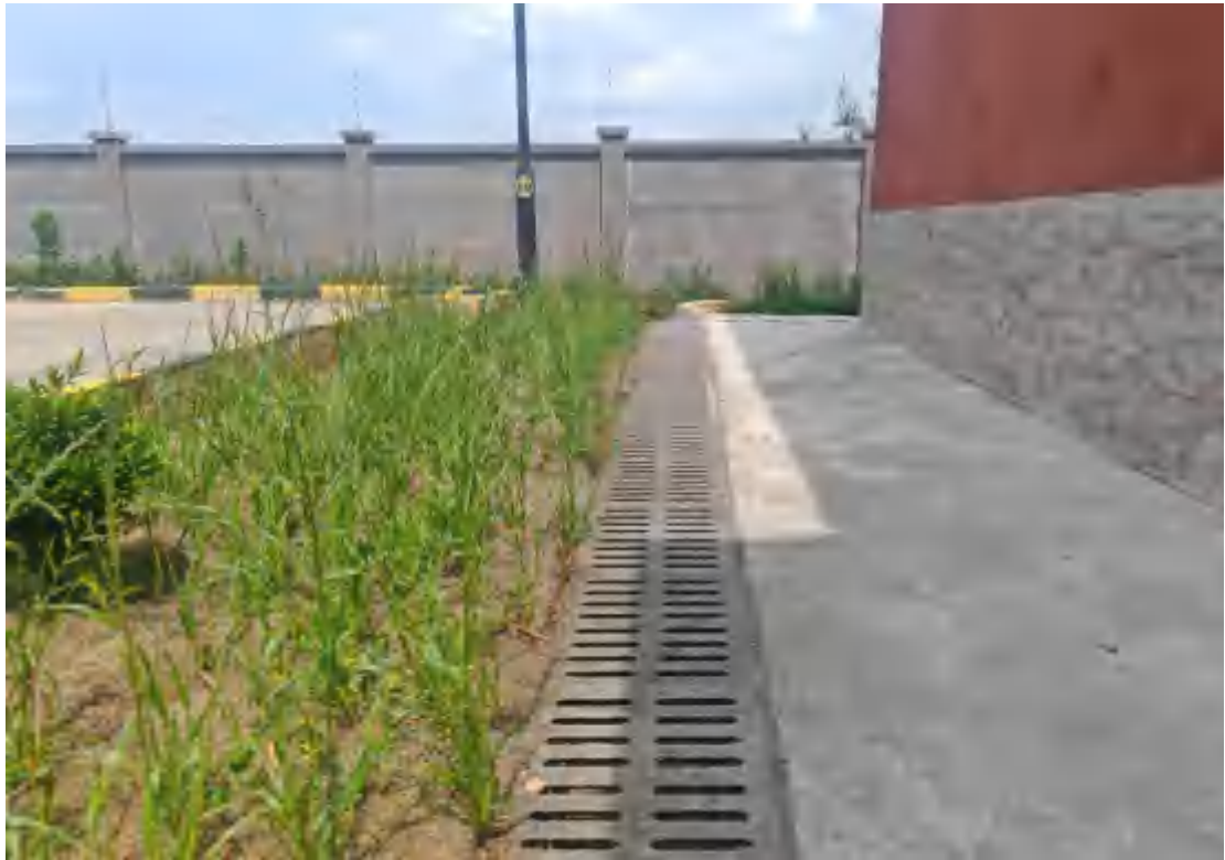
升压站排水系统和植被建设情况（2024.05.14）
