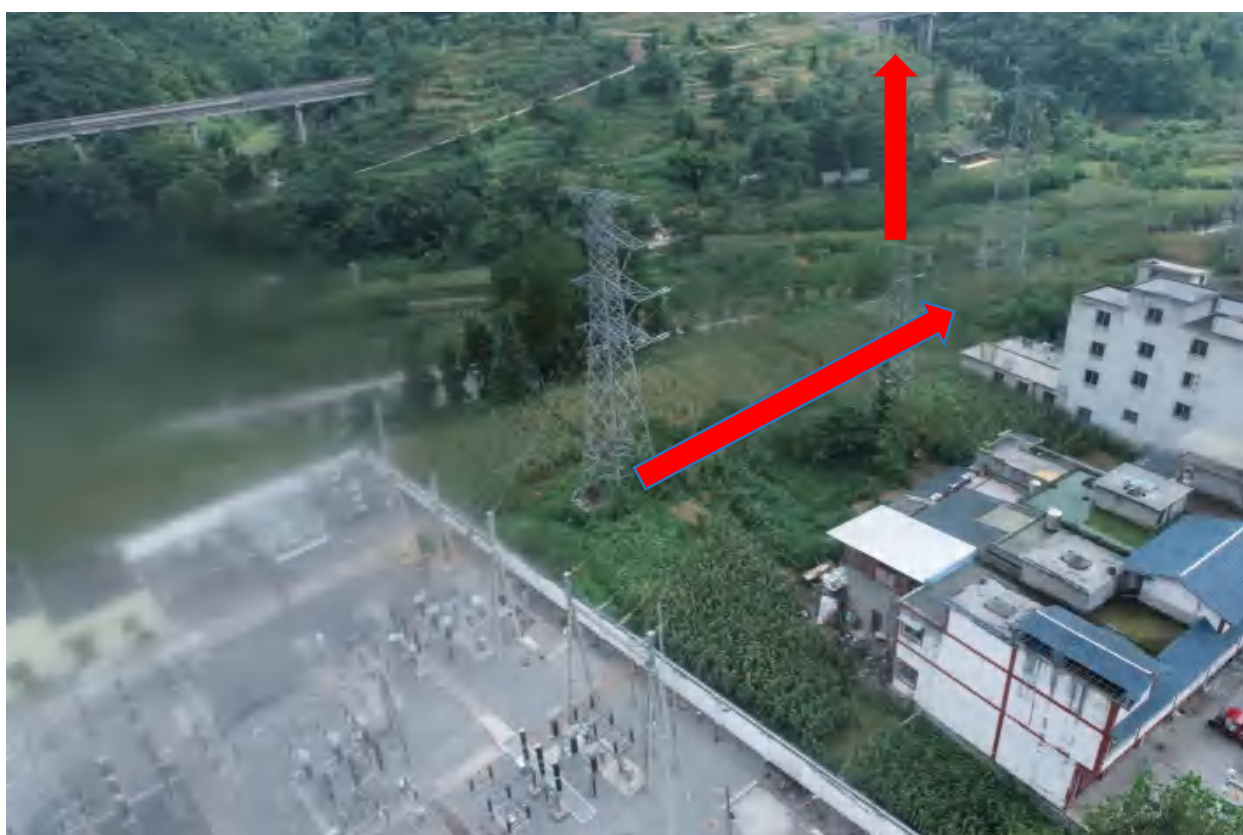
夜温线（变电站）塔基治理效果图
