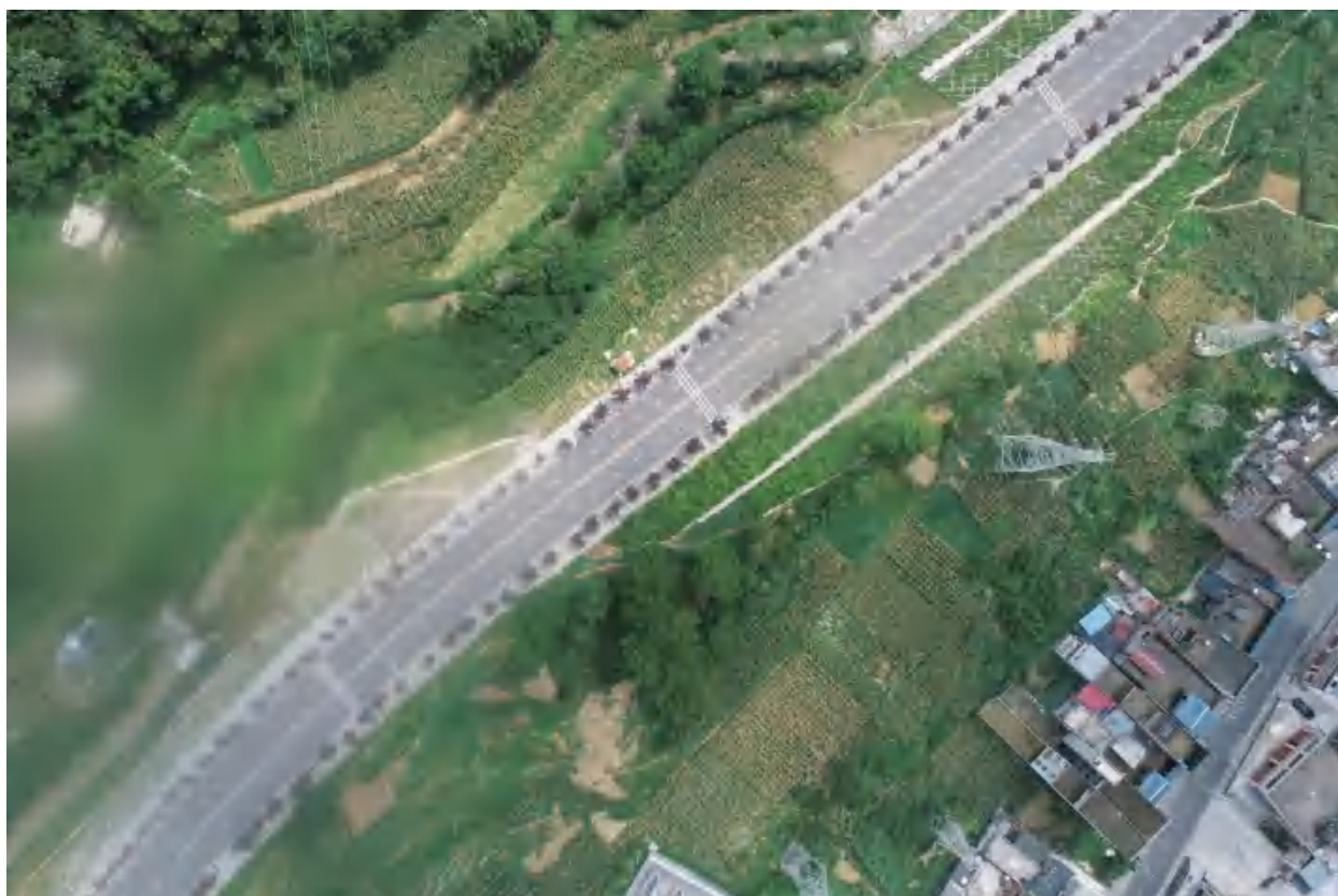
夜温线（变电站）塔基治理效果图
