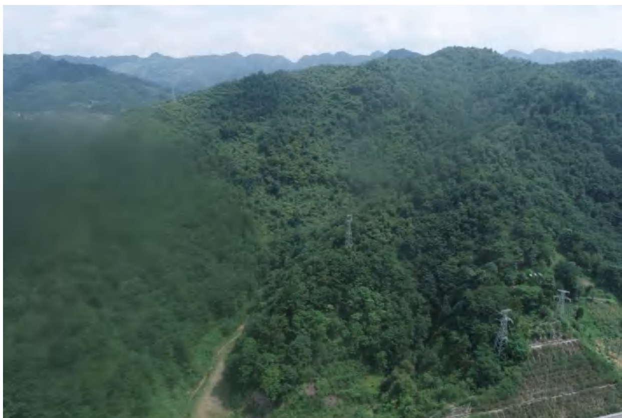
夜温线（变电站）塔基治理效果图
