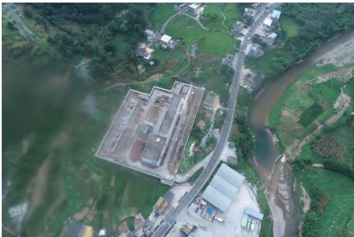
夜松、太线（变电站）塔基治理效果图
