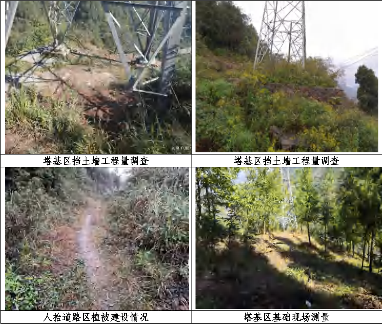
图 4.2-1 工程质量现场抽查照片
