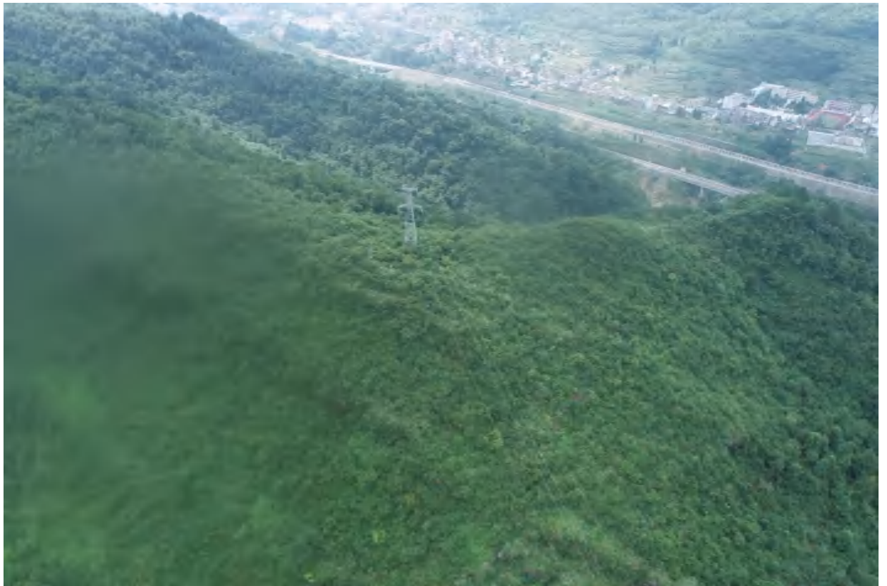
夜温线（变电站）塔基治理效果图
