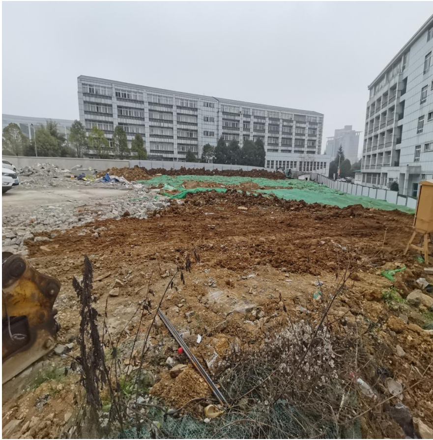
临时施工营地（治理前）
