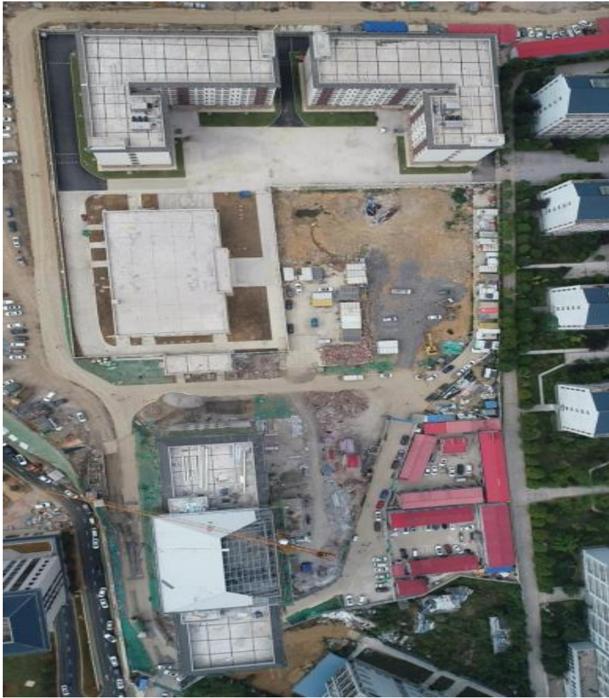
项目建设中（引用方案）
