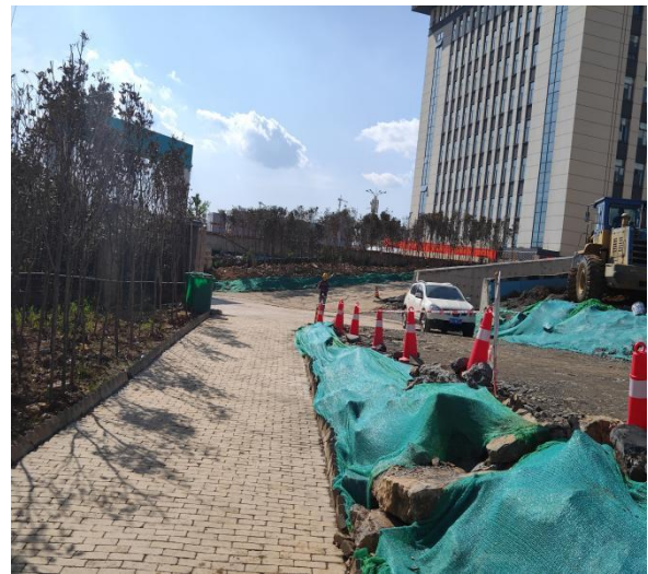
生活休闲区临时苫盖
