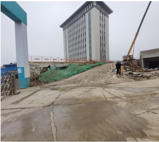
生活休闲区临时苫盖
