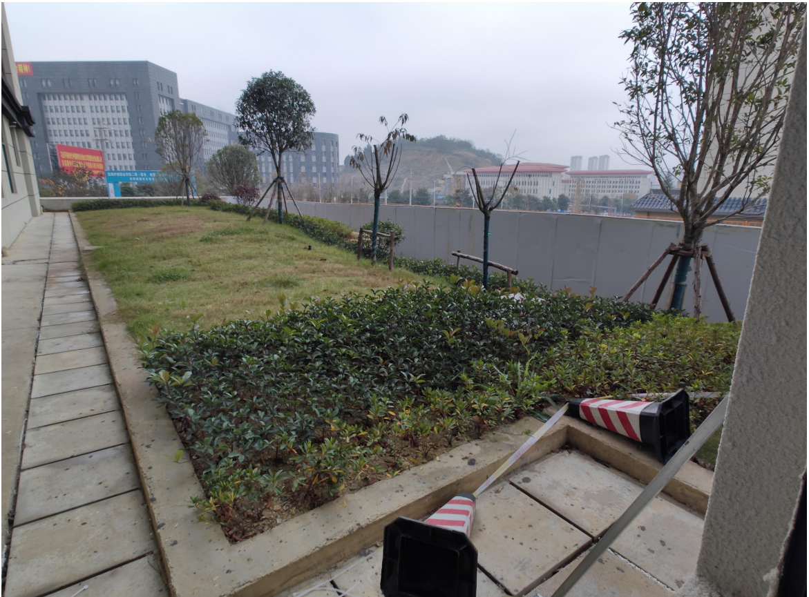
生活休闲区（植被建设及盖板排水管）
