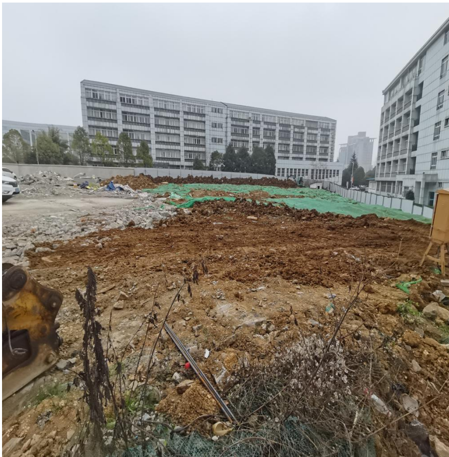
临时施工营地（治理前）
