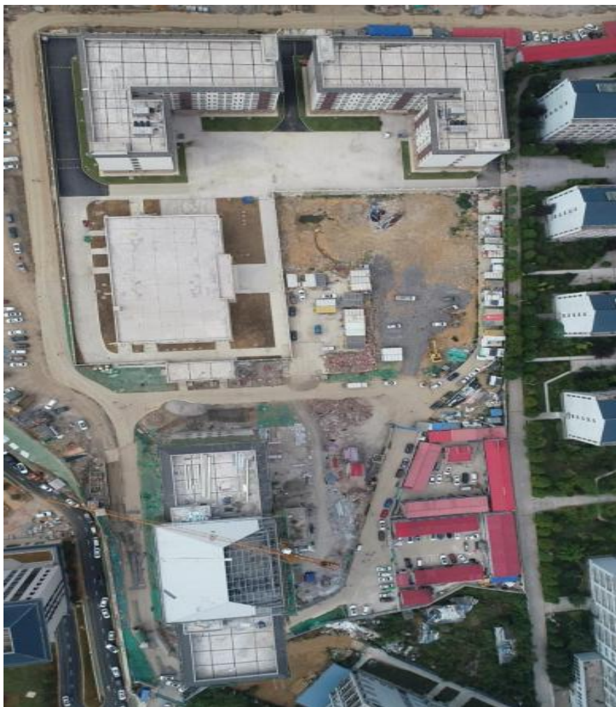
项目建设中（引用方案）
