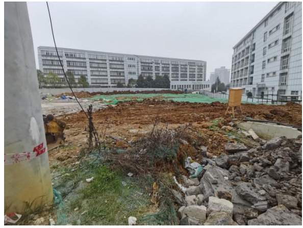
临时施工营地临时苫盖
