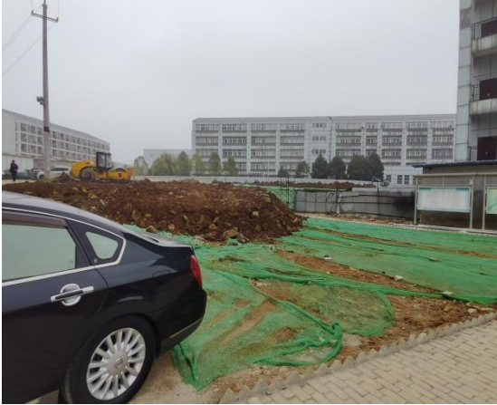
临时施工营地临时苫盖
