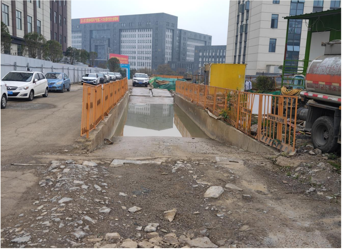
生活休闲区域（临时洗车槽及临时沉沙池）
