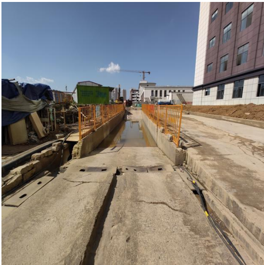
生活休闲区已修建临时洗车槽及沉沙池
