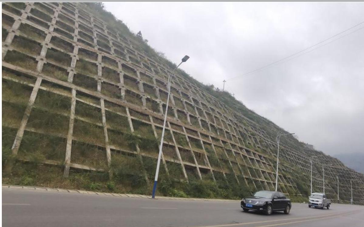
路基工程(区右侧坡骨架植草护坡)
