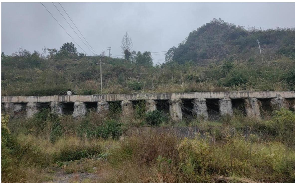
路基工程区(边坡拱形骨架植草护坡)
