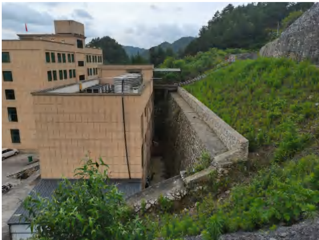
副井生产区主体挡土墙及植被建设
