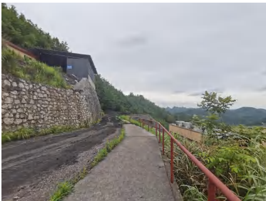
副井生产区主体挡土墙
