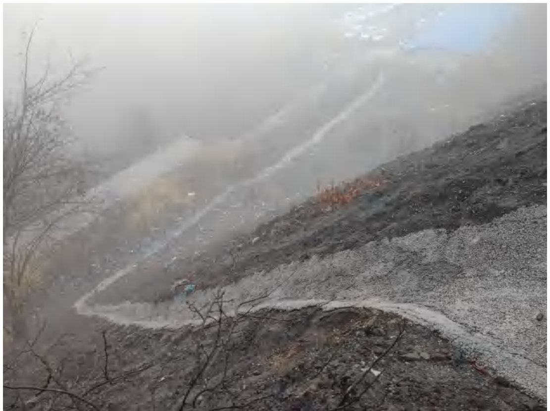
临时排矸场截水沟及挡土墙
