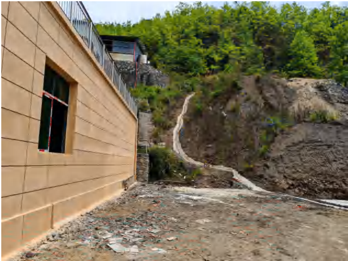
临时排矸场截水沟
