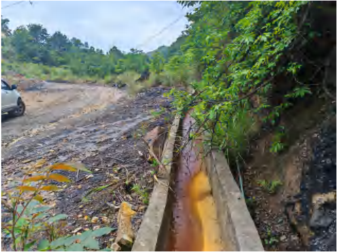
废弃场地排水沟
