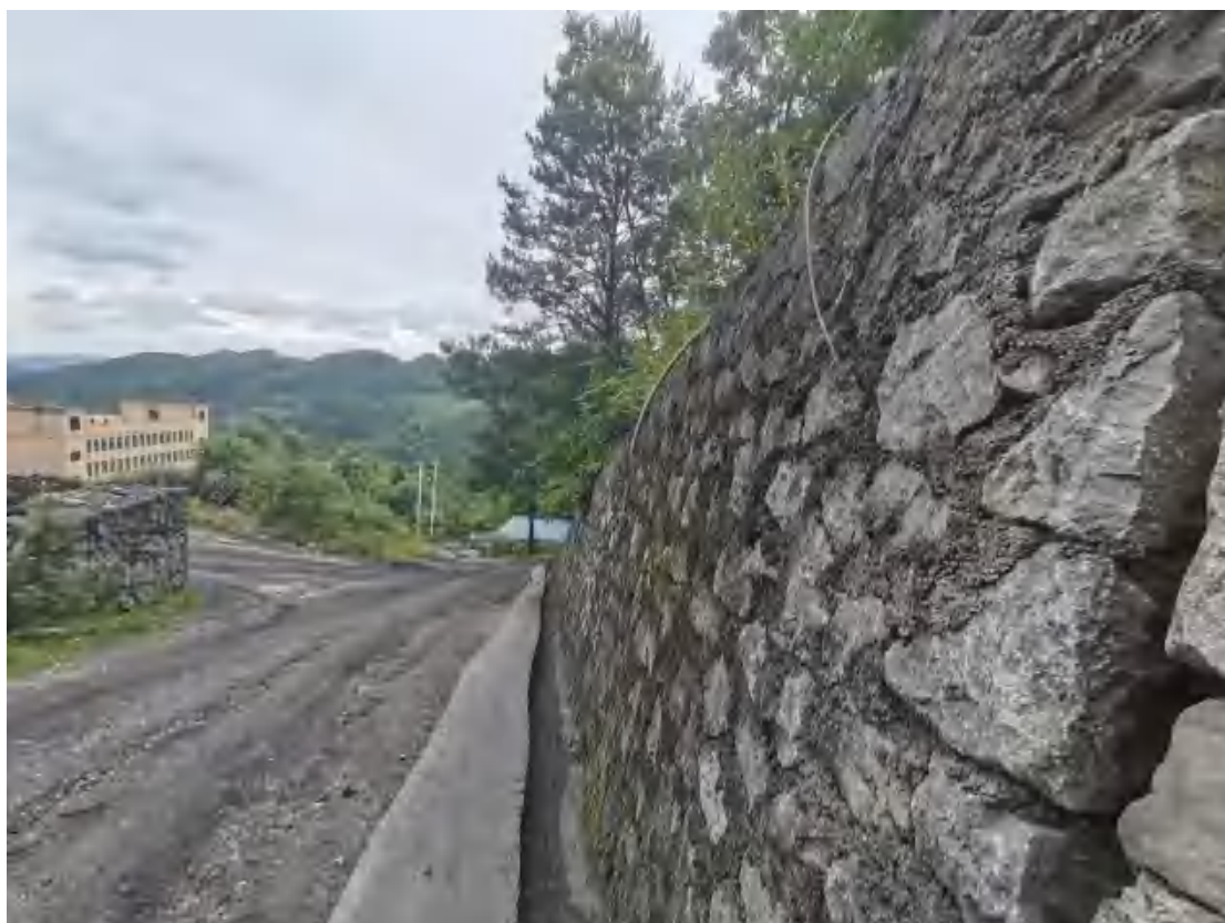
副井生产区排水系统及主体挡土墙
