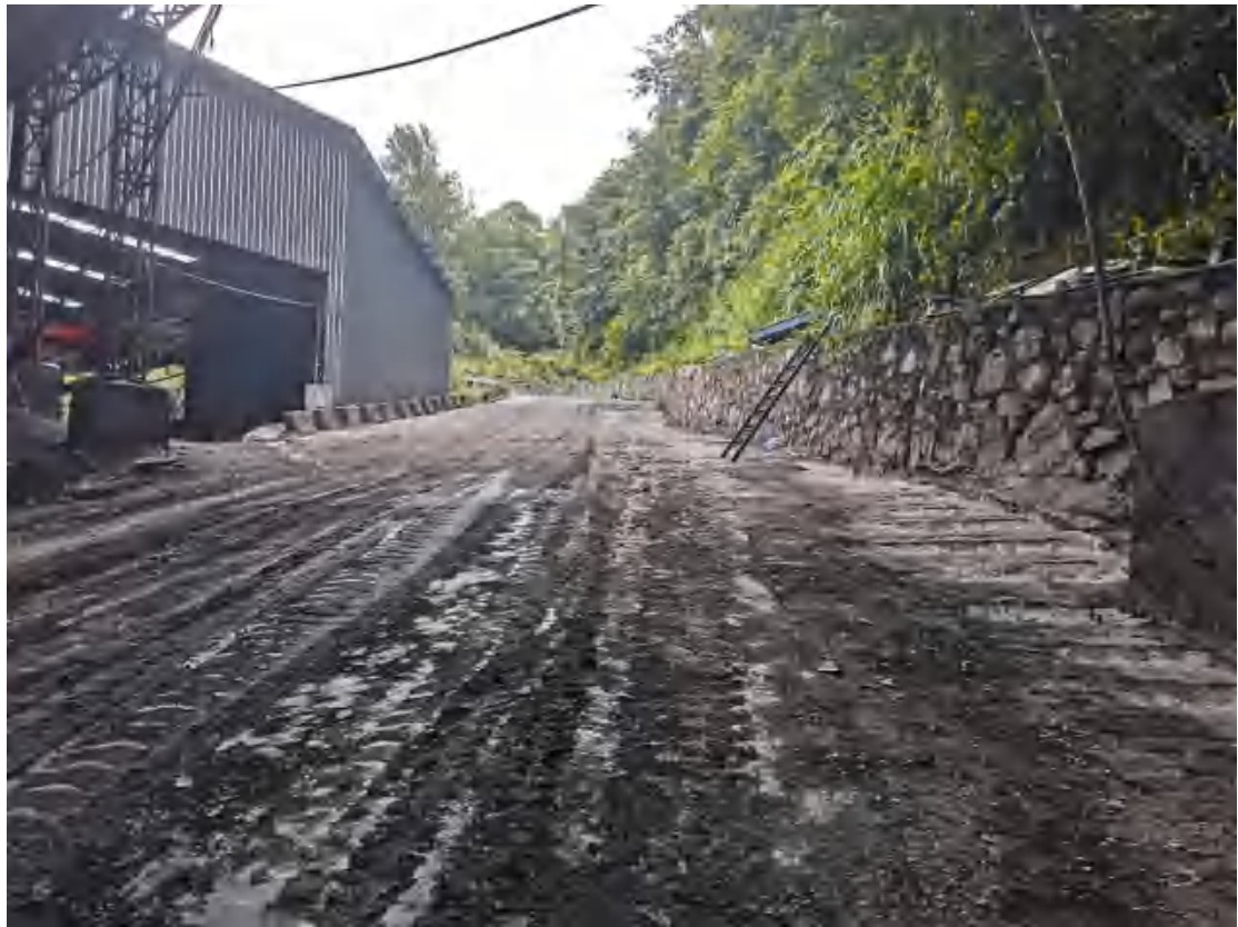
主井连接道路挡土墙
