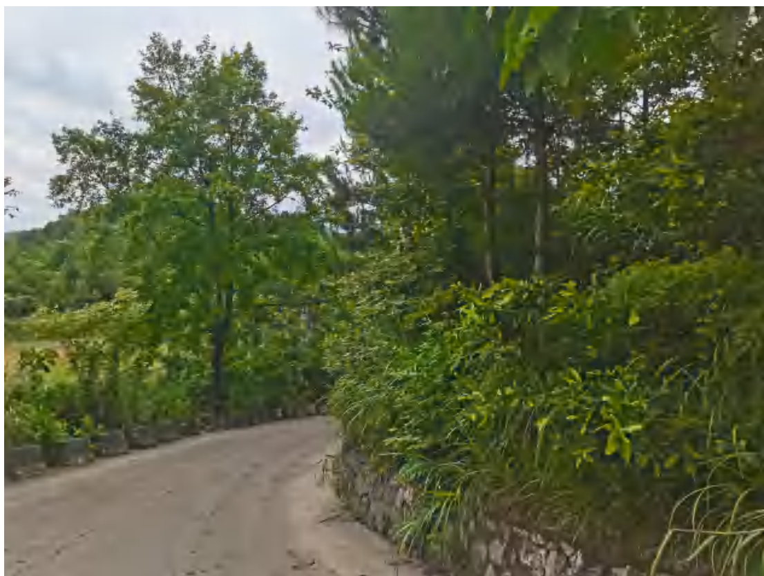
副井连接道主体挡土墙
