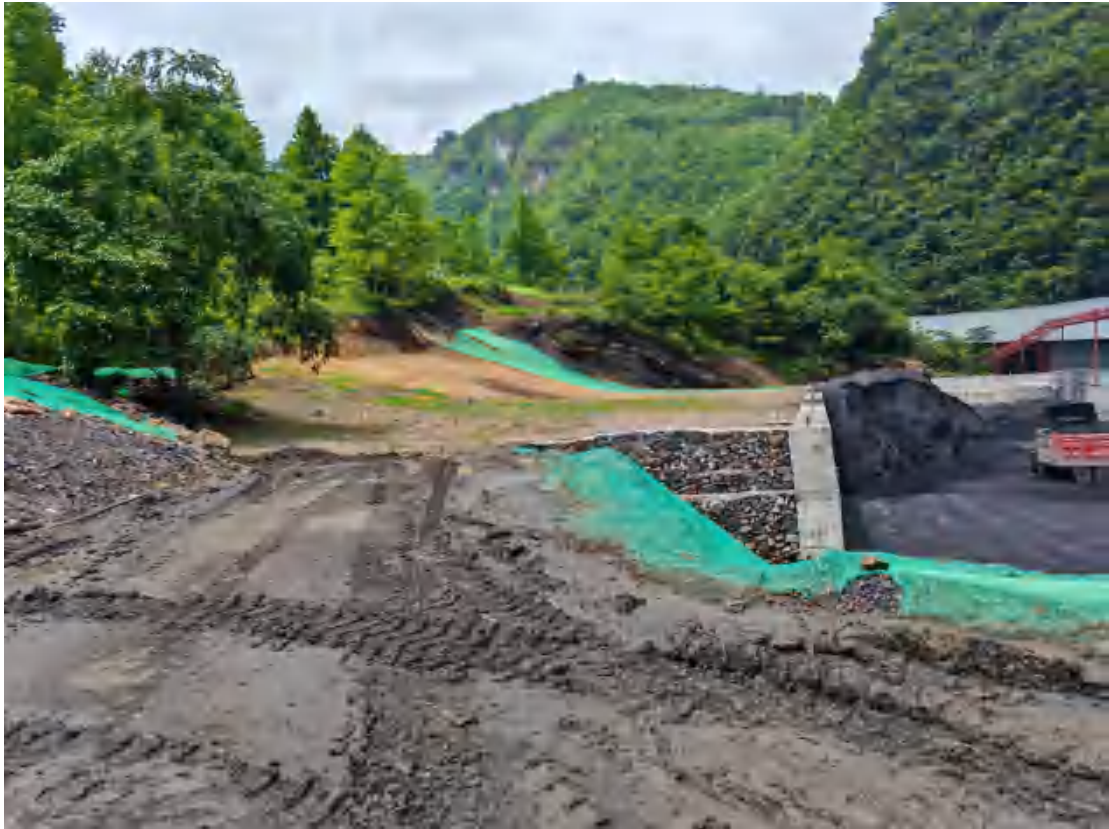
临时转运场地挡土墙及植被建设
