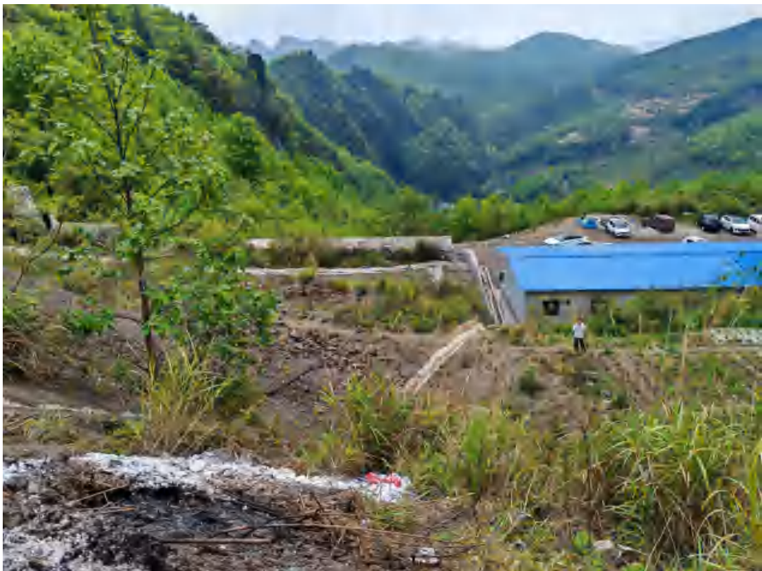
临时排矸场截水沟及挡土墙
