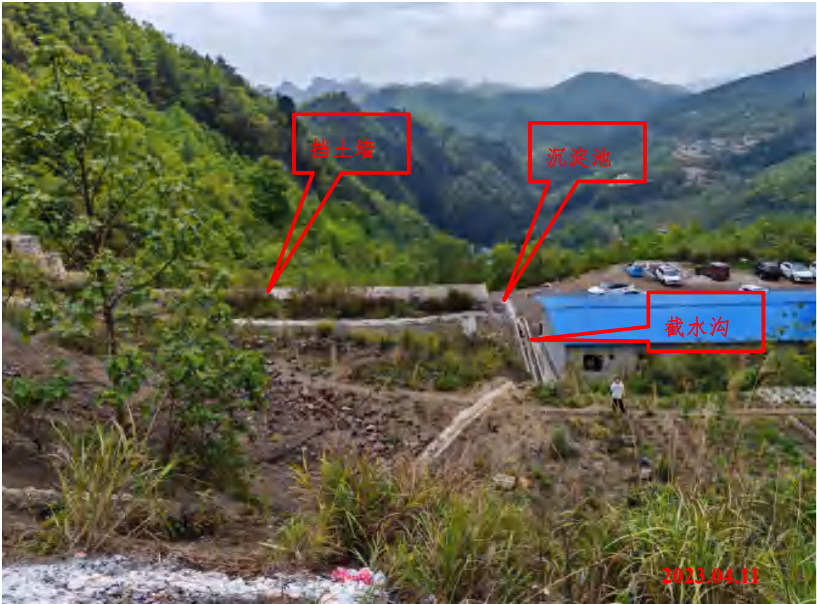
临时排矸场修建挡土墙及截排水沟
