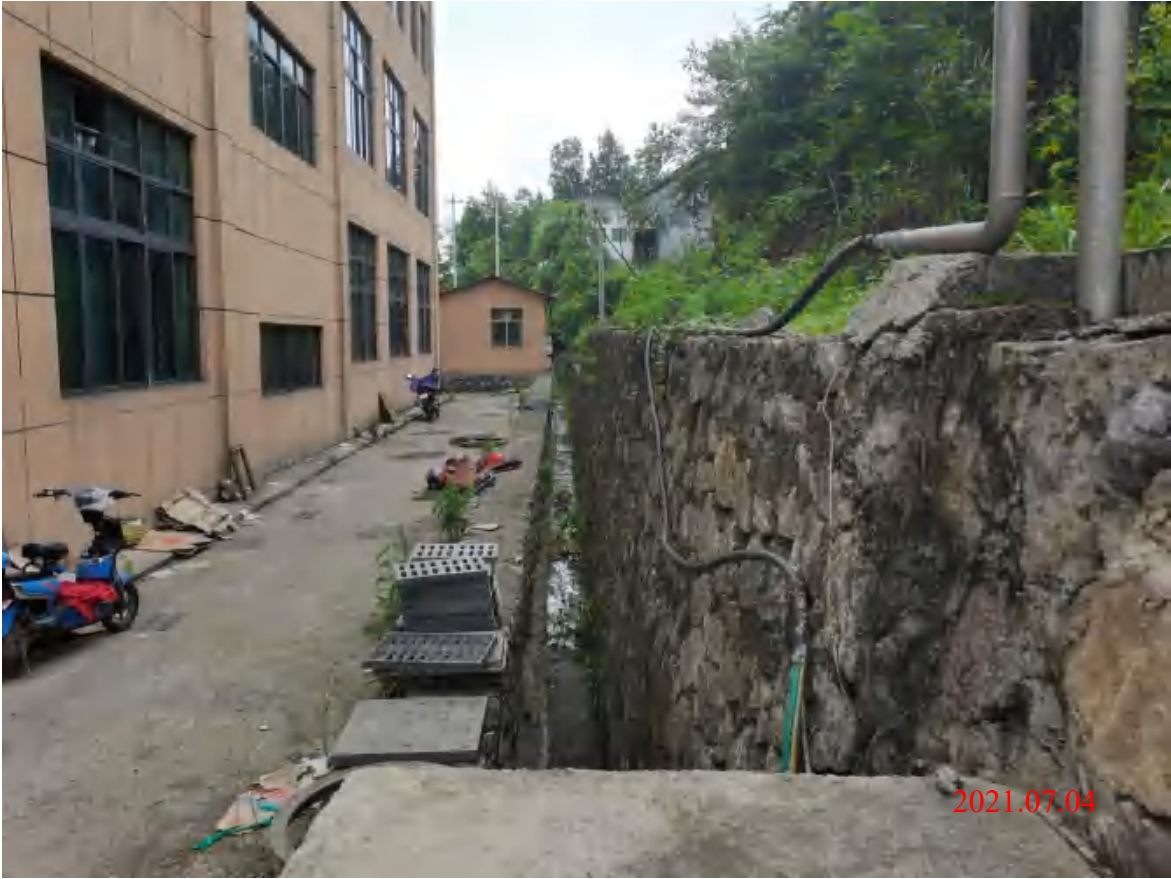
副井办公区综合护坡及排水系统
