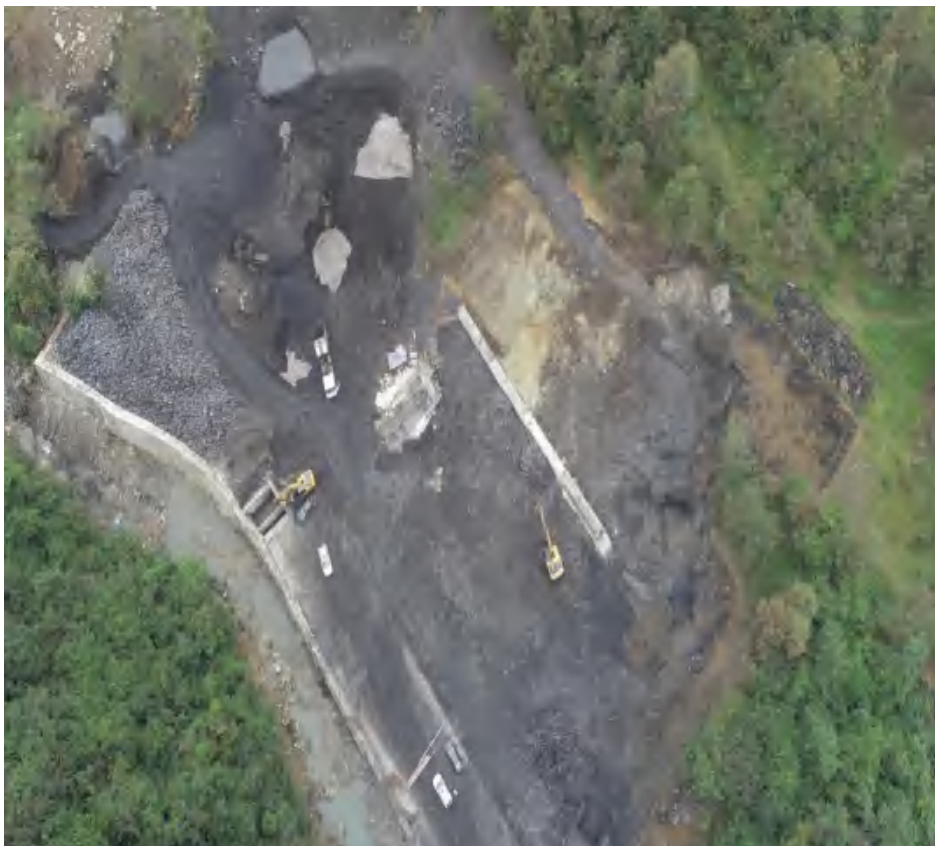
新增临时储煤转运场（治理前）
