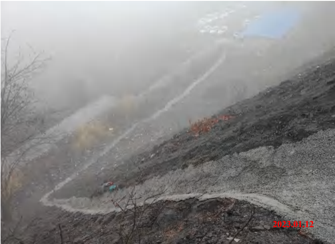
临时排矸场修建挡土墙及截排水沟
