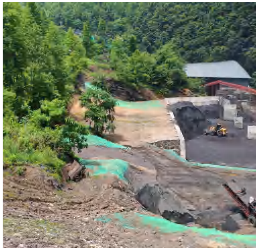
新增临时储煤转运场( 治理后)
