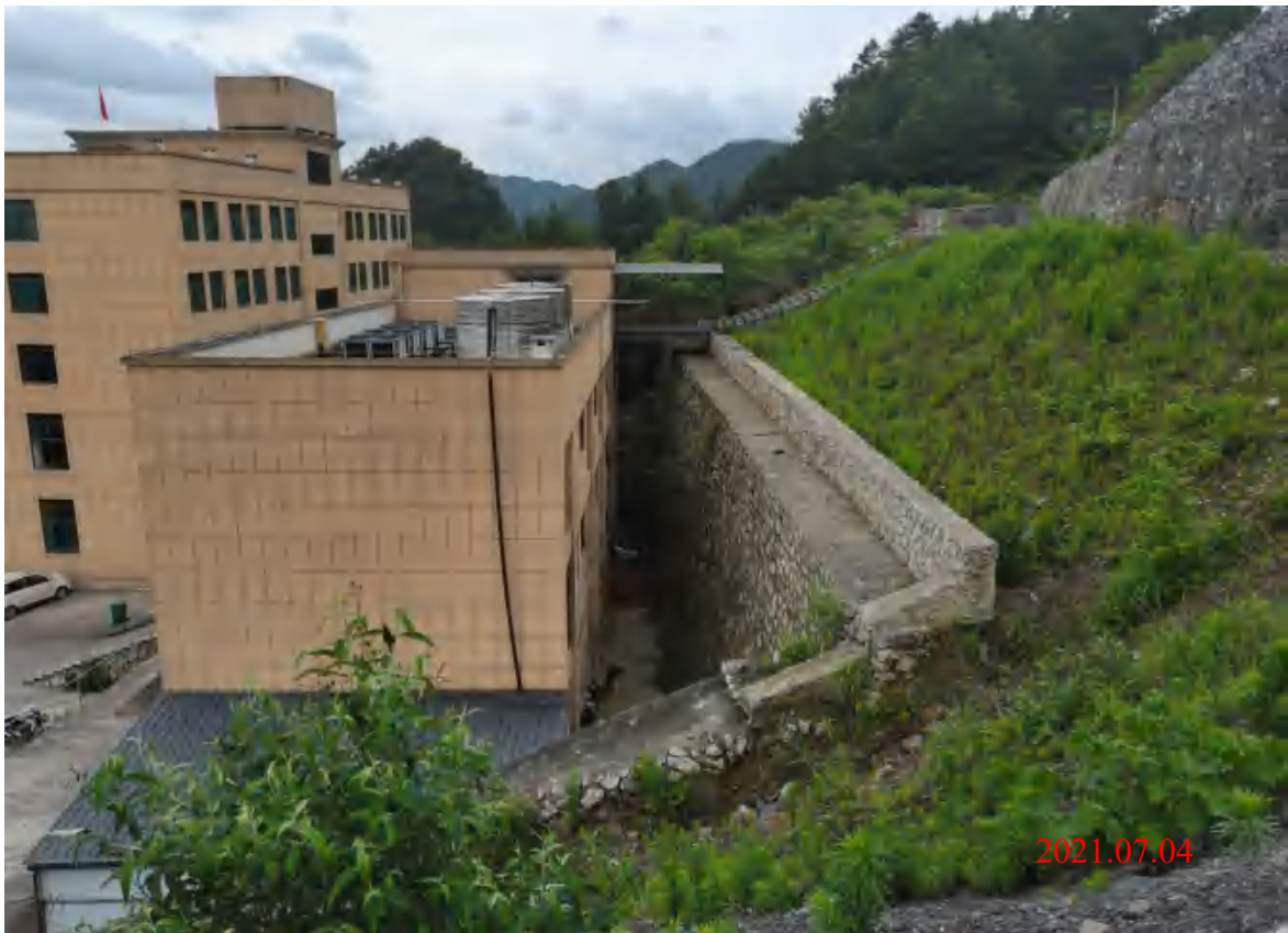
副井道路综合护坡及植被恢复情况
