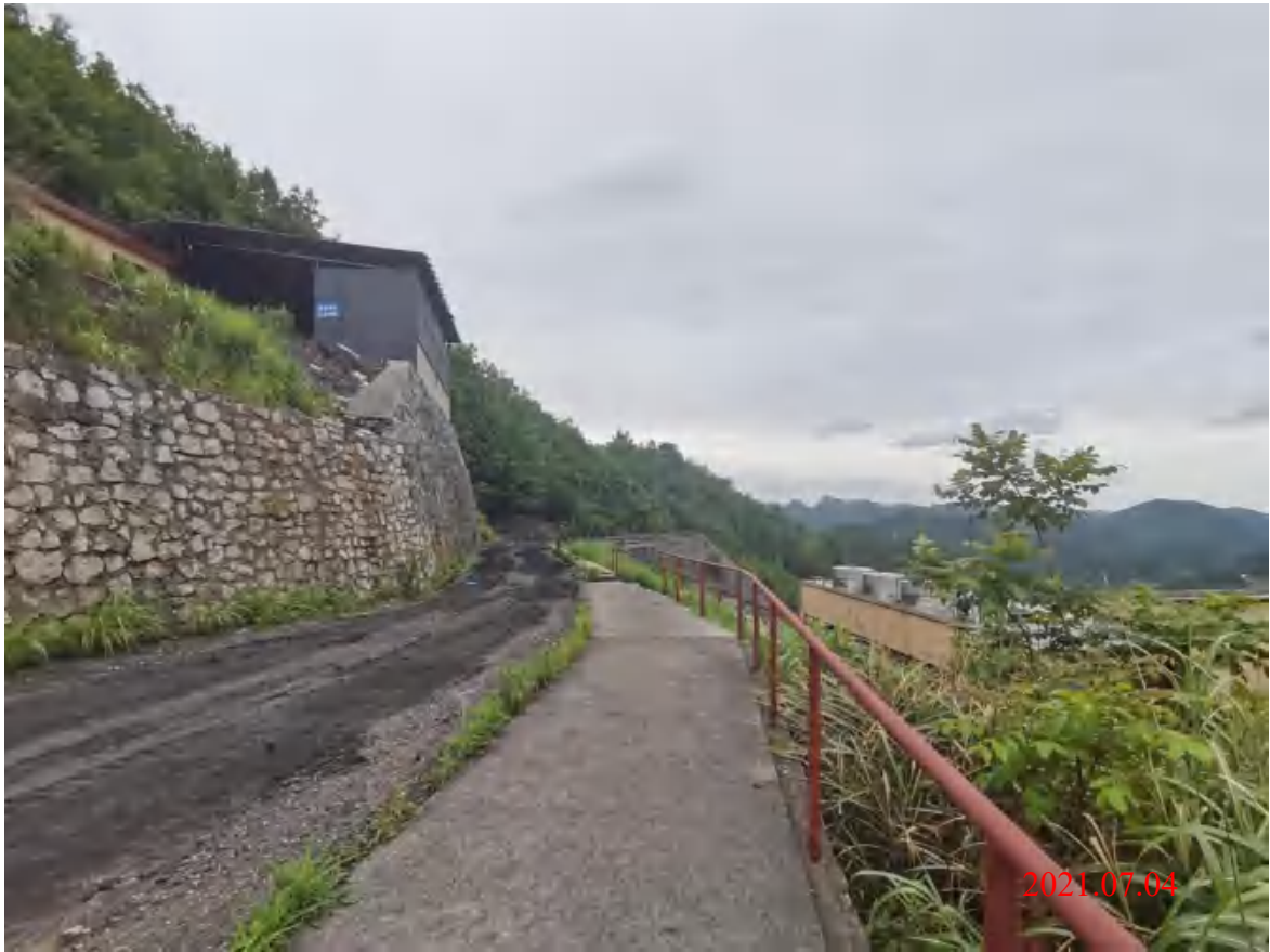
副井道路综合护坡
