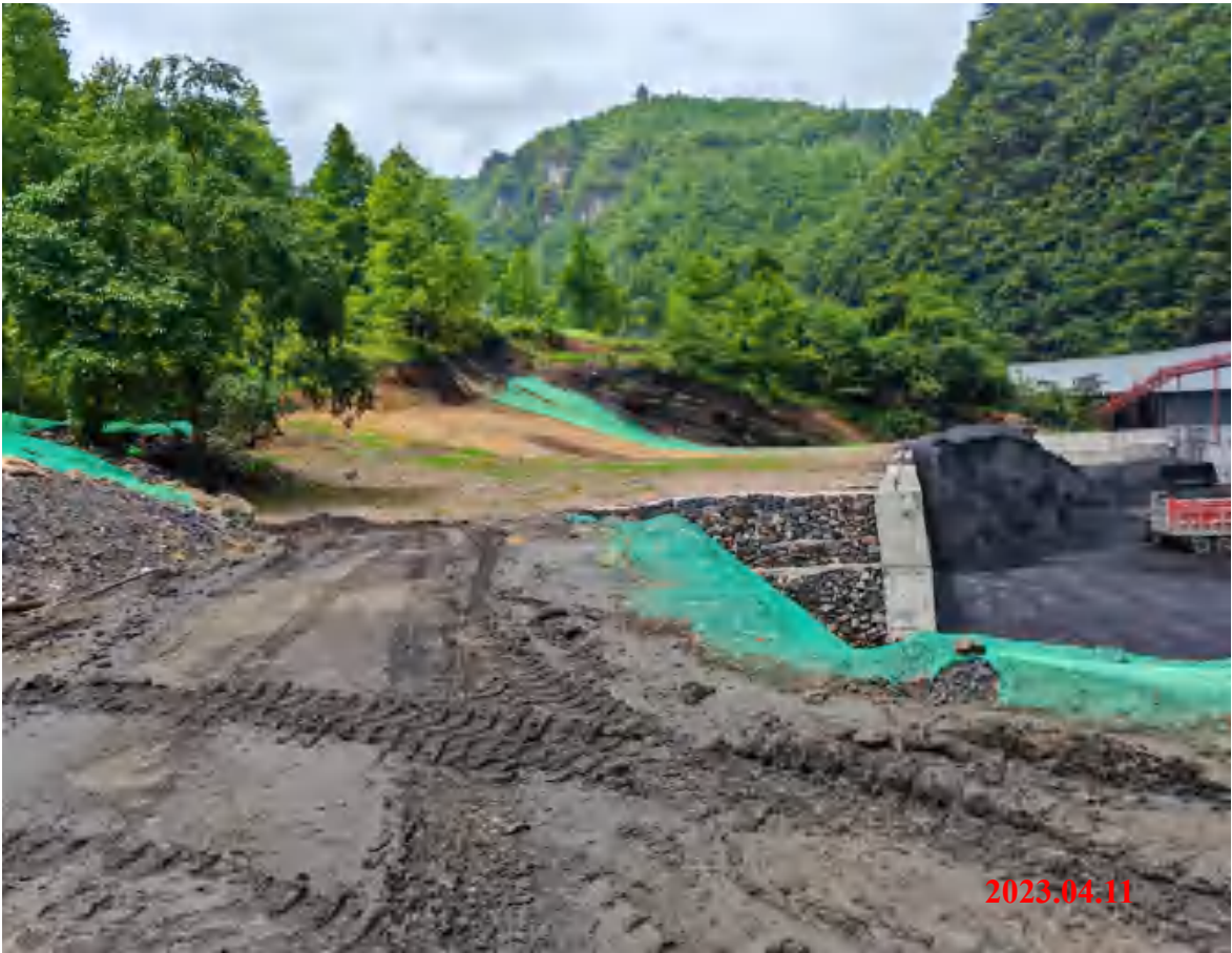
主井新增临时储煤转运场植被建设及挡土墙
