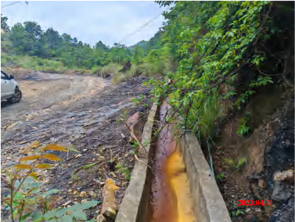
废弃物地区已建排水沟
