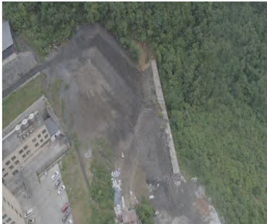
临时排矸场（治理前）
