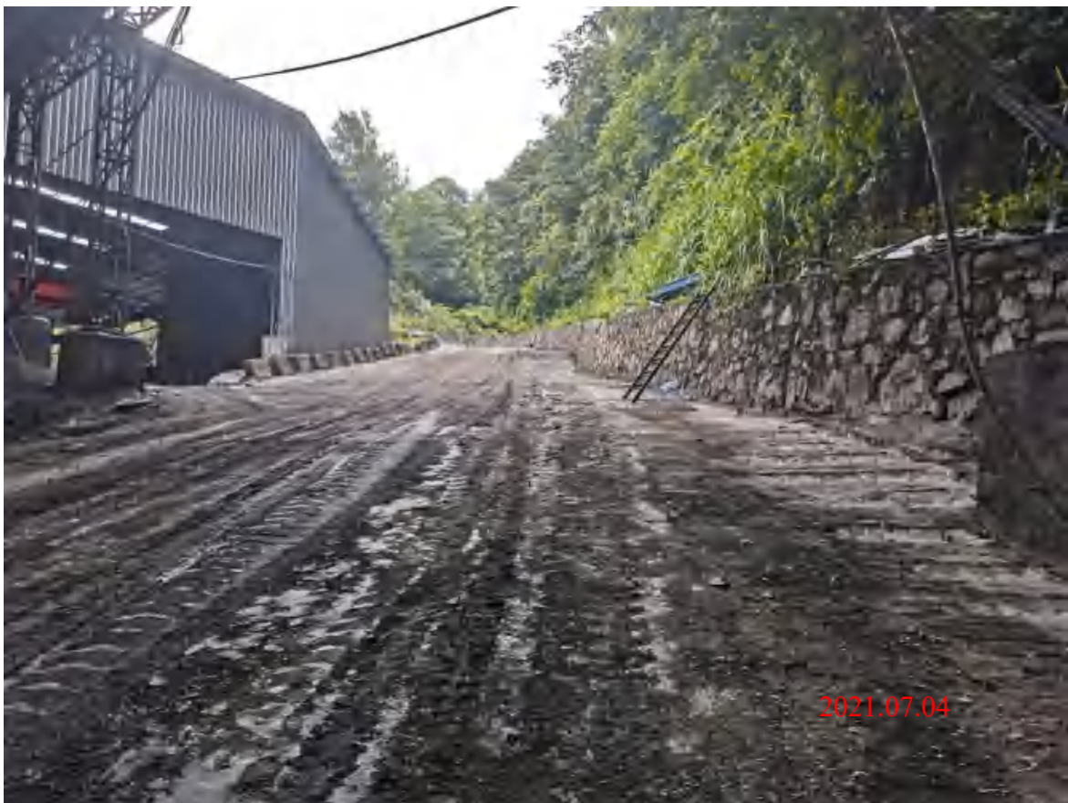
主井道路挡土墙
