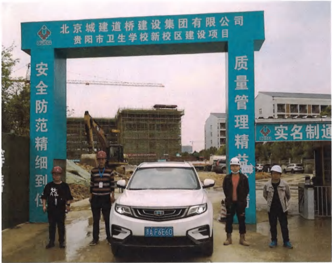
图一：贵阳市卫生学校新校区建设项目施工现场起点段（吉利博越：贵 AF6E60）
