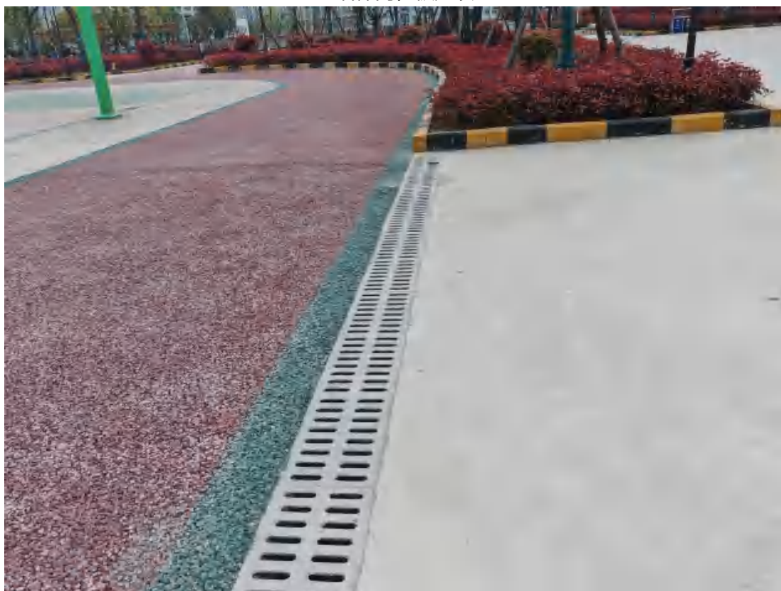
生活休闲（运动场）植被建设及排水系统
