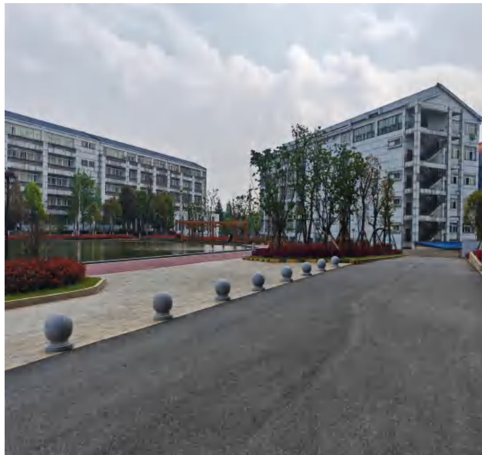
临时施工营地（治理后）
