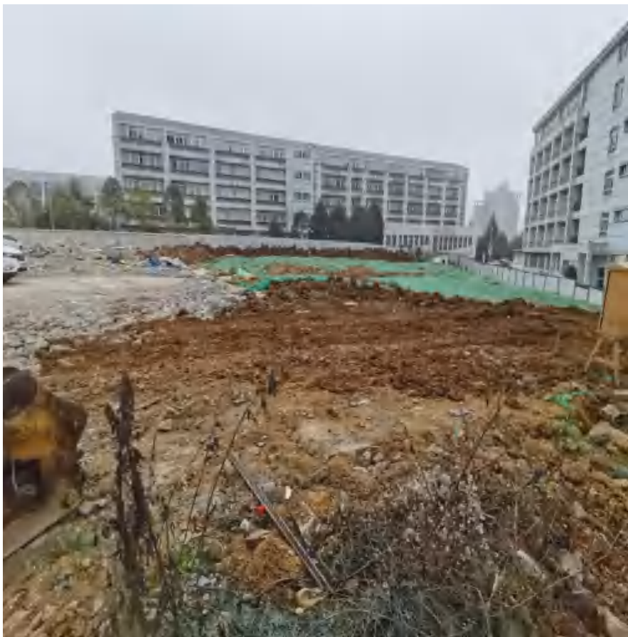
临时施工营地（治理前）
