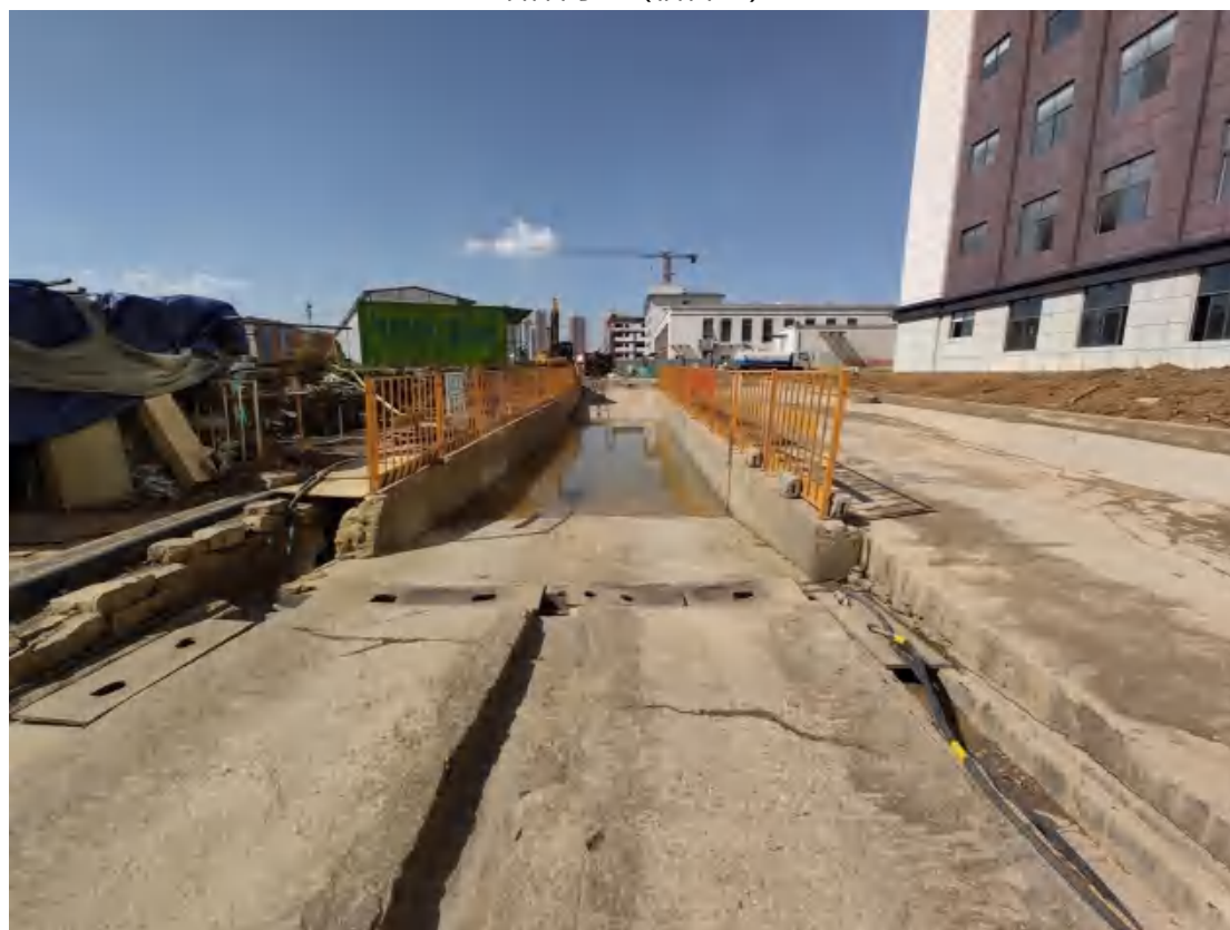
生活休闲区临时洗车槽及临时沉沙池
