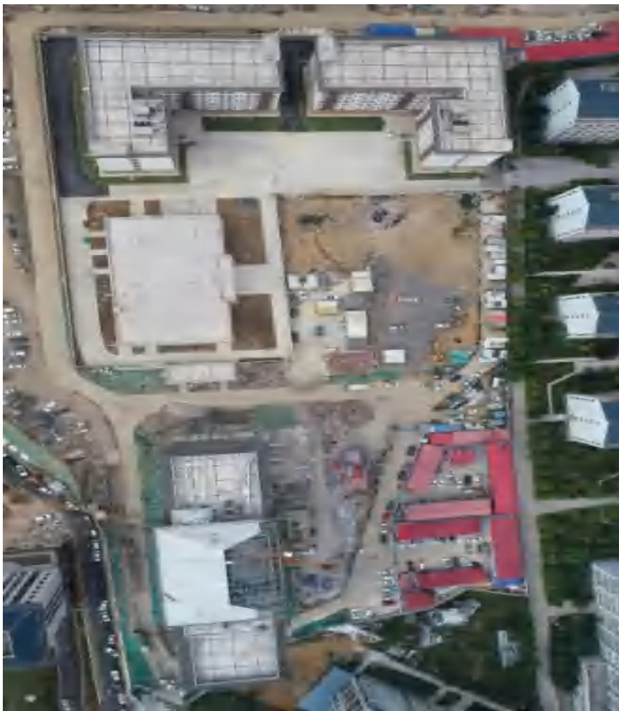
项目建设中（引用方案）
