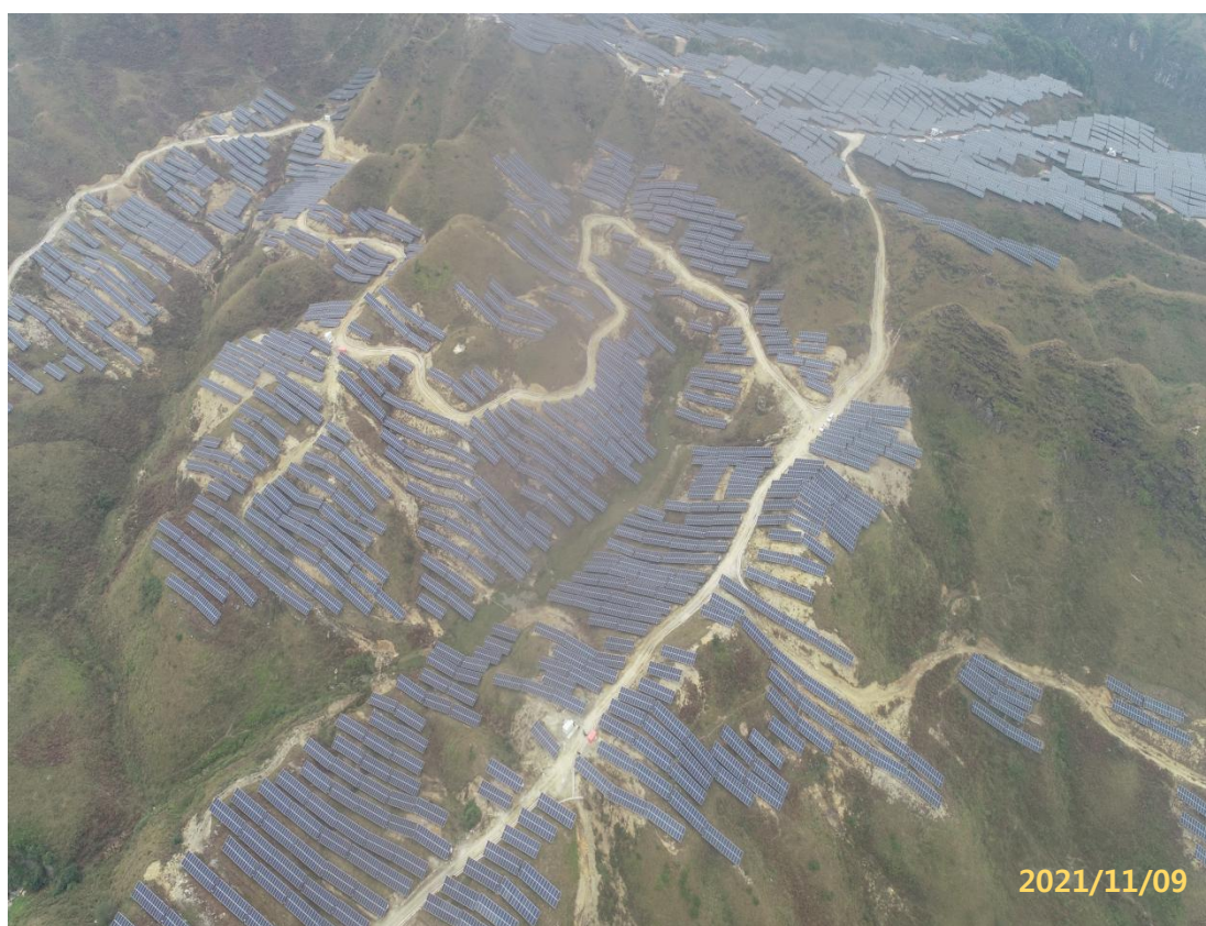
图 8 西区光伏场区现状
