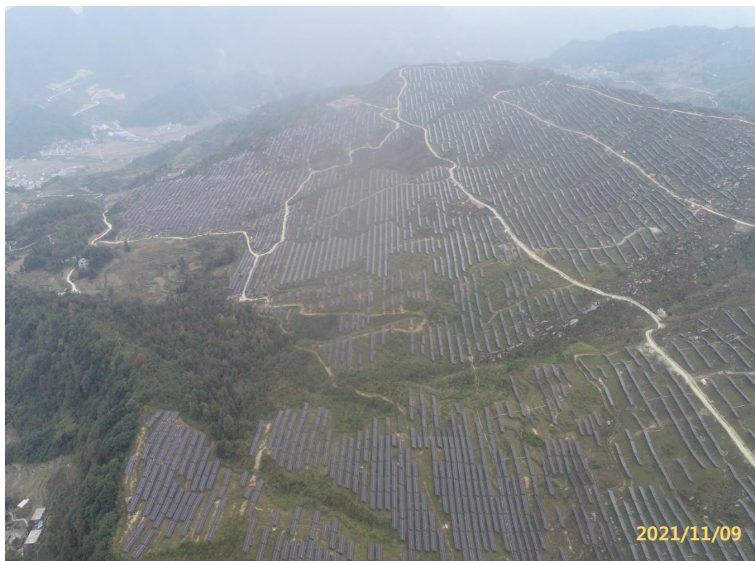
图 2 东区光伏场区现状
