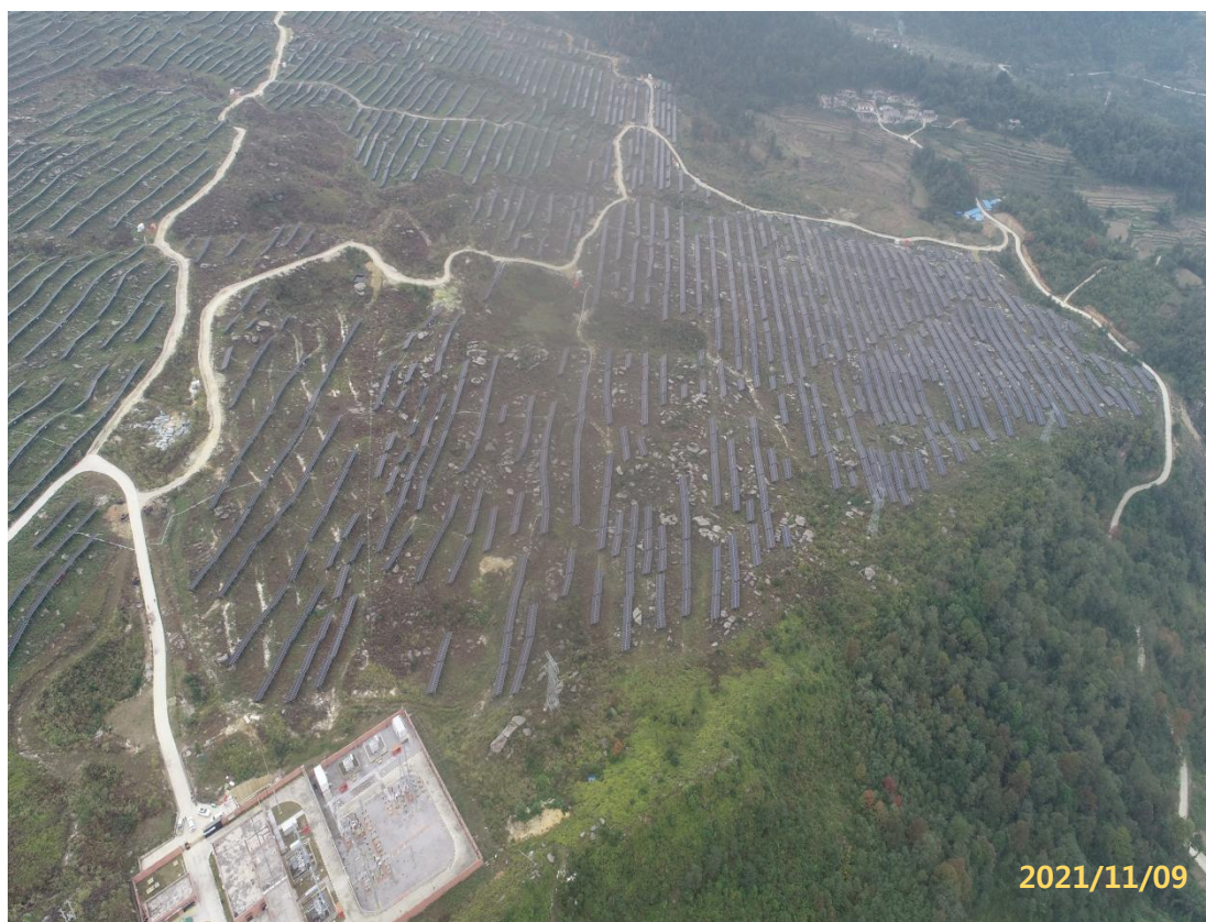
图 1 东区光伏场区现状
