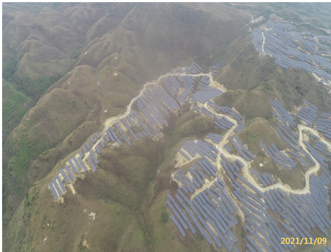
图 9 西区光伏场区现状
