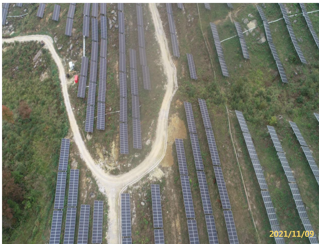
图 4 东区道路排水沟和沉沙池
