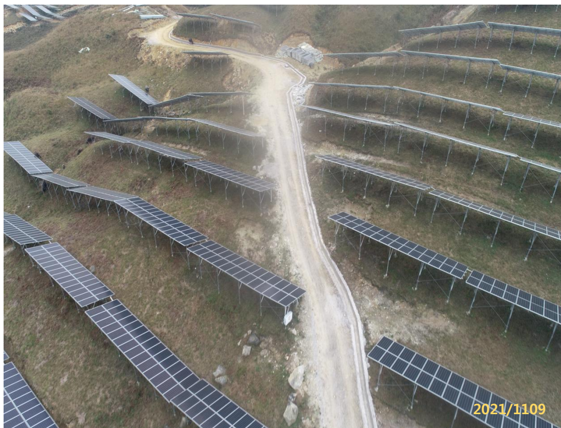
图 11 西区道路排水沟和沉沙池
