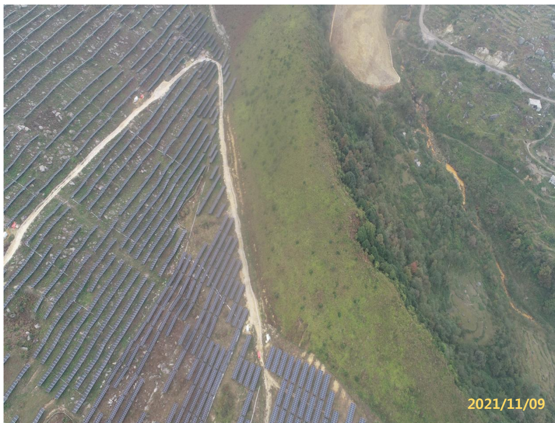
图 3 东区道路排水沟和沉沙池
