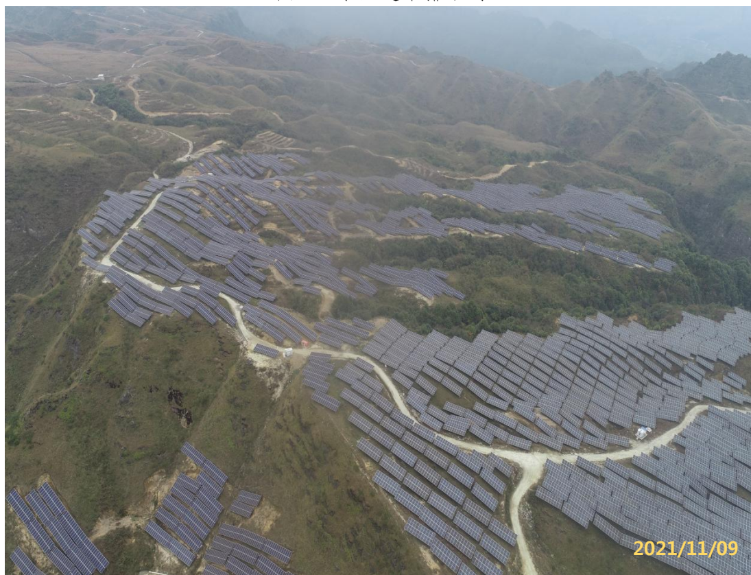
图 6 西区光伏场区现状
