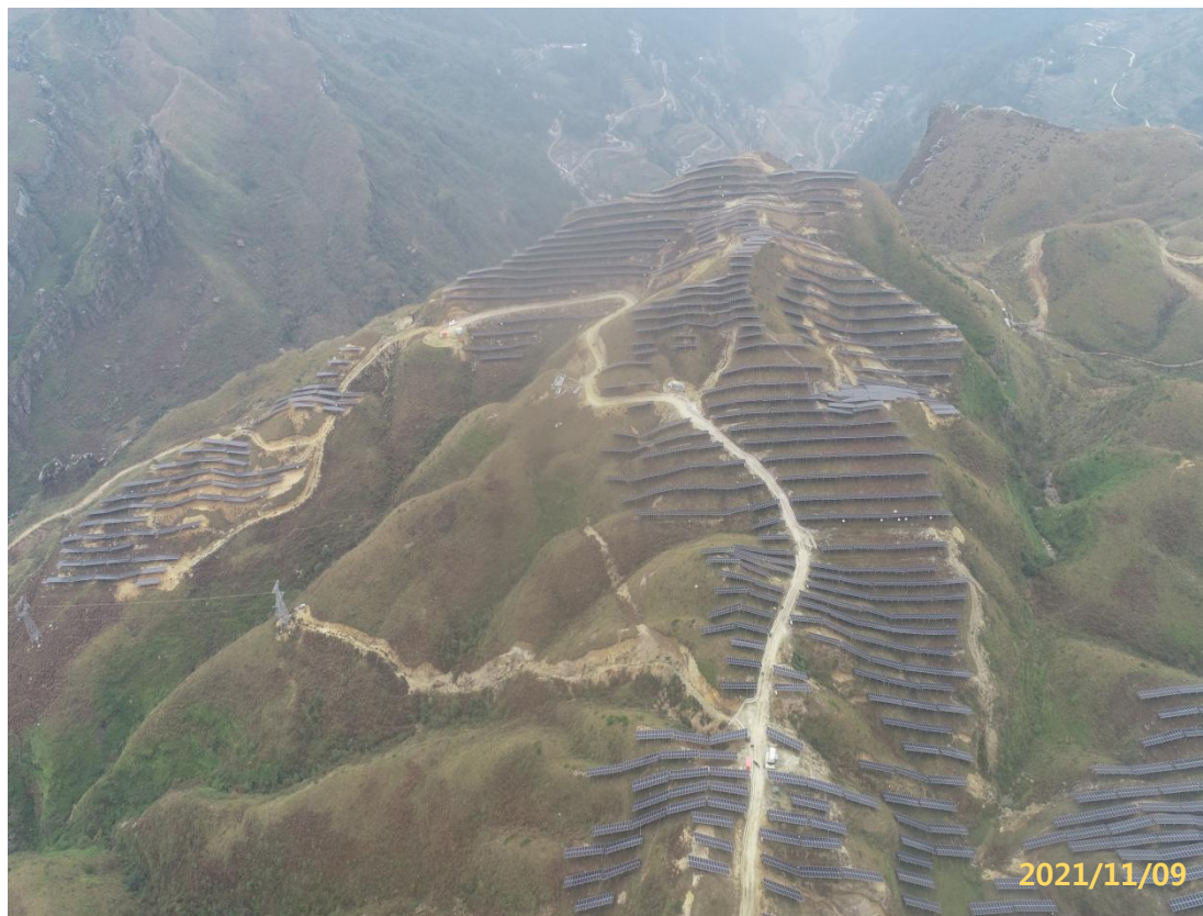
图 7 西区光伏场区现状
