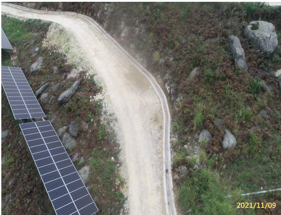
图 5 东区道路排水沟
