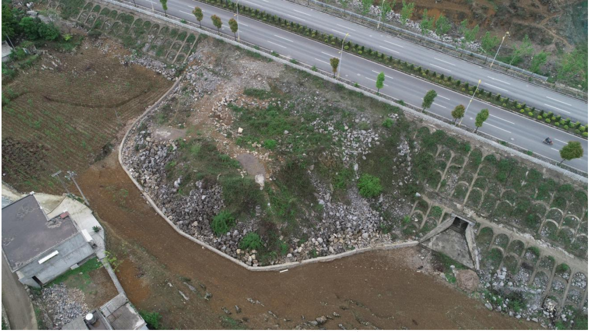
10#弃渣场水土保持治理效果图
