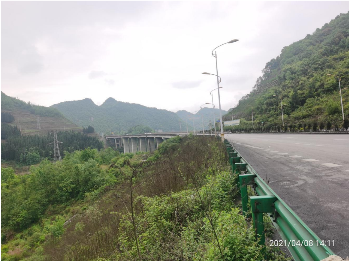
桥梁工程区植被恢复情况
