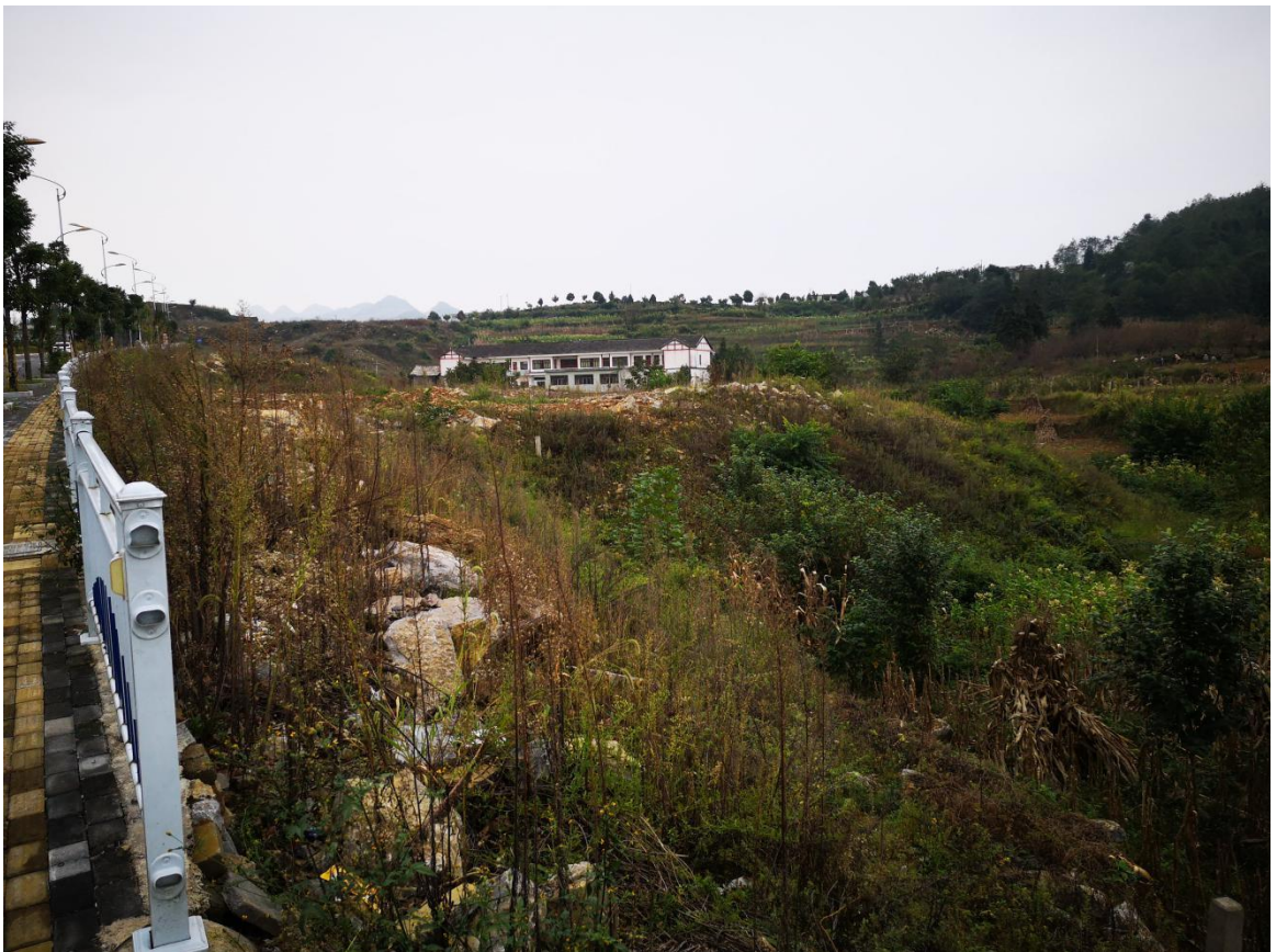
9#弃渣场水土保持治理效果图
