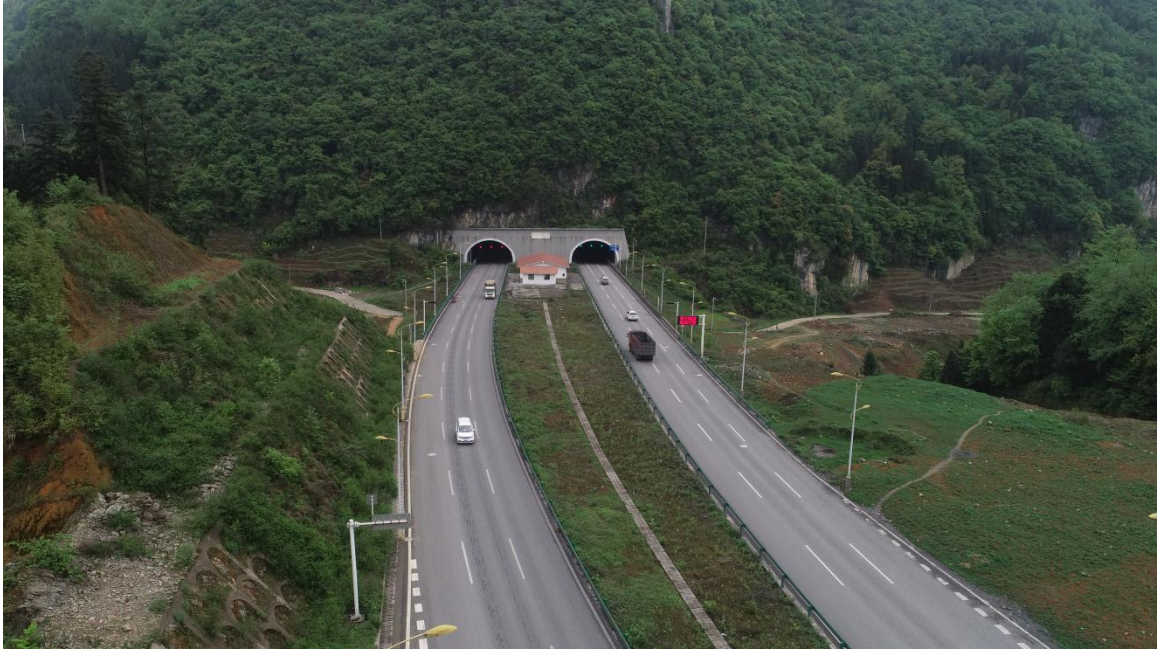
隧道洞口水土保持治理效果
