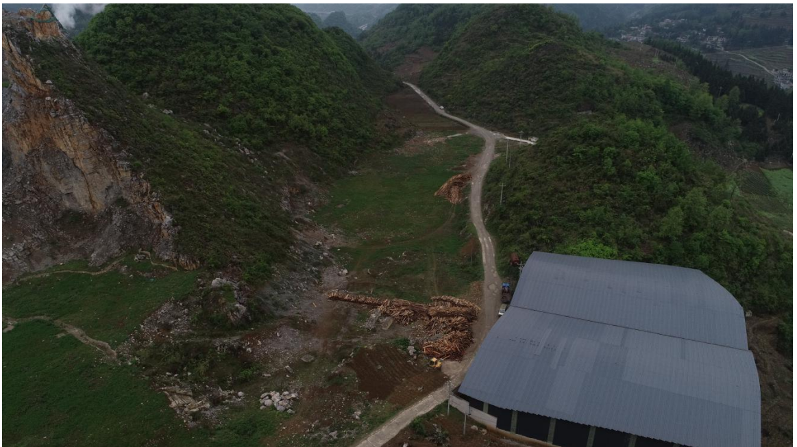
施工生产生活区水土保持治理效果
