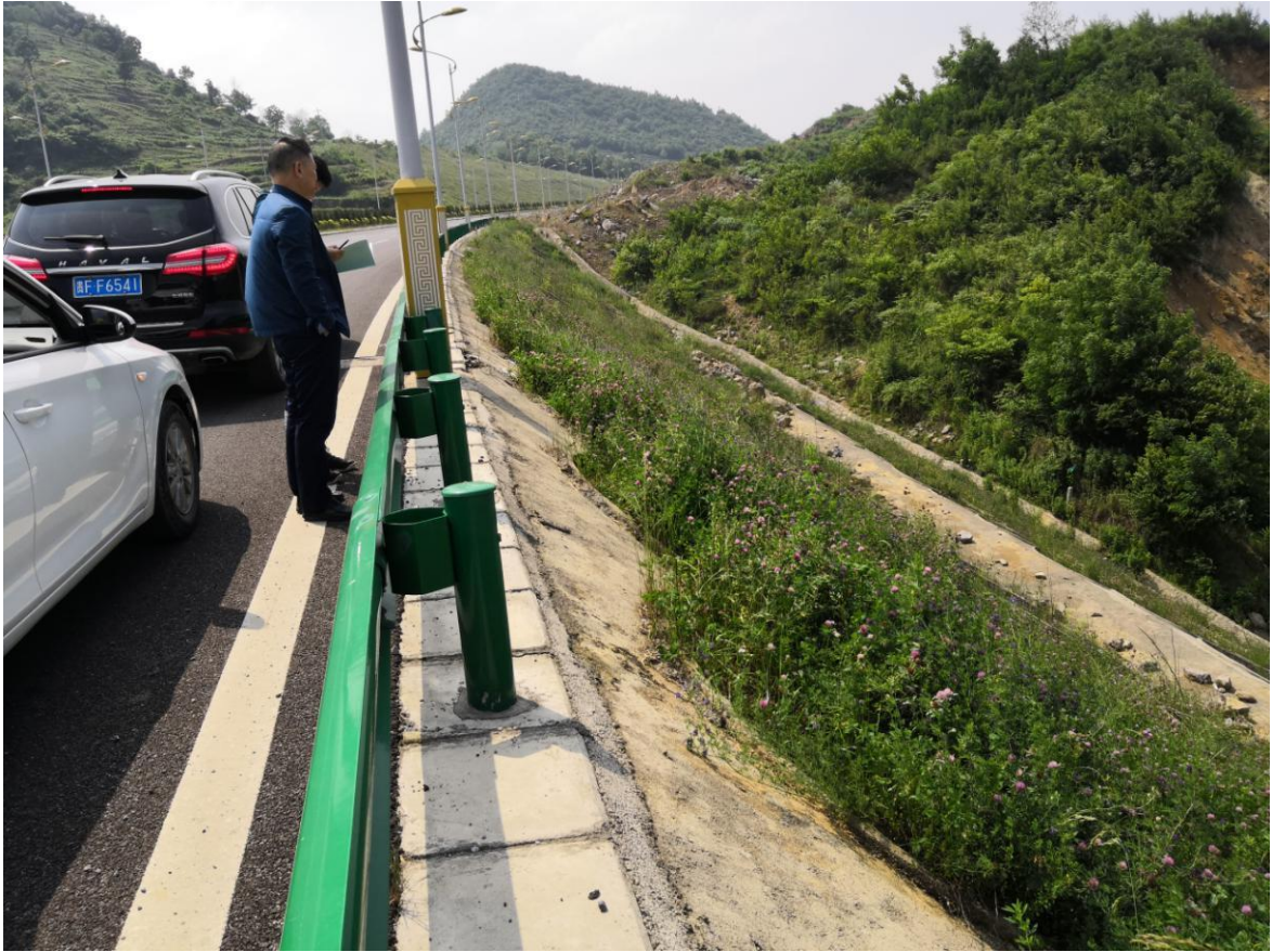
监测小组人员在现场调查项目区措施实施情况
