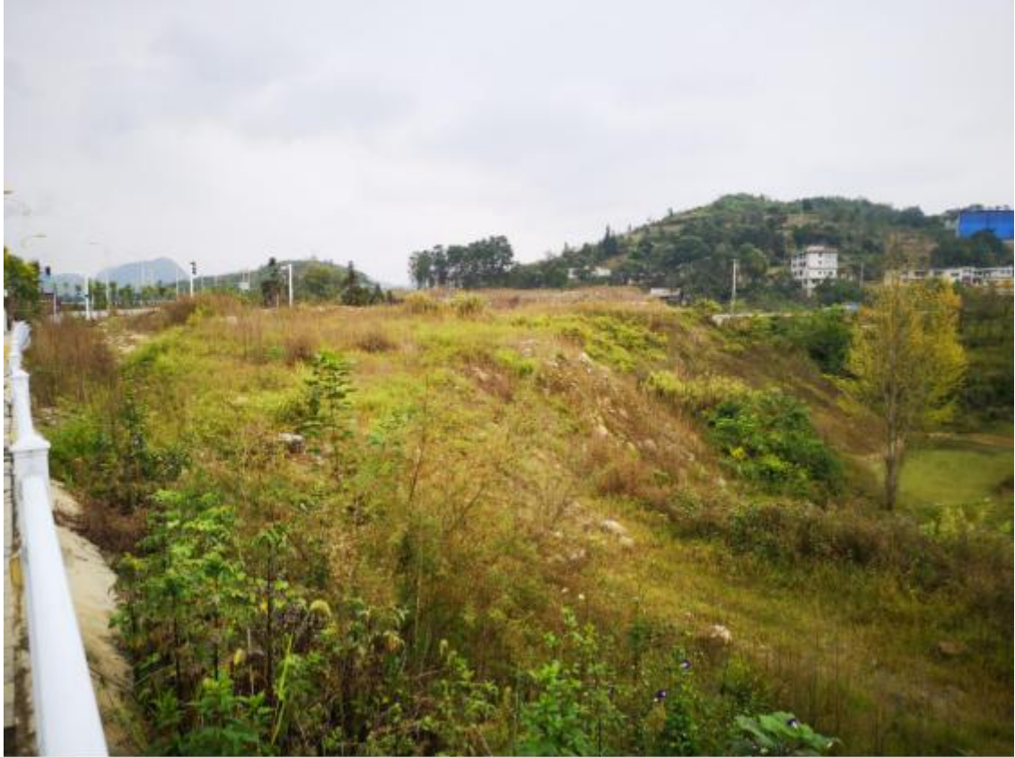
5#弃渣场水土保持治理效果图
