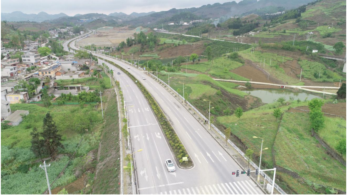
6#弃渣场水土保持治理效果图
