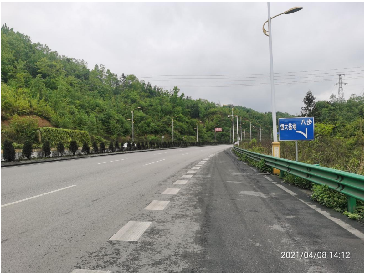
路基工程区两侧植被恢复情况
