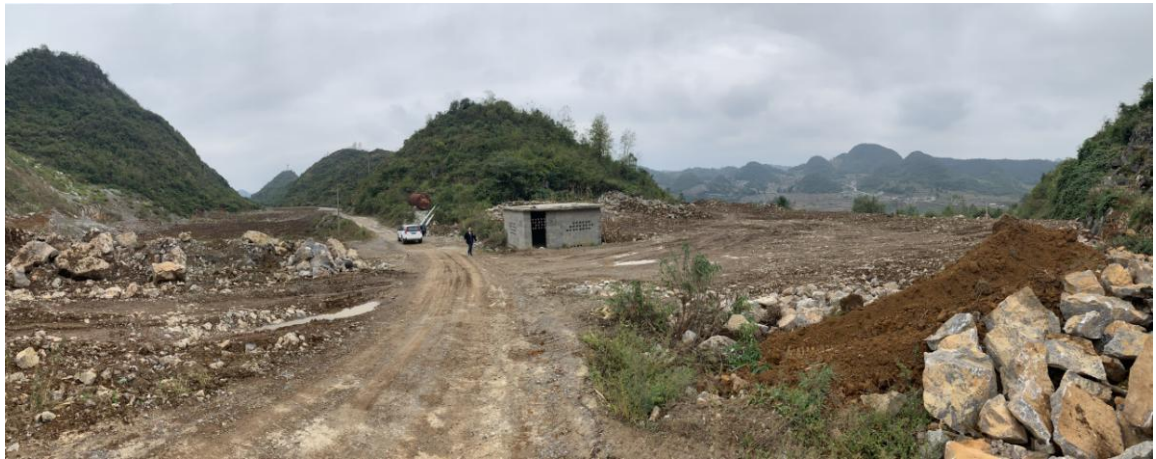
监测人员巡查调查场内取料场水土保持措施实施情况
