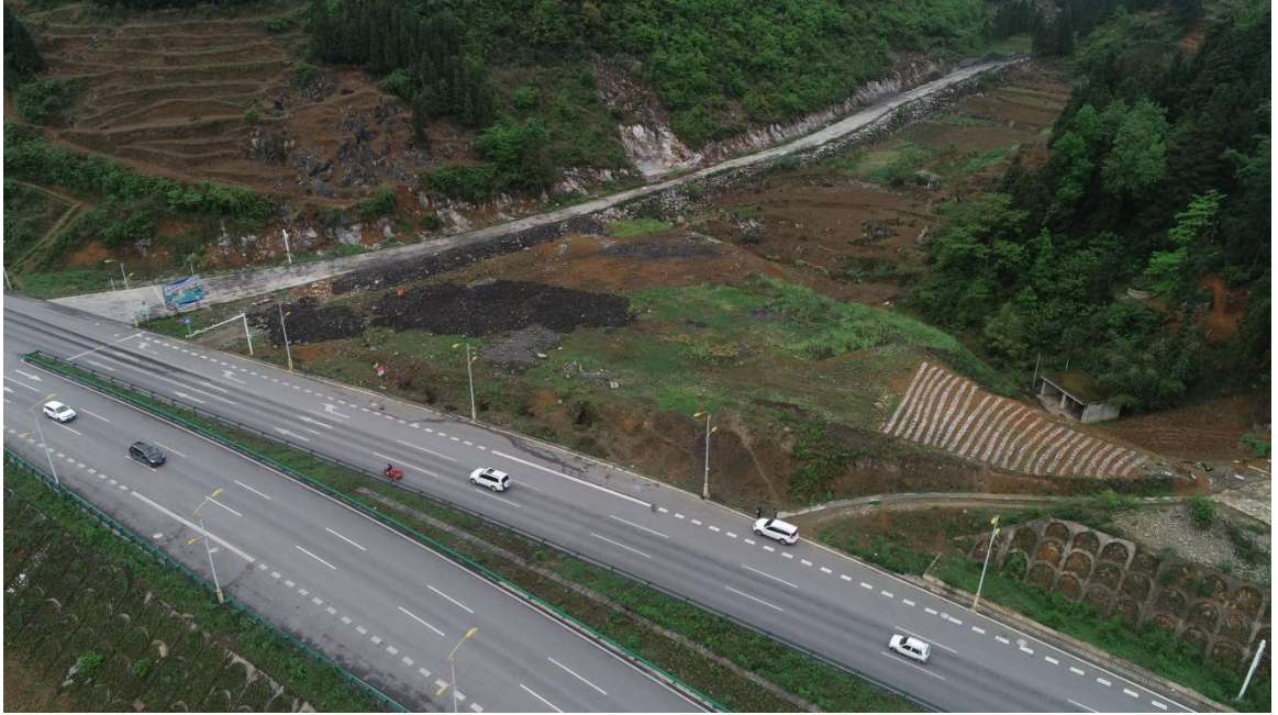
3#弃渣场水土保持治理效果图
