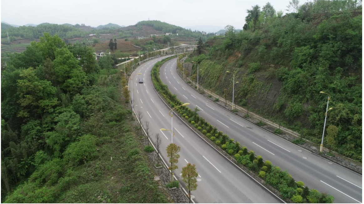
路基工程区水土保持治理效果
