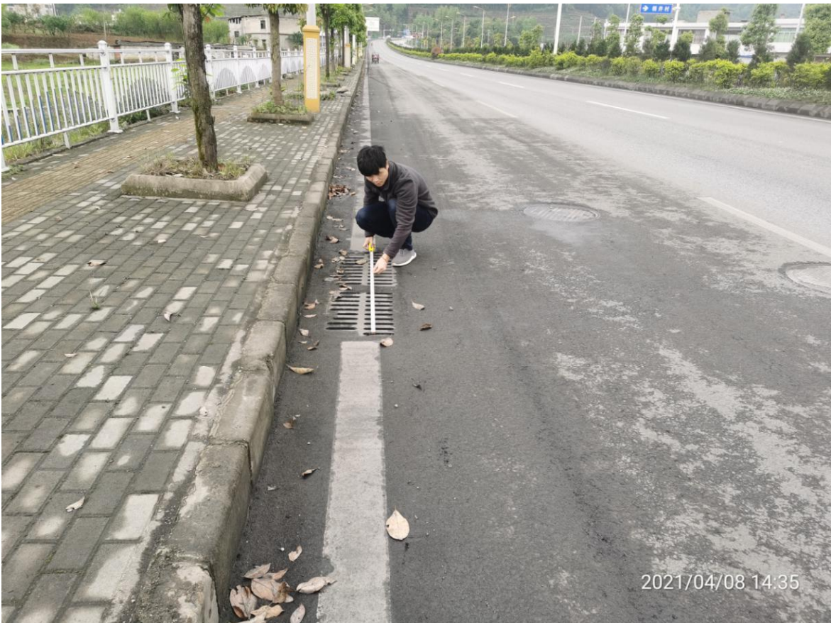
监测小组人员对路面排水措施尺寸进行测量调查
