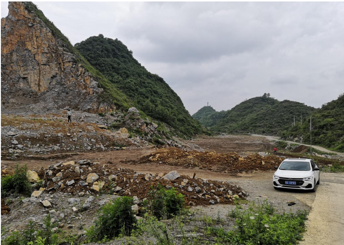
监测小组人员对取料场实施措施进行调查监测
