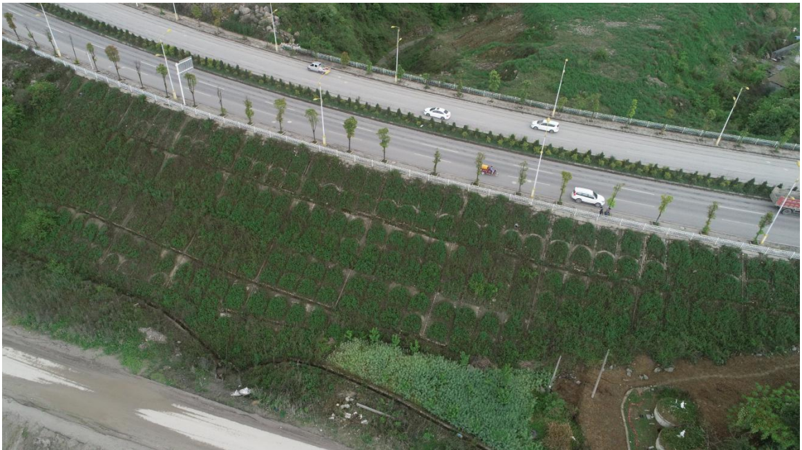
路基工程区两侧及中央绿化带水土保持治理效果（综合护坡）
