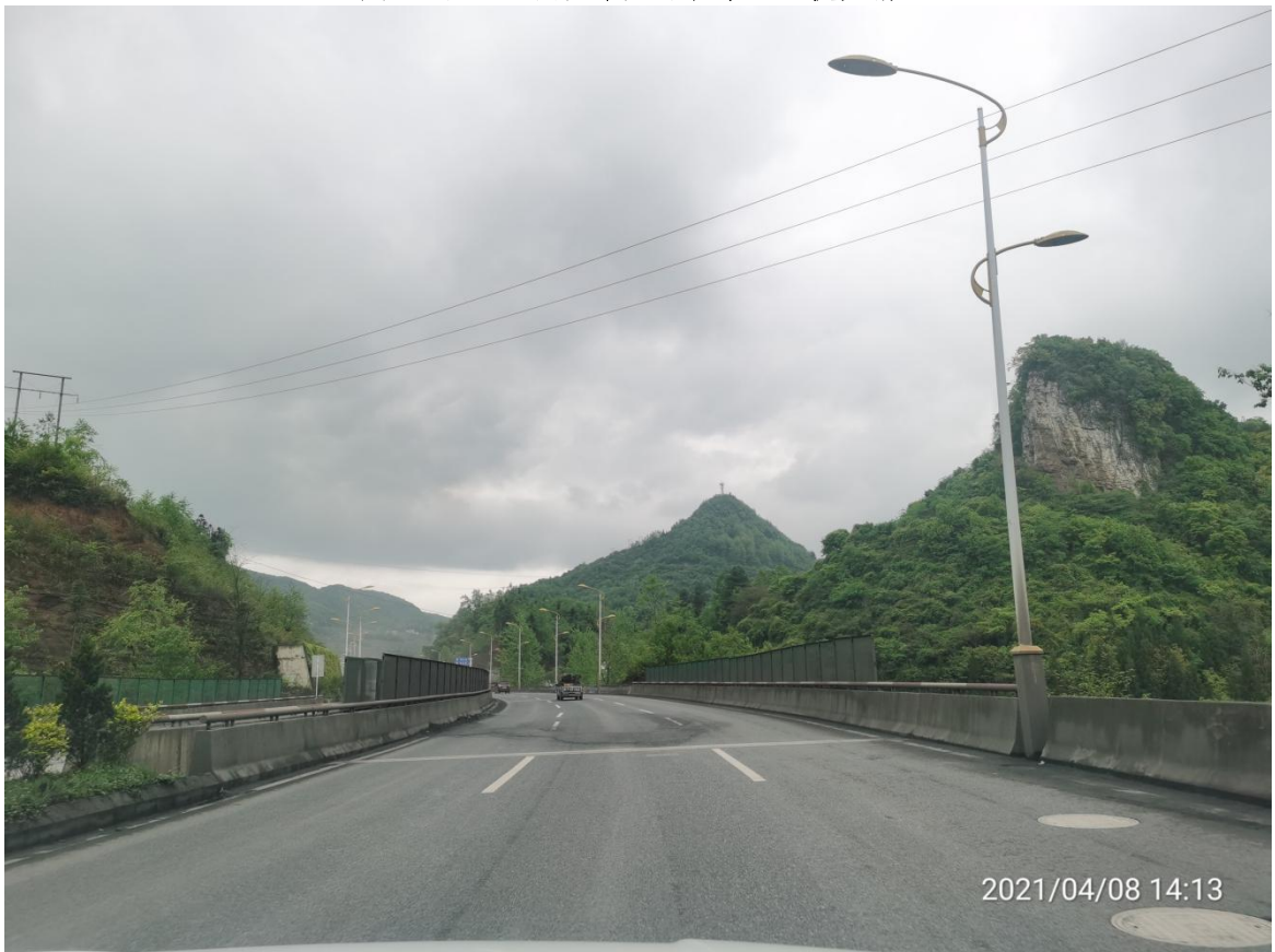
桥梁工程区实施情况
