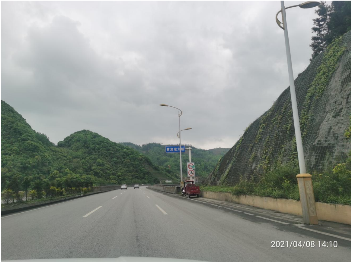
路基工程区上边坡挂植物攀爬网种植爬藤植物恢复情况
