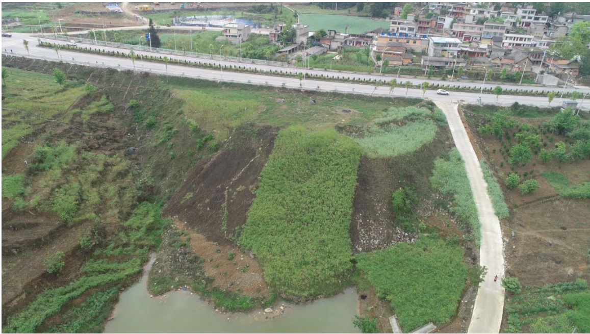
6#弃渣场水土保持治理效果图
