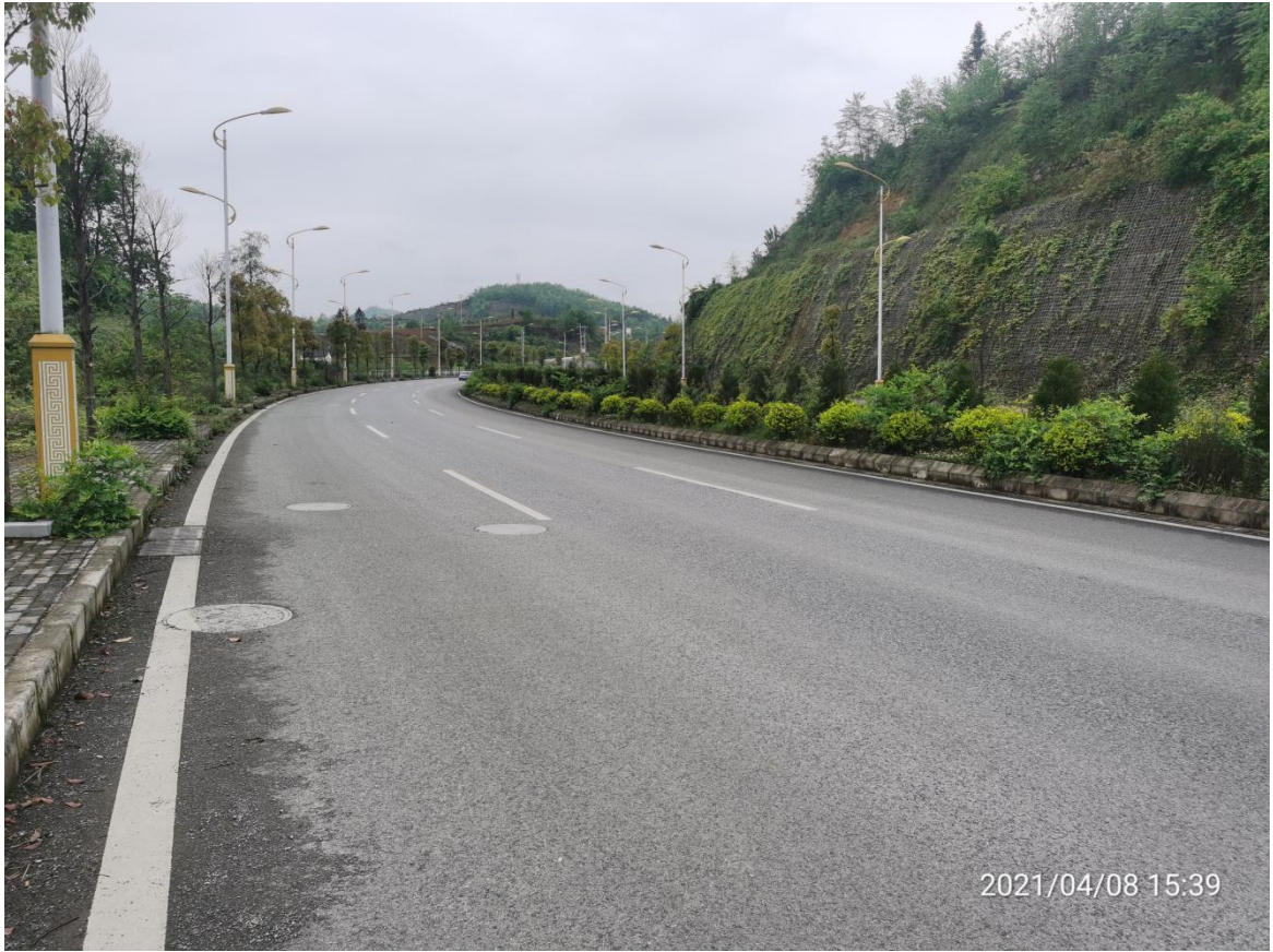
路基工程区两侧及中央绿化带治理恢复情况
