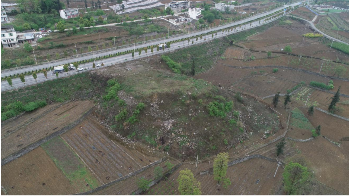
8#弃渣场水土保持治理效果图
