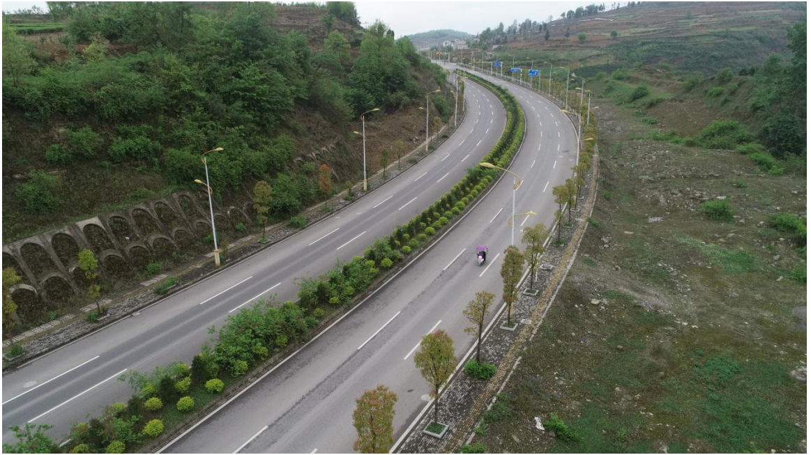
路基工程区两侧水土保持治理效果
