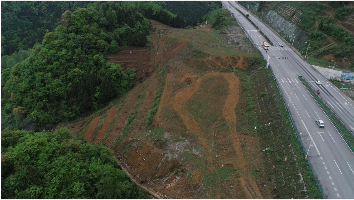
2#弃渣场水土保持治理效果图
