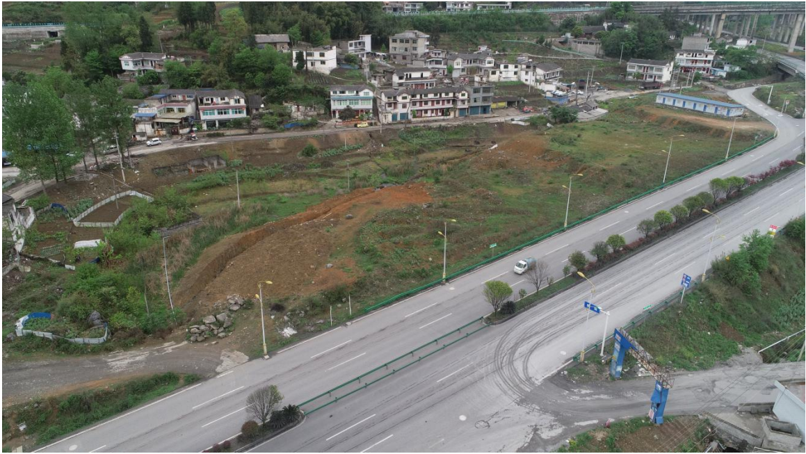
1#弃渣场水土保持治理效果图
