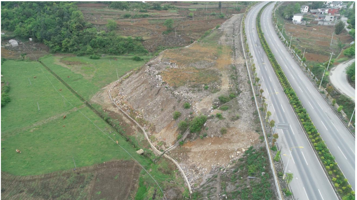
7#弃渣场水土保持治理效果图（挡土墙、截水沟）
