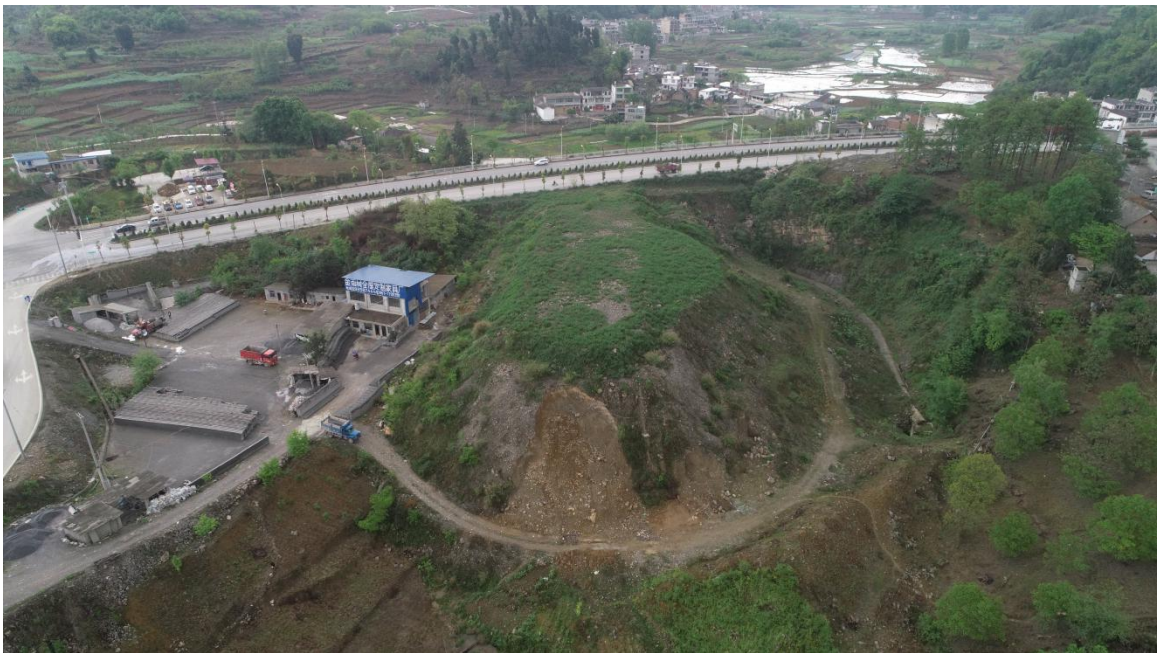
4#弃渣场水土保持治理效果图
