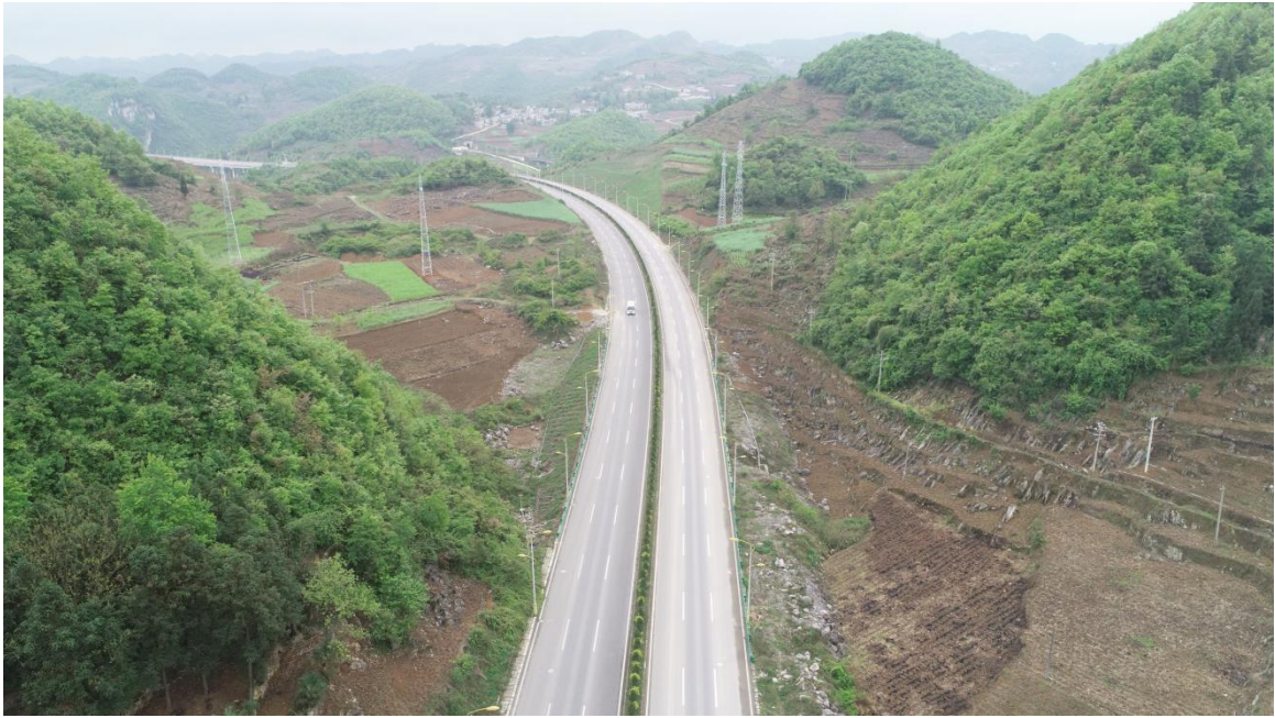
路基工程区两侧及中央绿化带水土保持治理效果
