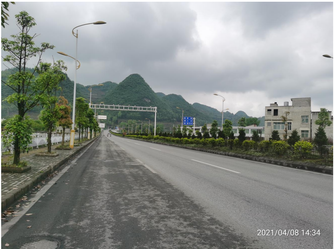
路基工程区中央绿化带及行道树植被恢复情况
