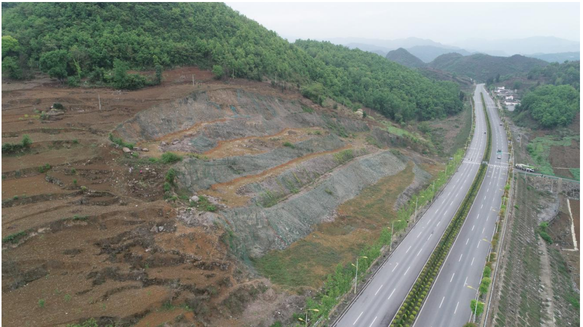
路基工程区两侧及边坡水土保持治理效果
