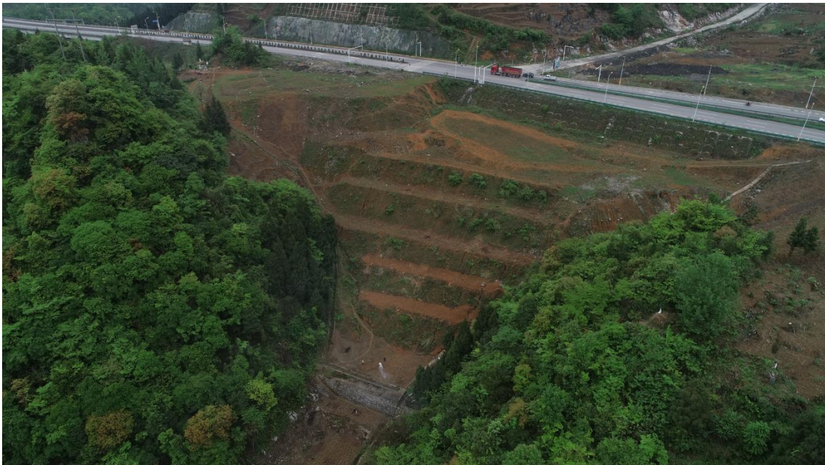
2#弃渣场水土保持治理效果图（挡土墙、截水沟）
