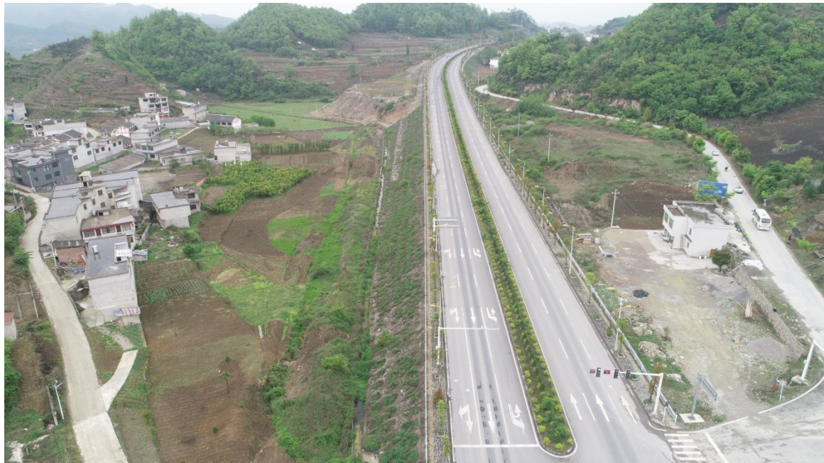
路基工程区两侧及中央绿化带水土保持治理效果
