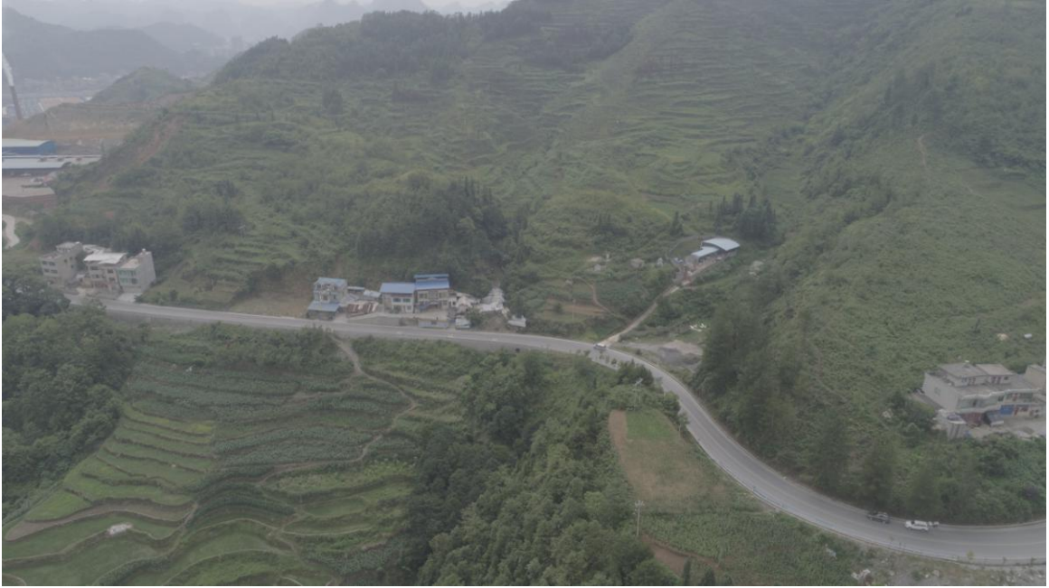
路基工程区两侧水土保持治理效果
