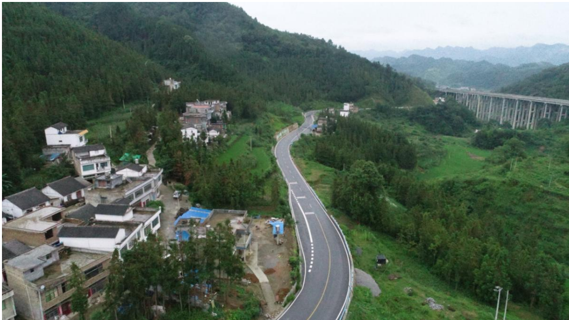
路基工程区两侧水土保持治理效果
