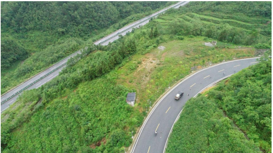
路基工程区两侧水土保持治理效果
