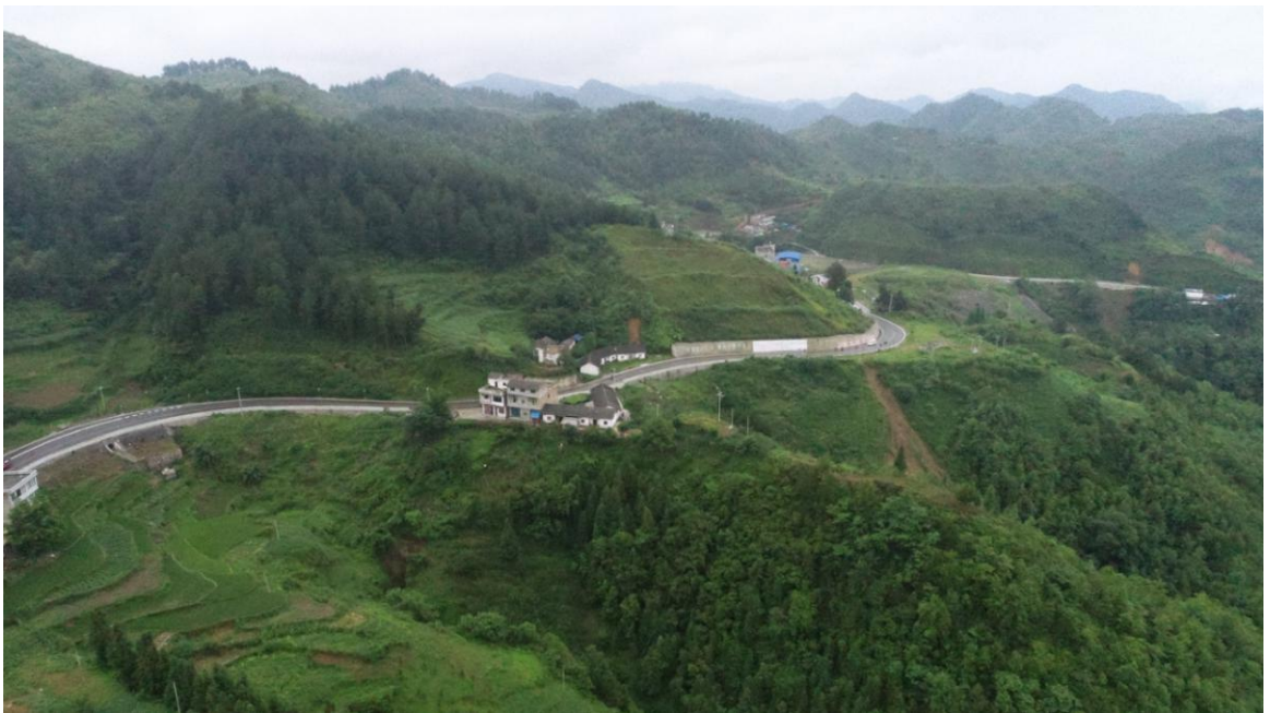
路基工程区水土保持治理效果
