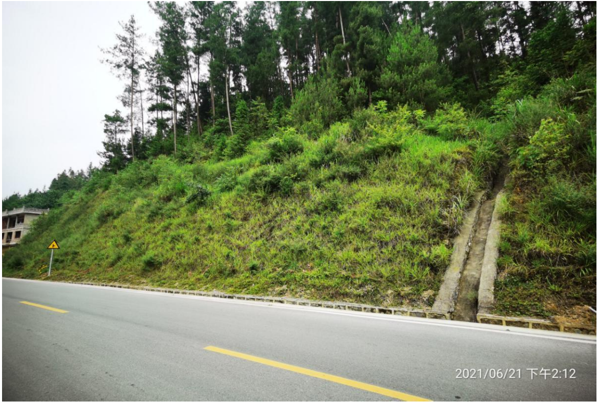
路基工程区两侧绿化（喷播植草）及排水沟、边坡截水沟实施情况
