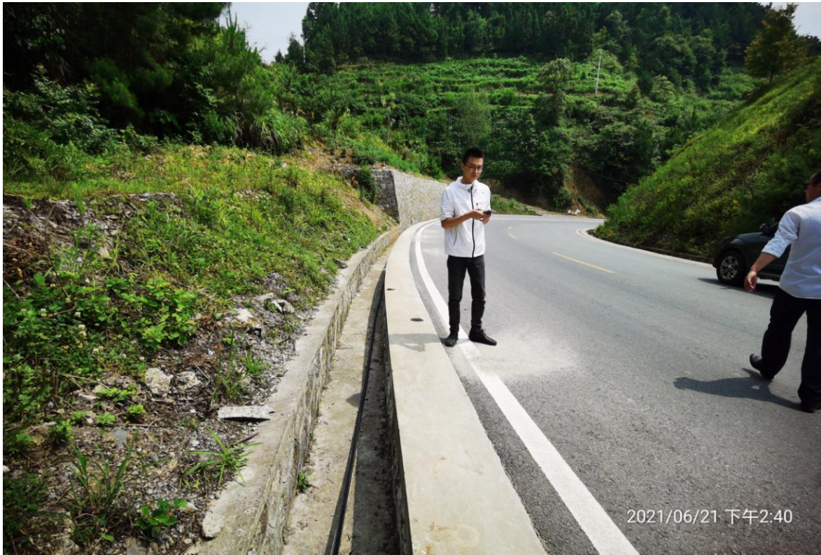
监测人员巡查调查道路两侧水土保持措施实施情况
