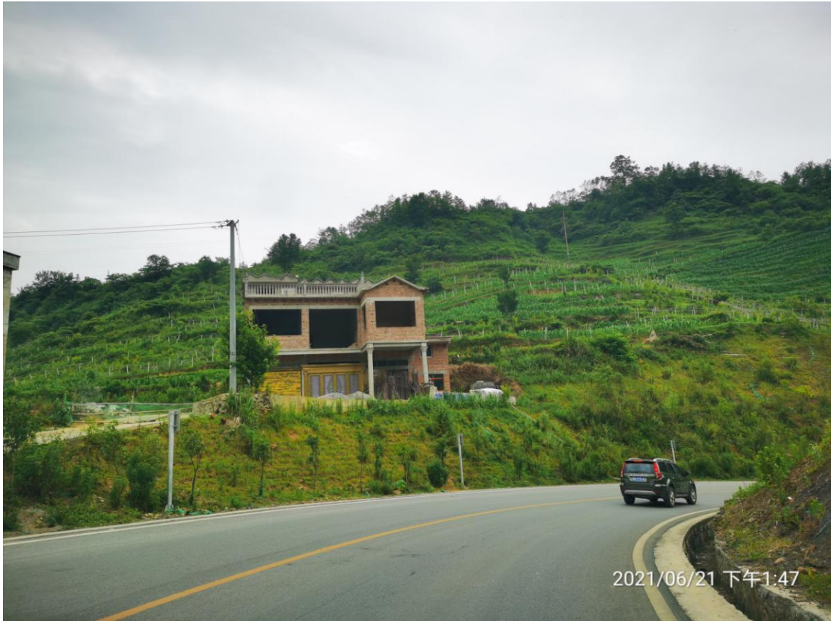
路基工程区两侧绿化（喷播植草）及排水沟实施情况
