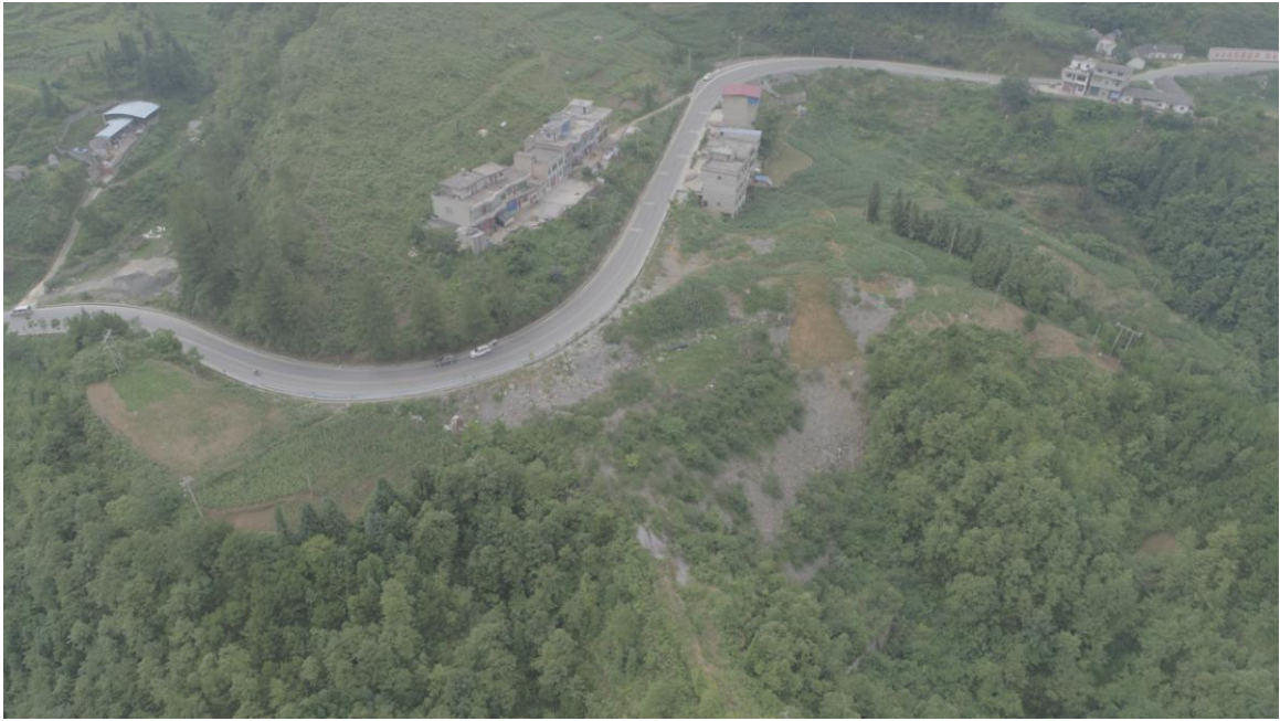
路基工程区两侧水土保持治理效果
