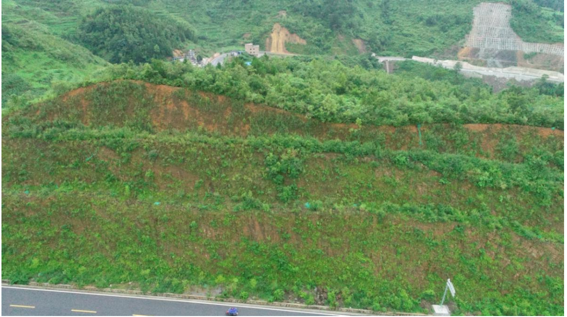
路基工程区两侧水土保持治理效果
