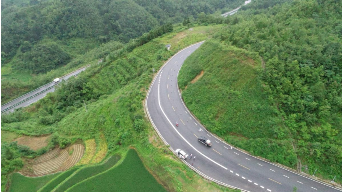
路基工程区两侧水土保持治理效果
