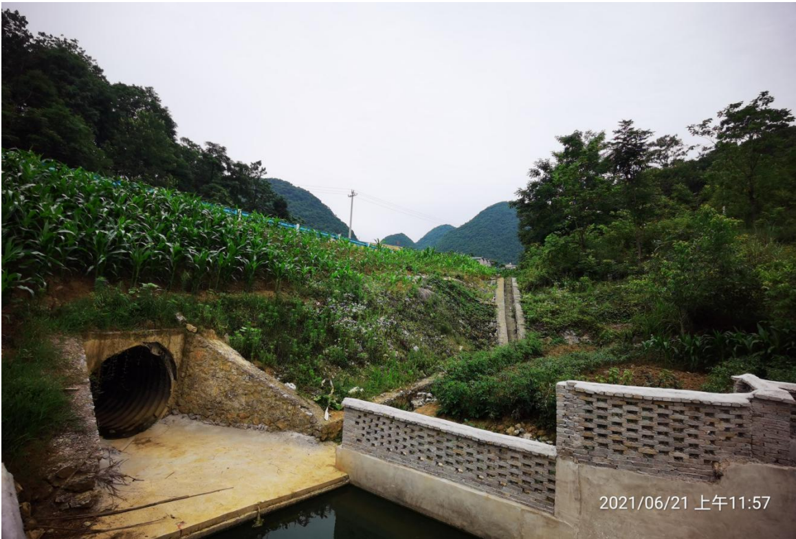
路基工程区两侧绿化、涵洞、排水沟
