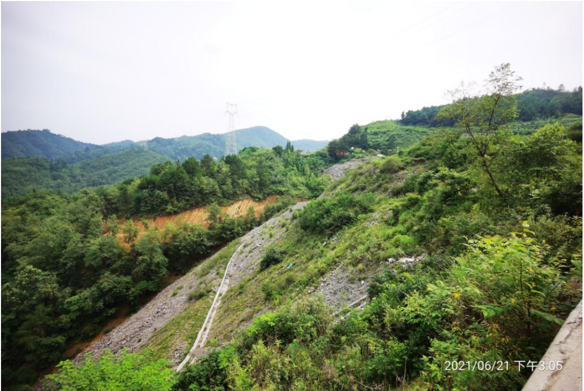
8#弃渣场水土保持治理效果图（挡土墙、排水沟）
