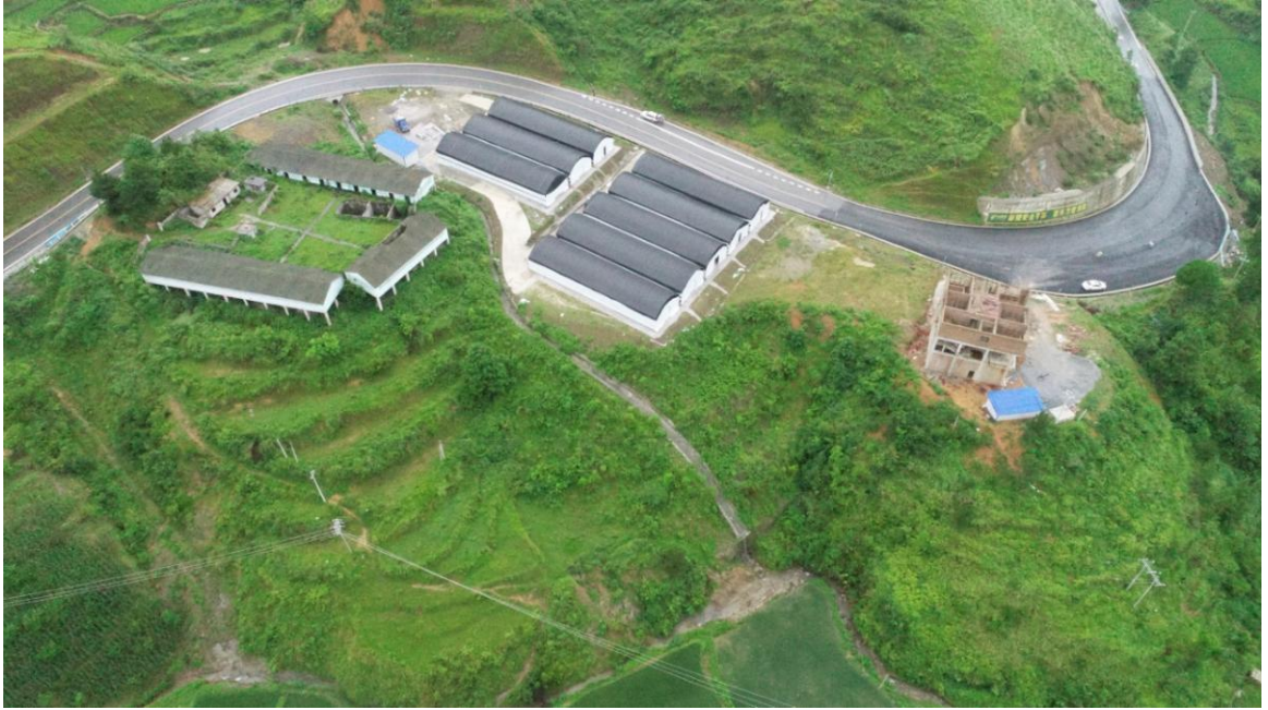
3#弃渣场水土保持治理效果图（挡土墙、截水沟）
