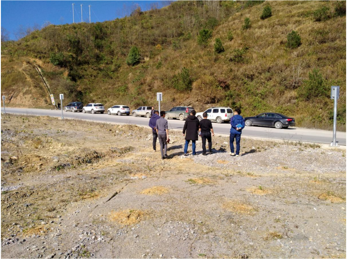
监测小组人员对项目全线实施措施进行调查监测
