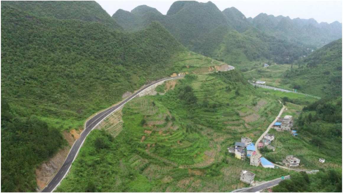
路基工程区两侧水土保持治理效果
