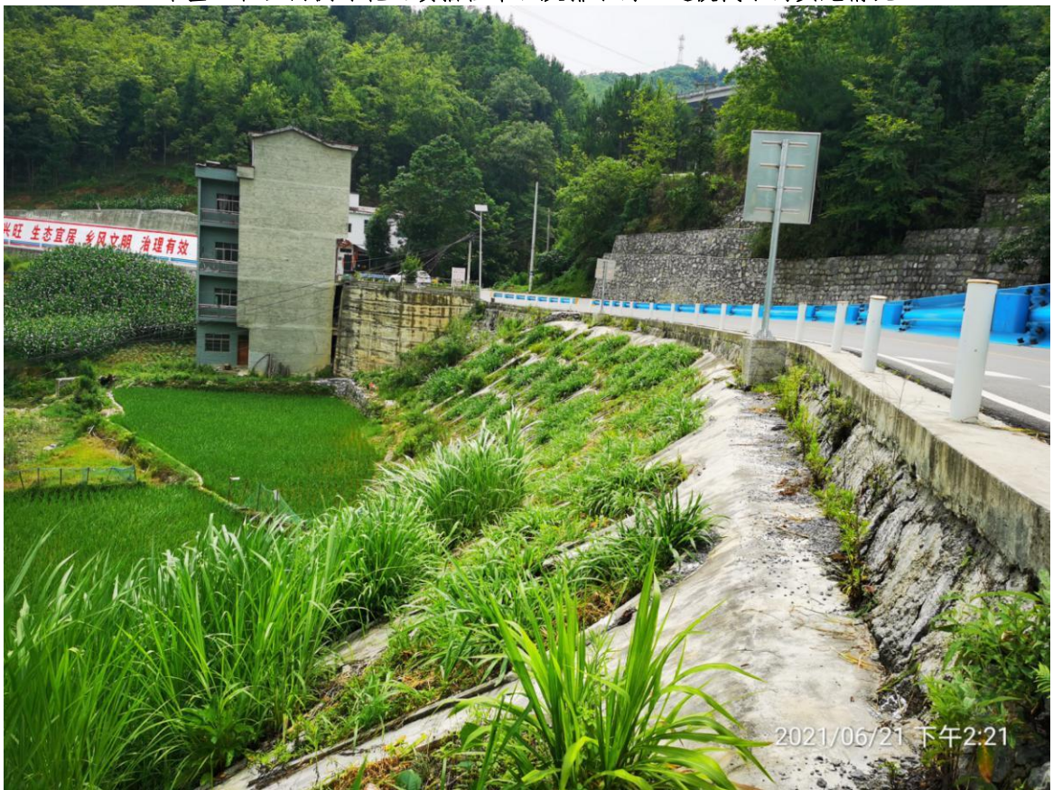
路基工程区拱形护坡及植被实施情况
