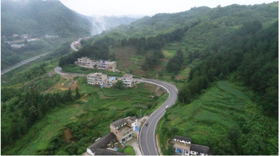
路基工程区水土保持治理效果
