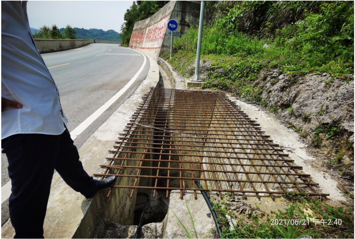
路基工程区涵洞帽石实施情况
