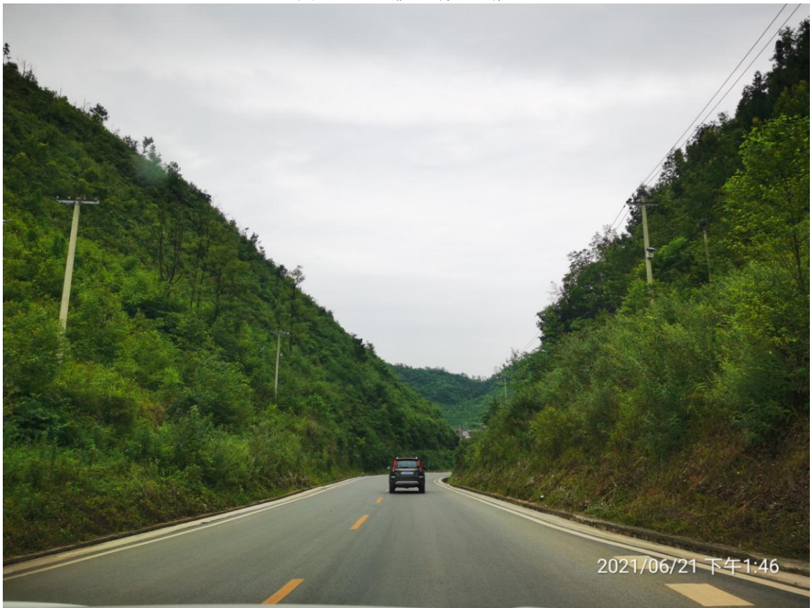
路基工程区两侧绿化及排水沟实施情况
