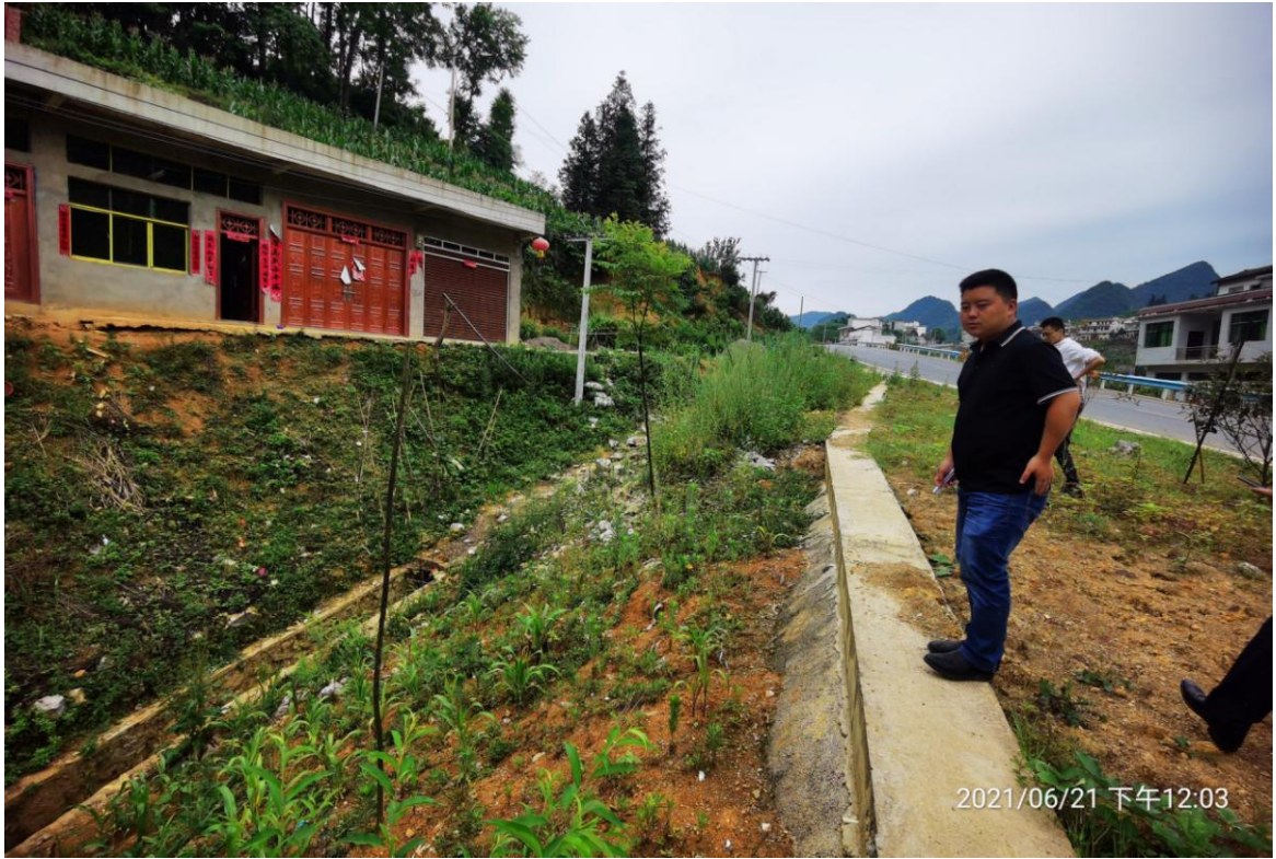
路基工程区排水沟及绿化实施情况
