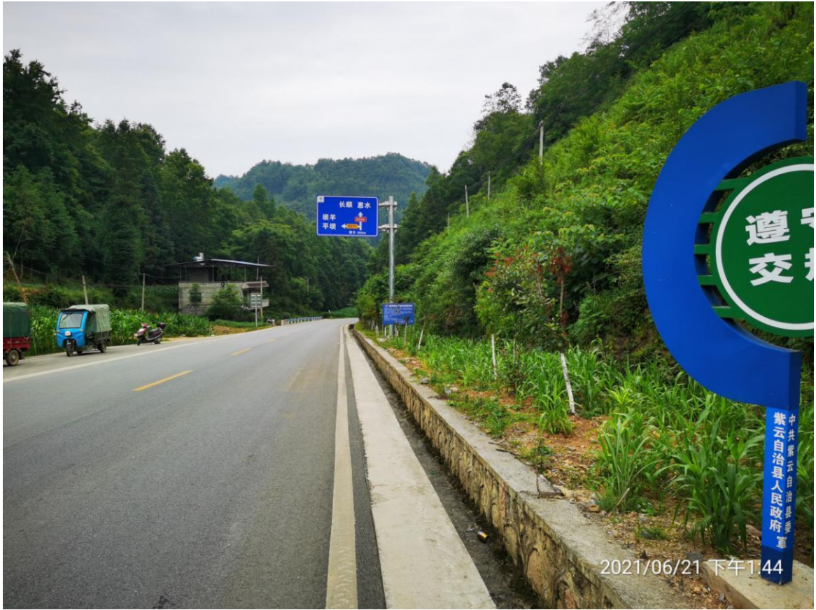
路基工程区排水沟实施情况
