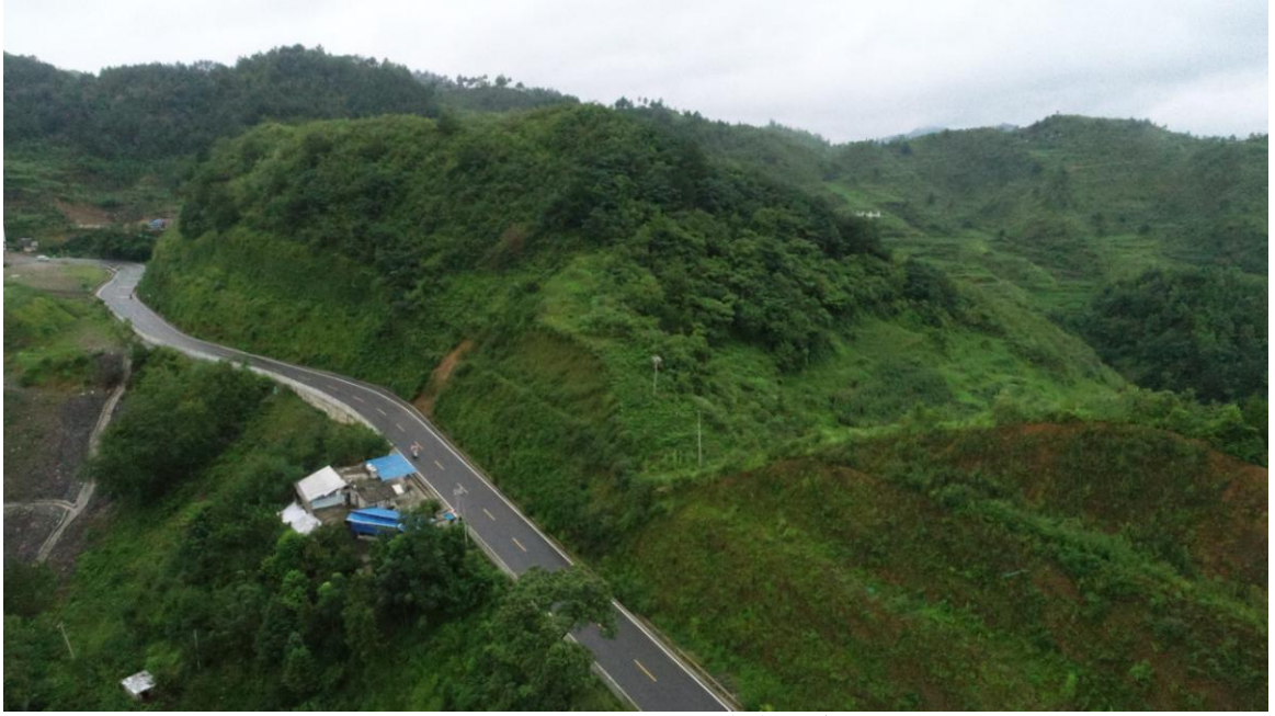
路基工程区两侧水土保持治理效果
