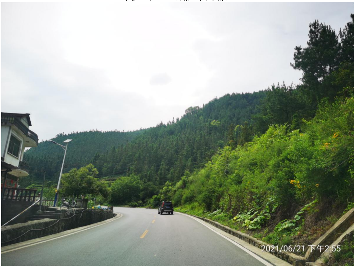
路基工程区两侧绿化（喷播植草）及排水沟、边坡截水沟实施情况
