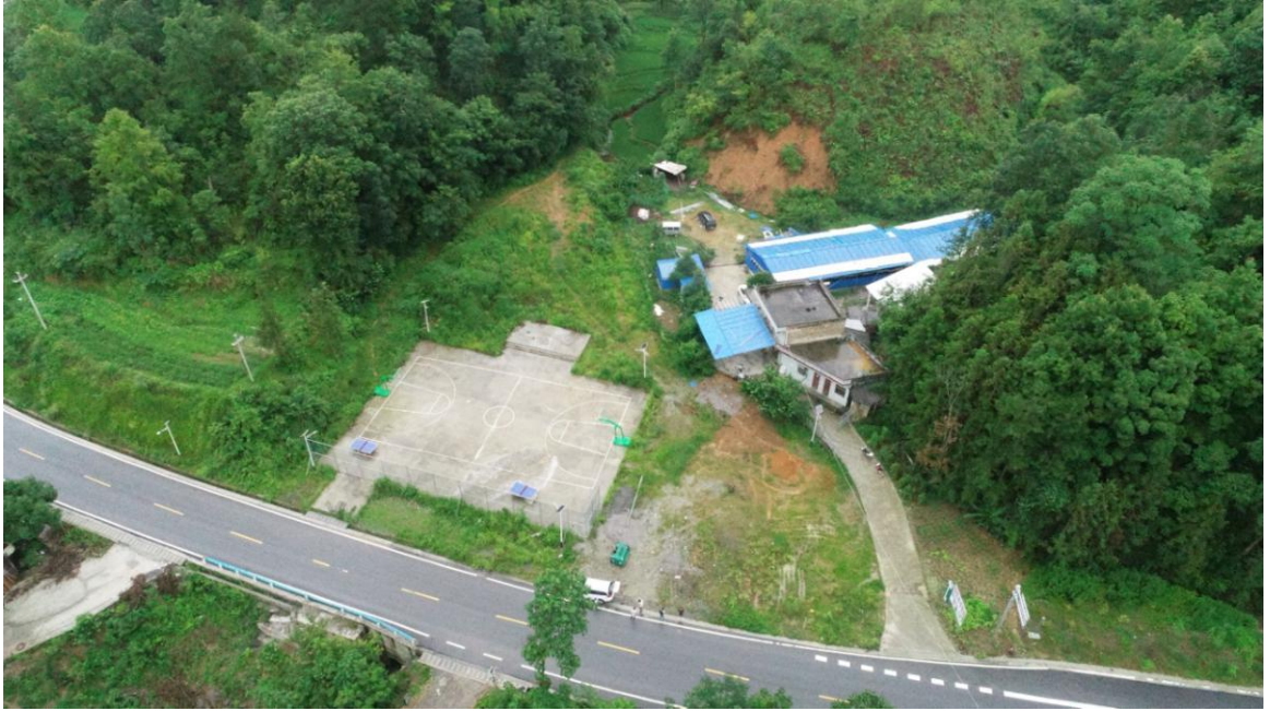
5#弃渣场水土保持治理效果图
