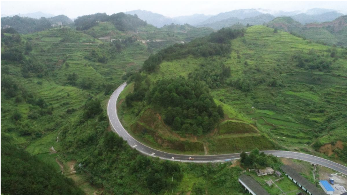
路基工程区两侧水土保持治理效果
