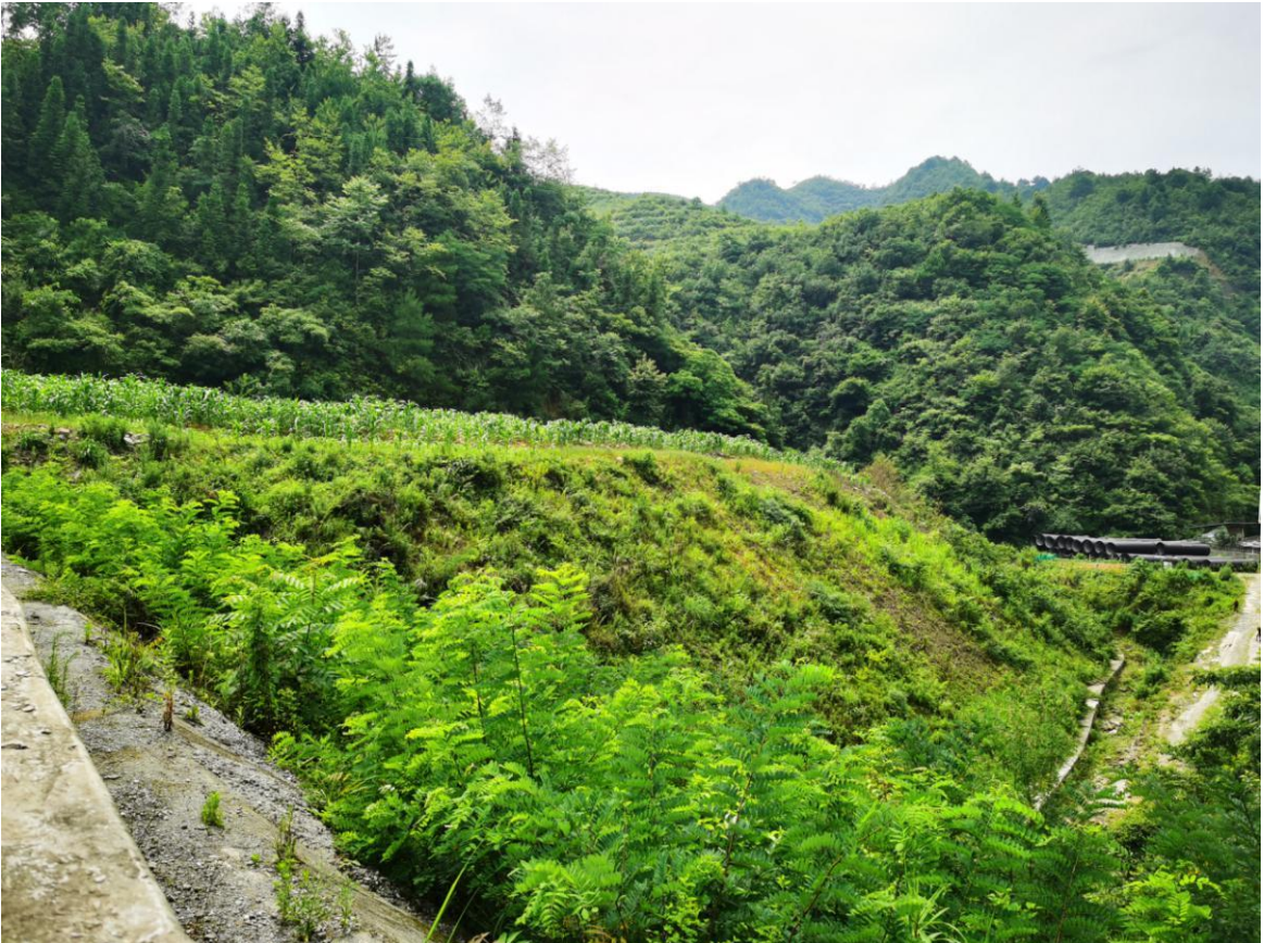
6#弃渣场水土保持治理效果图（挡土墙、截水沟）
