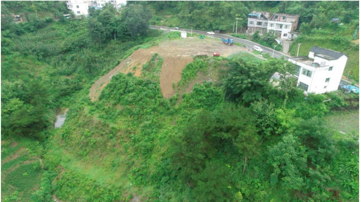
4#弃渣场水土保持治理效果图
