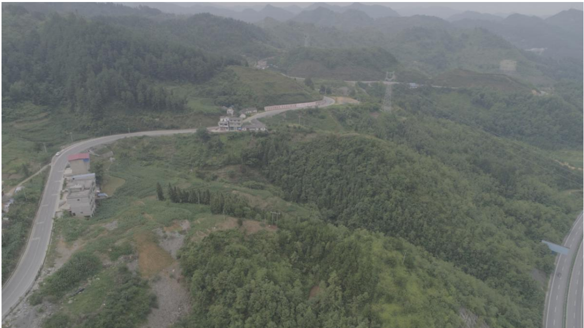
路基工程区两侧水土保持治理效果
