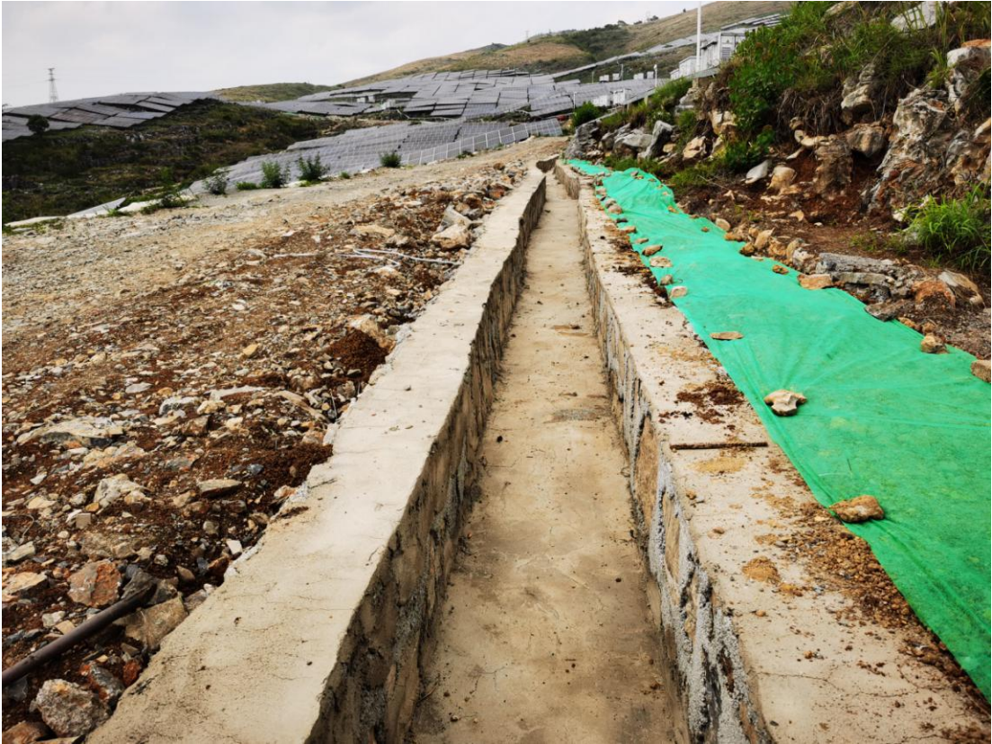
巡查调查场内道路水土保持措施（排水沟）实施情况
