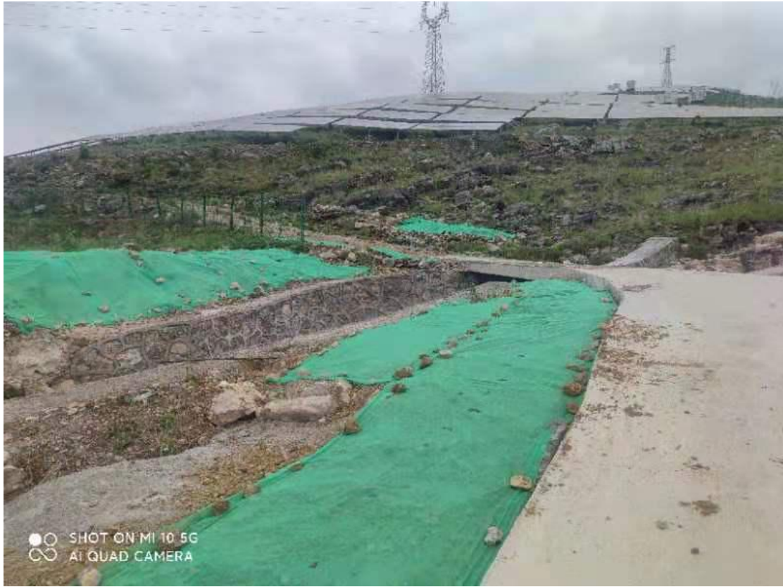
场内道路区过水涵及植物措施
