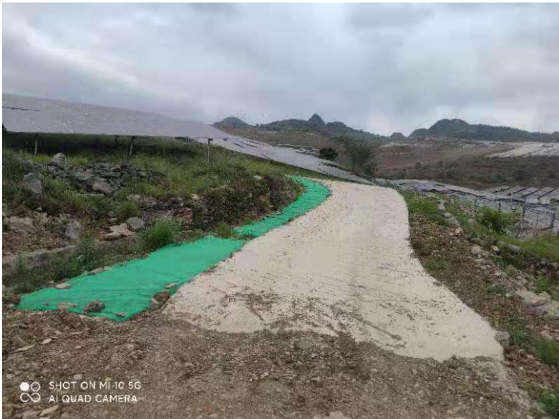
监测小组人员对场内道路区覆土整治区域进行调查监测
