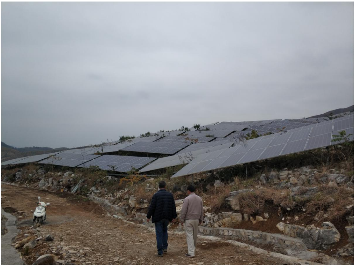
巡查调查场内道路水土保持措施实施情况
