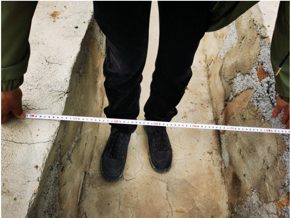
监测小组人员对场内道路区排水沟尺寸进行调查监测
