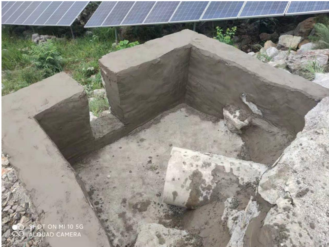
调查道路区域水土保持措施（沉砂池）实施情况
