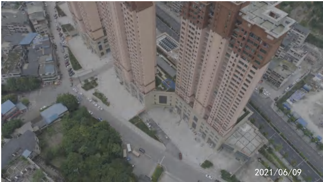
道路广场区航拍图
