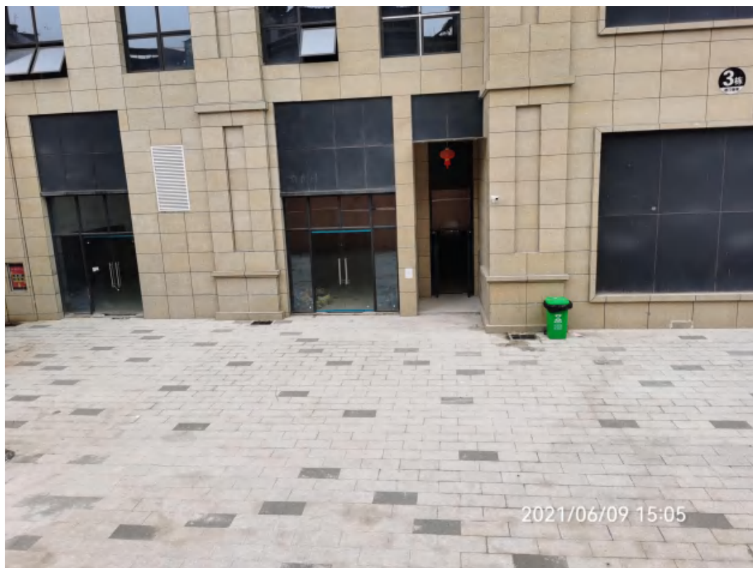
房屋建筑区雨水管（地下）/雨篦子
