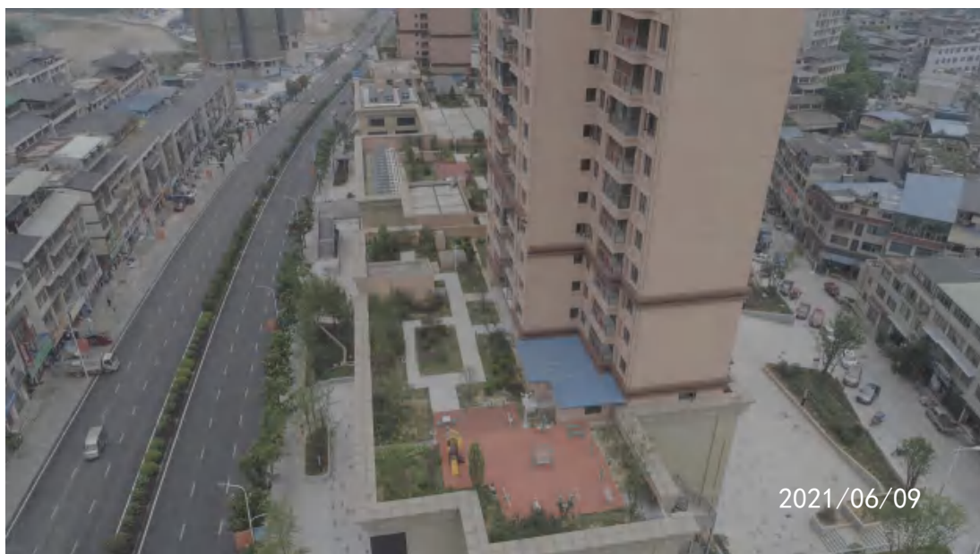
屋顶花园航拍图
