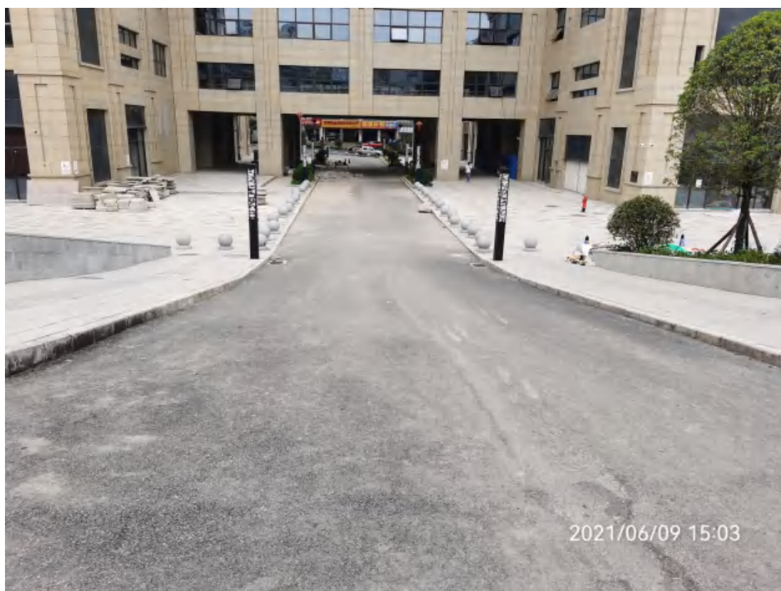
道路广场区、房屋建筑区
