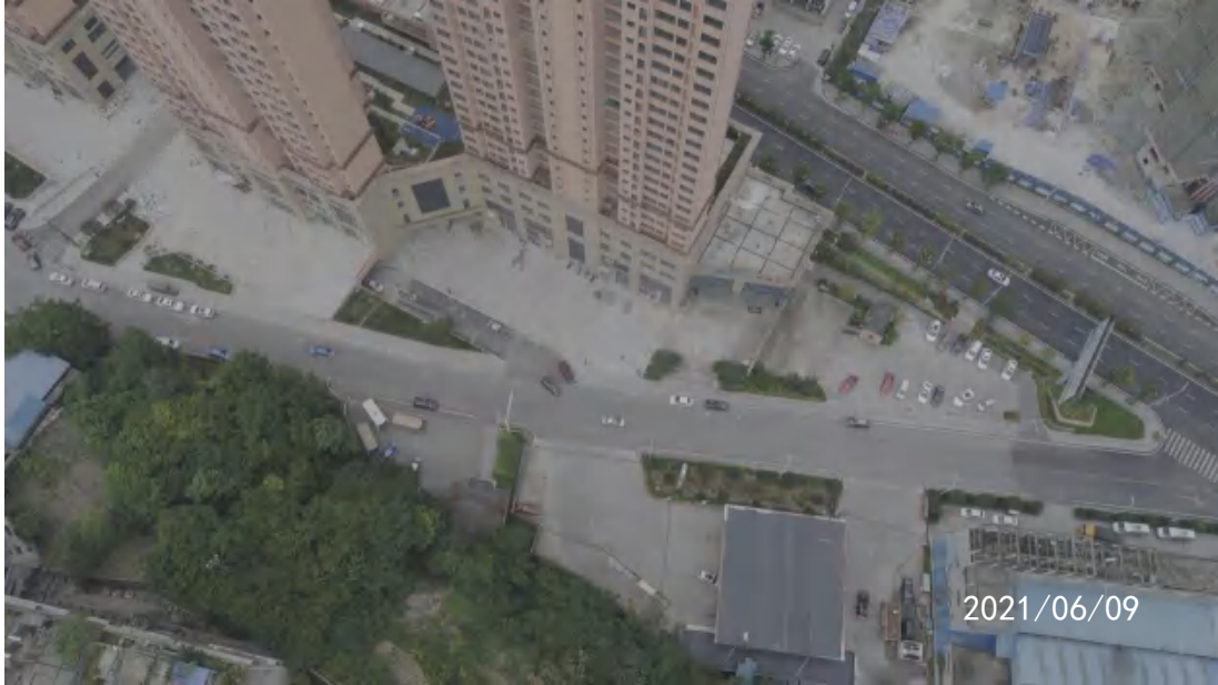
道路广场区航拍图
