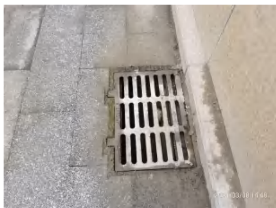
雨篦子/雨水管（地下）
