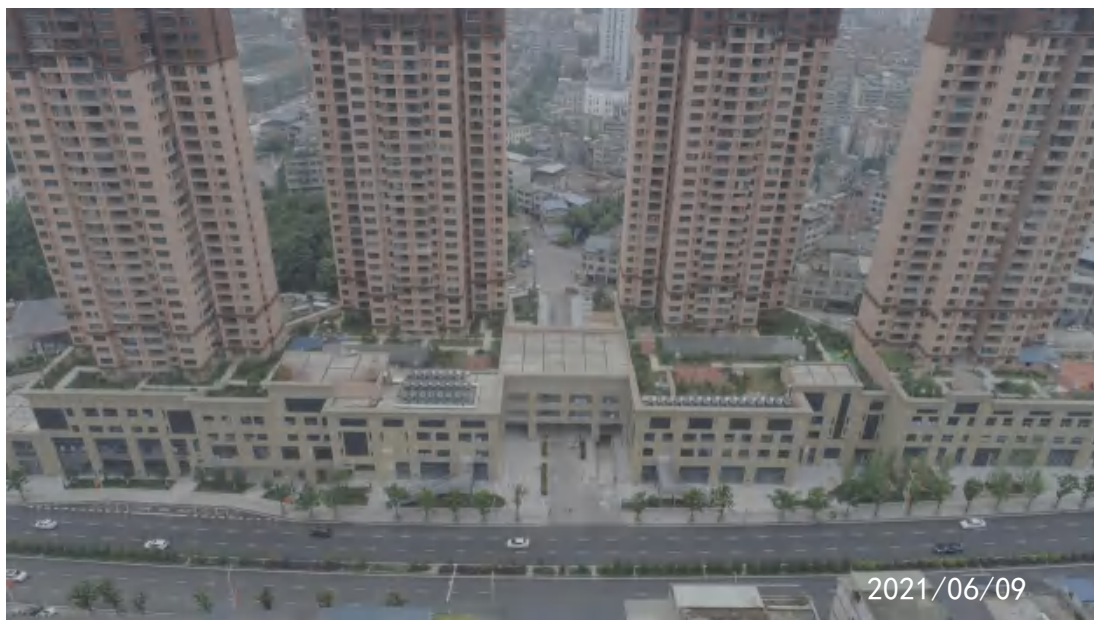
房屋建筑区航拍图
