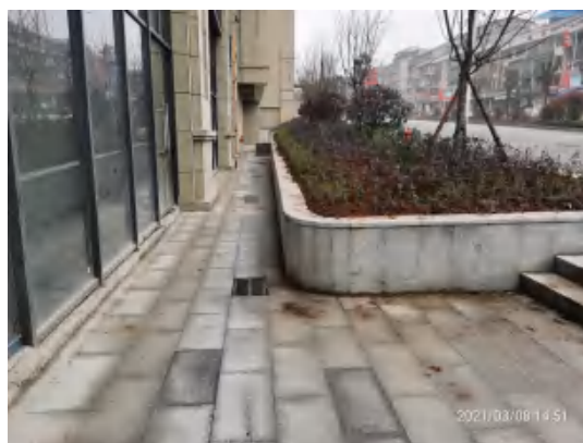
雨篦子/雨水管（地下）
