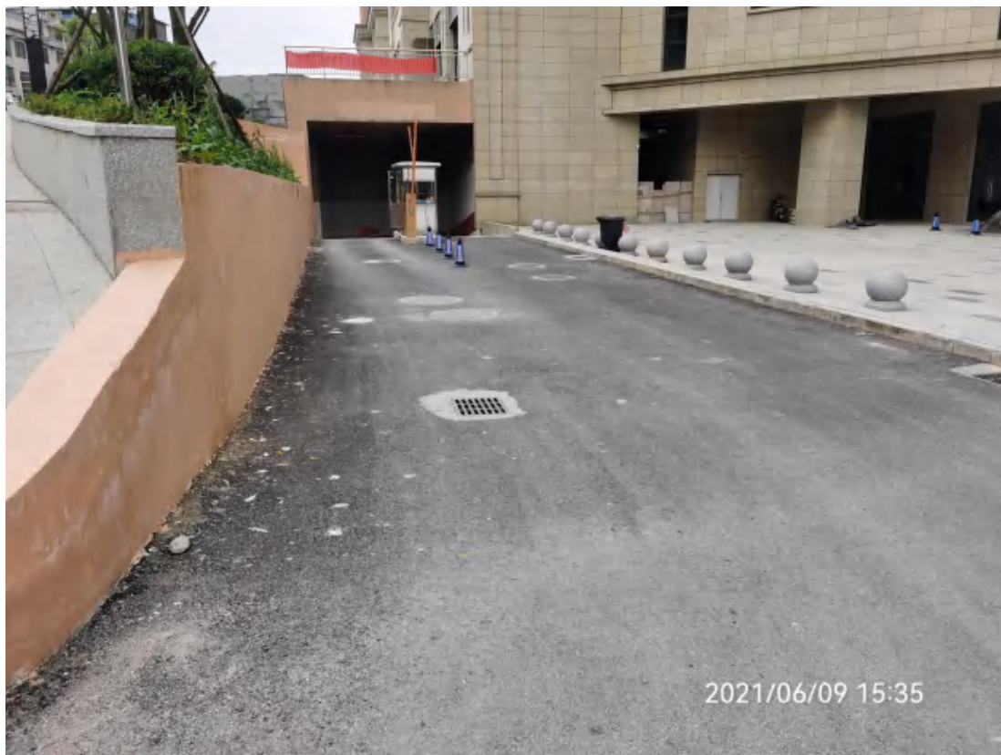
道路广场区雨水管（地下）/雨篦子
