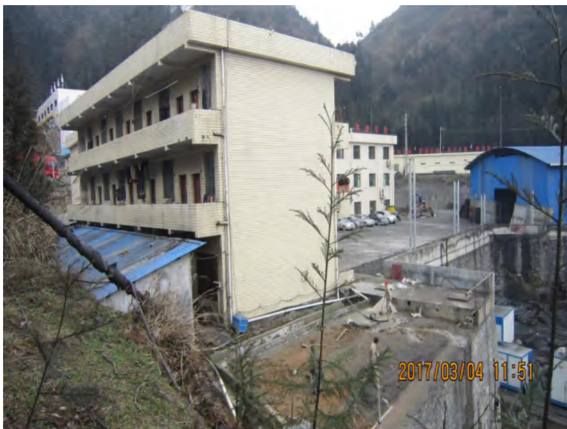
工业场地区地表硬化
