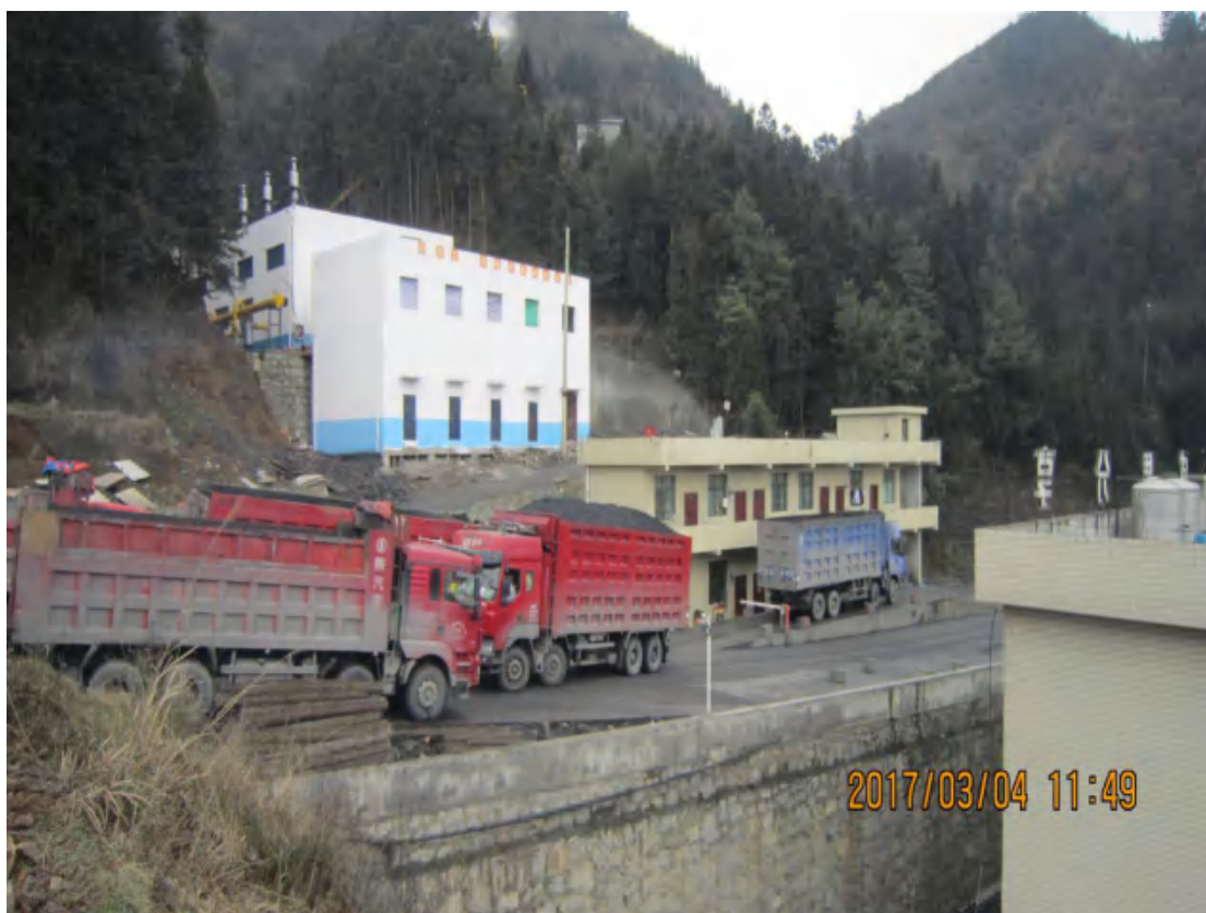
工业场地区地表硬化
