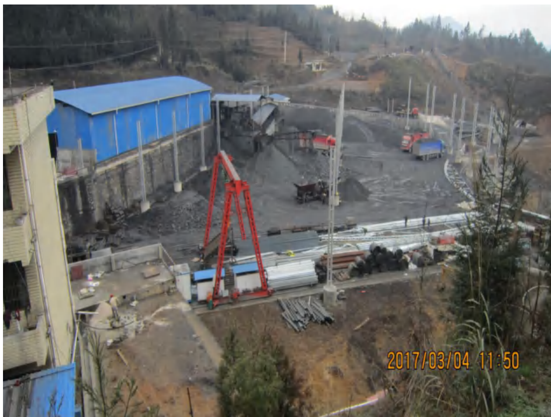
工业场地区地表硬化
