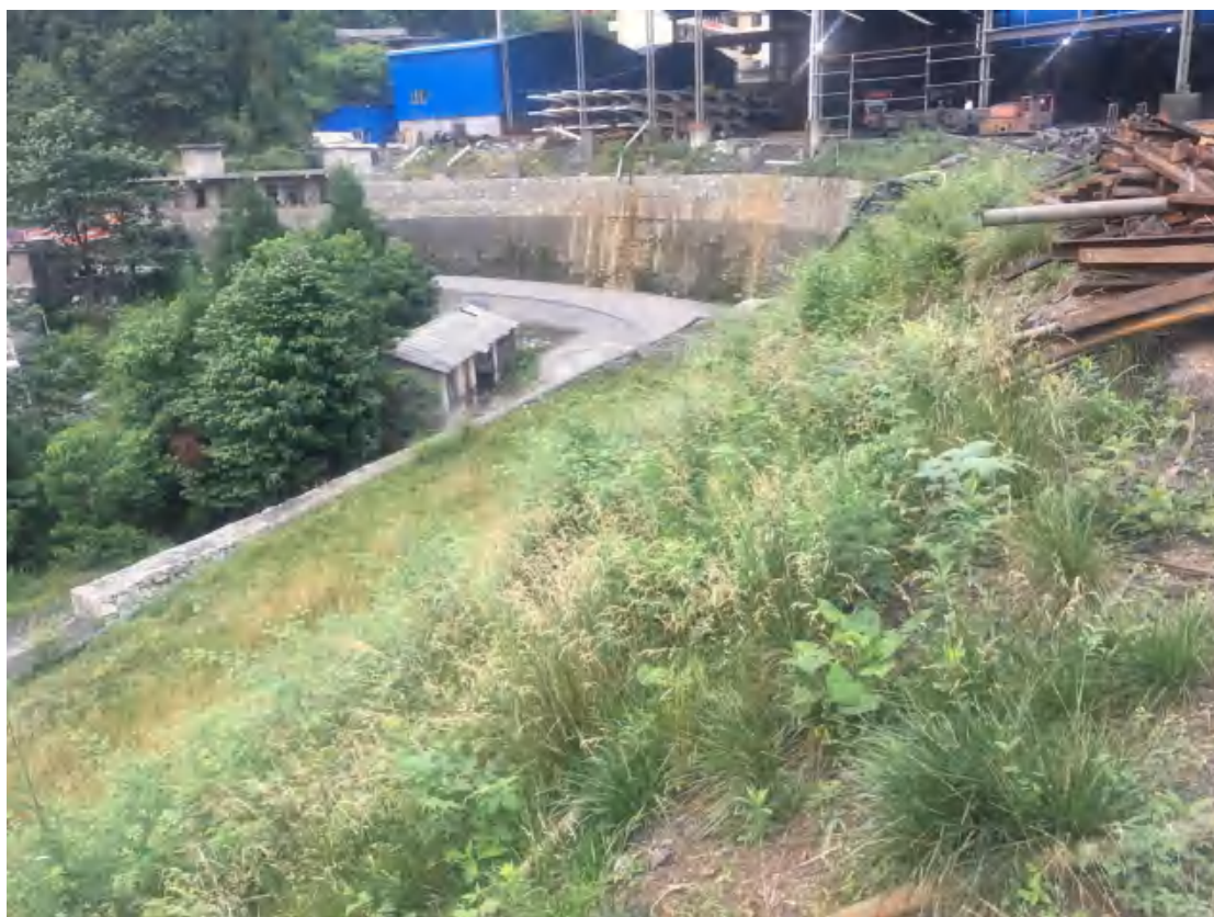
工业场地区下边坡植被恢复
