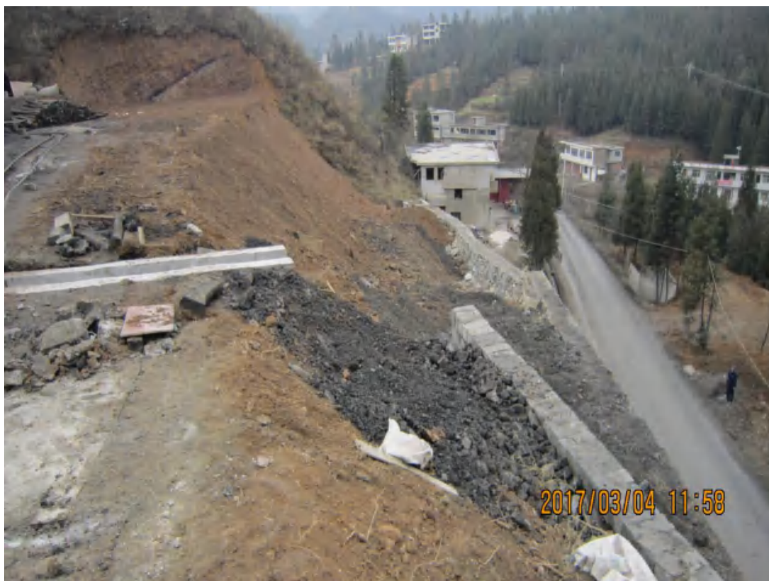
工业场地区边坡覆土及挡土墙
