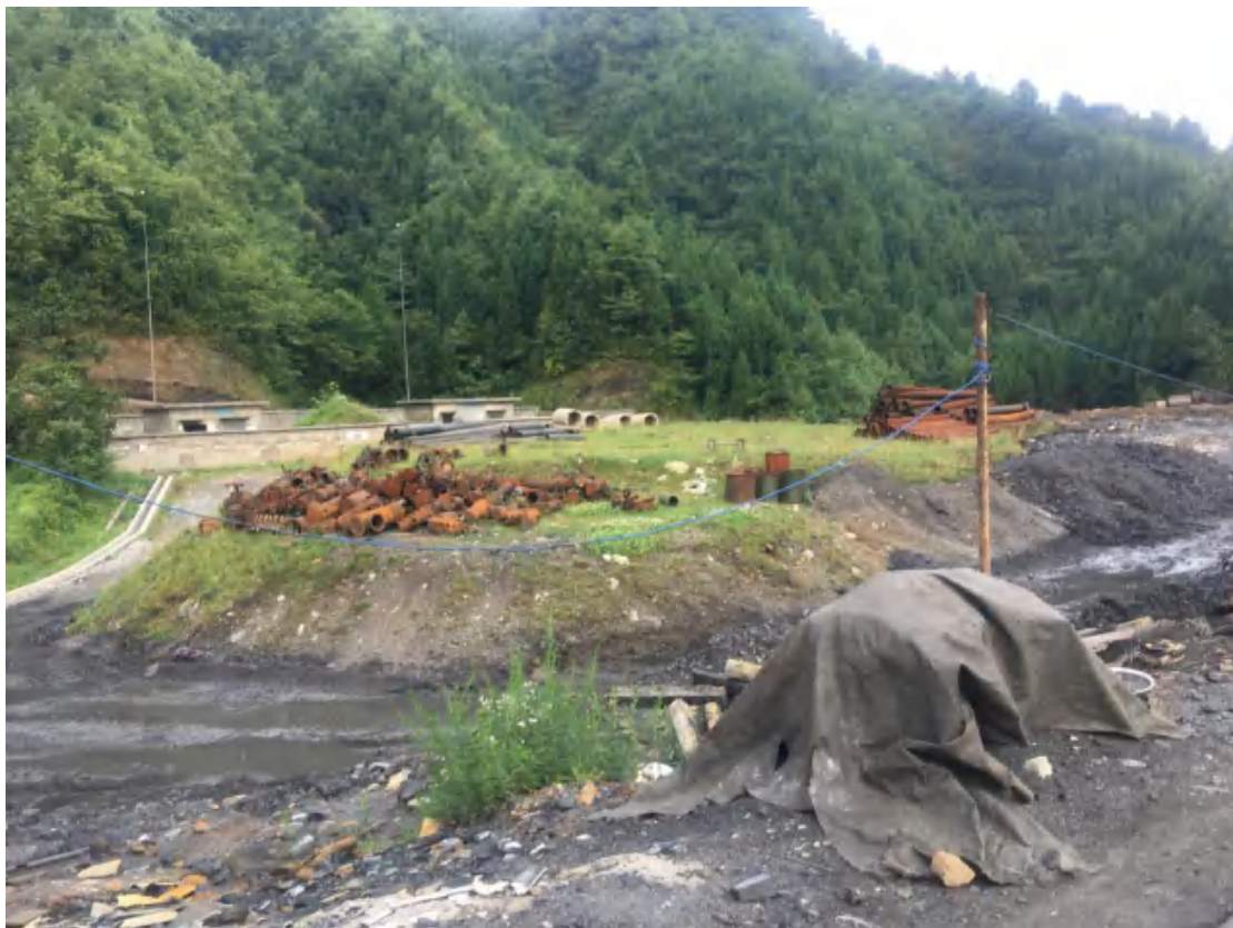
排矸场及炸药库
