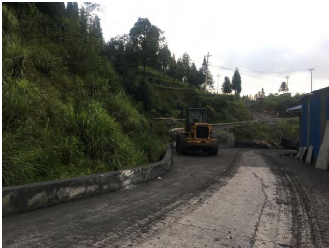
工业场地排水沟
