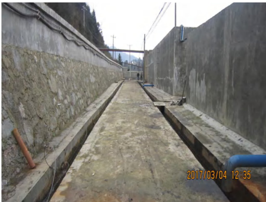
污水处理厂区
