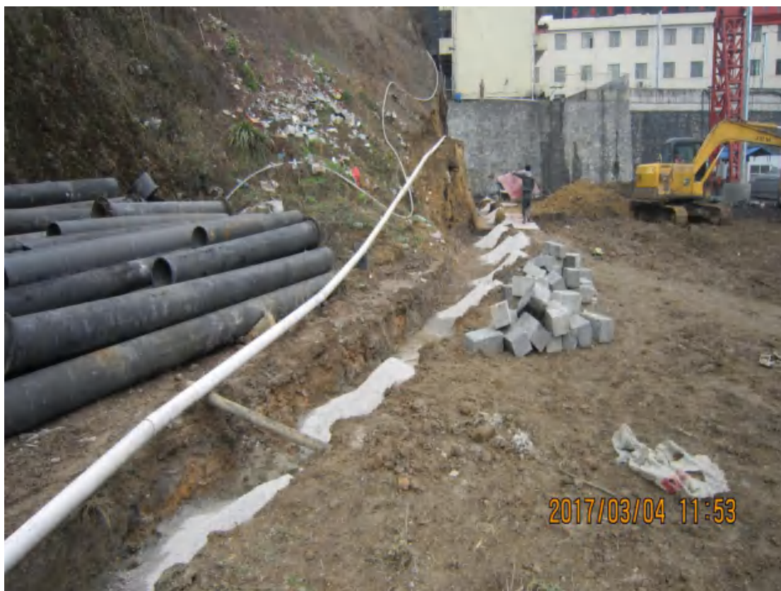
工业场地区排水沟开挖
