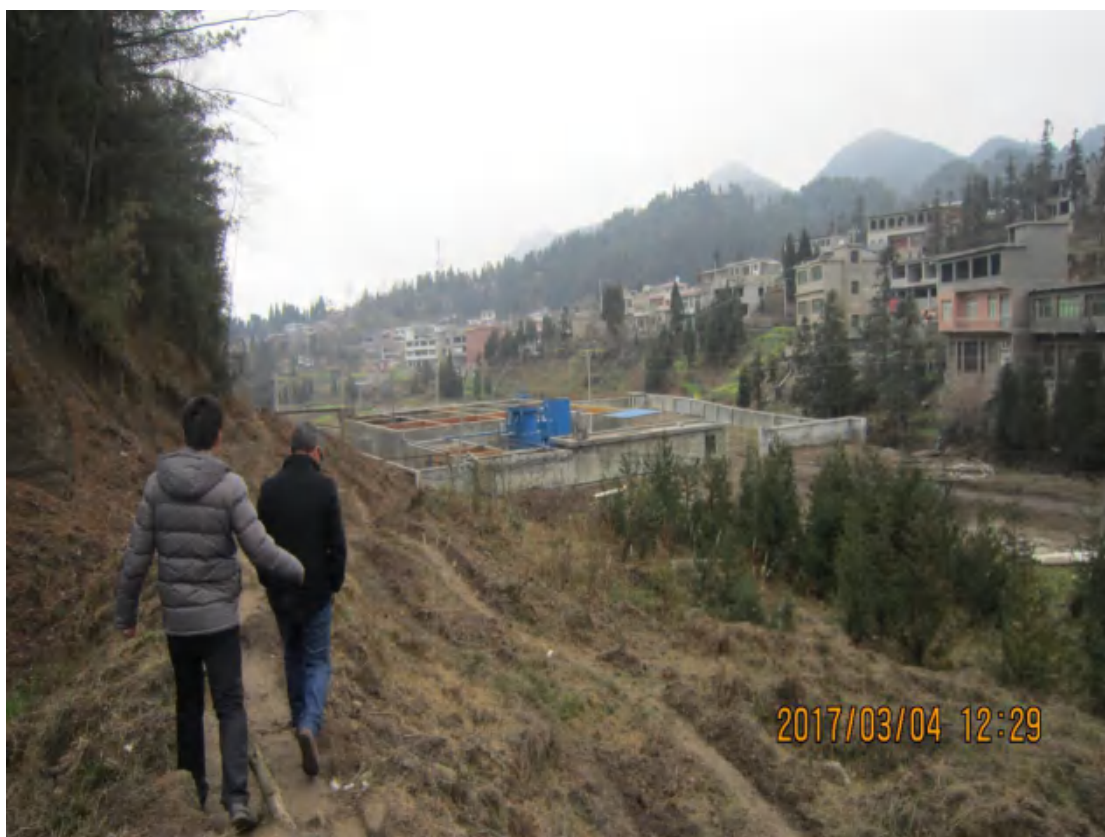
污水处理厂区
