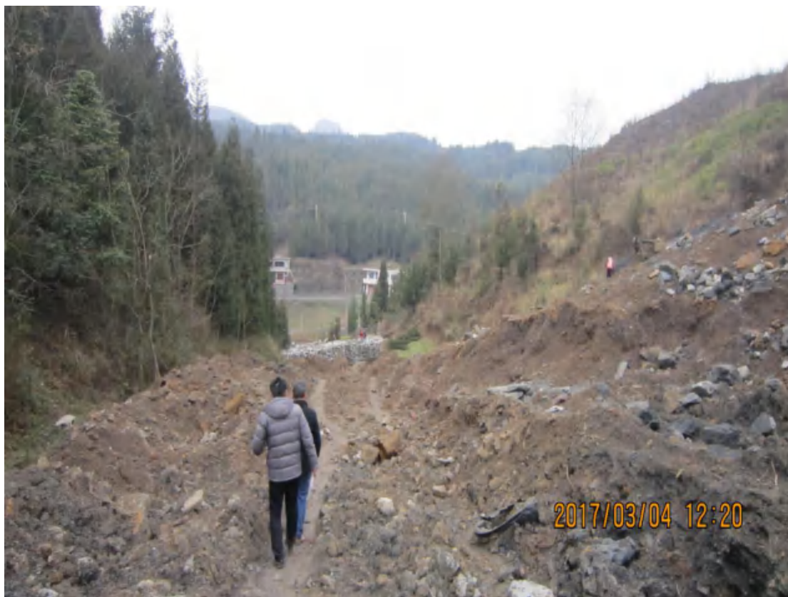
排矸场挡土墙
