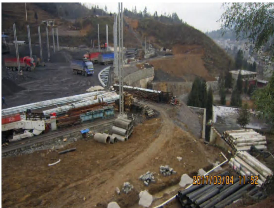
工业场地区地表硬化
