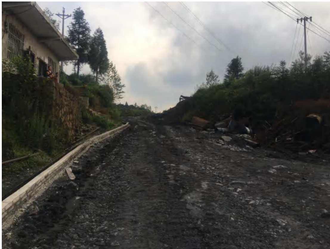
排矸场进场道路排水沟
