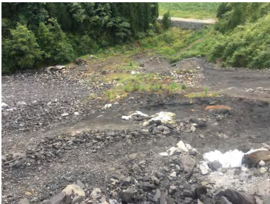
排矸场区挡土墙砌筑完成
