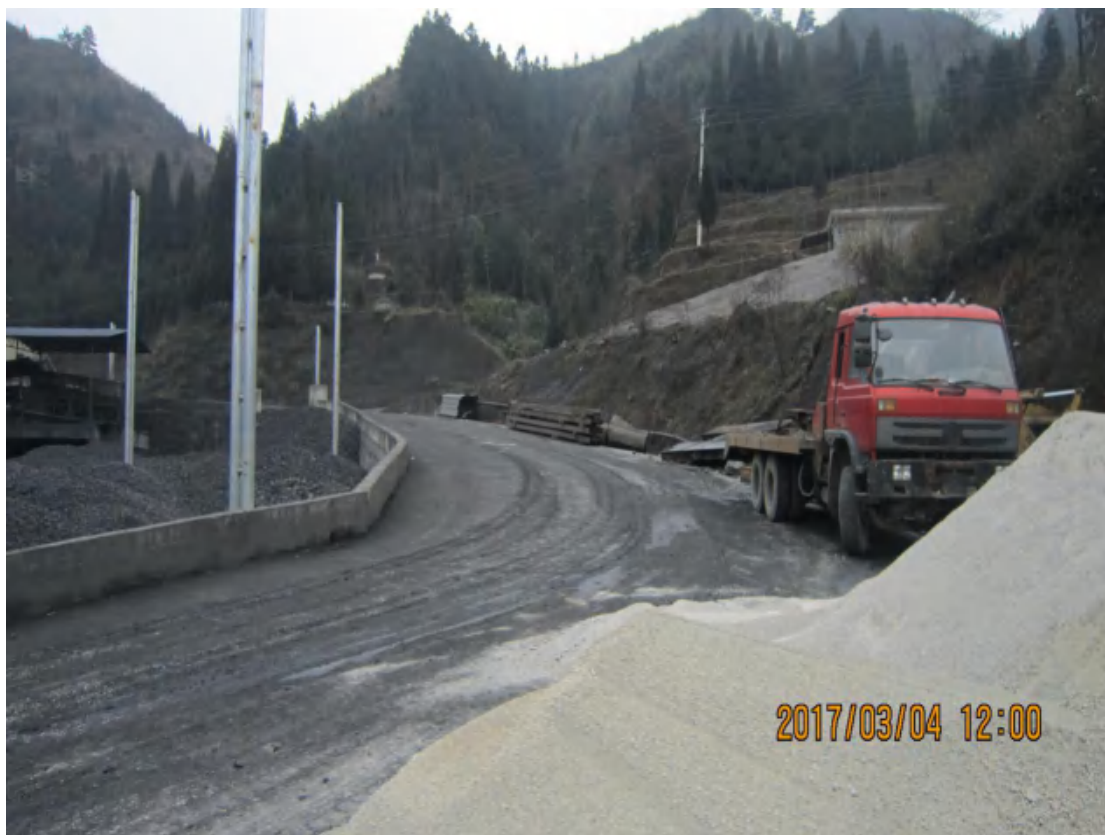
工业场地区地表硬化
