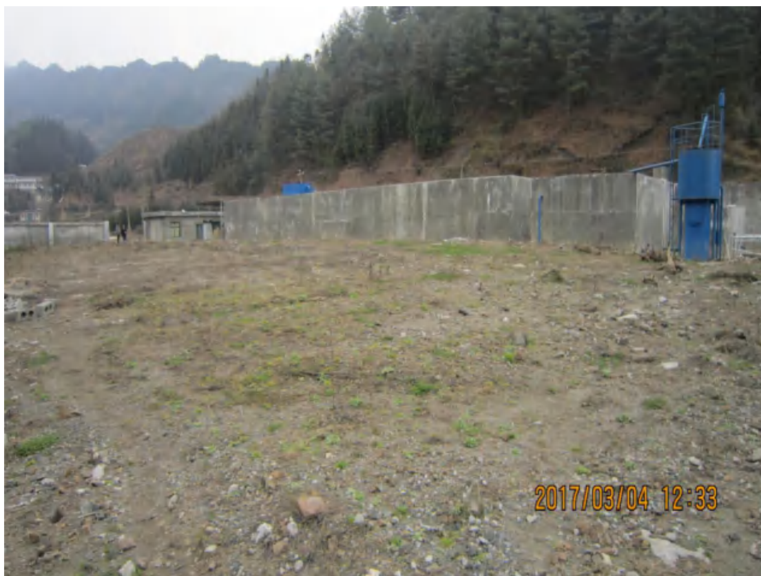
污水处理厂区
