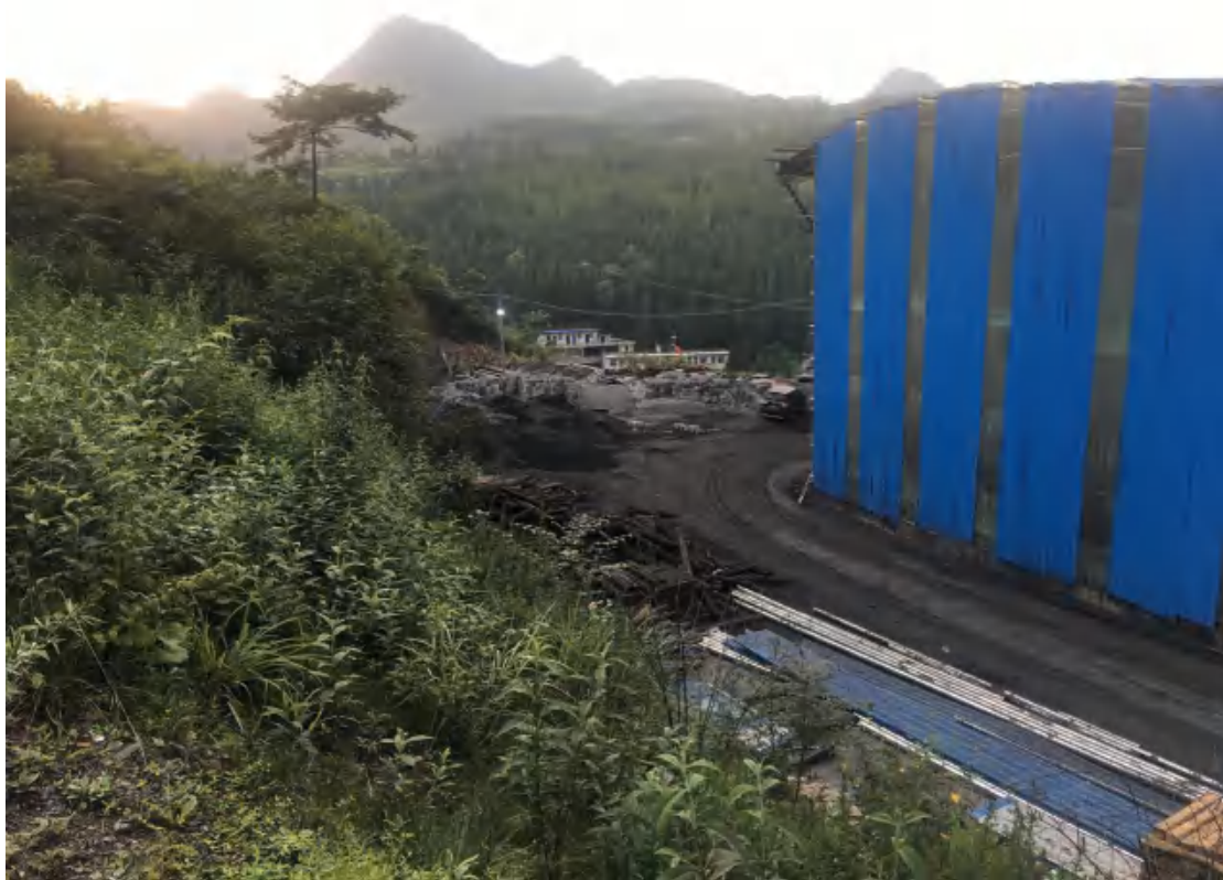
工业场地区上边坡植被恢复
