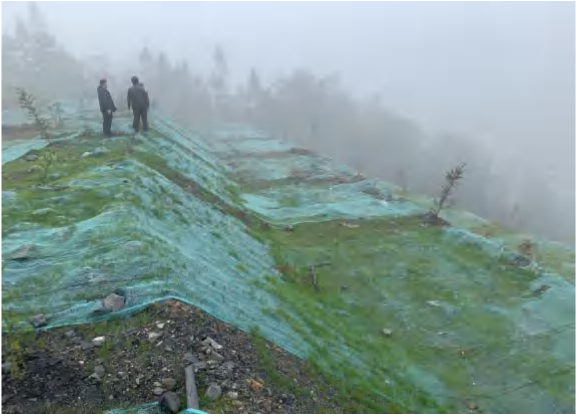
排矸场区植被恢复
