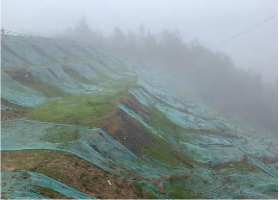
排矸场区植被恢复
