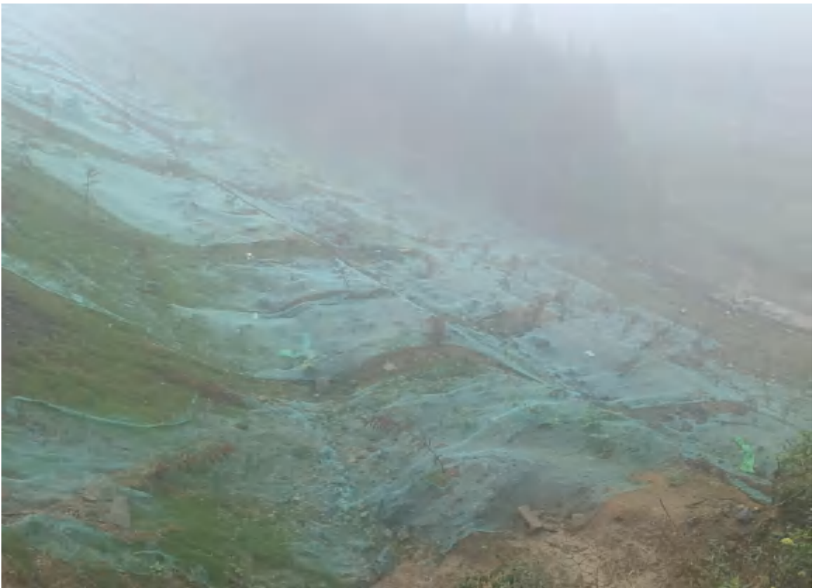
排矸场区植被恢复
