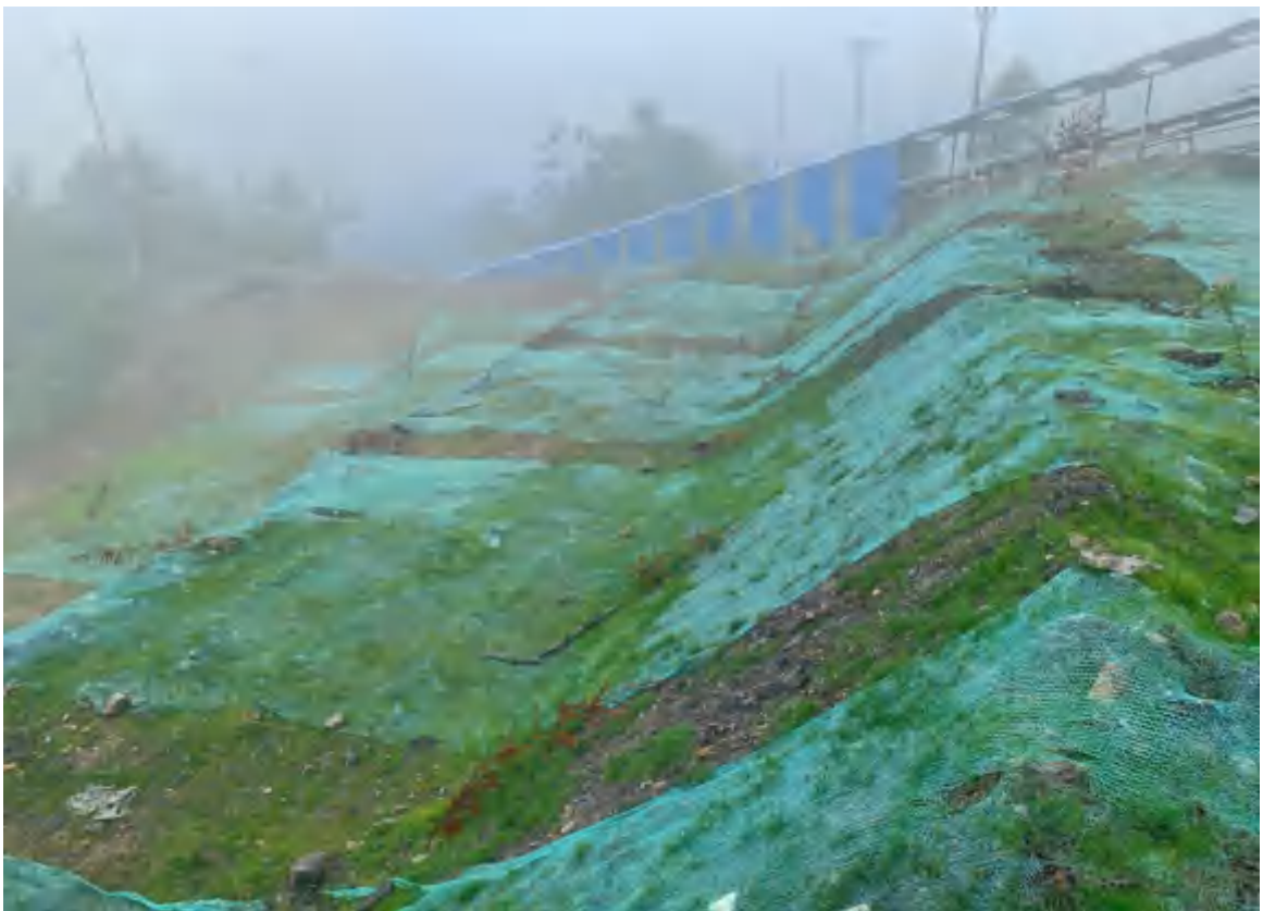
排矸场区植被恢复
