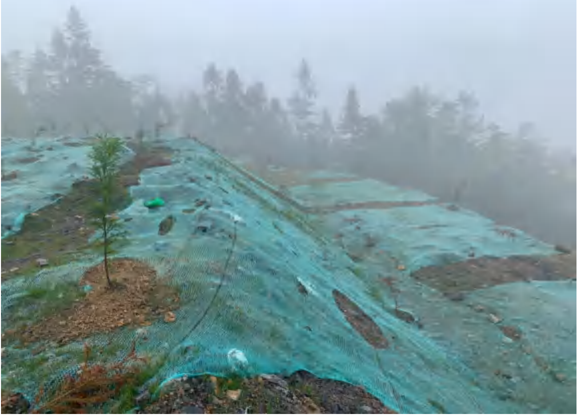
排矸场区植被恢复
