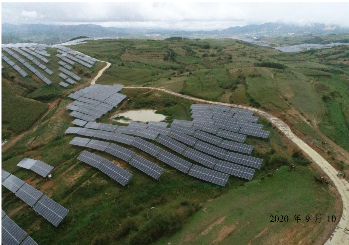
七舍梁子光伏 2 区监测
