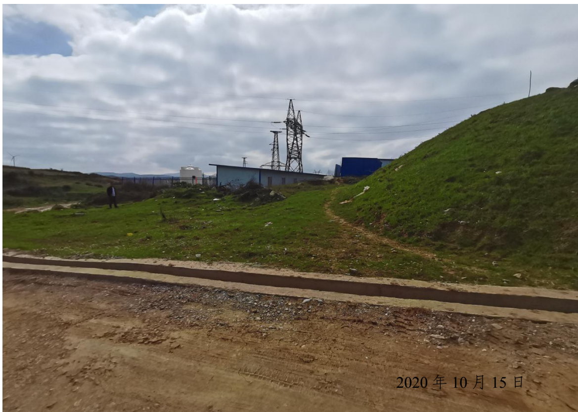
七舍梁子临时施工场地排水及绿化
