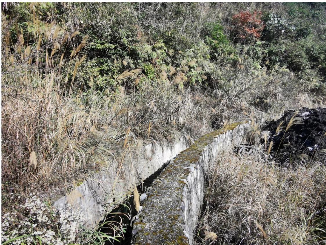
弃渣场区（排洪沟）
