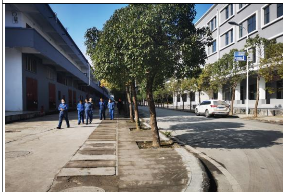
厂区（盖板排水沟）
