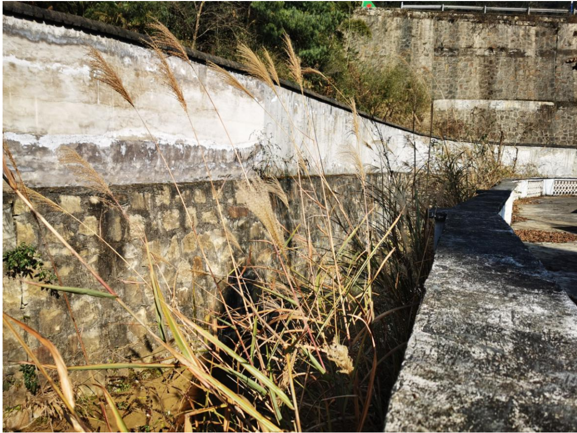
厂区（河流改道区）治理效果
