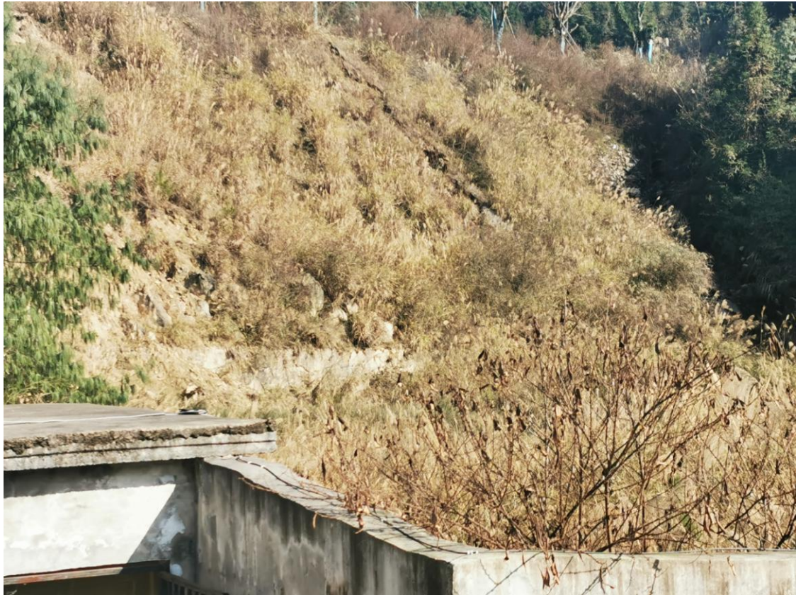
弃渣场区（挡渣墙）
