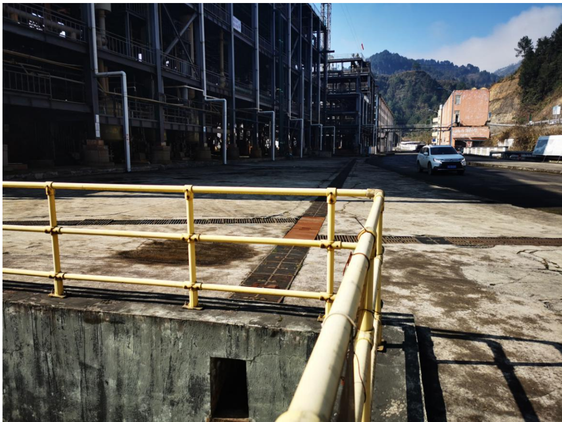
厂区（生产区）排水措施
