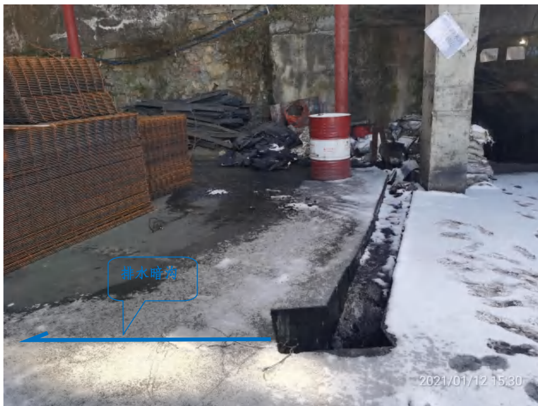
西风井场地区排水沟
