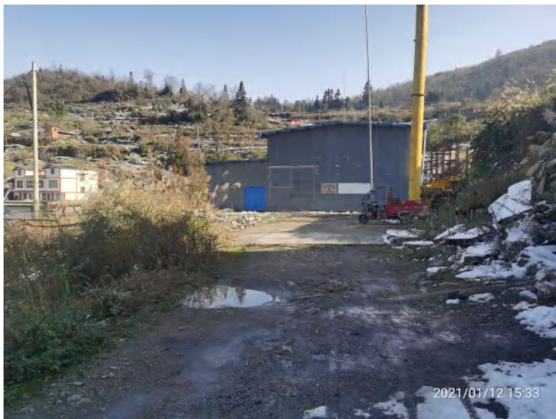
西风井场地区（瓦斯发电站）
