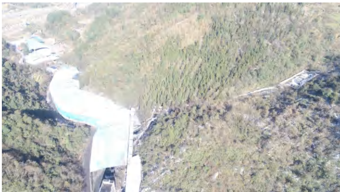
工业场地——进场道路——炸药库（航拍时间：2021.01.12）
