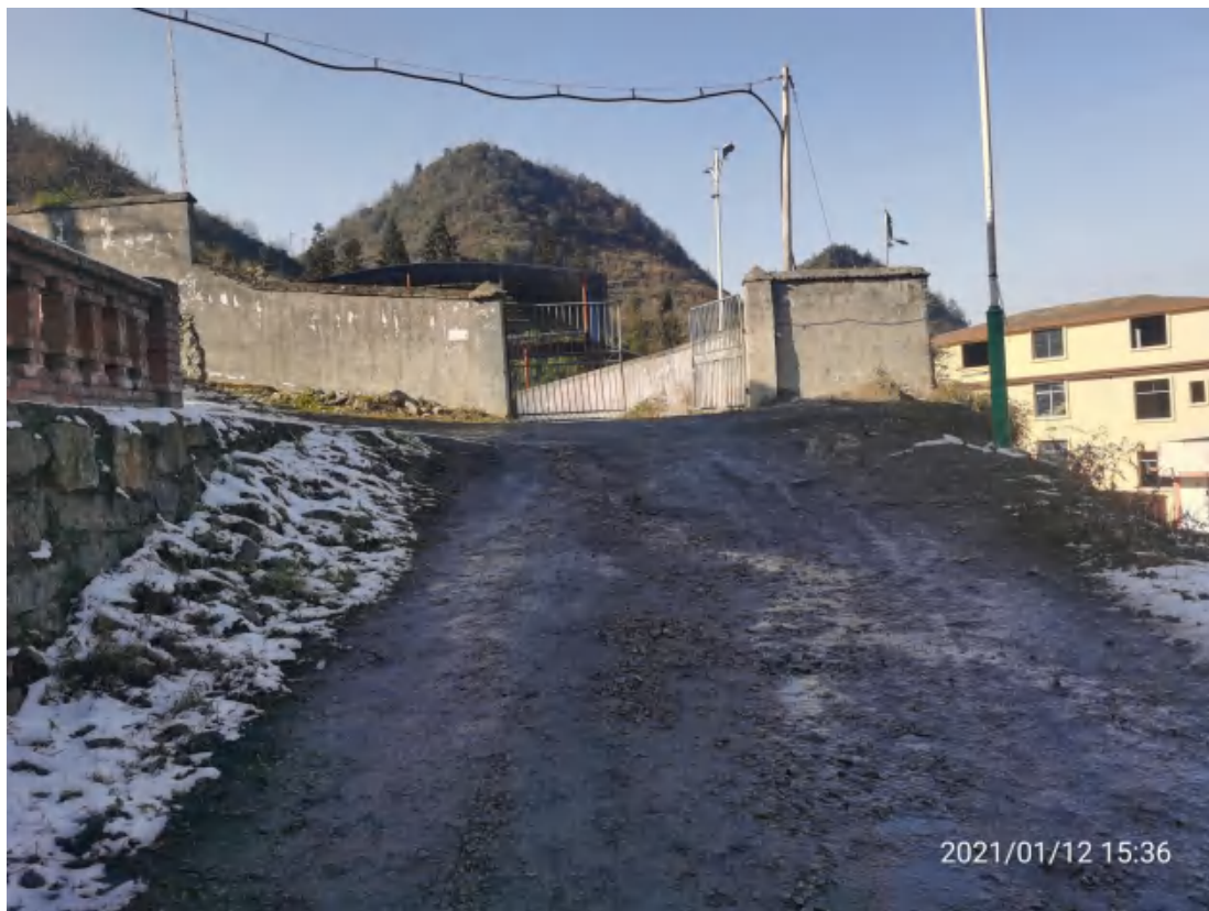
进西风井场地区道路
