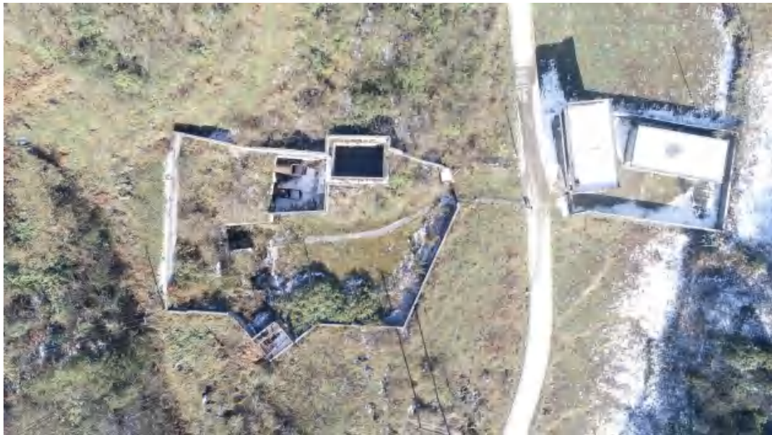
东风井场地及值班室（航拍时间：2021.01.12）
