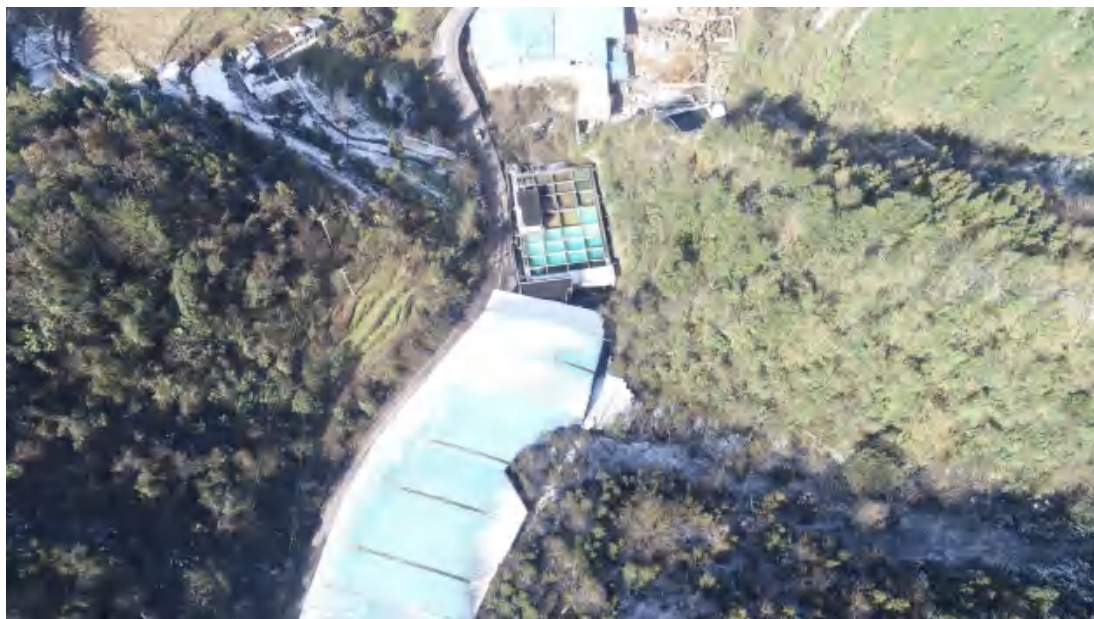
工业场地区污水处理（航拍时间：2021.01.12）
