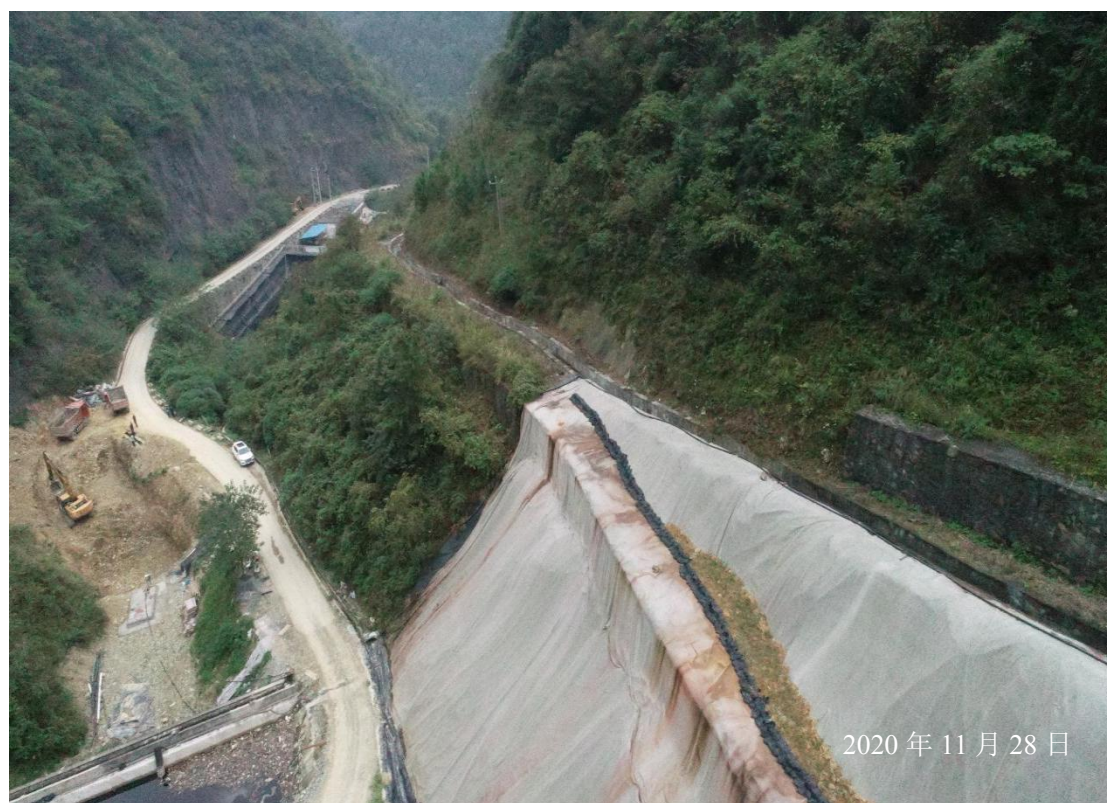
填埋场区截洪沟
