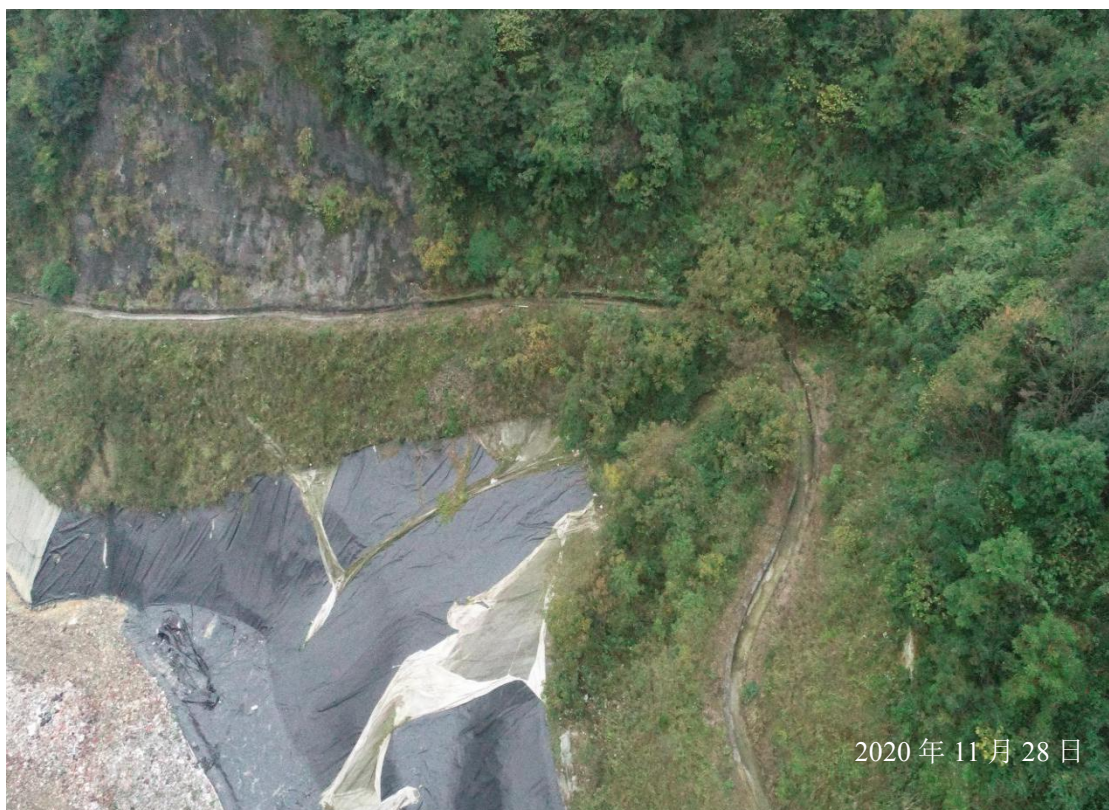
填埋场区截洪沟
