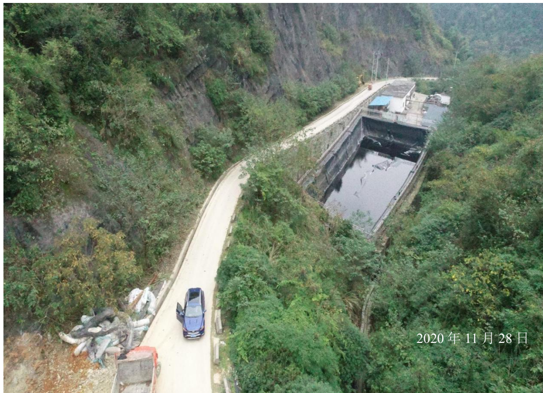
渗滤液处理站区
