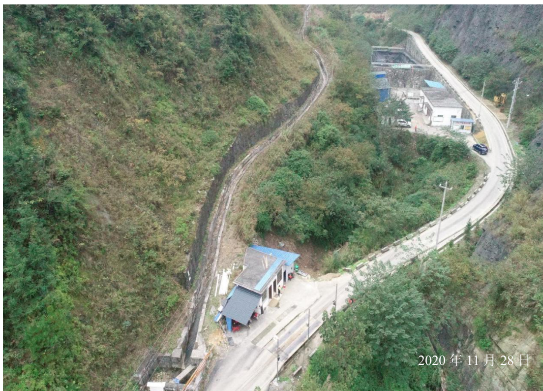
道路系统区及截洪沟
