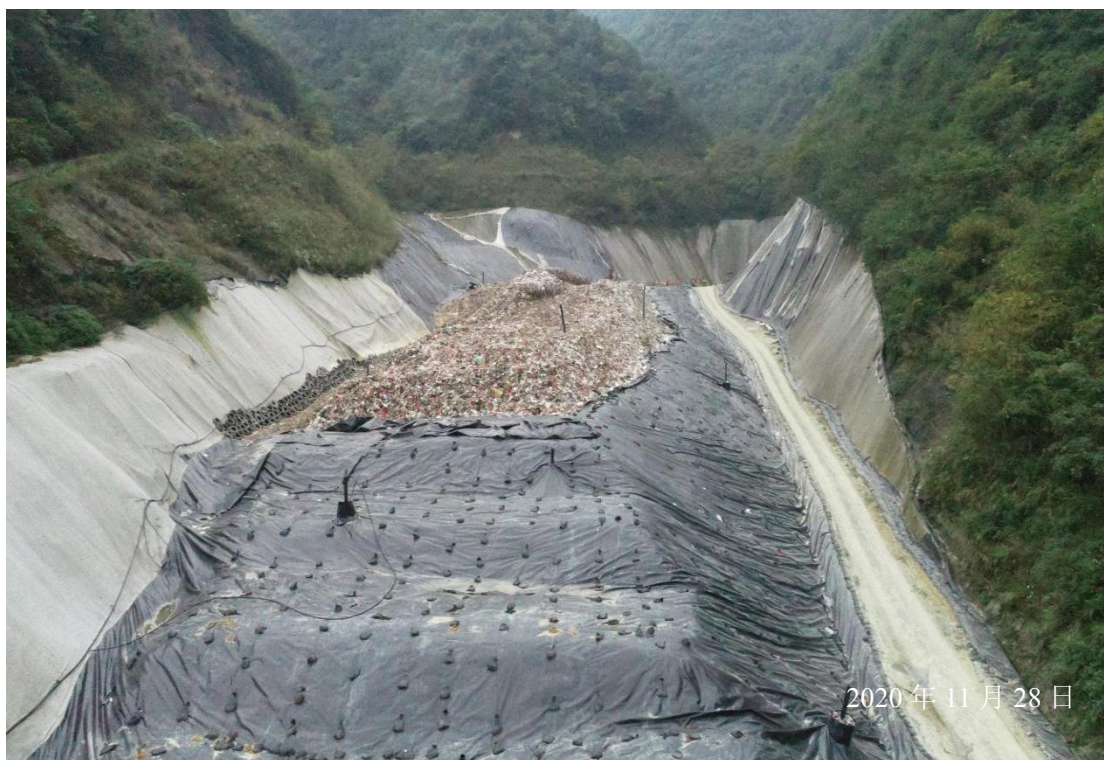
垃圾填埋场区及临时排水沟
