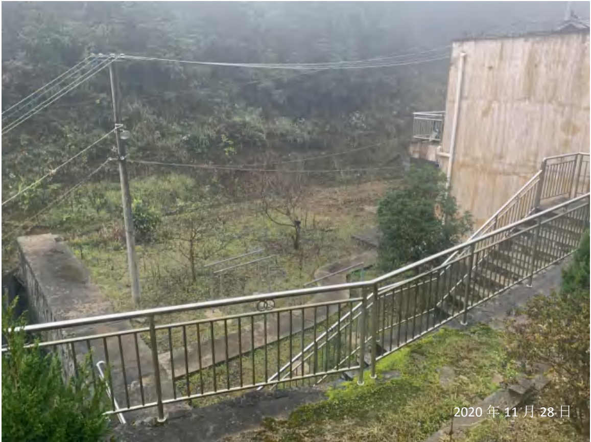
管理站区边坡植物绿化
