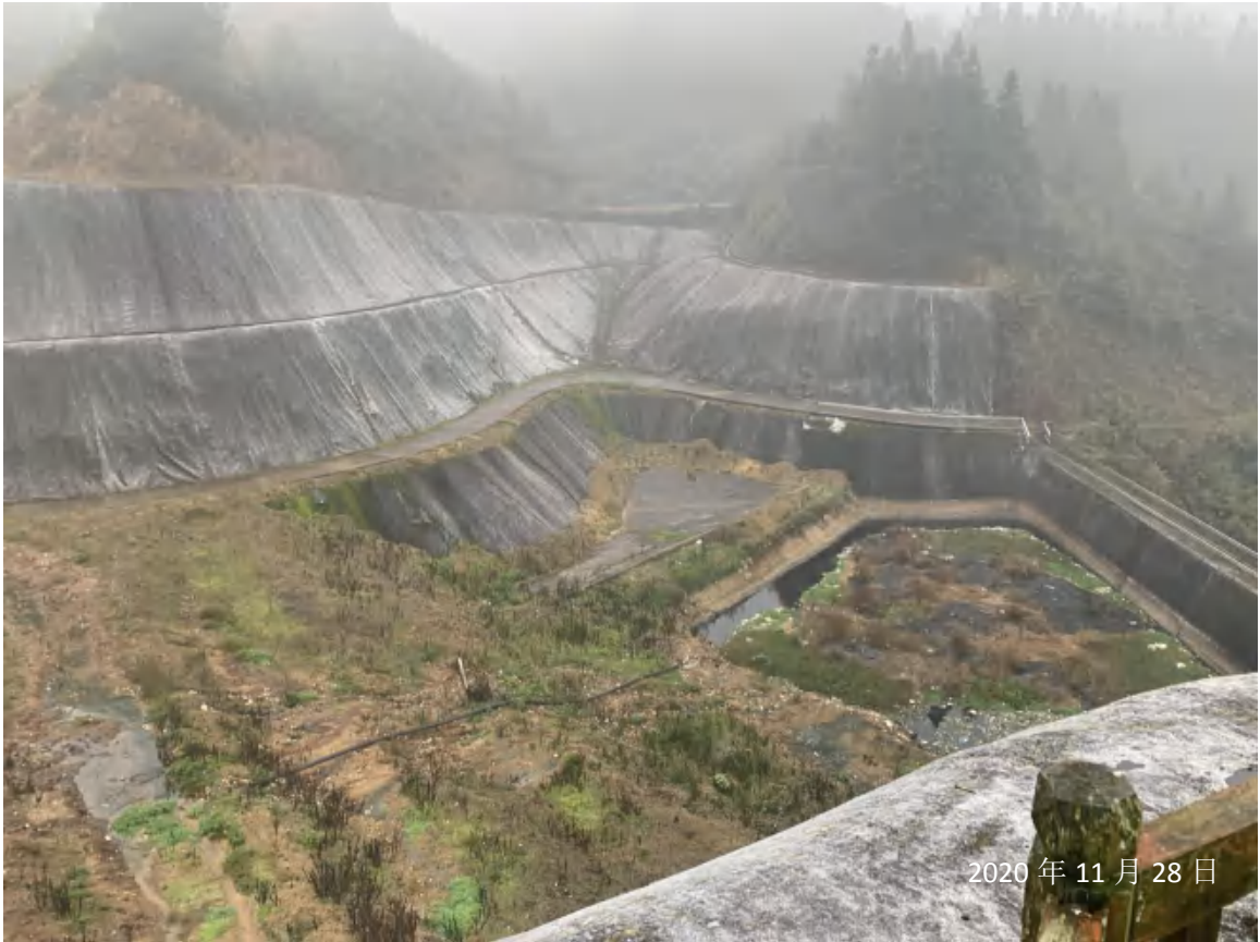
填埋场库区截排水沟、截水拦挡和污水容纳池措施效果
