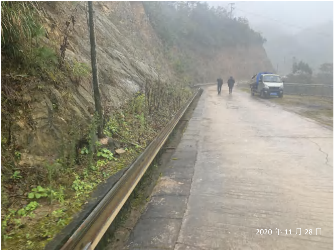
进场道路硬化及排水沟
