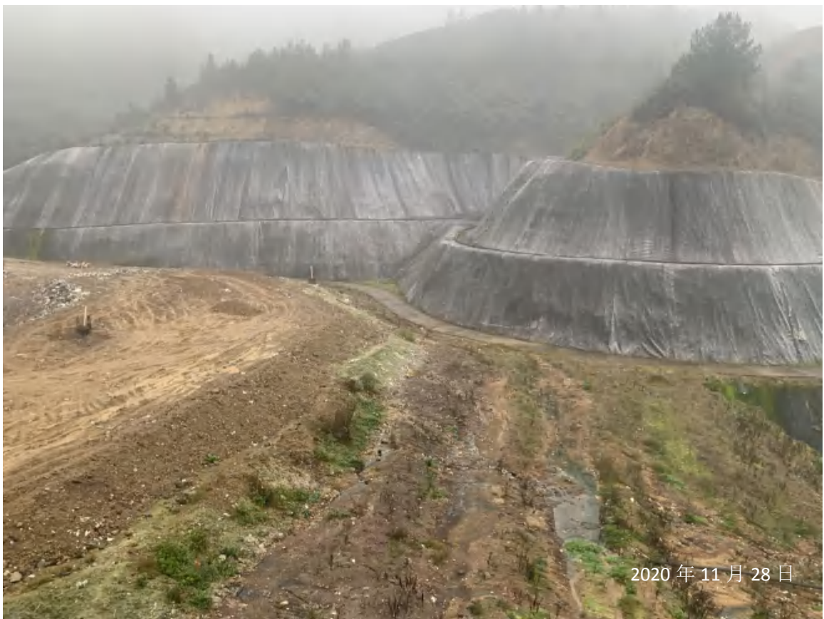
填埋场库区截排水沟及截水拦挡措施效果
