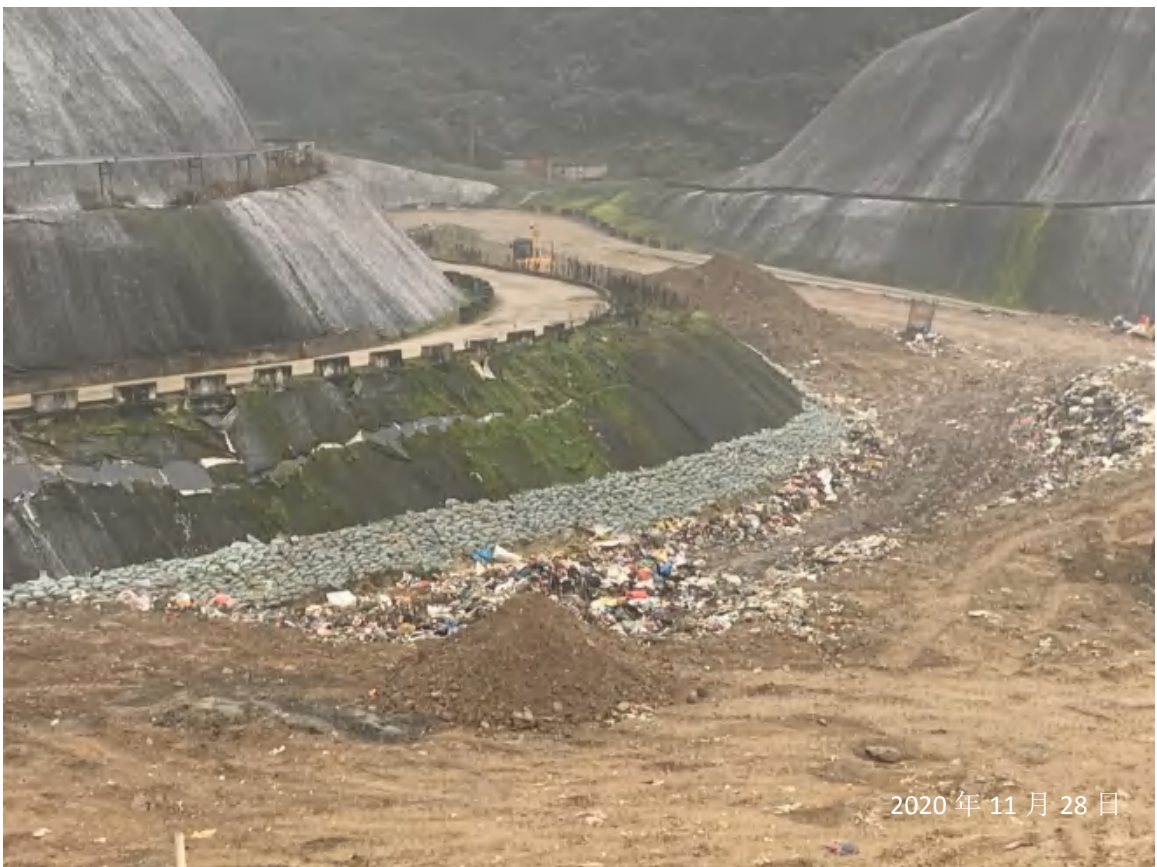
填埋场库区临时土袋拦挡措施
