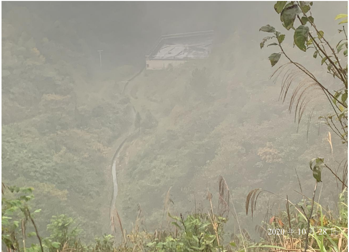
渗滤液处理站
