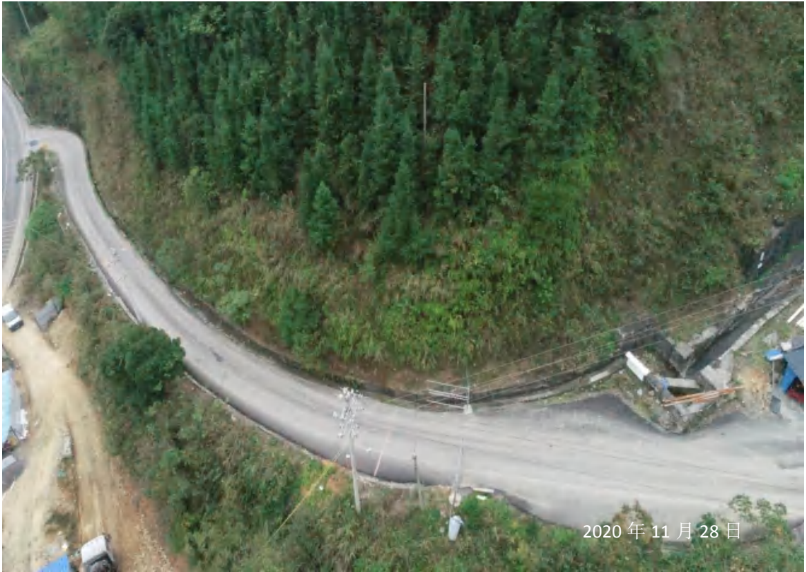
道路系统区及排水沟
