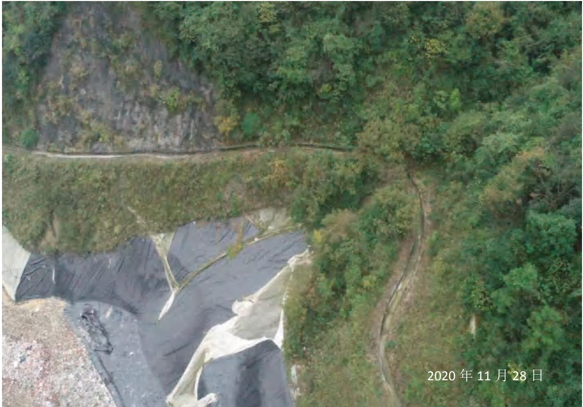
填埋场区截洪沟
