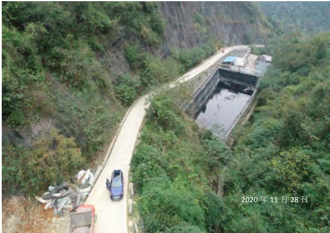
渗滤液处理站区
