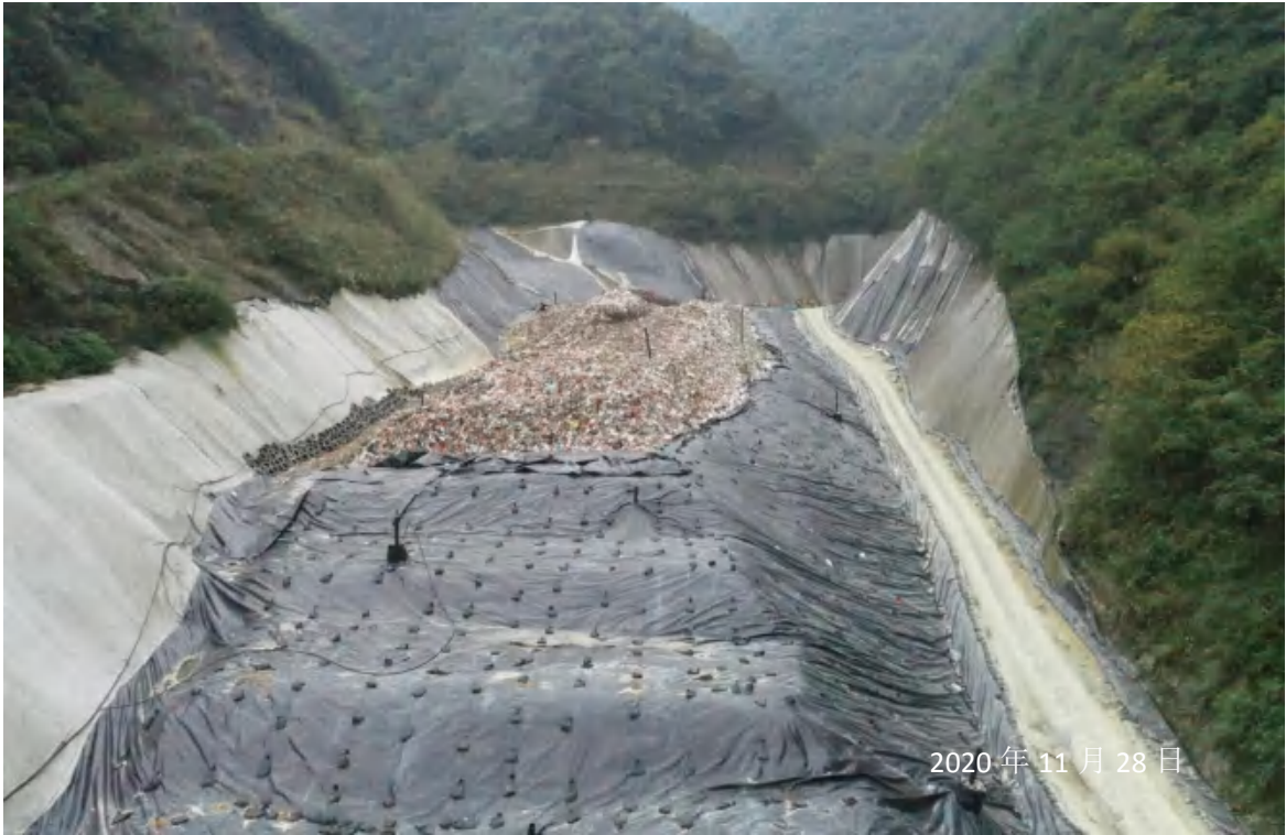
垃圾填埋场区及临时排水沟
