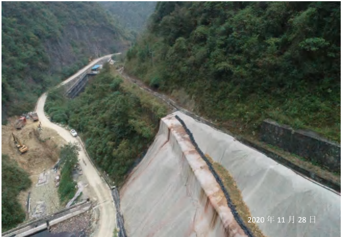
填埋场区截洪沟
