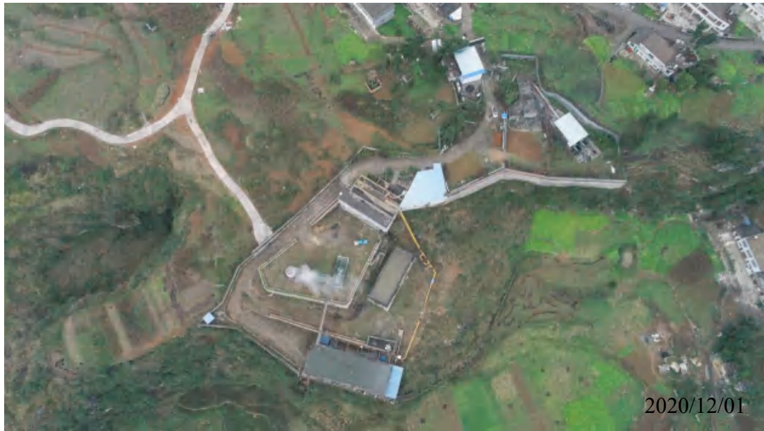
13 回风斜井航拍图
