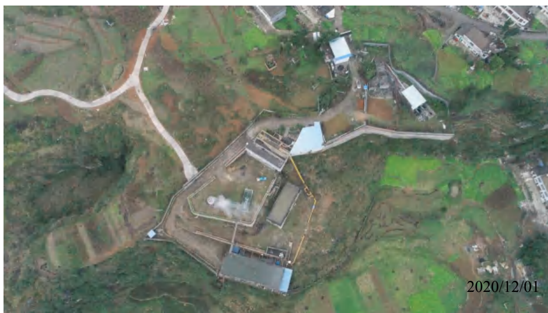
13回风斜井航拍图
