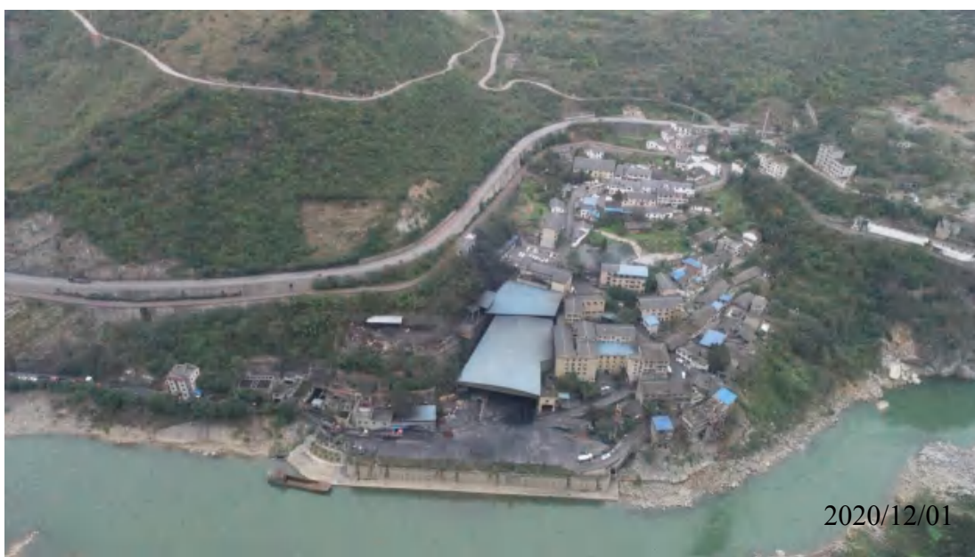
岔角煤矿厂区航拍图
