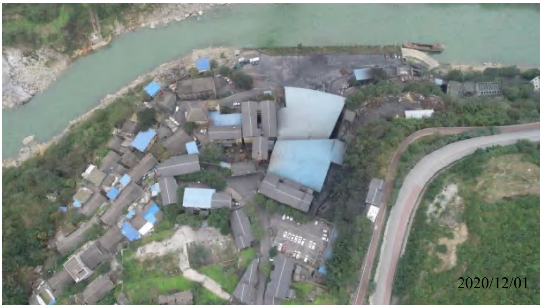
岔角煤矿厂区航拍图
