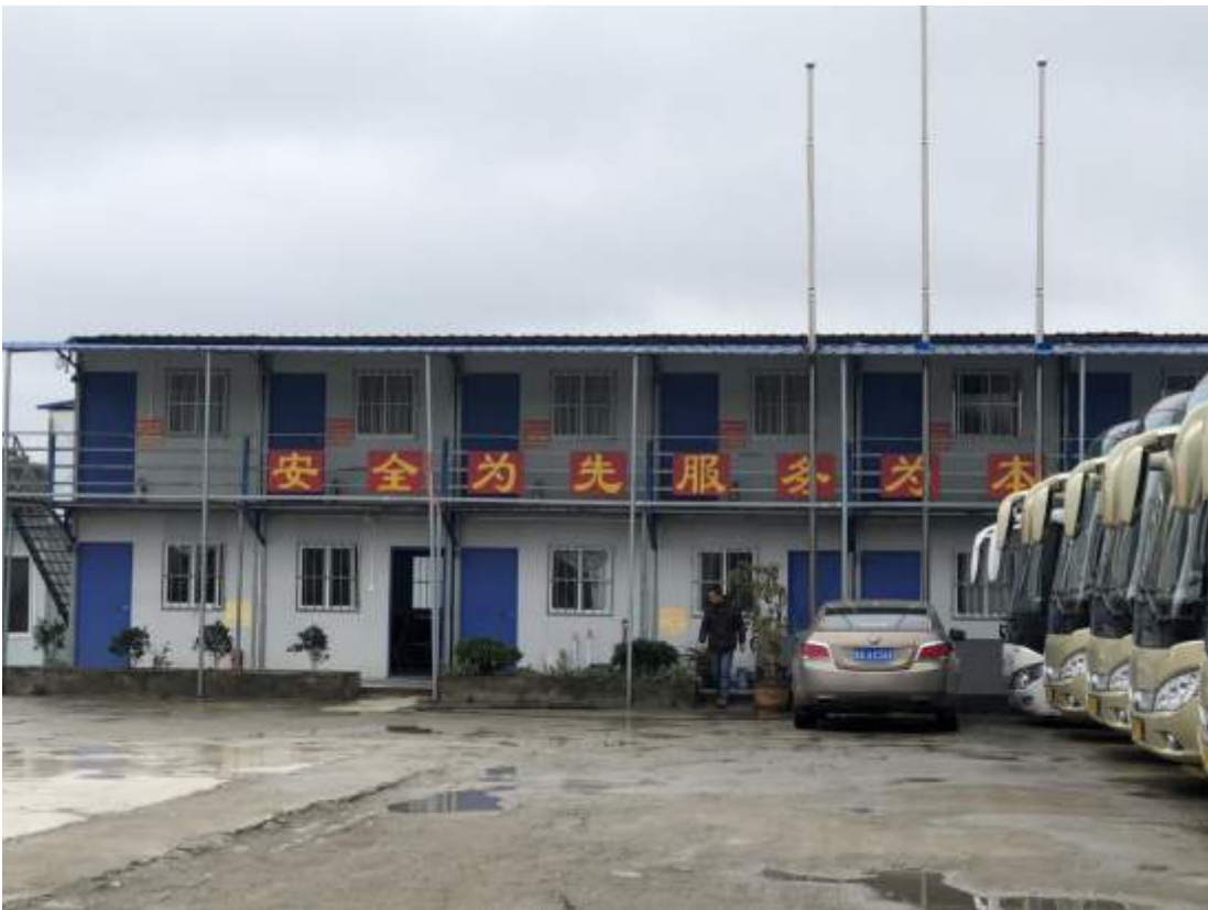
项目区用房现状
