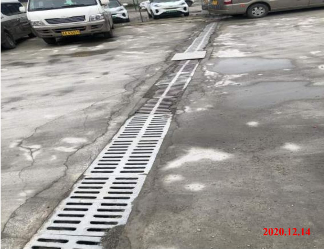
项目区盖板排水沟
