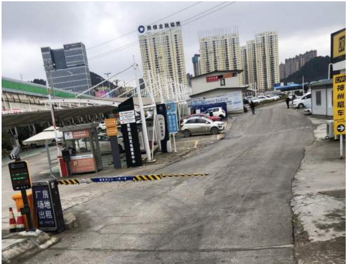
项目区进口道路
