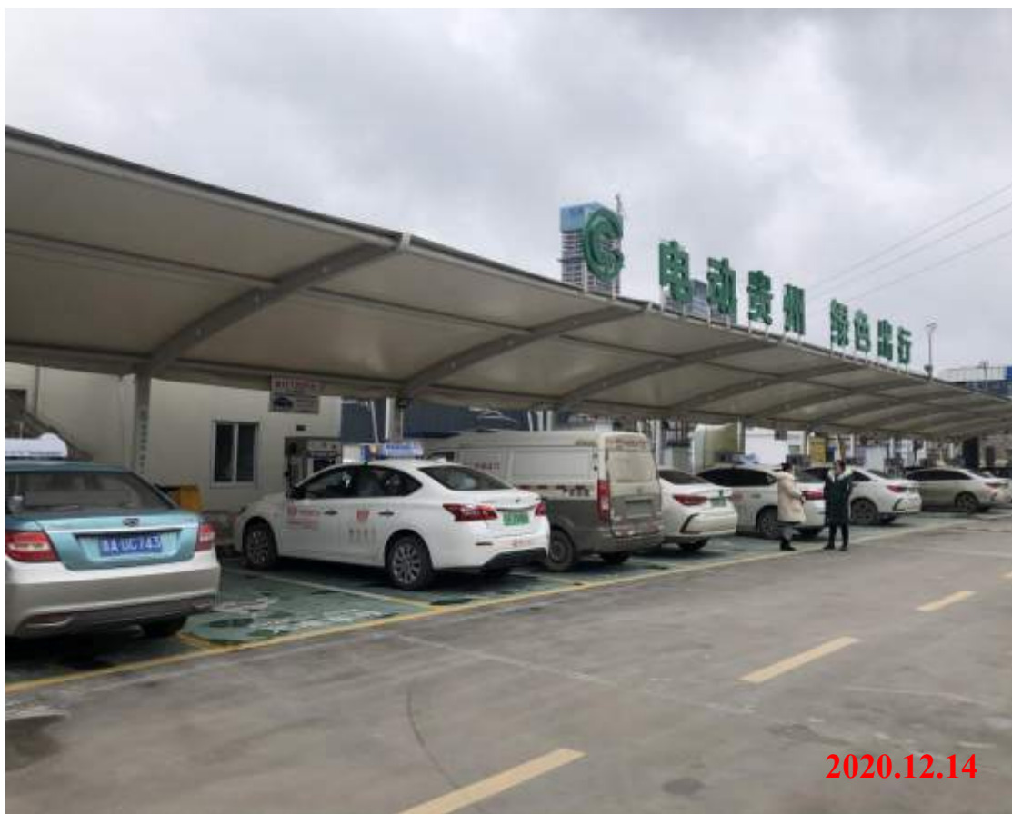
项目区停车场现状
