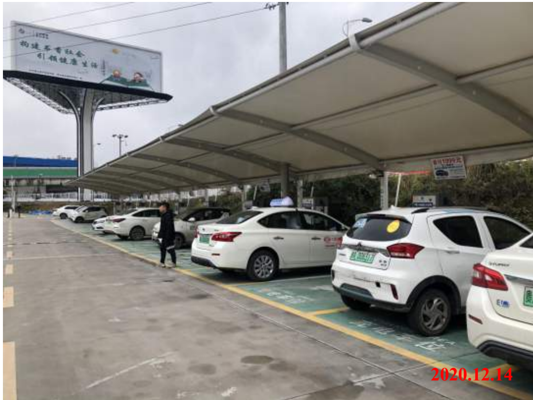
项目区停车场现状
