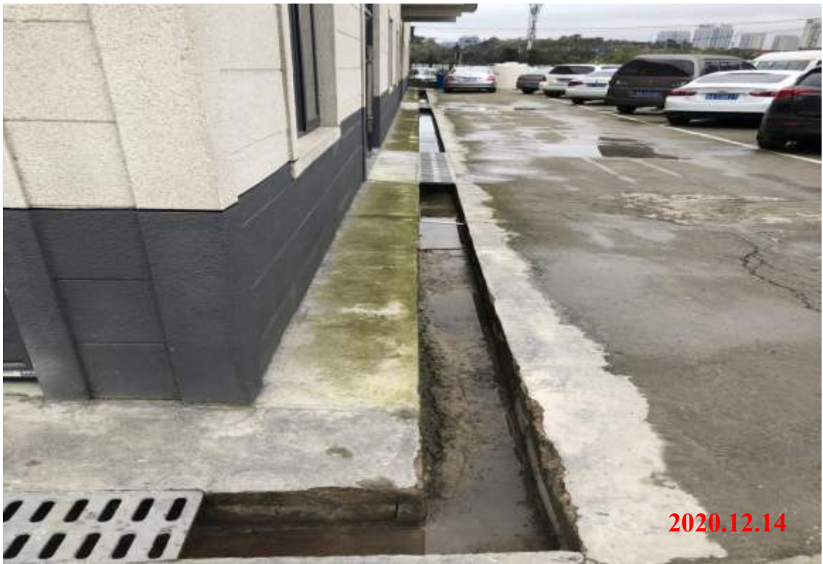
项目区排水沟
