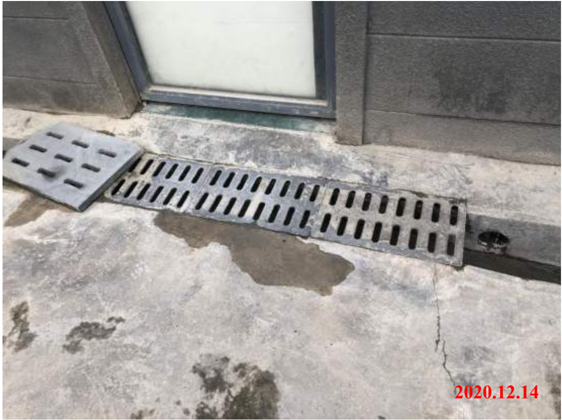
项目区盖板排水沟
