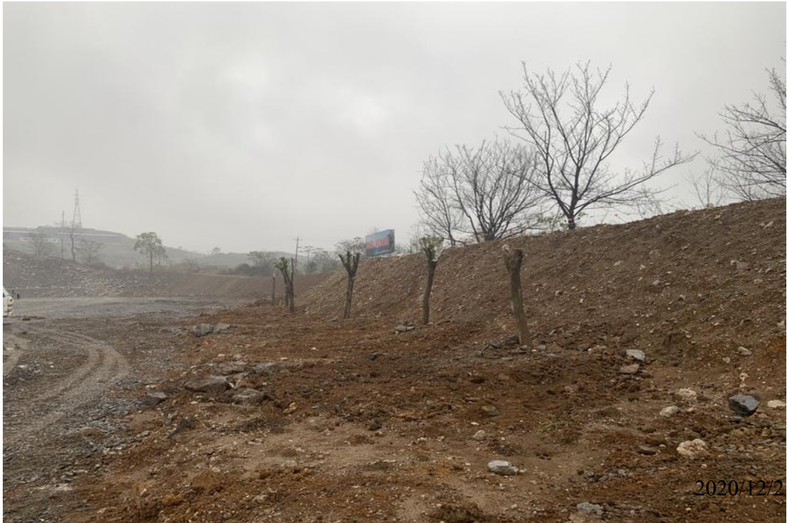
矿区已扰动完成区域正在进行植被恢复
