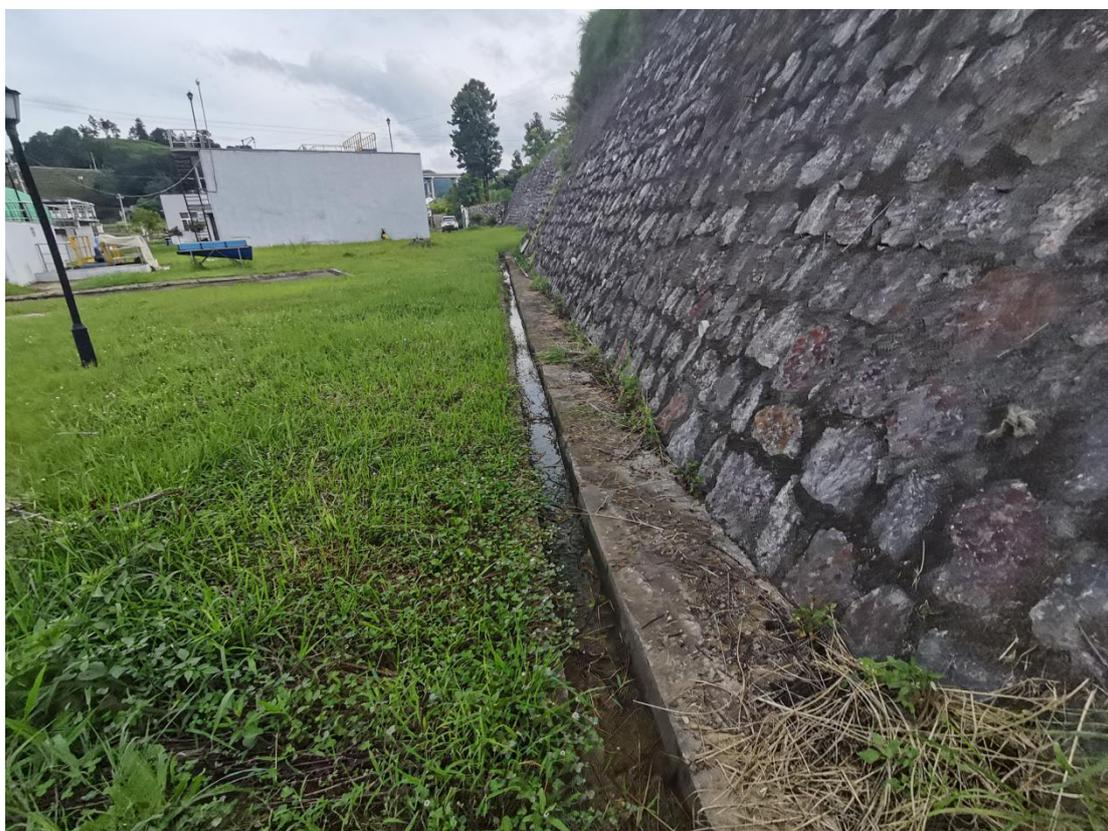
瓦窑寨污水处理厂截排水沟及主体挡墙效果图
