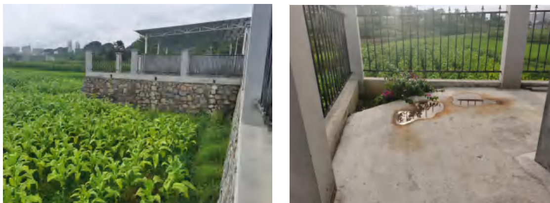
雨水排出厂区处
