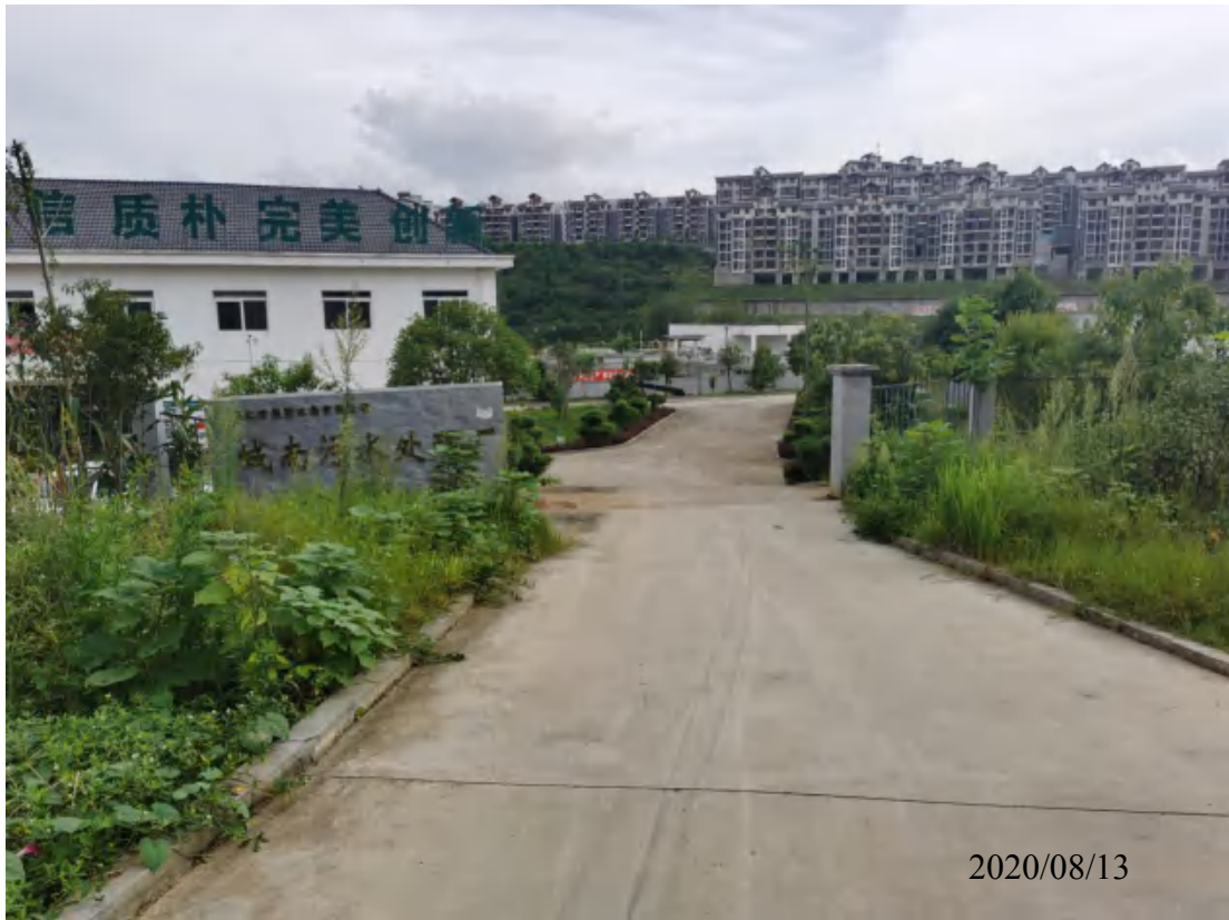
污水处理厂进口
