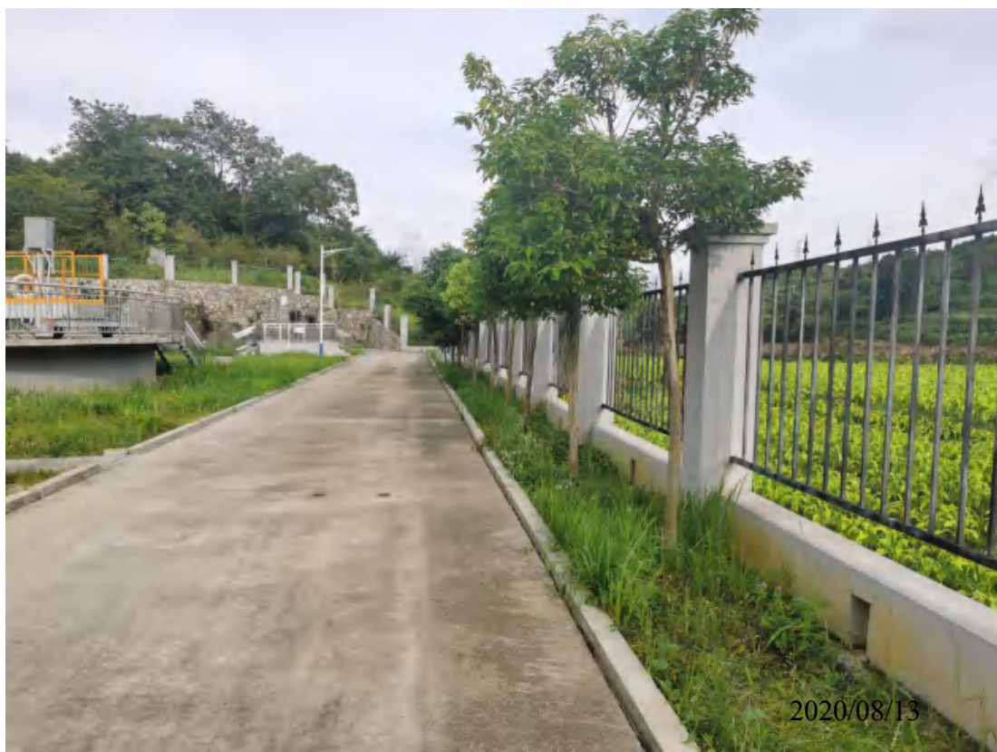
污水处理厂进口一角
