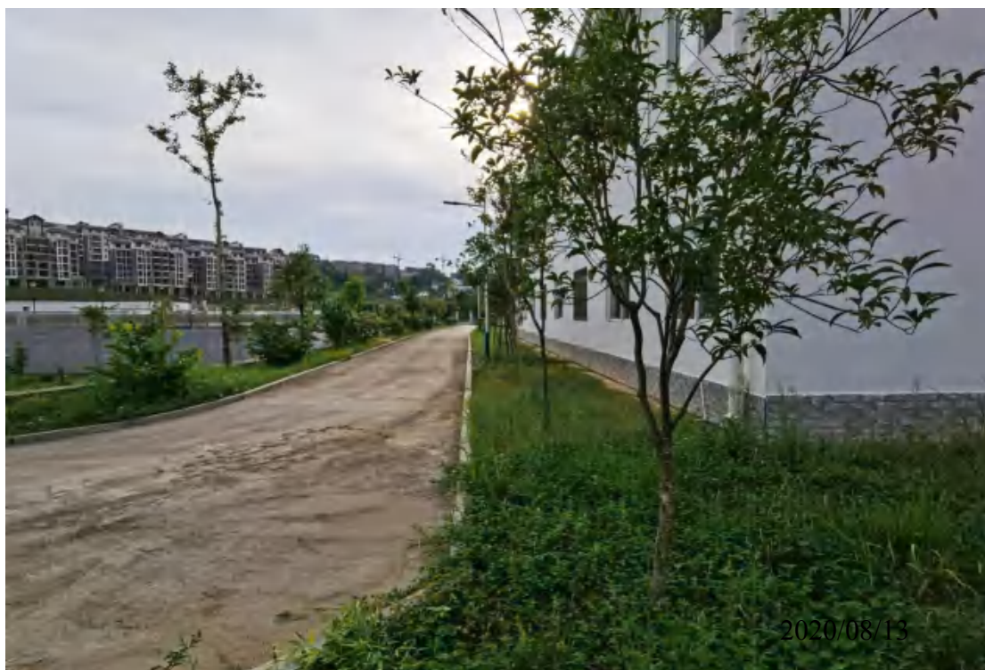
污水处理厂进口一角
