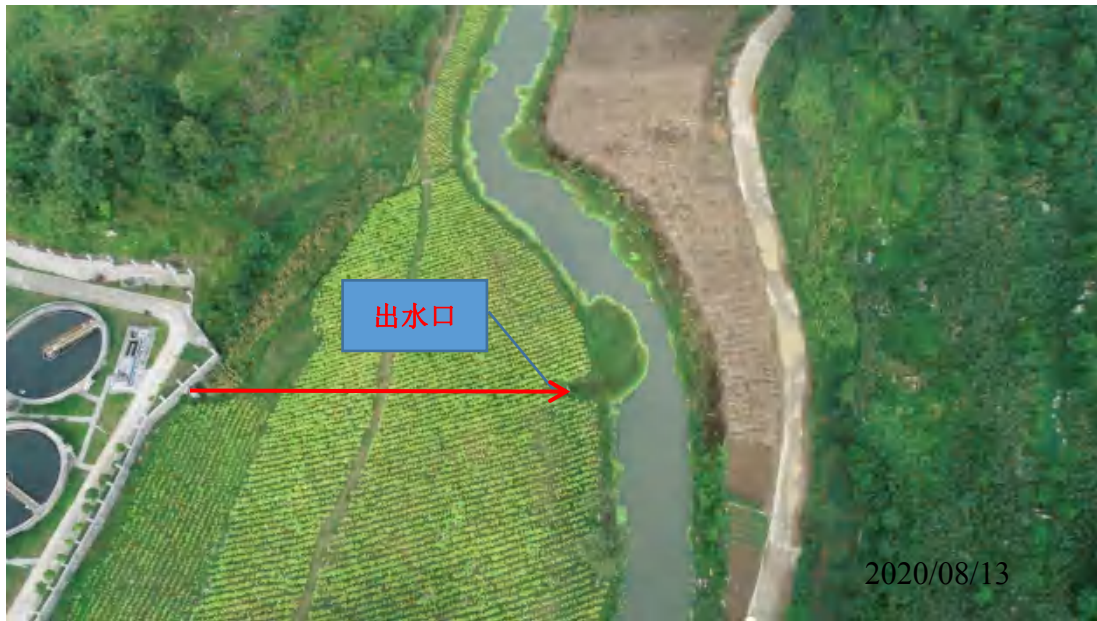
污水管网出水口图
