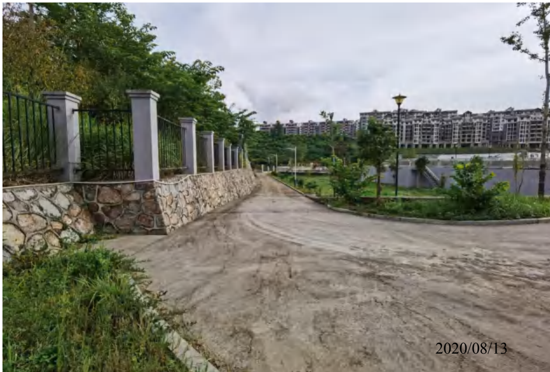
污水处理厂进口一角
