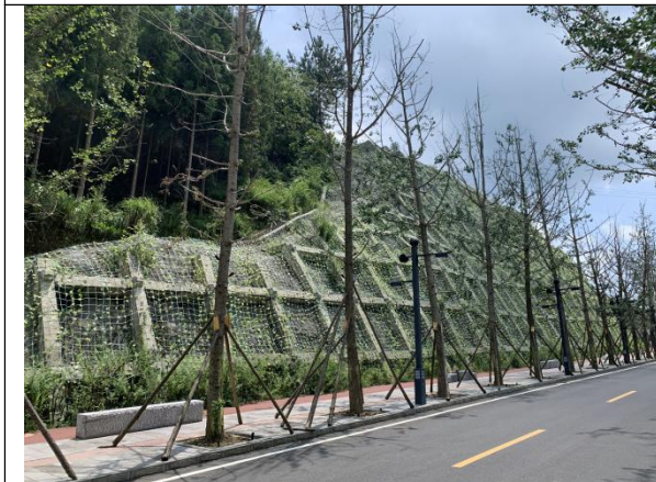
锚杆框架梁护坡
