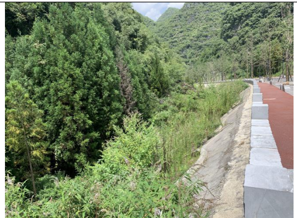
衬砌拱植草护坡
