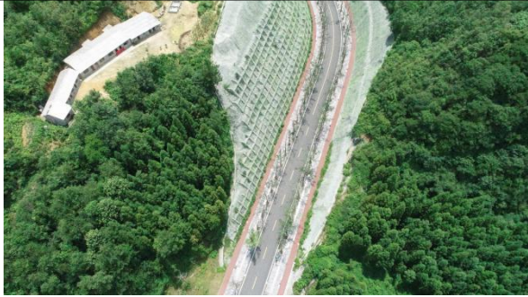
项目区工程护坡效果
