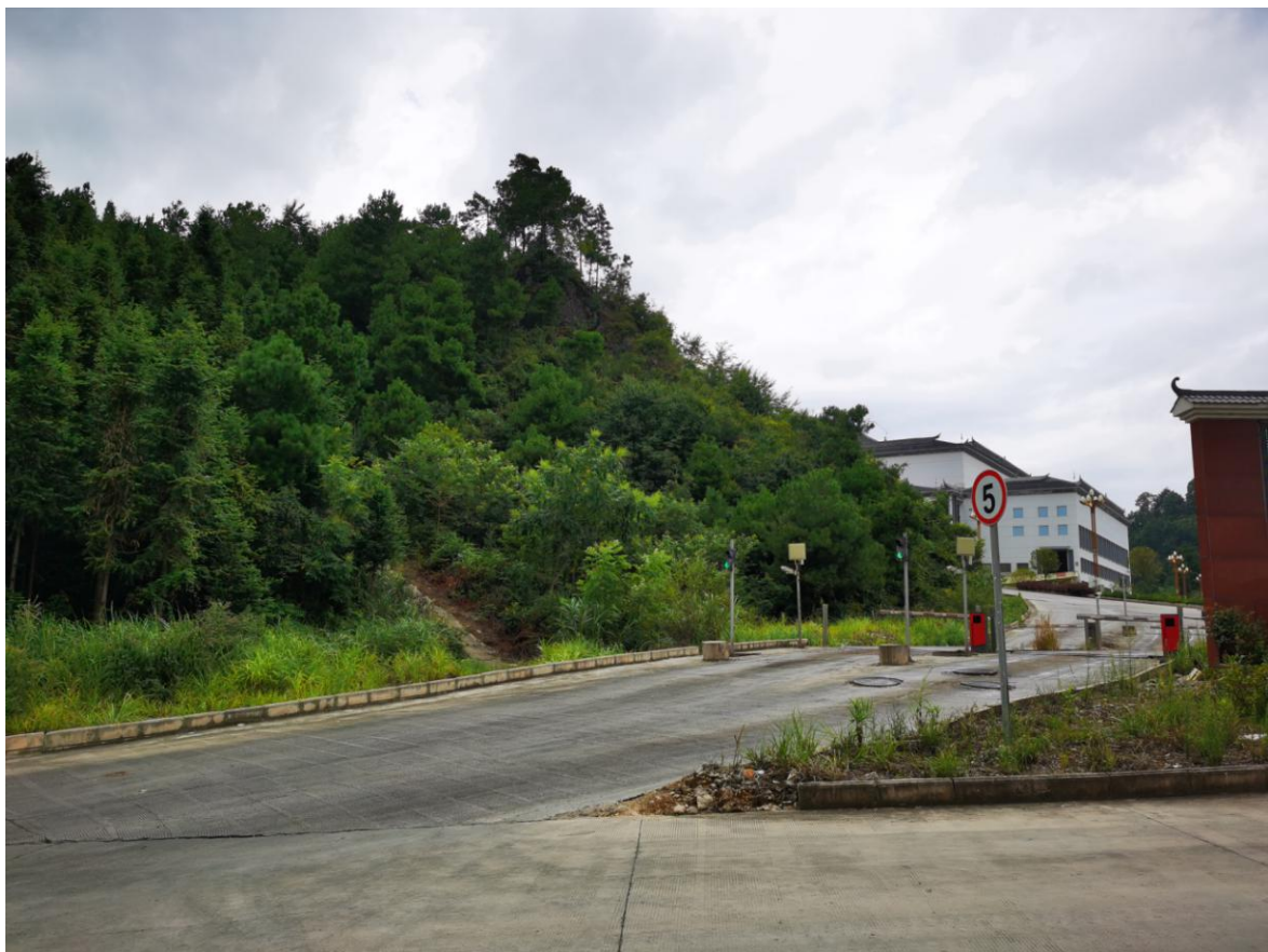
调查进厂道路水土保持植物措施实施情况
