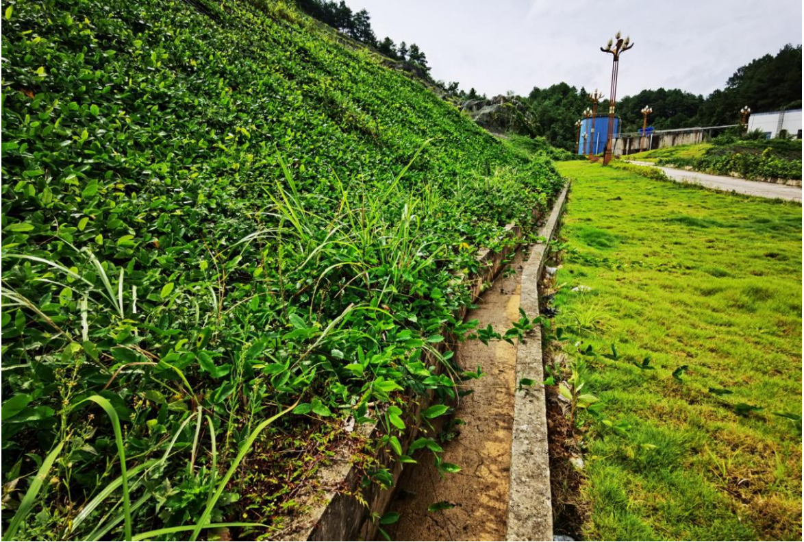
调查厂内边坡水土保持植物措施实施情况
