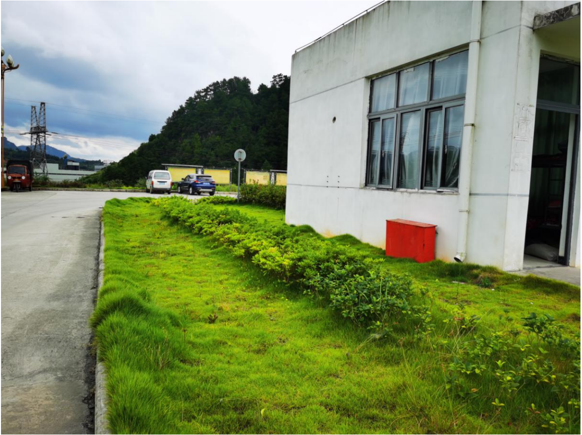
调查厂内道路两侧水土保持植物措施实施情况
