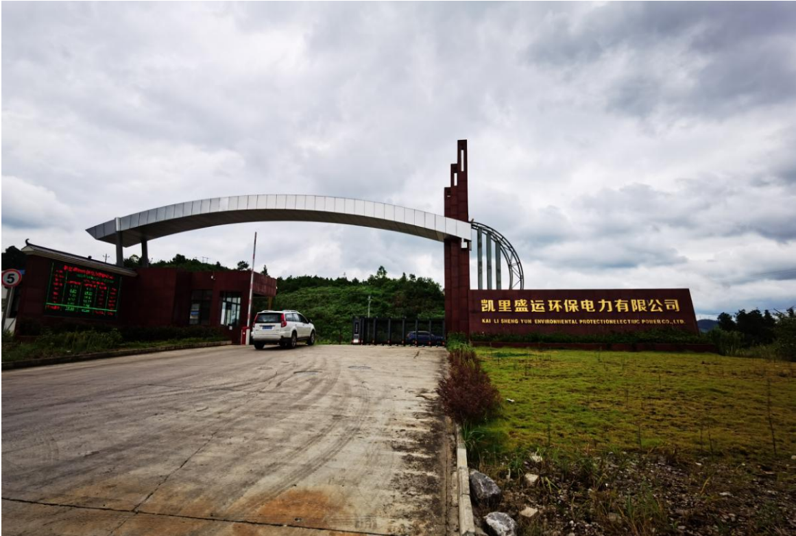
厂区工程门口水土保持治理效果
