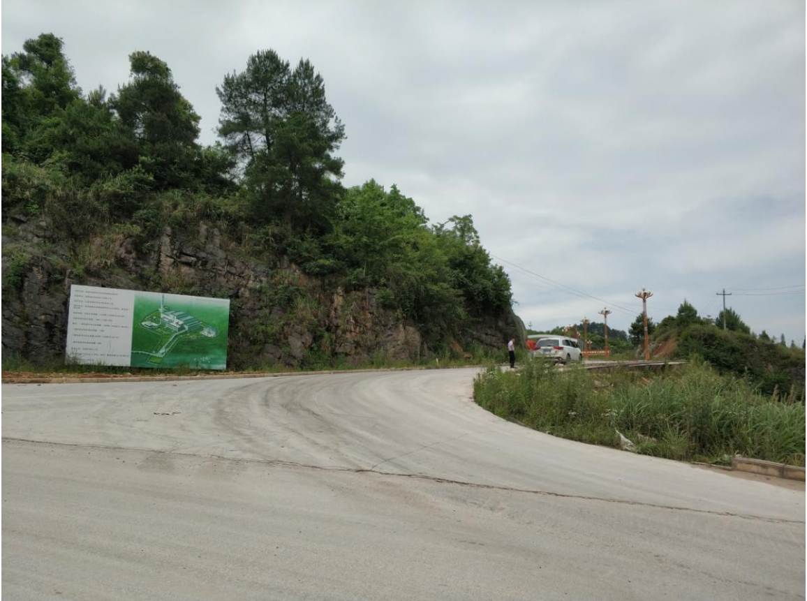
进厂道路区起点水土保持治理效果
