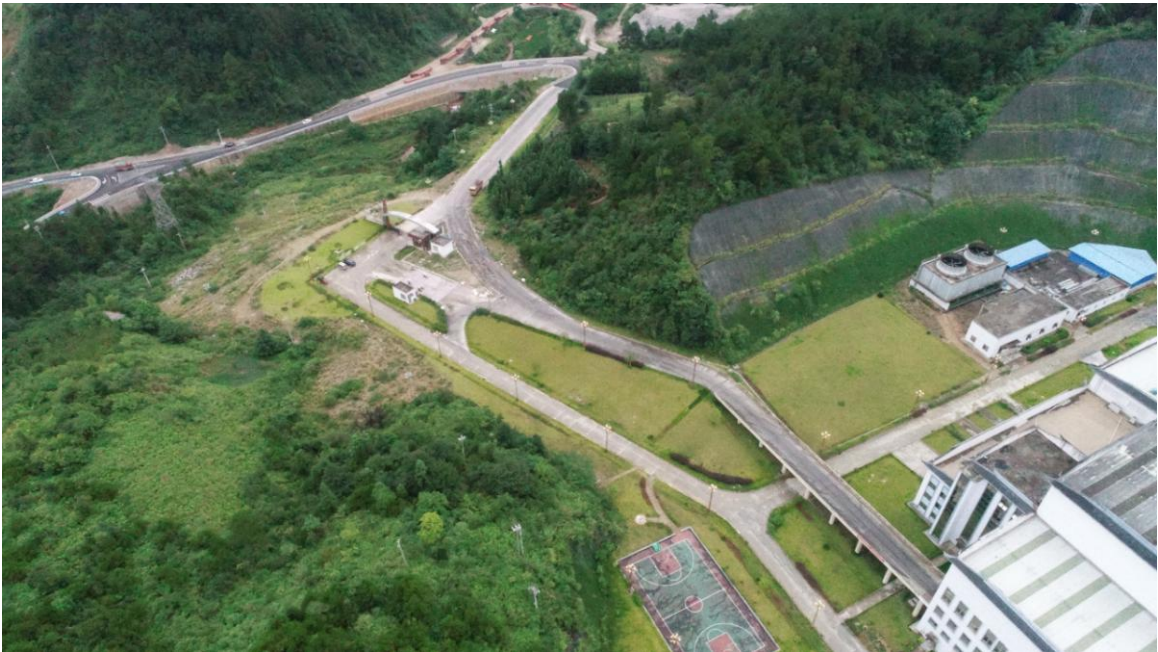
厂区工程及进厂道路工程区航拍治理效果图
