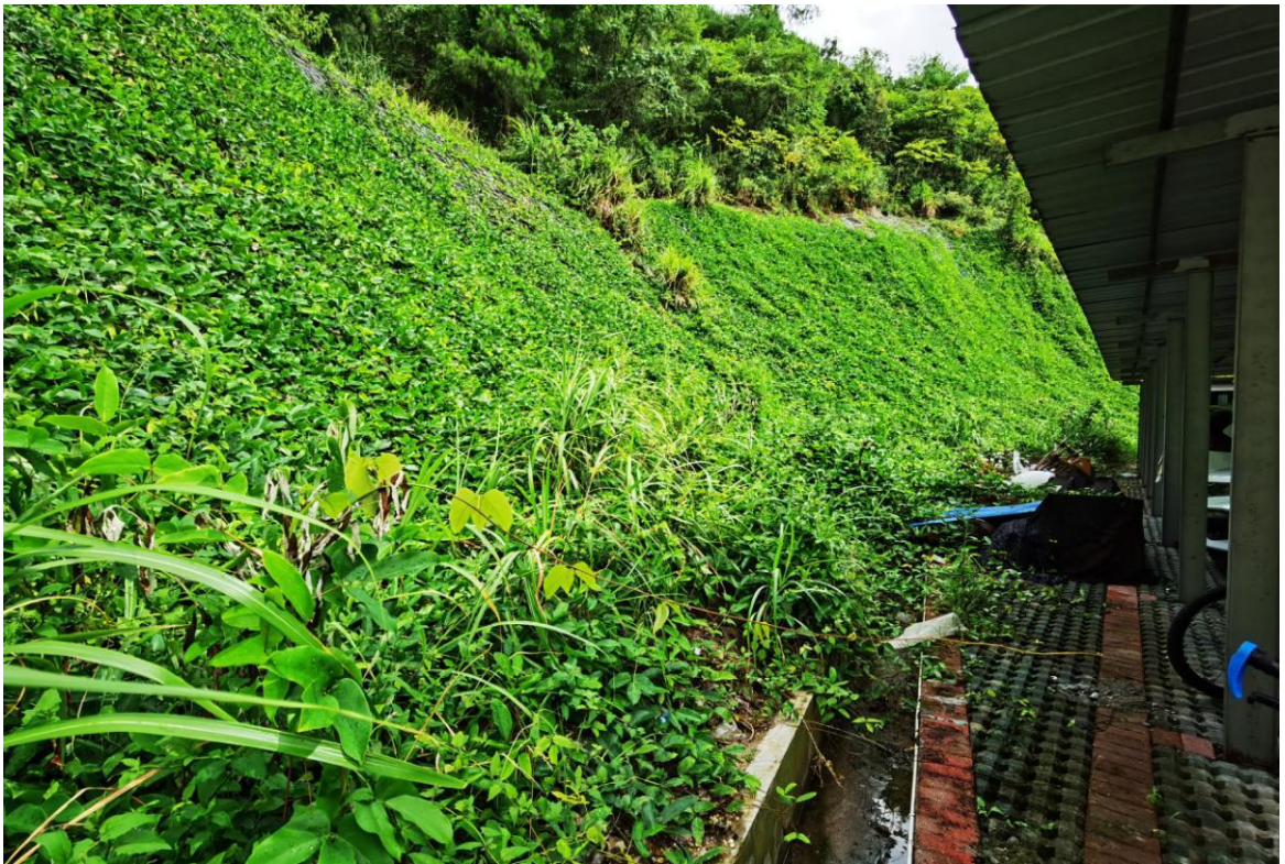
厂区工程排水沟及上边坡水土保持治理效果
