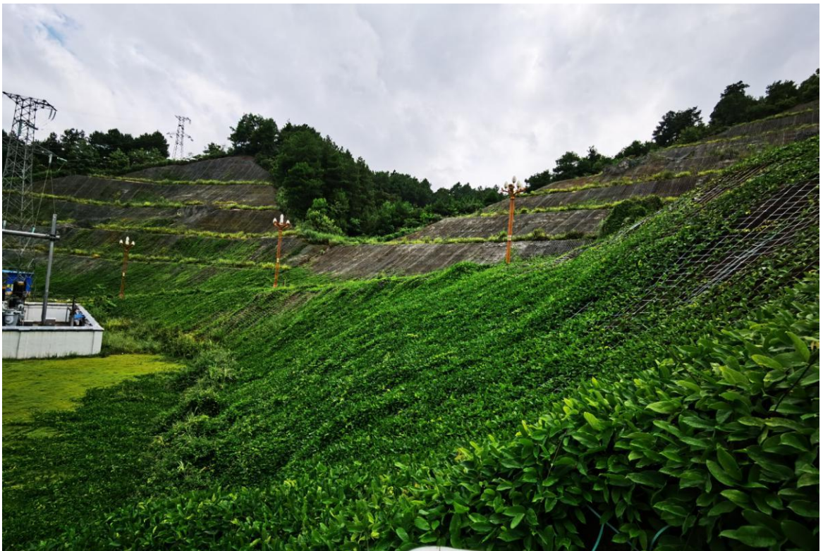
厂 区 工 程 上 边 坡 水 土 保 持 治 理 效 果
