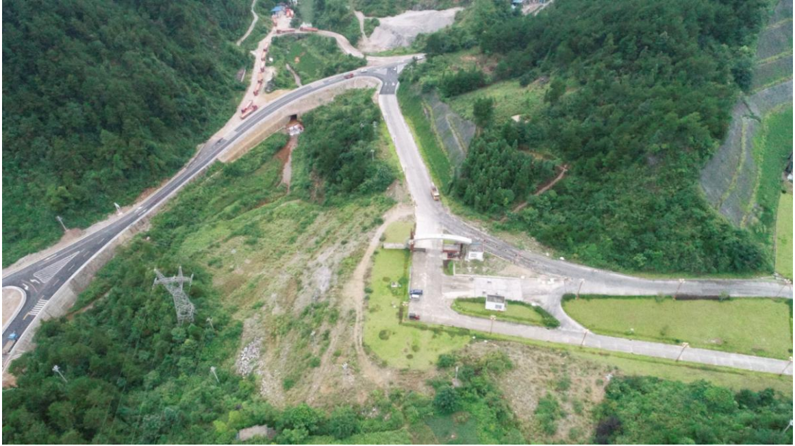
进场道路区工程航拍治理效果图
