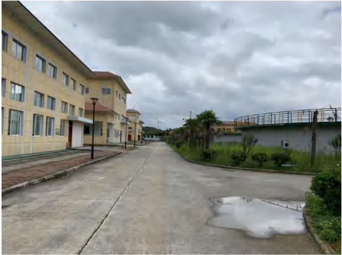
污水处理厂地面硬化、雨水管道和植物措施实施效果
