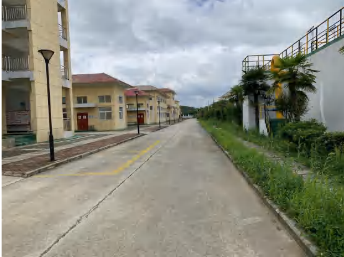
污水处理厂地面硬化及植物措施实施效果
