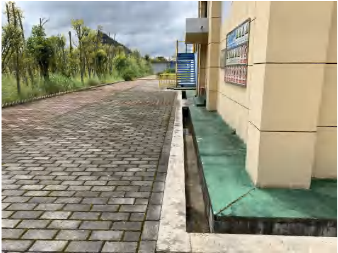
污水处理厂地面硬化、截水沟和植物措施实施效果
