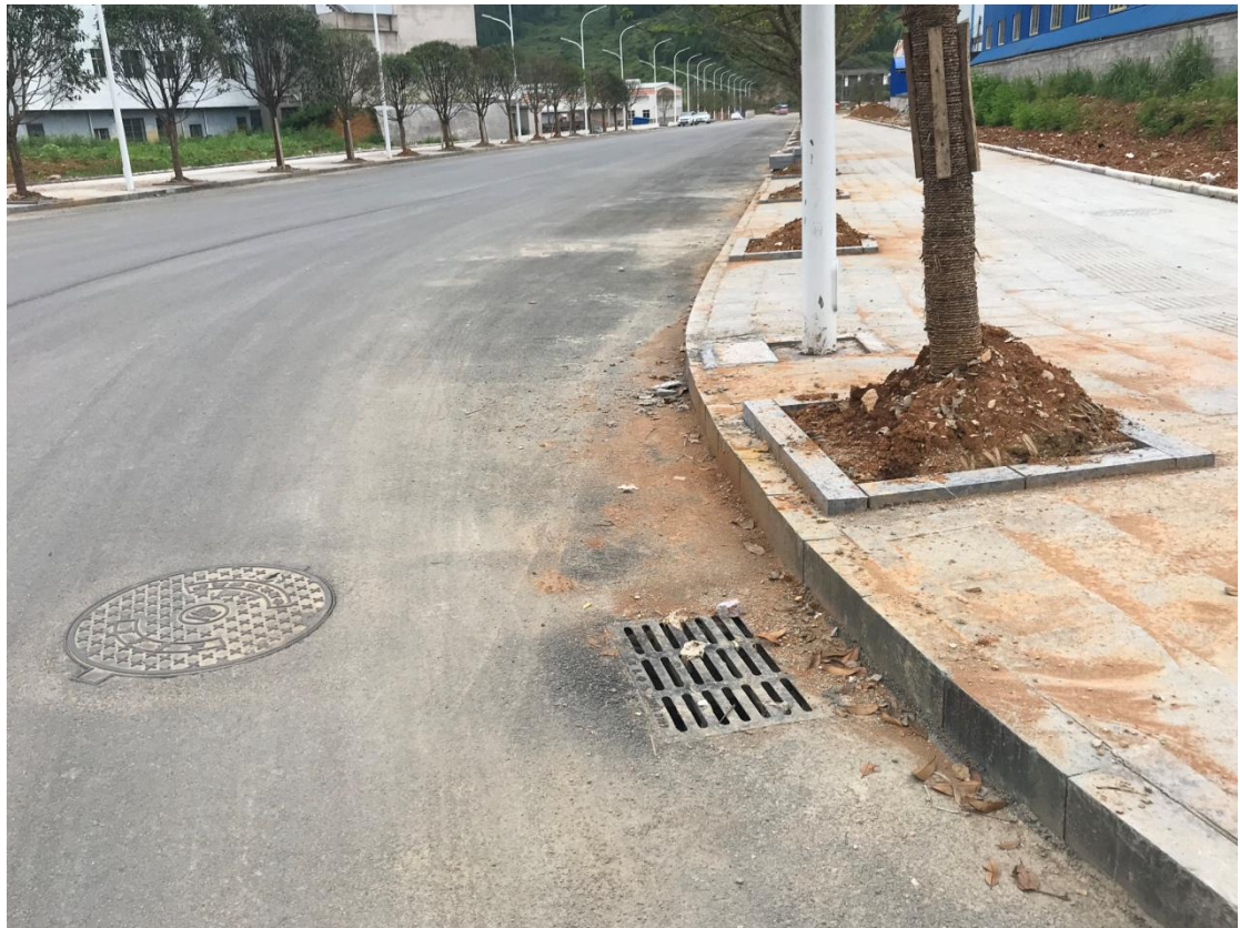
道路雨水口和雨水井
