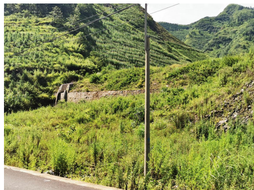
1#弃渣场治理后
