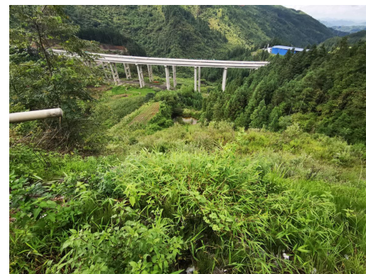
2#弃渣场治理后
