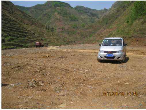
1#弃渣场治理前
