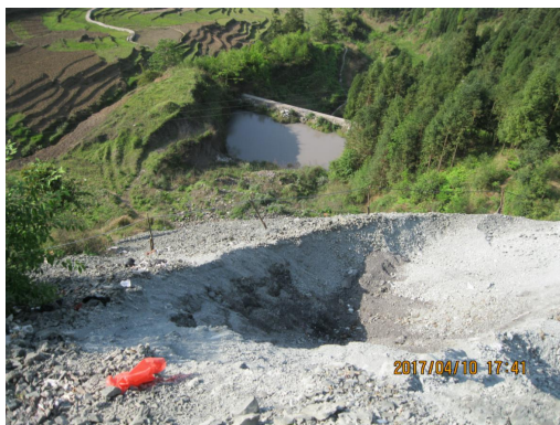
2#弃渣场治理前
