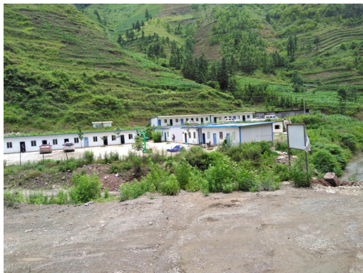
施工营区治理前
