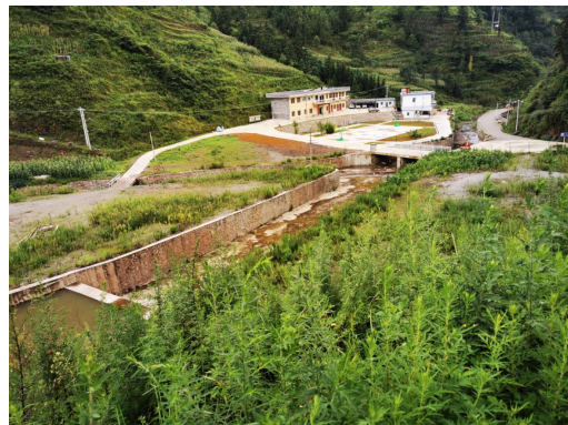
施工营区治理后
