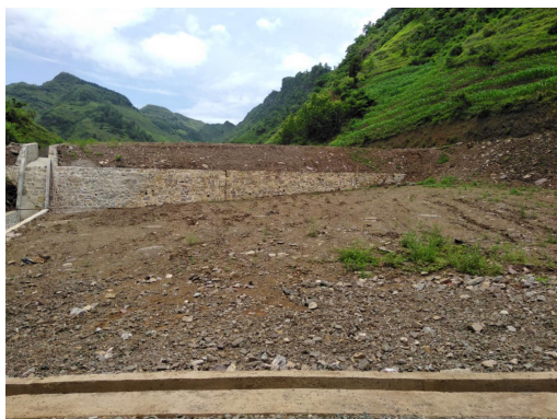
1#弃渣场治理前
